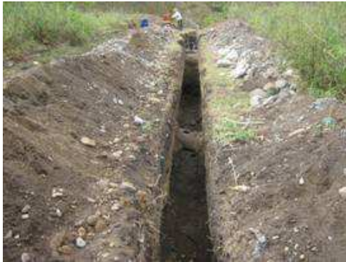
Figura No 20. Excavación de zanjas
