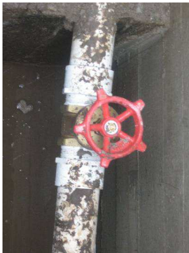
Figura No 70. Válvula de Bola HF 3"
