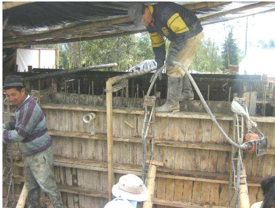
Figura No 64. Fundición de muros del tanque
