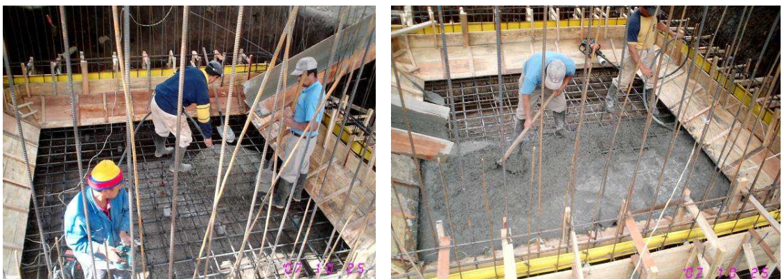
Figura No 59. Fundición de placa de piso en concreto impermeabilizado
