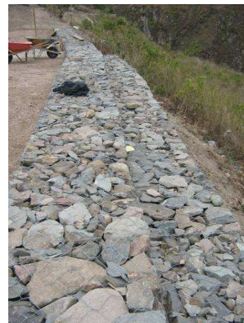
Figura No 44. Gaviones terminados
