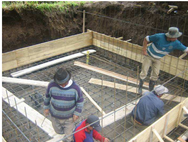
Figura No 58. Armado de refuerzo y formaleta
