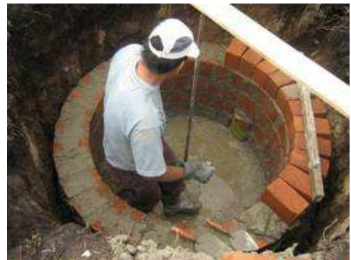
Figura No 27. Pega de ladrillo
