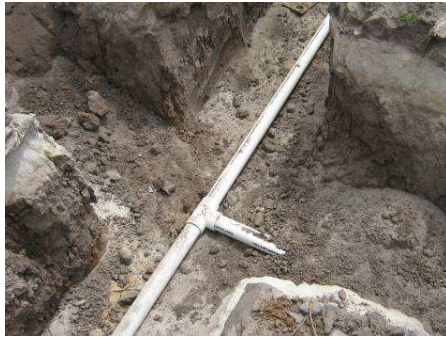
Figura No 83. Instalación de Tee
