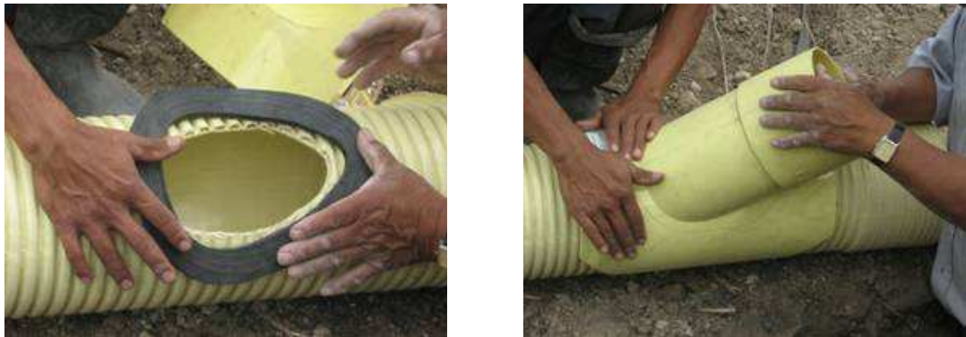
Figura No 35. Instalación de silla Yee
