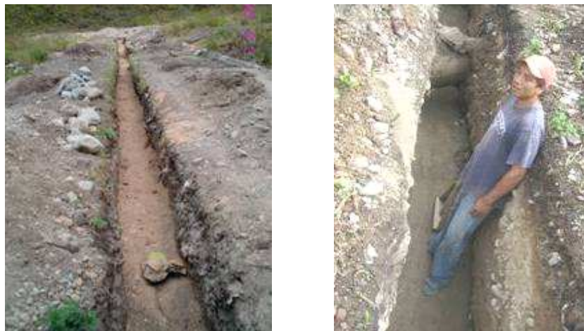
Figura No 36. Compactación sobre tubería con pisón
