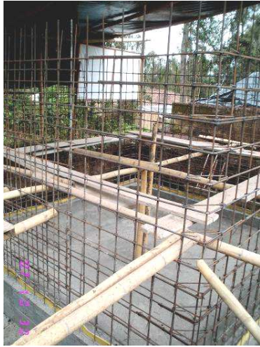
Figura No 60. Refuerzo de paredes
