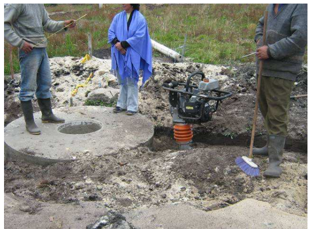
Figura No 13. Relleno compactado con material de excavación
