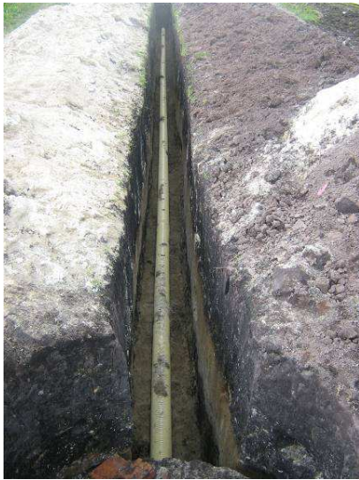
Figura No 10. Instalación de tubería
