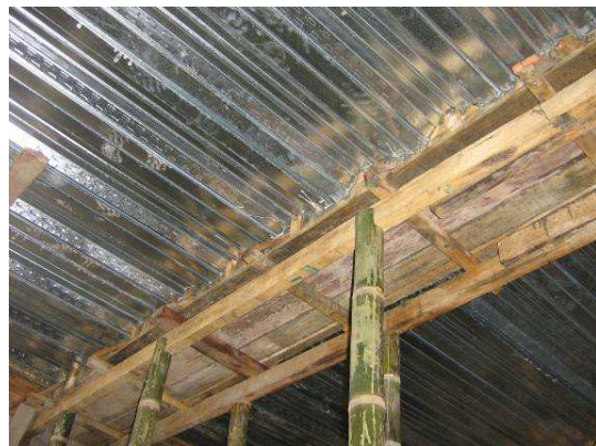
Figura No 67. Losa en Metaldeck
