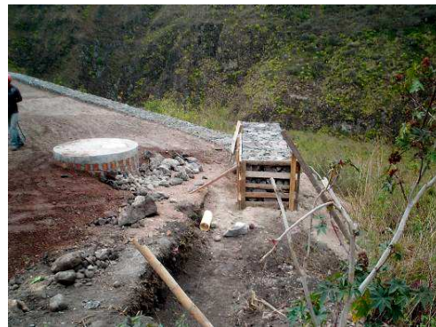
Figura No 43. Armado de gaviones
