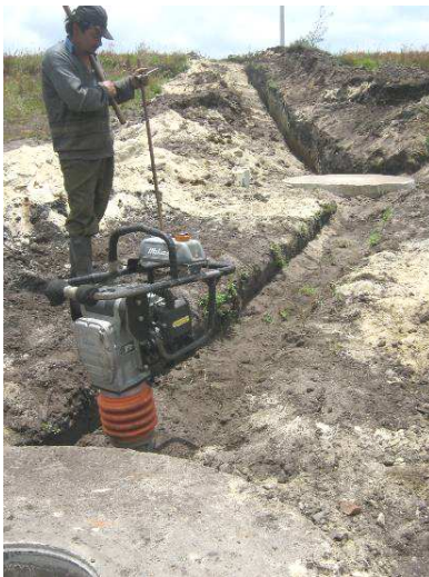
Figura No 13. Relleno compactado con material de excavación
