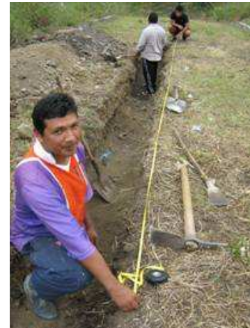
Figura No 23. Medición de excavación
