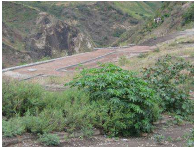
Figura No 50. Panorámica final Urbanización Chirimoyal
