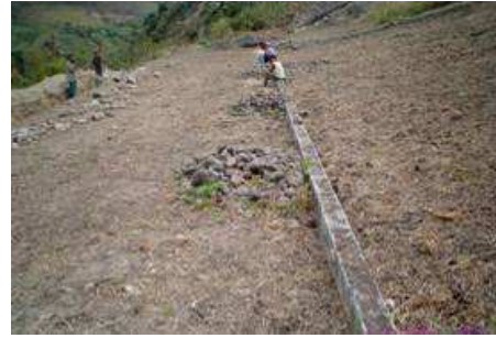
Figura No 37. Descapote de zona para efectuar relleno
