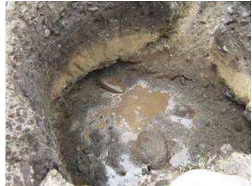
Figura No 21. Excavación de cámaras
