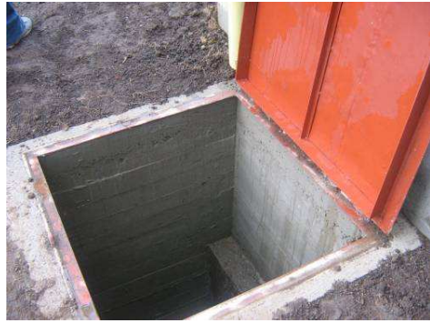
Figura No 72. Cajilla de inspección para válvulas
