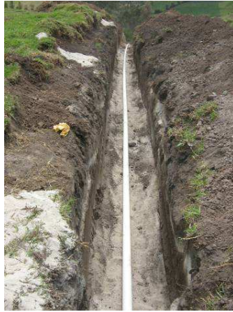
Figura No 82. Instalación de tubería
