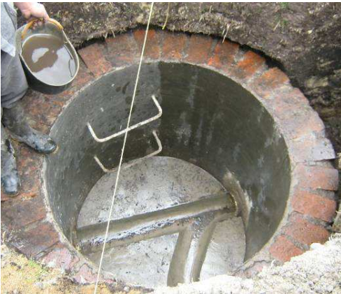
Figura No 7. Construcción de pisos Y muros en tizón
