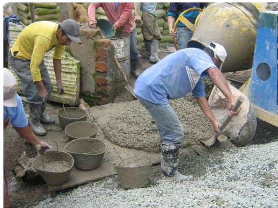
Figura No 62. Mezcla para fundición de muros
