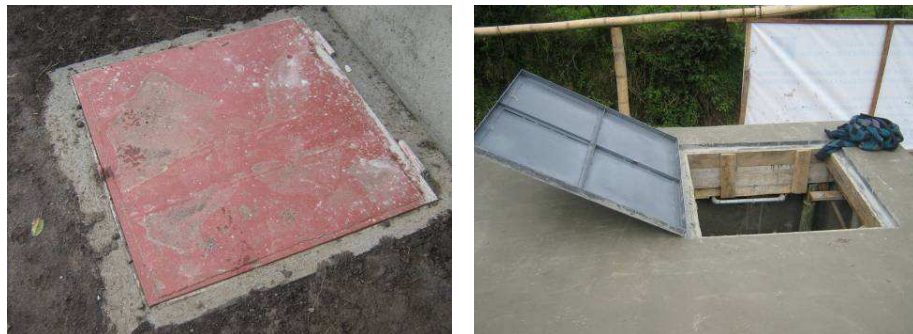
Figura No 76. Tapas en HF 96 x 96 para cajilla y acceso al tanque
