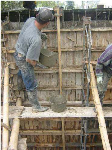
Figura No 64. Fundición de muros del tanque
