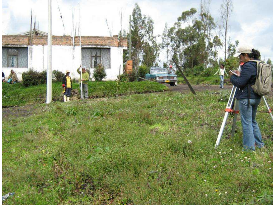
Figura No 3. Localización y replanteo
