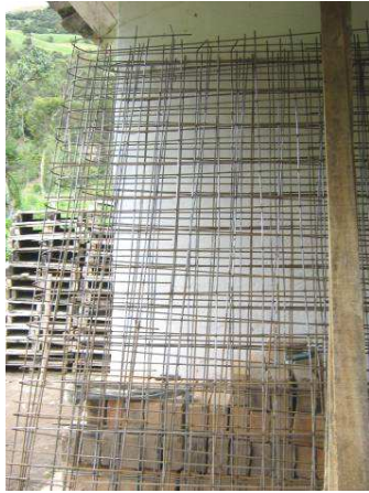
Figura No 66. Refuerzo para parrilla de tapa en metaldeck y vigas
