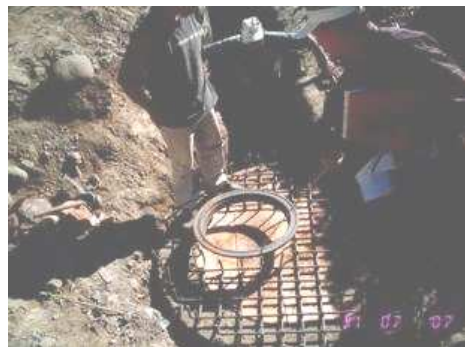
Figura No 29. Refuerzo para tapas
