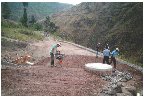
Figura No 39. Compactación mecánica y riego de material
