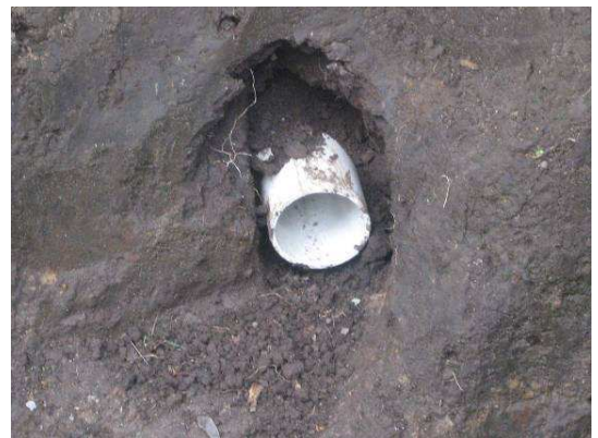
Figura No 74. Tubería de salida 3"
