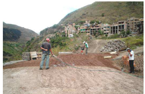
Figura No 39. Compactación mecánica y riego de material
