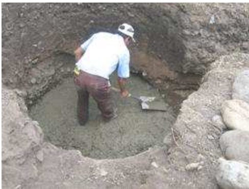
Figura No 26. Fundición de pisos
