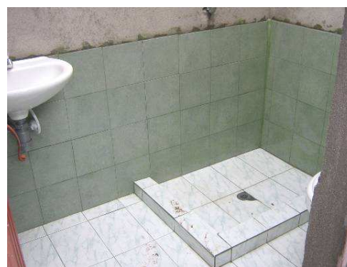
Figura No 96. Enchape de pared y pisos
