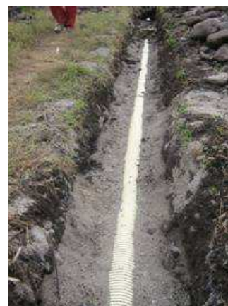
Figura No 34. Instalación de tubería sobre colchón de arena
