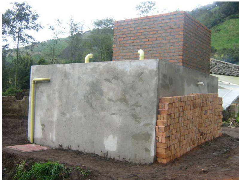
Figura No 79. Panorámica final de Tanque de almacenamiento de agua potable, acueducto Panecillo – La Cruz.
