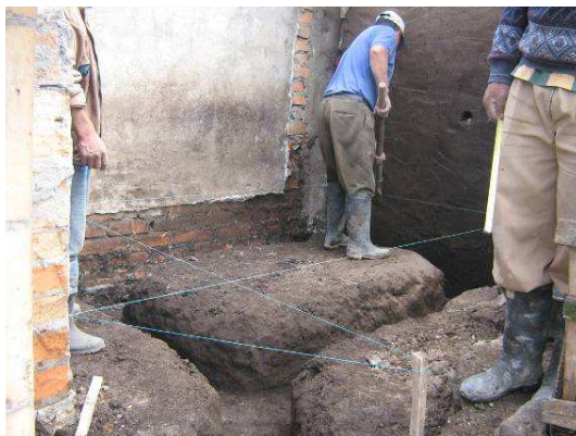
Figura No 92. Localización y excavación de Unidad Sanitaria
