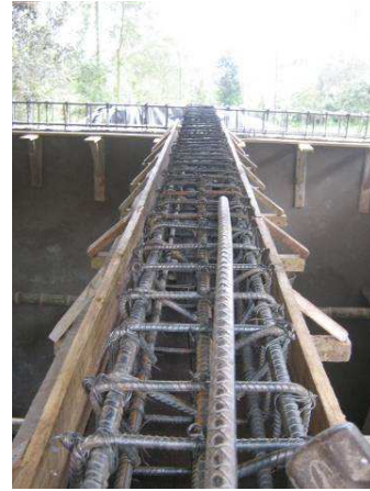
Figura No 66. Refuerzo para parrilla de tapa en metaldeck y vigas
