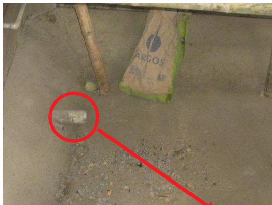
Figura No 74. Tubería de salida 3"
