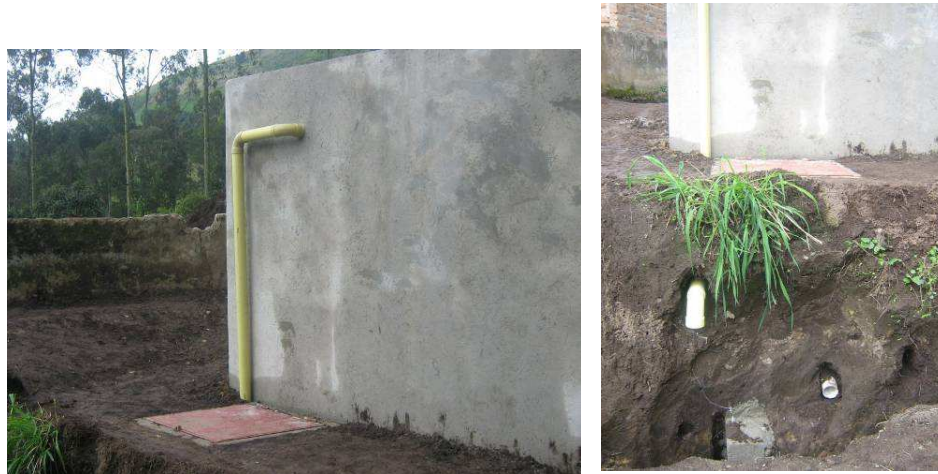
Figura No 78. Tubería de rebose 3"
