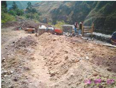
Figura No 38. Material con sobretamaños que se hizo retirar del sitio
