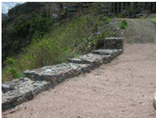
Figura No 44. Gaviones terminados
