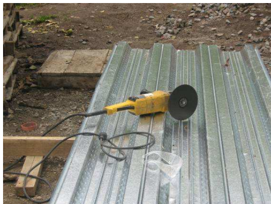
Figura No 65. Láminas de Metaldeck
