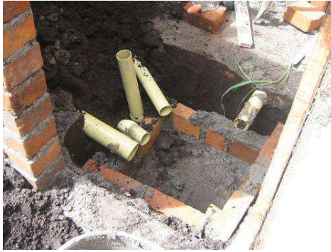
Figura No 103. Caja de inspección
