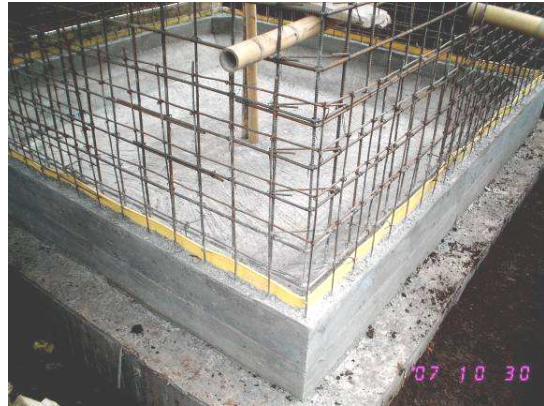
Figura No 60. Refuerzo de paredes
