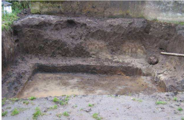
Figura No 55. Excavación para tanque.
