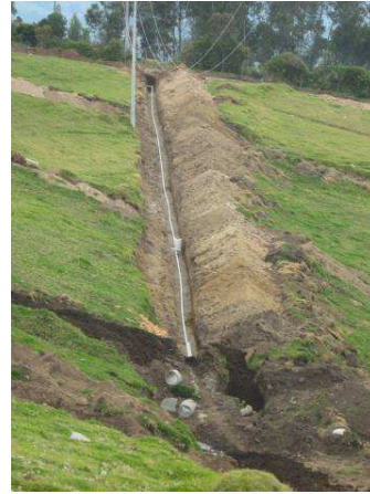
Figura No 82. Instalación de tubería
