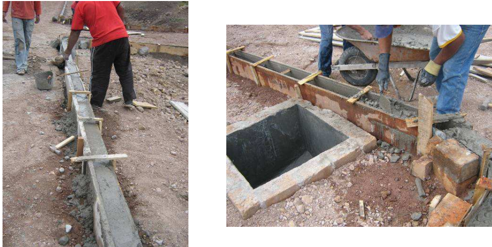
Figura No 45. Fundición de sardineles
