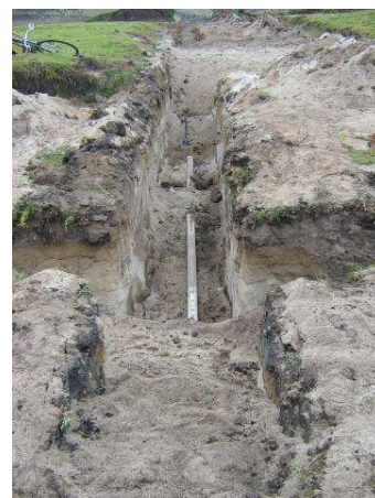
Figura No 85. Relleno de zanjas
