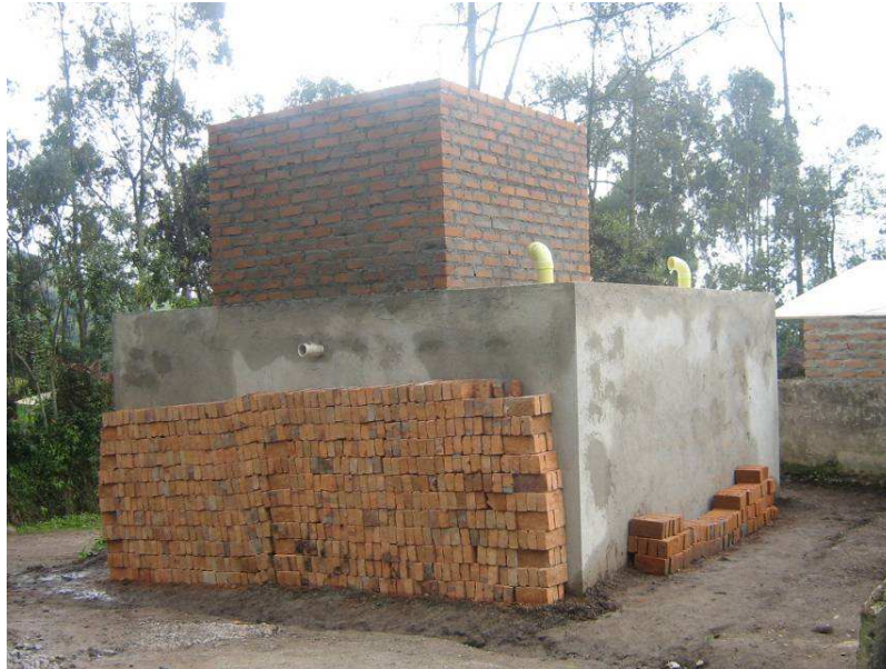
Figura No 51. Panorama del Tanque de almacenamiento terminado
