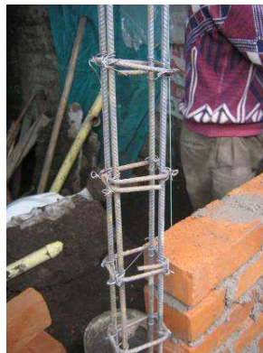
Figura No 102. Refuerzo para columna
