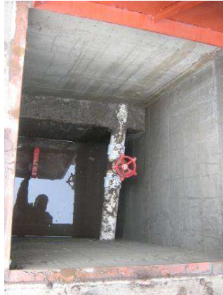
Figura No 72. Cajilla de inspección para válvulas
