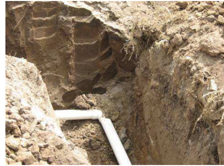
Figura No 84. Instalación de codo 90°
