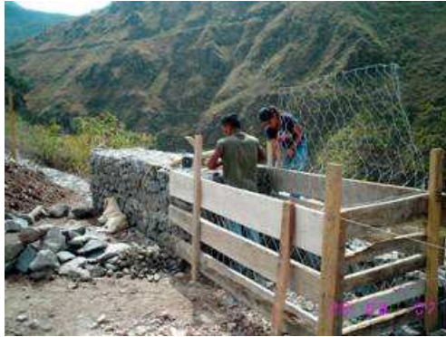
Figura No 42. Armado de canastillas para construcción de gaviones
