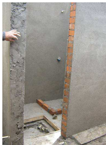
Figura No 94. Repello de pisos y muros
