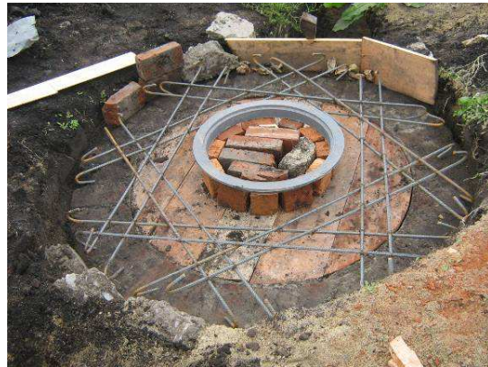
Figura No 8. Formaleta y refuerzo para tapas
