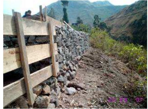
Figura No 42. Armado de canastillas para construcción de gaviones
