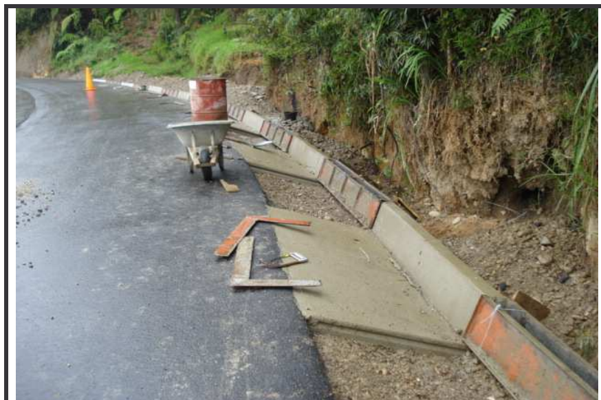
Figura 33. - Construcción intercalada de cunetas
