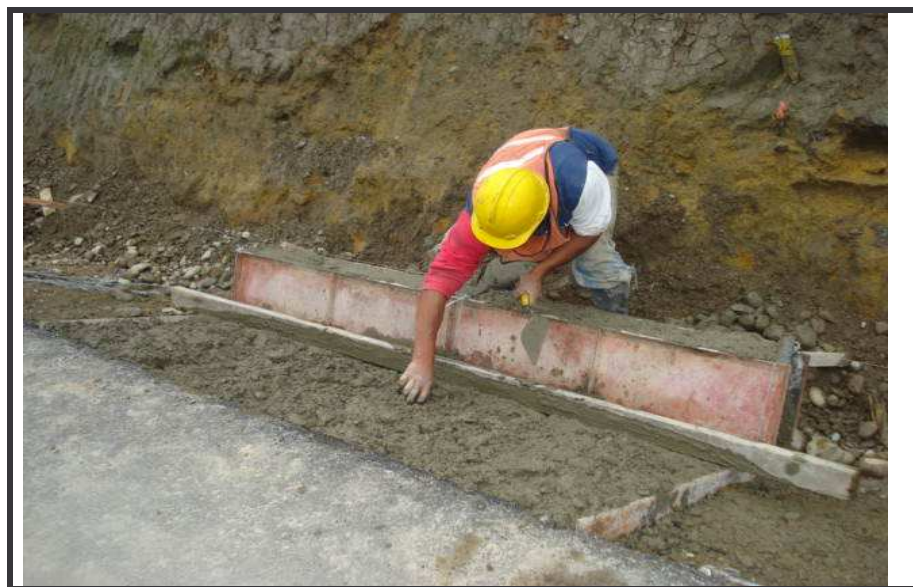
Figura 31. - Construcción de la cuneta
