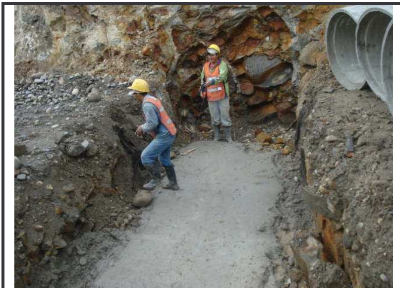
Figura 18. - Excavación y solado tubería tramo 2,
