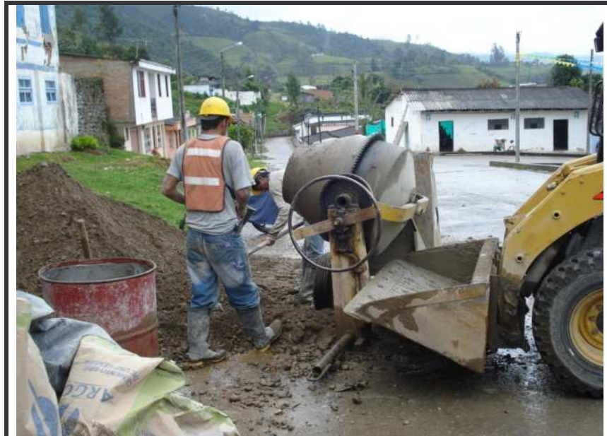
Figura 30. - Producción y transporte de concreto
