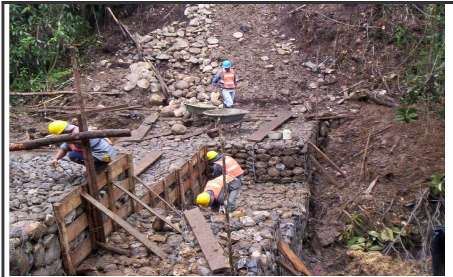
Figura 44.- Construcción nivel 2 y 3
