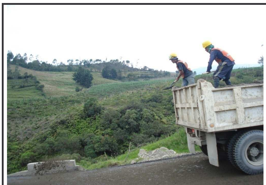
Figura 48. - Venteo de arena para habilitar el carril al trafico
