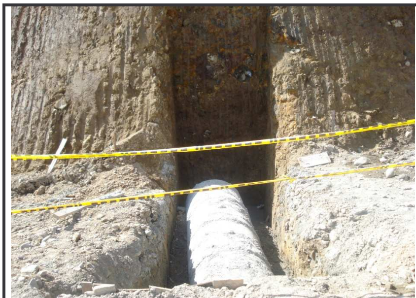
Figura 20. - Atraque y solado caja de entrada
