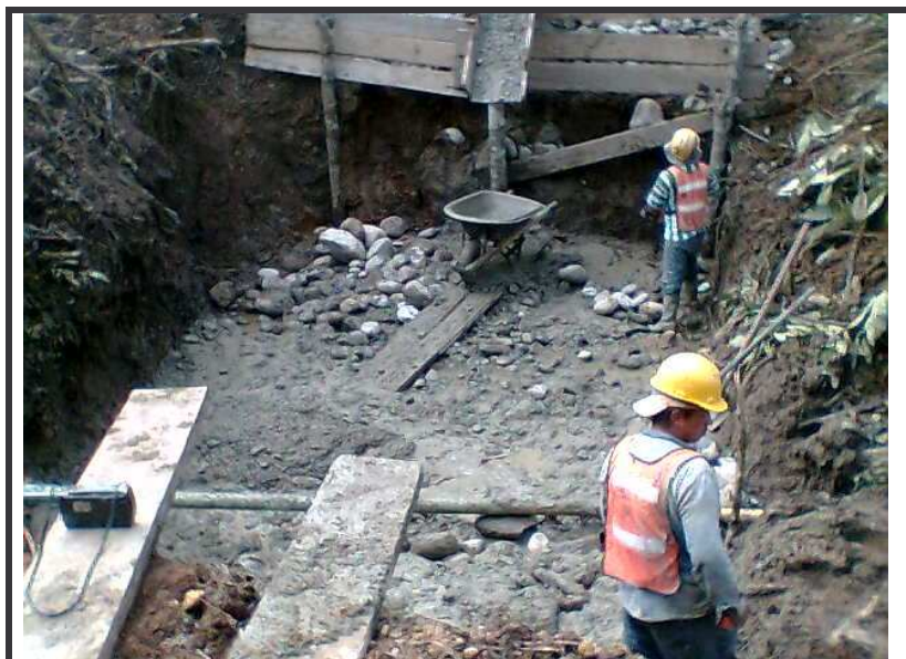
Figura 41. - Construcción de solado de Limpieza.
