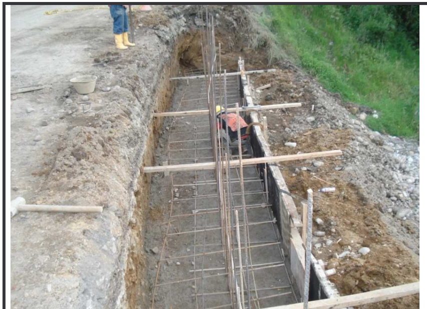
Figura 36. - Acero de refuerzo muro. K44+420
