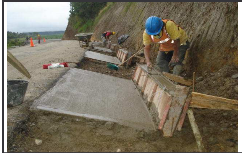
Figura 32. - Labores de terminado
