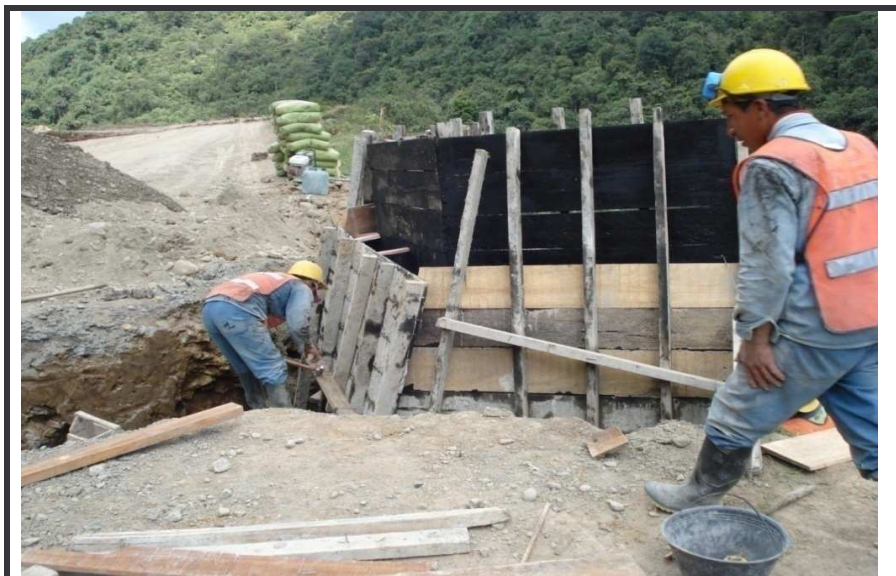
Figura 16. - Encofrado de cabezal de salida (aletas)
