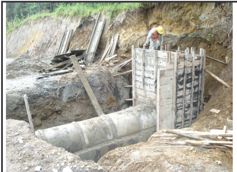
Figura 21. – Encofrado y fundición caja de entrada
