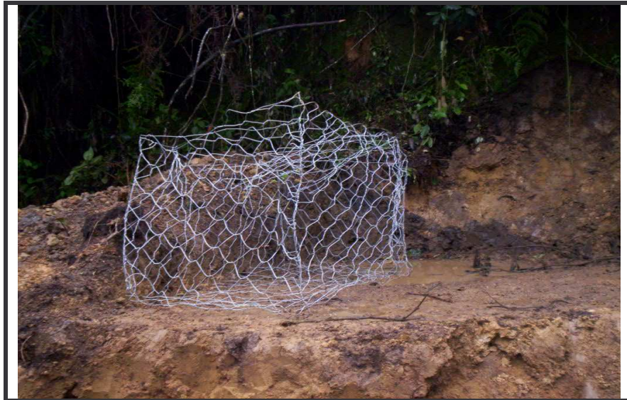
Figura 42. - Armado de las mallas
