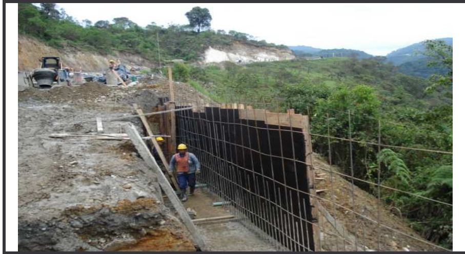
Figura 37. - Inicio encofrado Vástago sección 1. K44+420
