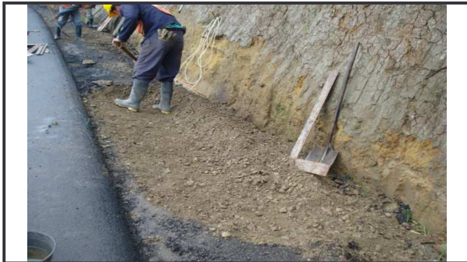
Figura 28. - Acondicionamiento de la superficie de fundación
