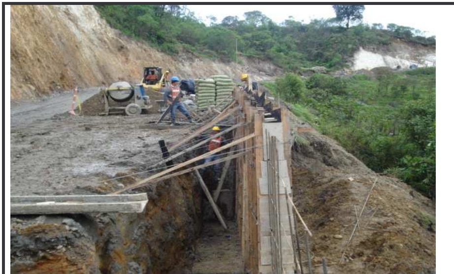
Figura 38.- Encofrado y fundición de vástago muro K44+420.
