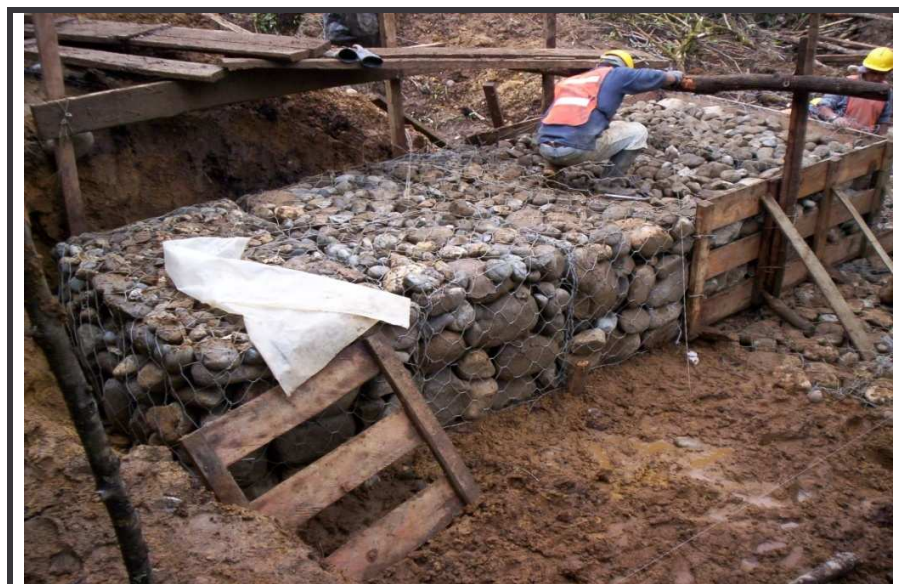
Figura 43. - Relleno de las mallas – muro primer nivel
