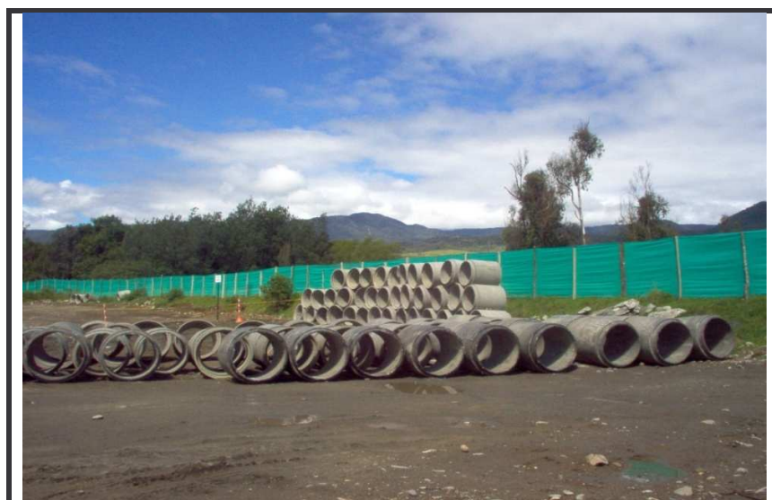
Figura 12. - Almacenamiento de tubería
