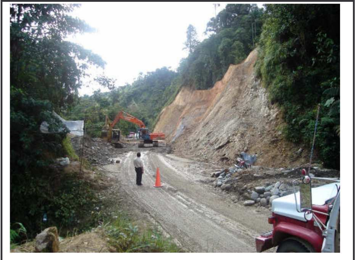
Figura 4. – Estado actual de la carretera el encano - santiago
