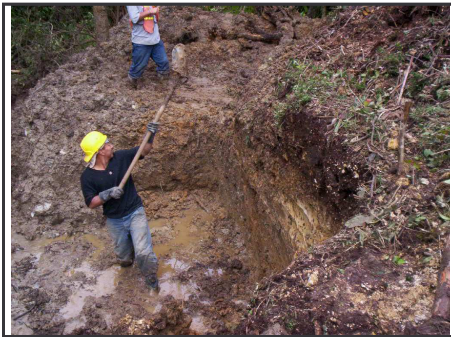
Figura 40. - Excavación para cimentación
