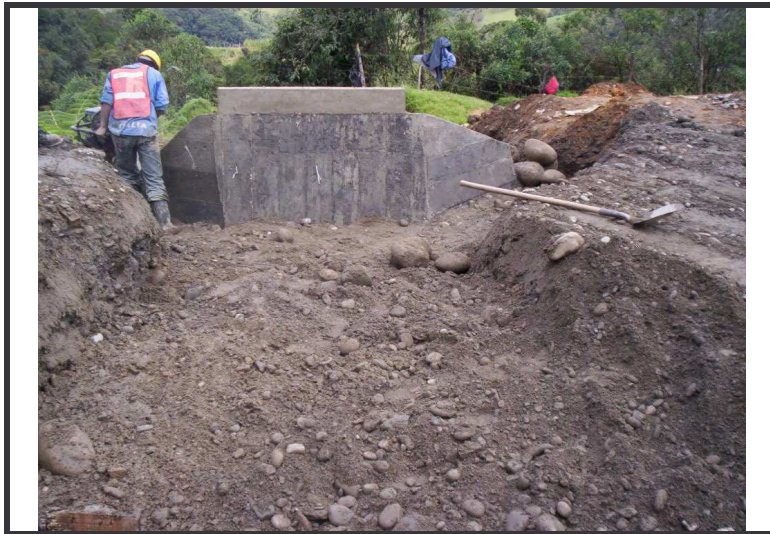
Figura 17. - Rellenos estructurales
