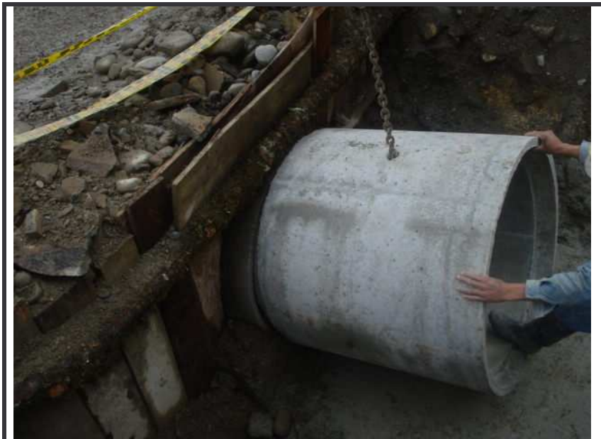
Figura 19. - Instalación tubería tramo 2
