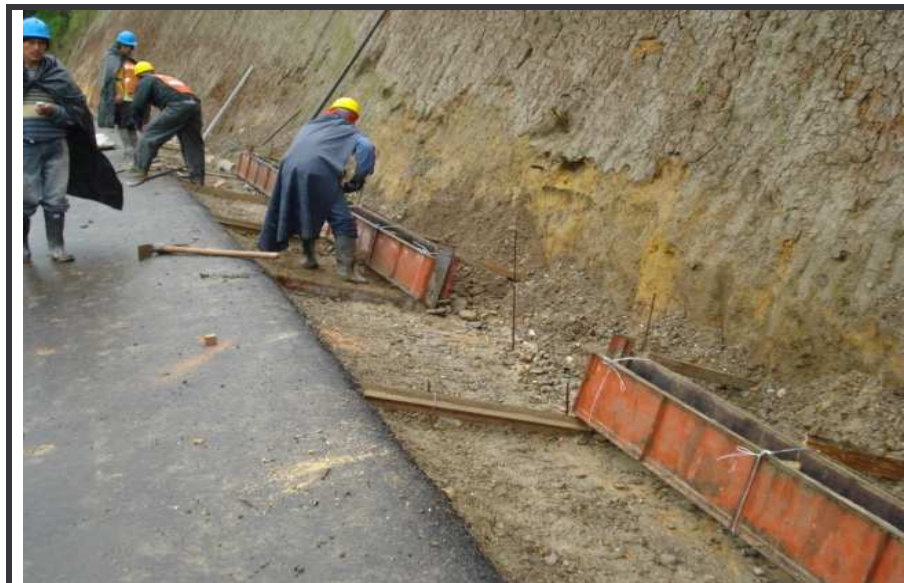
Figura 29. - Instalación de formaleta para cunetas
