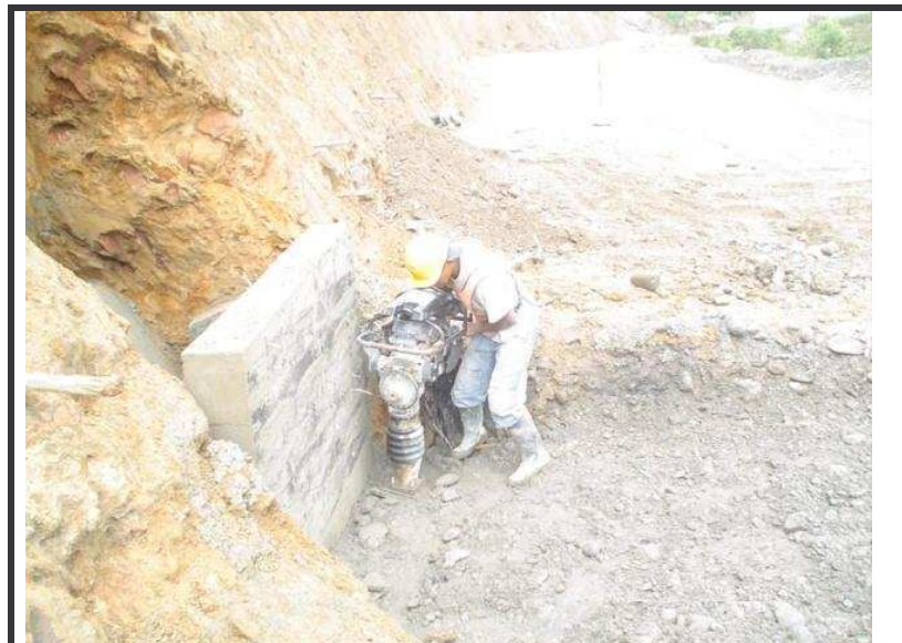
Figura 22. - Relleno tubería tramo 2 – fin de obra
