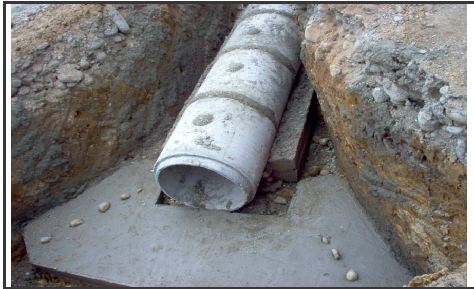
Figura 15. - Atraque, sello de juntas y solado cabezal de salida
