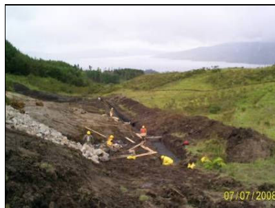
Figuras 97. Construcción de filtros: depósito No 010 k27+800
