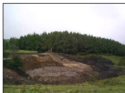
Figura 81. Panorámica: Depósitos No 010 k27+800
