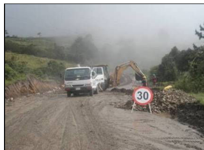
Figuras 108. Suministro de ACPM en el corredor vial
