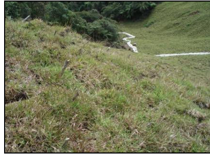
Figuras 120. Cespedones con estacas – Dep. 008
