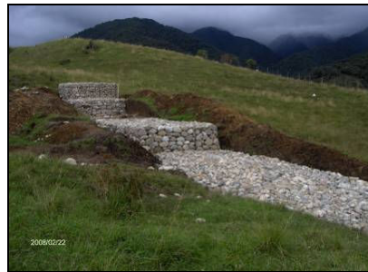
Figuras 114. Estabilización de taludes k41+900
