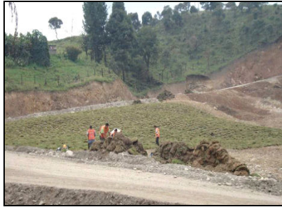
Figuras 119. Empradización Dep. 007 – cespedones
