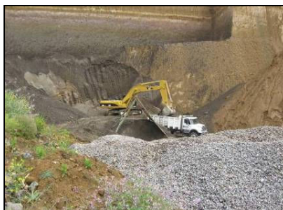
Figura 68. Panorámica mina El Hueco - Catambuco
