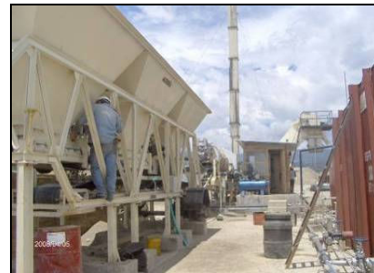
Figura 129. Instalación de la Planta de Asfaltos de Contraflujo TEREX.
