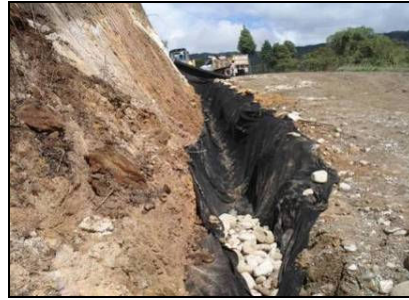
Figuras 101. Construcción de filtros: zona de ampliación – y k41+080
