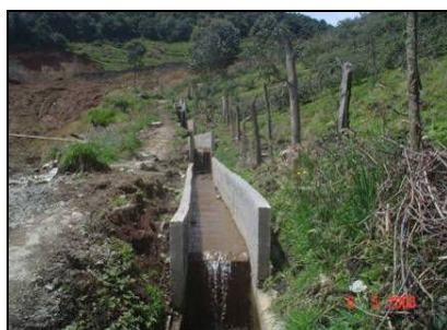
Figuras 92. Canal perimetral Dep. No 008
