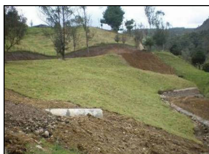
Figura 78. Panorámica: Depósitos No 007 k25+300
