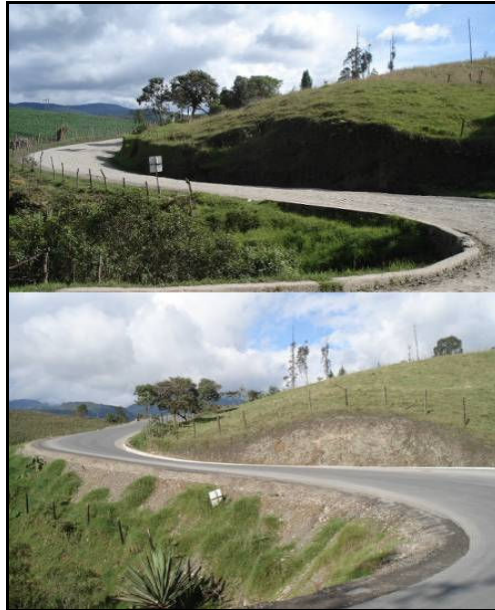
Figura 6. Estado de la vía antes y después de ser intervenida – k50+200
