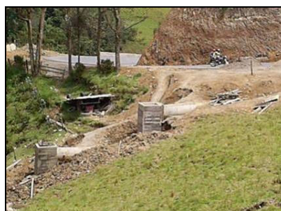
Figuras 93. Prolongación de alcantarilla Dep. 007
