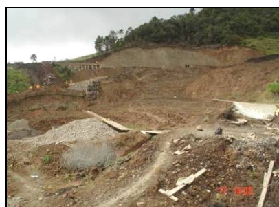
Figura 79. Panorámica: Depósitos No 008 k26+400
