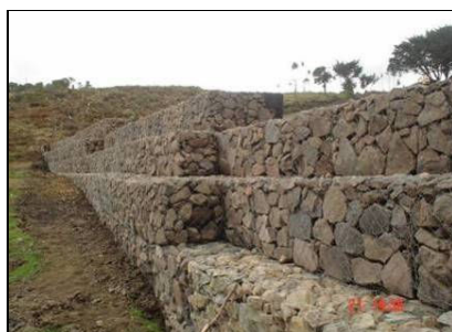
Figuras 111. Muro de contención depósito No 009 k27+300
