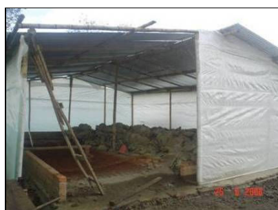
Figura 75. Bodega para almacenamiento temporal de residuos.
