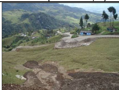
Figura 83. Panorámica: Depósitos No 007 k45+500
