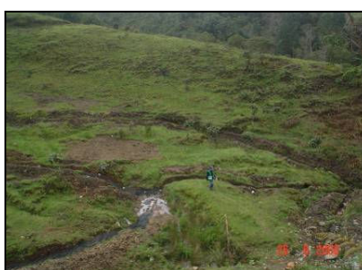
Figura 144. Verificación del funcionamiento de los filtros – depósito No 010 k38+960
