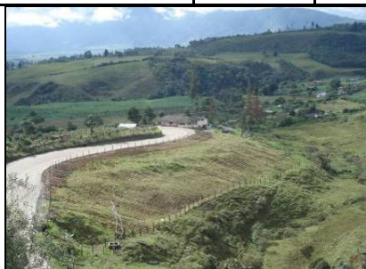
Figura 82. Panorámica: Depósitos No 005 k48+280
