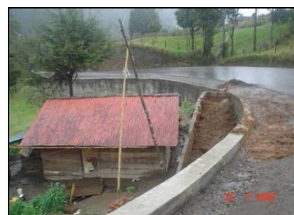
Figura. 59. Adecuación del acceso a la vivienda de la señora Zamboni
