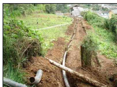
Figura 65. Traslado de la tubería de acueducto de Santiago.
