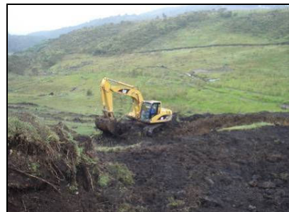
Figuras 116. Descapote en el Dep. No 010 k27+800
