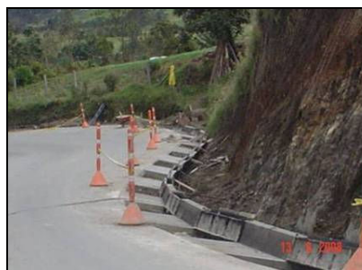
Figuras 95. Manejo de corrientes de agua: construcción de cunetas k24+380
