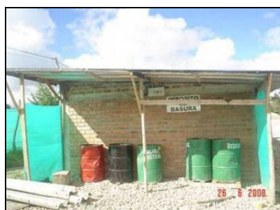
Figura 77. Depósito y clasificación de residuos sólidos.
