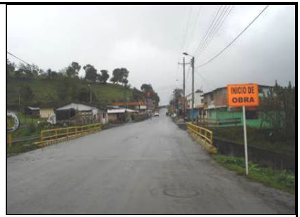
Figura 19. Panorámica del barrio Av. Oriente – El Encano – inicio de obra.
