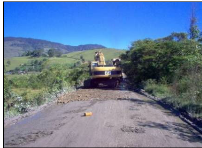
Figura 71. Explotación río San Pedro adecuación de vías de acceso
