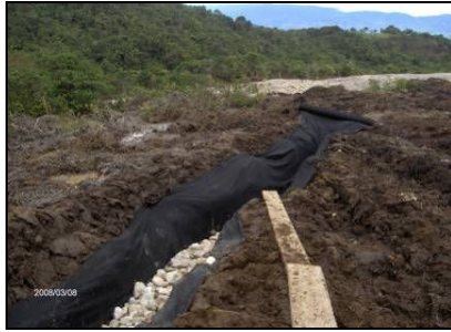
Figuras 100. Construcción de filtros: depósito No 009 k41+860
