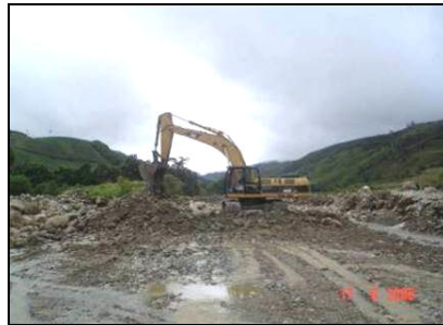
Figura 70. Explotación río San Pedro Sector norte – jarillón –
