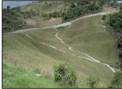
Figura 84. Panorámica: Depósitos No 008 k46+500
