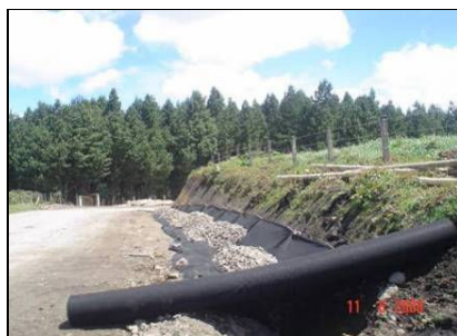
Figuras 96. Construcción de filtros: k28+500
