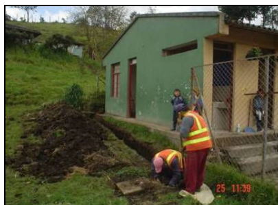
Figura 63. Construcción de filtros Escuela Campo Alegre
