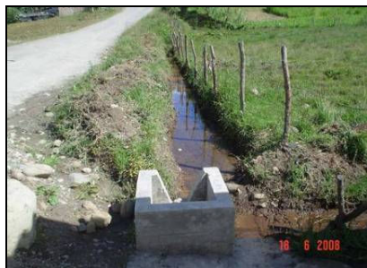
Figura 139. Inspección de la limpieza general de canales
