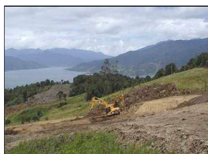
Figura 80. Panorámica: Depósitos No 009 k27+300
