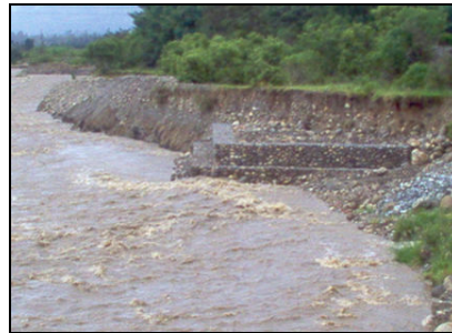
Figura 72. Explotación río San Pedro, construcción de muro de contención – gaviones -
