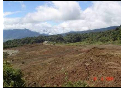
Figura 85. Panorámica: Depósitos No 009 k42+000
