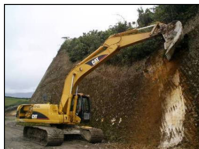
Figuras 112. Estabilización de taludes k30+160
