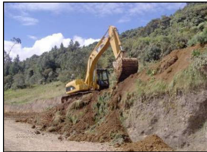
Figuras 113. Muro de contención depósito No 007 k45+500
