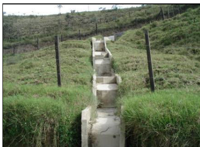
Figuras 98. Manejo de corrientes de agua: Disipador de energía k48+000
