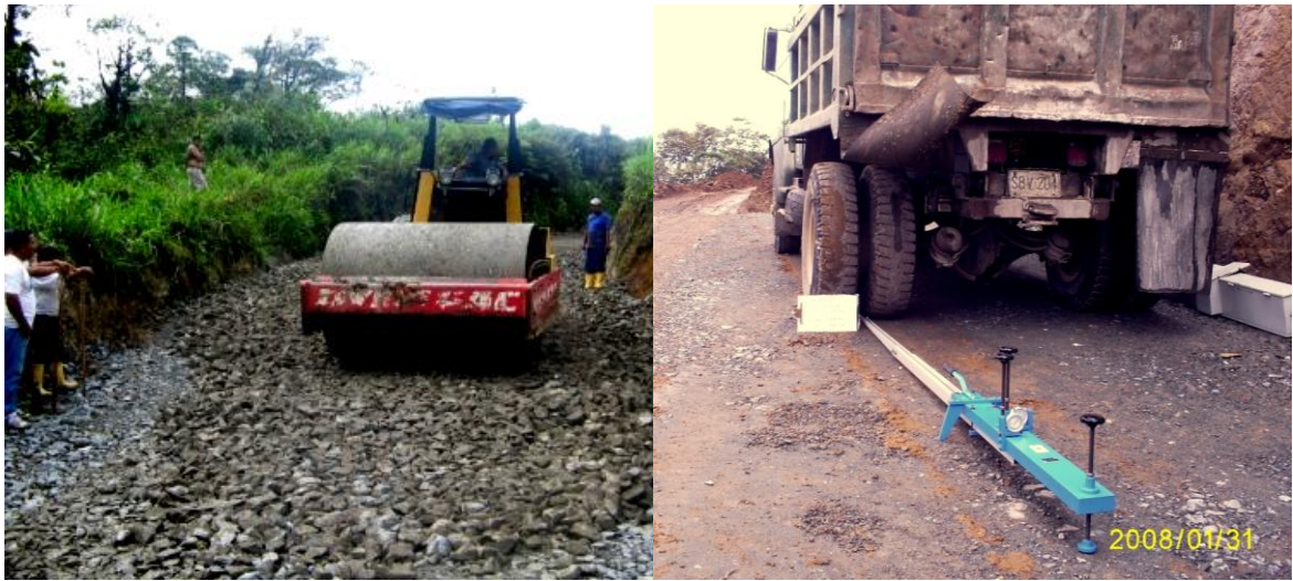
Figura No III.3. Fase de experimentación para verificar la cantidad de energía de compactación.
