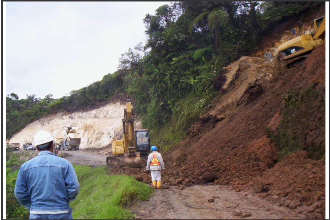
Figura 12. Supervisión de los trabajos de corte de talud. K43+500
