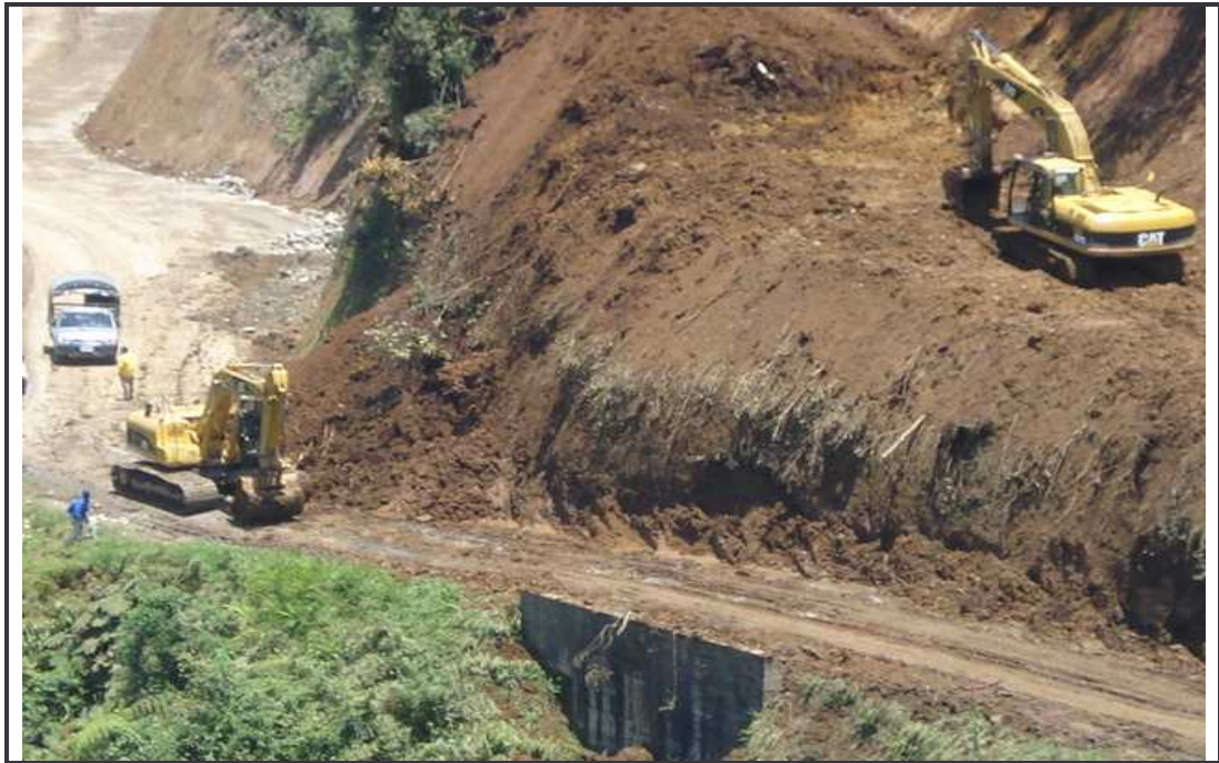
Figura 14. Limpieza de la calzada. K43+300
