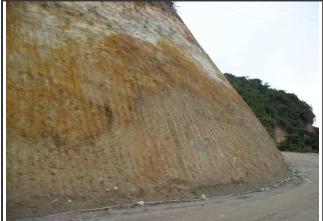
Figura 15 Superficie final de talud. K44+350
