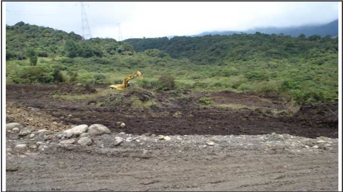
Figura 30. Desmonte limpieza y descapote zona de depósito. K42+000
