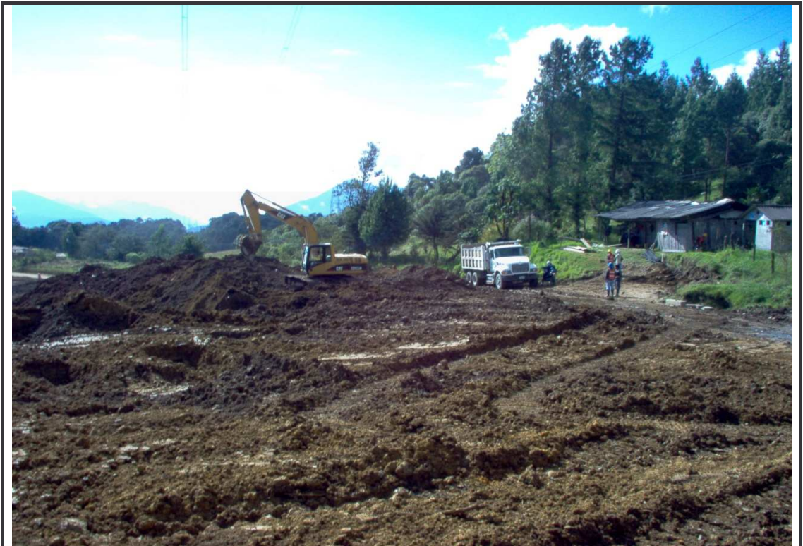
Figura 36. Conformación de depósito con 320C. K42+000
