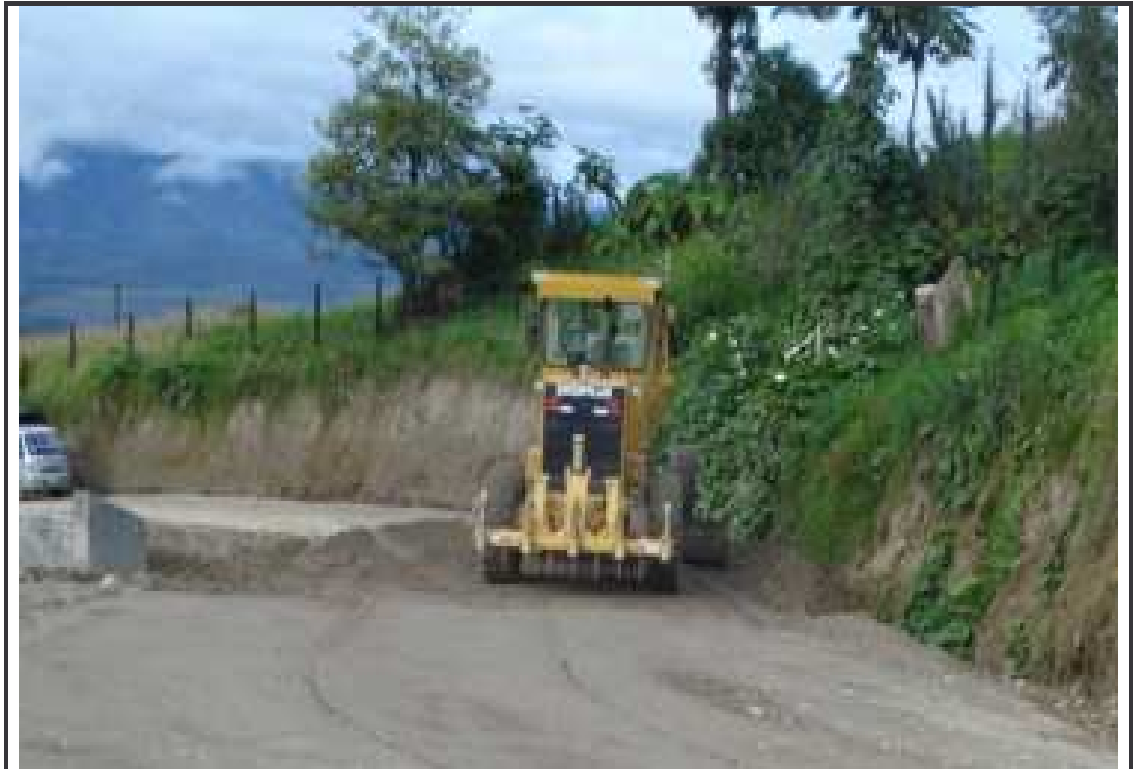
Figura 57. Extendido material de subbase. K45+700
