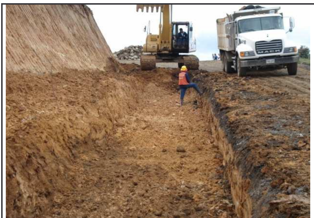
Figura 16. Excavación o cajeo. K47+800
