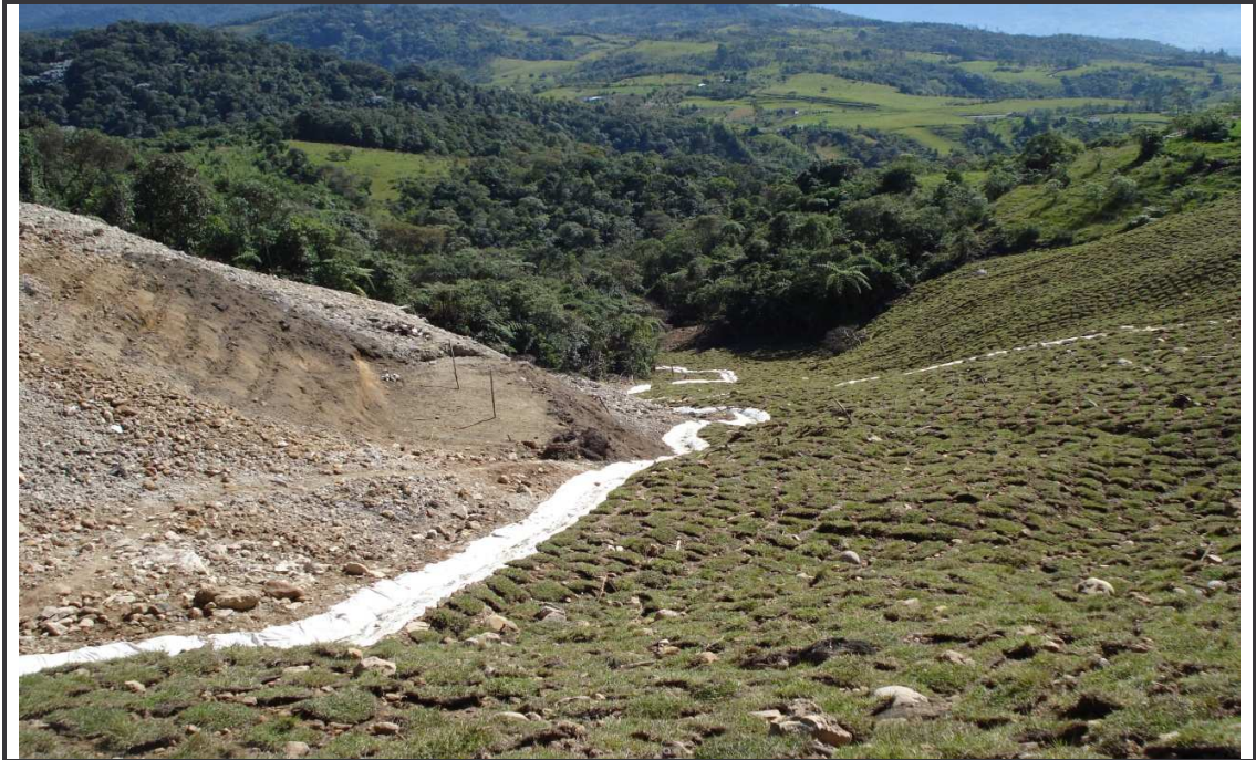
Figura 37. Empradización de depósito. K46+500
