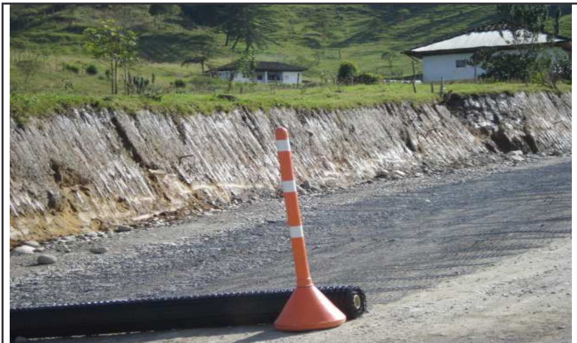
Figura 49. Colocación geomalla biaxial K46+700
