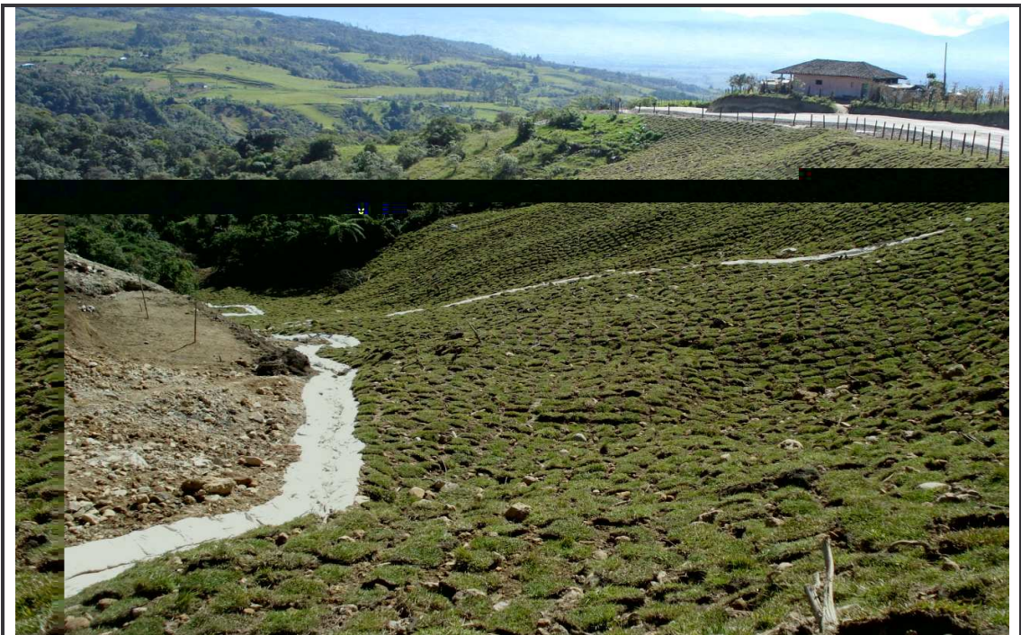
Figura 38. Empradización de depósito. K46+500
