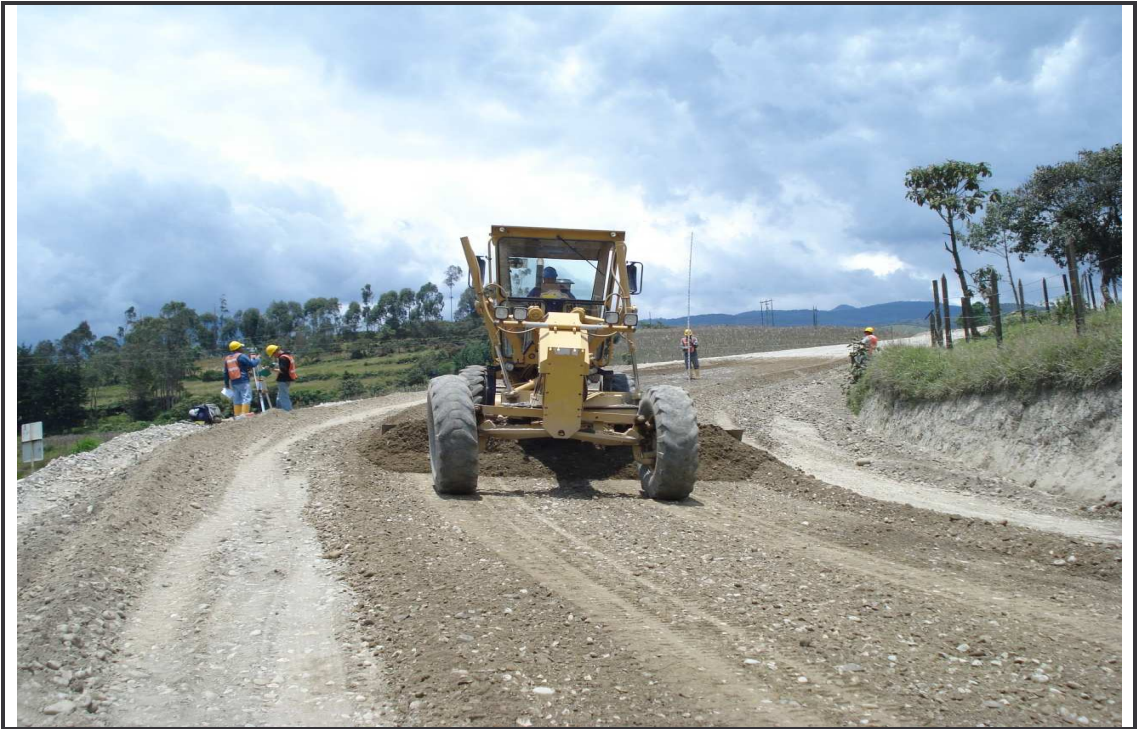
Figura 61. Cereo capa de subbase K50+100
