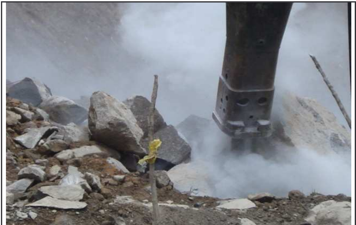
Figura 21. Excavación de roca para ampliación de calzada. K43+200
