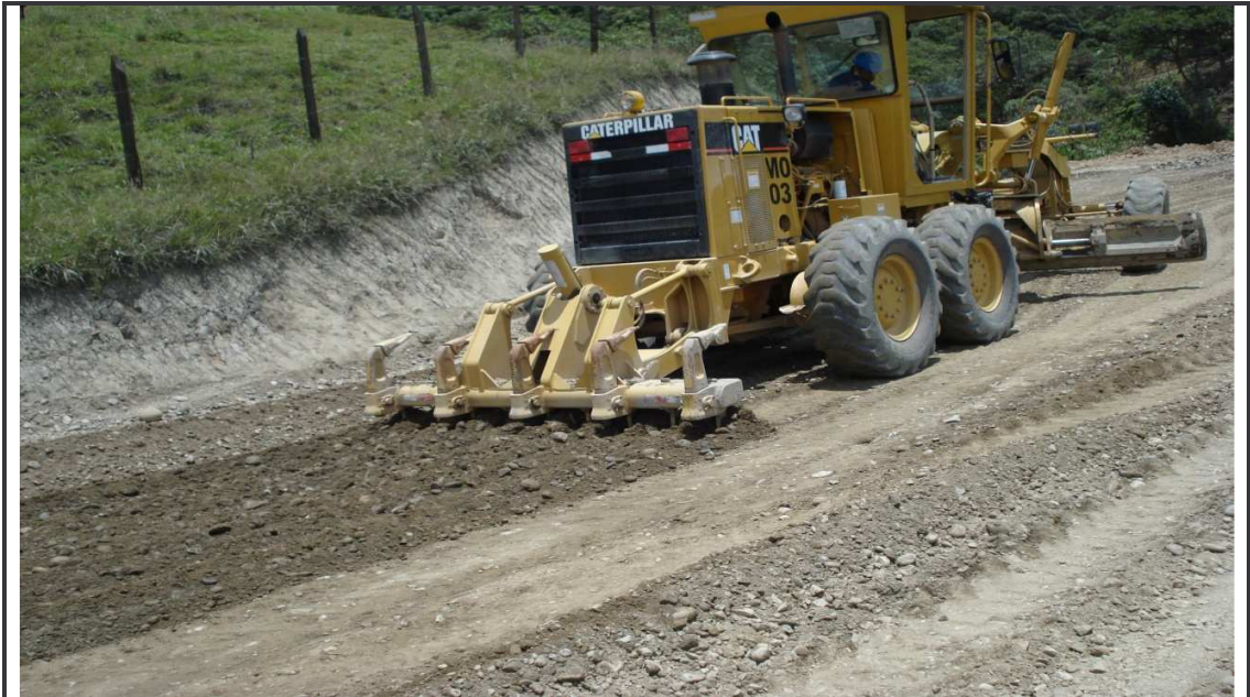
Figura 44. Escarificación de material existente de subrasante. K49+500
