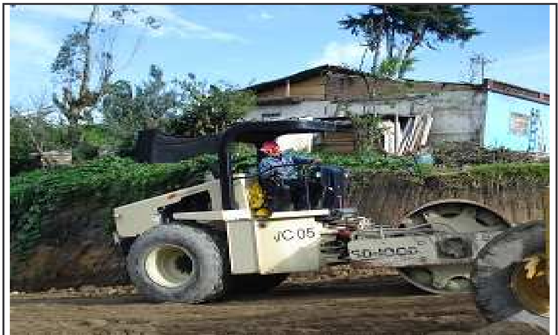
Figura 46. Compactación capa mejoramiento de subrasante. K45+550
