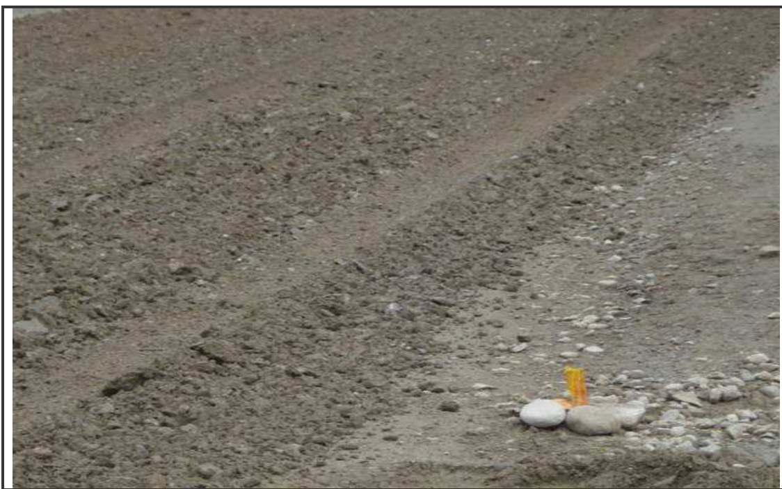
Figura 56. Taco de nivel para extendido de subbase
