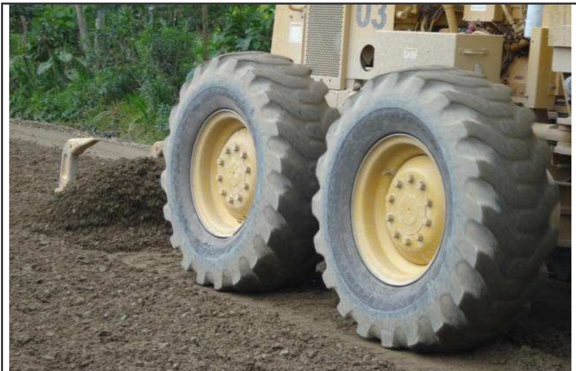
Figura 59. Escarificación de material K48+450
