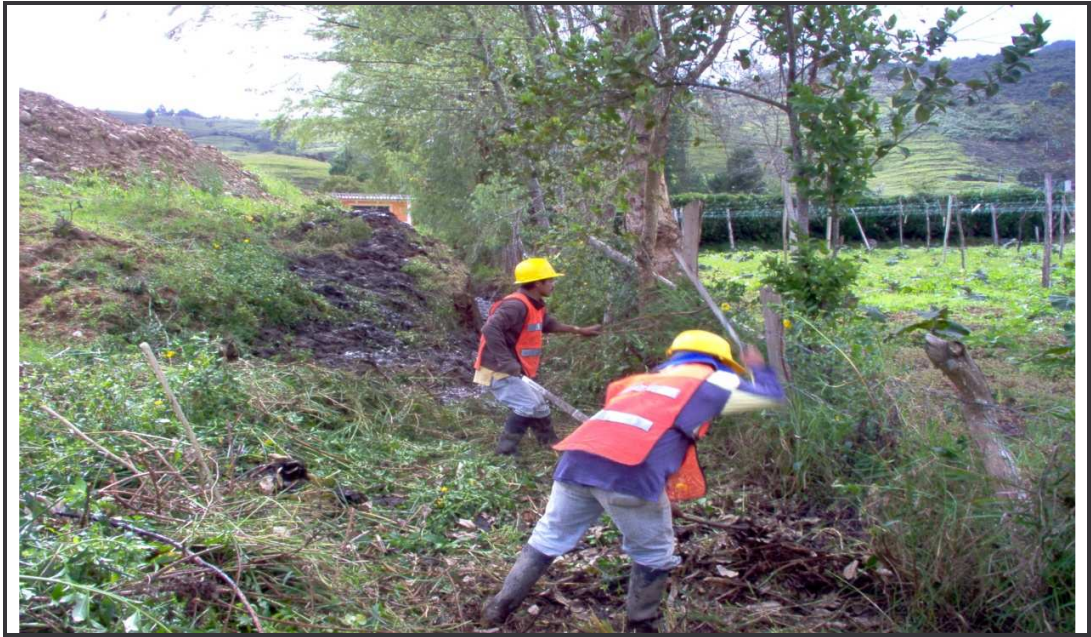
Figura 7. Desmonte y limpieza de forma manual K48+600
