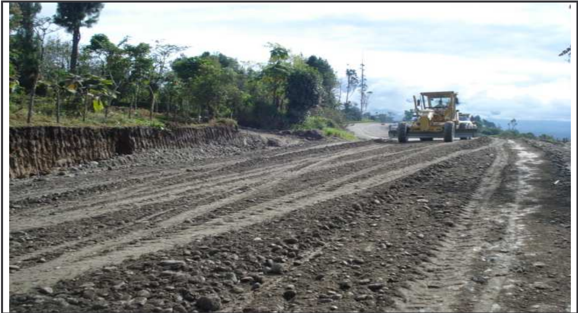
Figura 45. Extendido de material para mejoramiento de subrasante. K49+500
