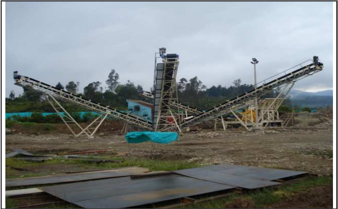
Figura 50. Planta de trituración caldehusa. Ubicada en el río Quichoa
