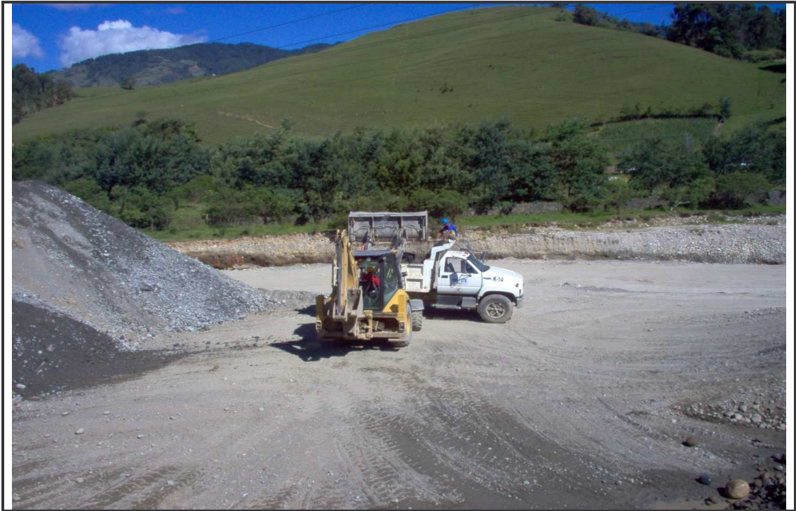
Figura 42. Cargue de material a las volquetas que salen al sitio de obra
