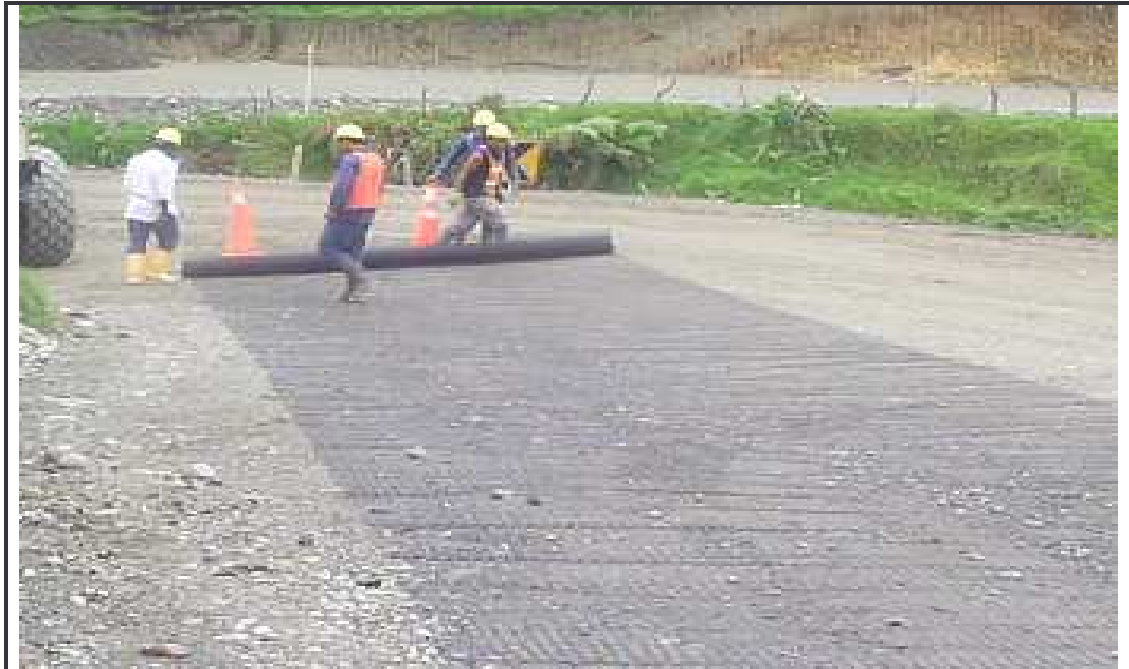
Figura 48. Colocación geomalla biaxial. K46+700
