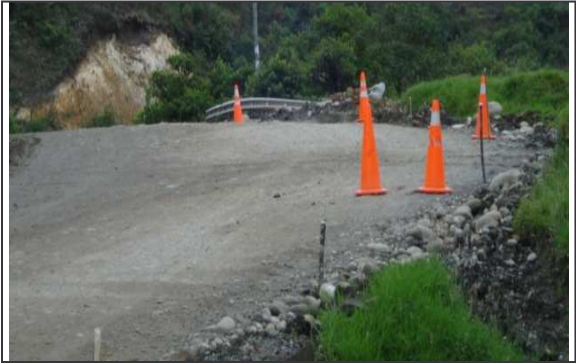
Figura 43. Tacos para nivel de subrasante. K44+800
