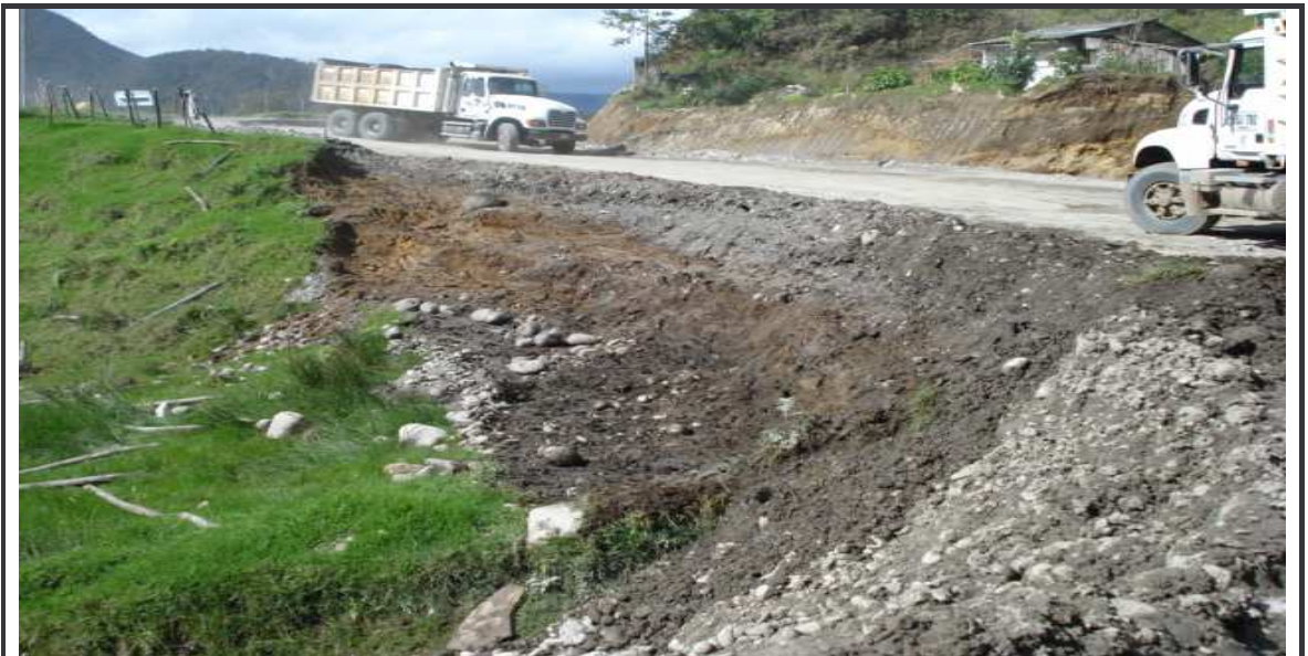
Figura 26. Transporte del material de descapote y excavación hacia el área de depósito. K45+270
