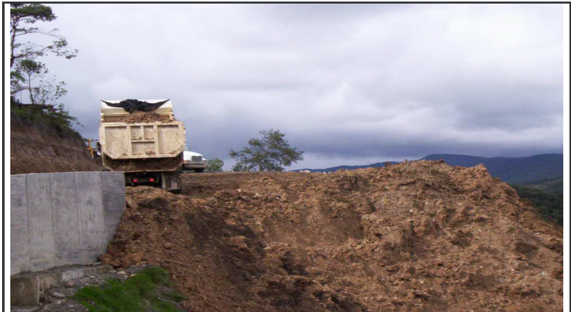
Figura 13. Disposición de material en el deposito No. 8 K 46+500
