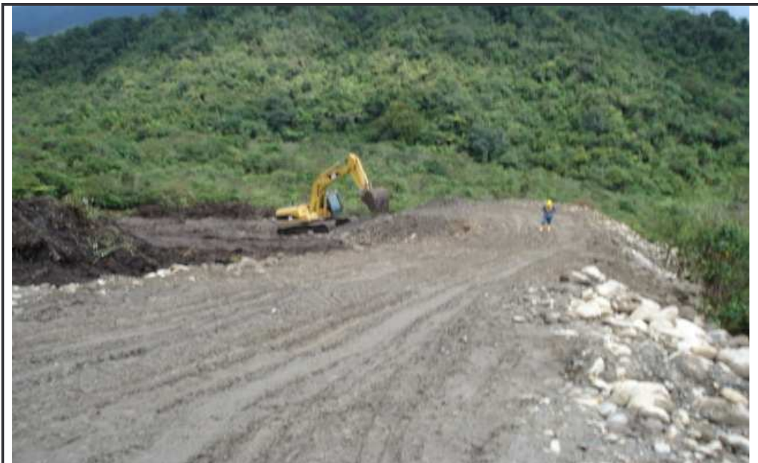
Figura 33. Construcción de dique para depósito. K42+000
