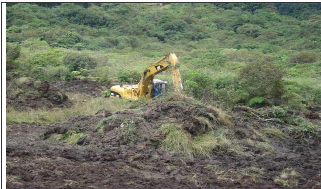
Figura 8. Desmante y limpieza con la excavadora 320C. K42+100
