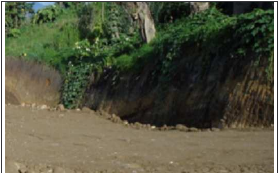
Figura 47. Nivel final de subrasante. K45+550
