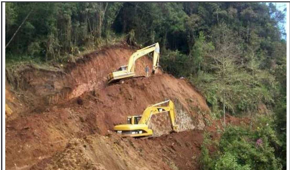
Figura 11. Corte de talud utilizando 2 excavadoras 320C. K43+500
