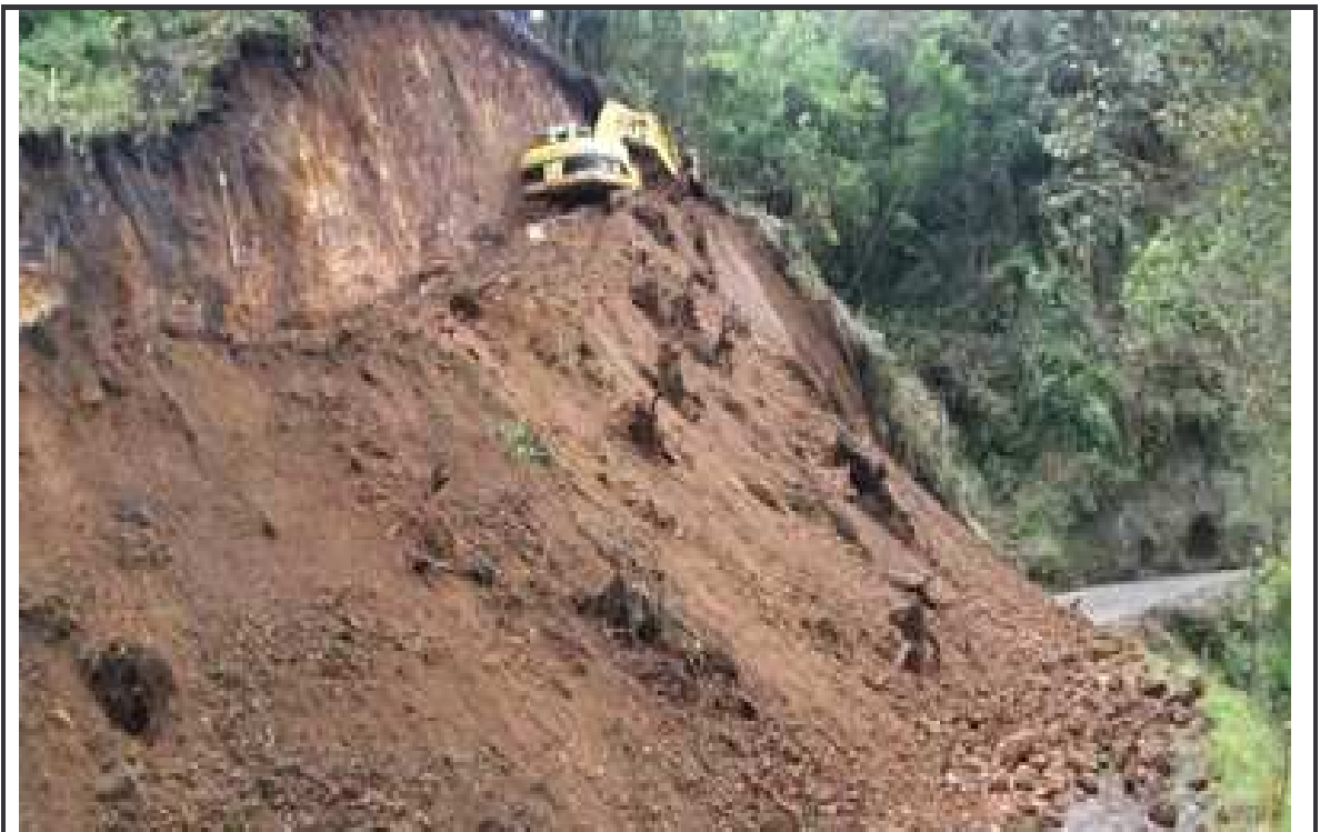
Figura 10. Corte de talud. K43+600
