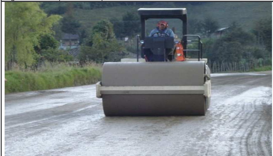
Figura 64. Compactación capa de base. K48+480
