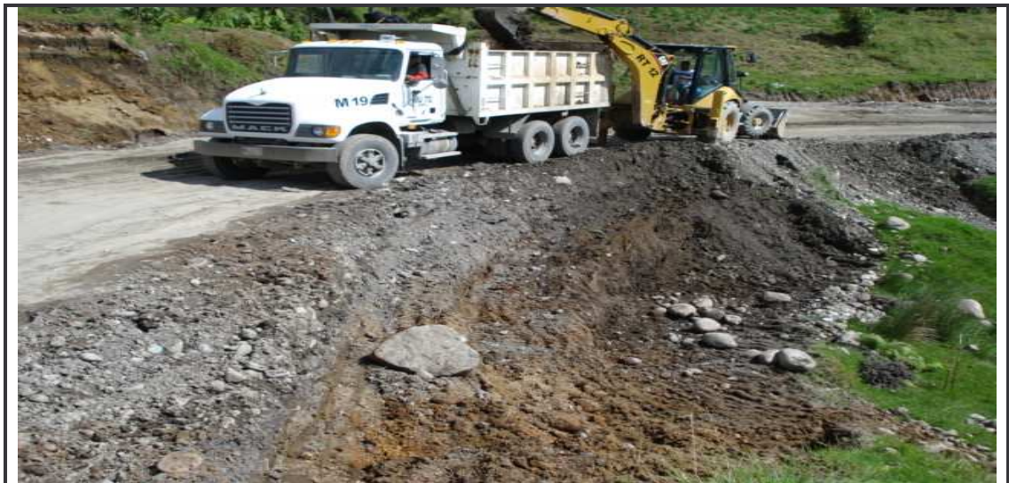
Figura 24. Descapote y excavación del área de ladera. K45+270
