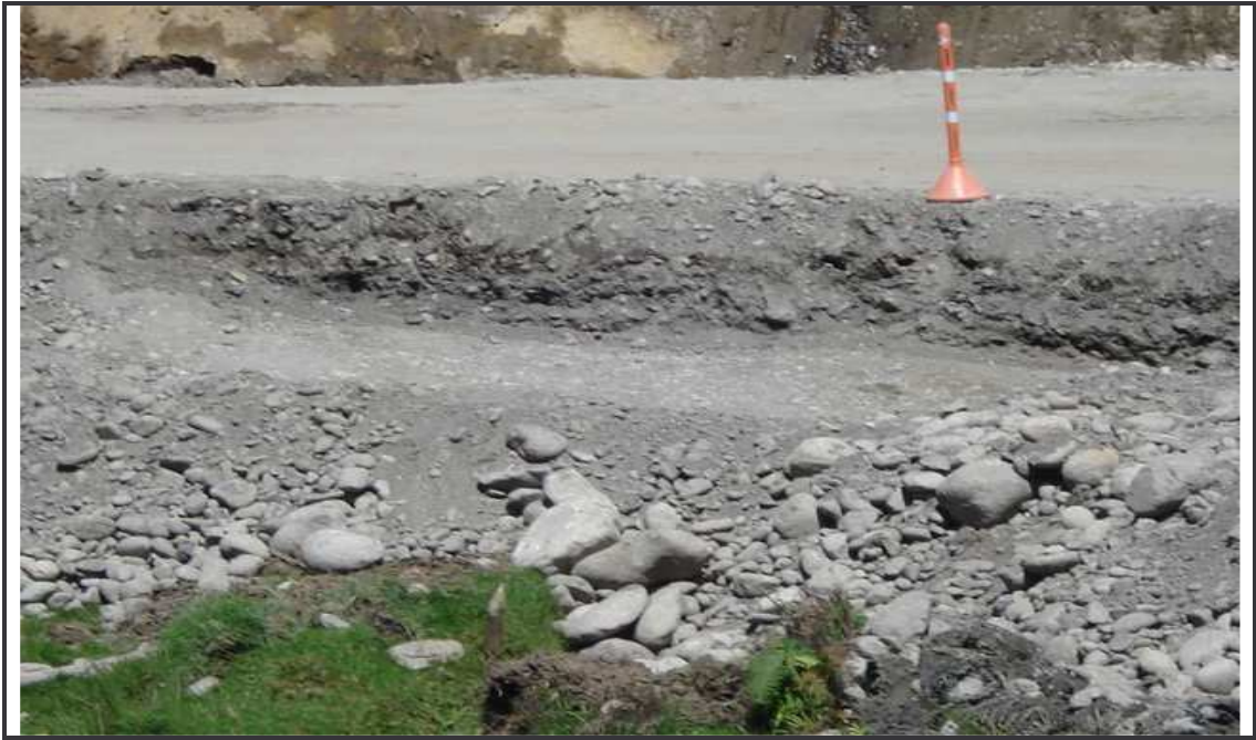
Figura 28. Capas compactadas. K45+270
