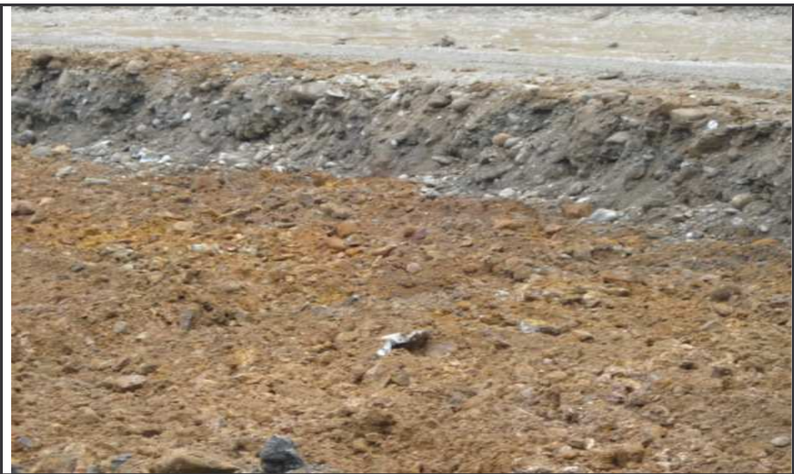
Figura 18. Culminación de la excavación o cajeo. K46+800
