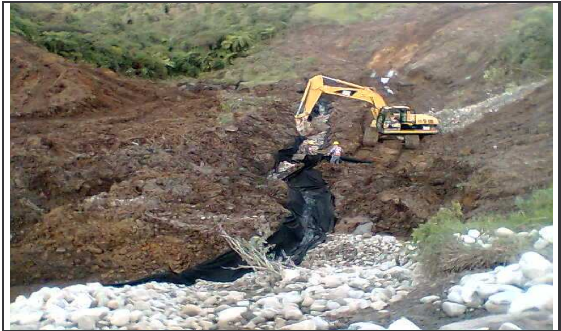
Figura 32. Construcción de filtro para depósito. K46+500
