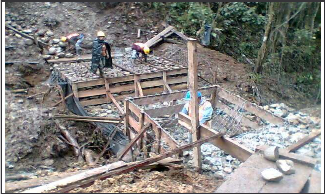
Figura 34. Construcción de muro en gaviones para depósito. K46+500
