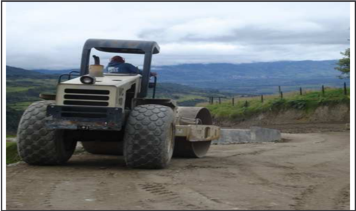
Figura 63. Compactación capa de subbase. K45+700
