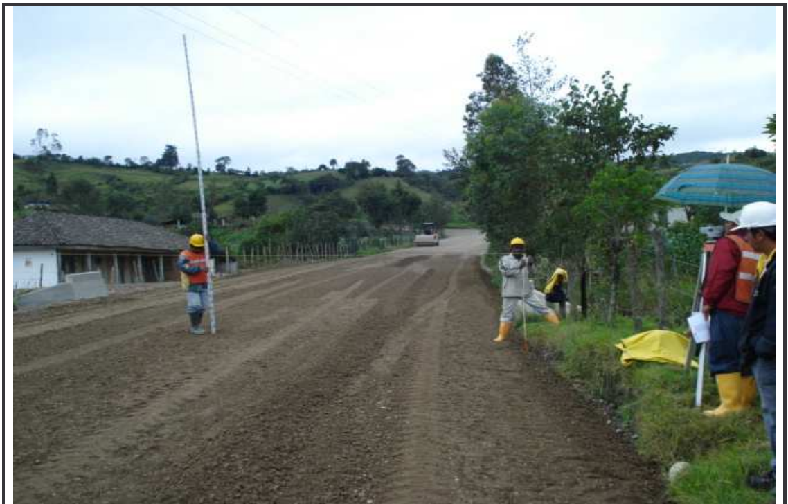
Figura 62. Cereo capa de base. K48+480
