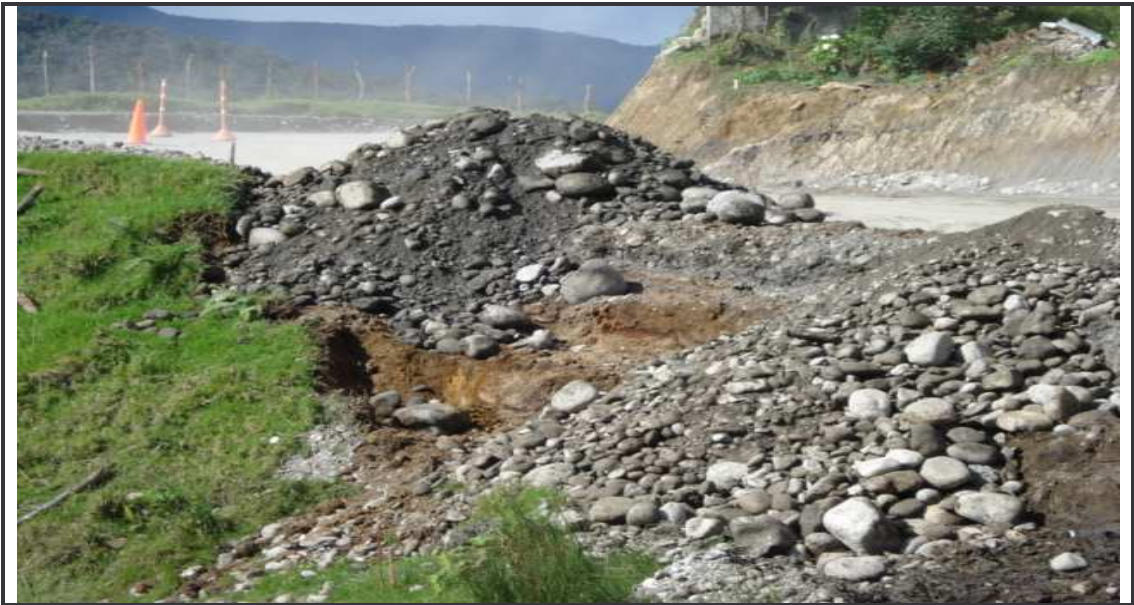
Figura 27. Colocación de material de pedraplén. K45+270
