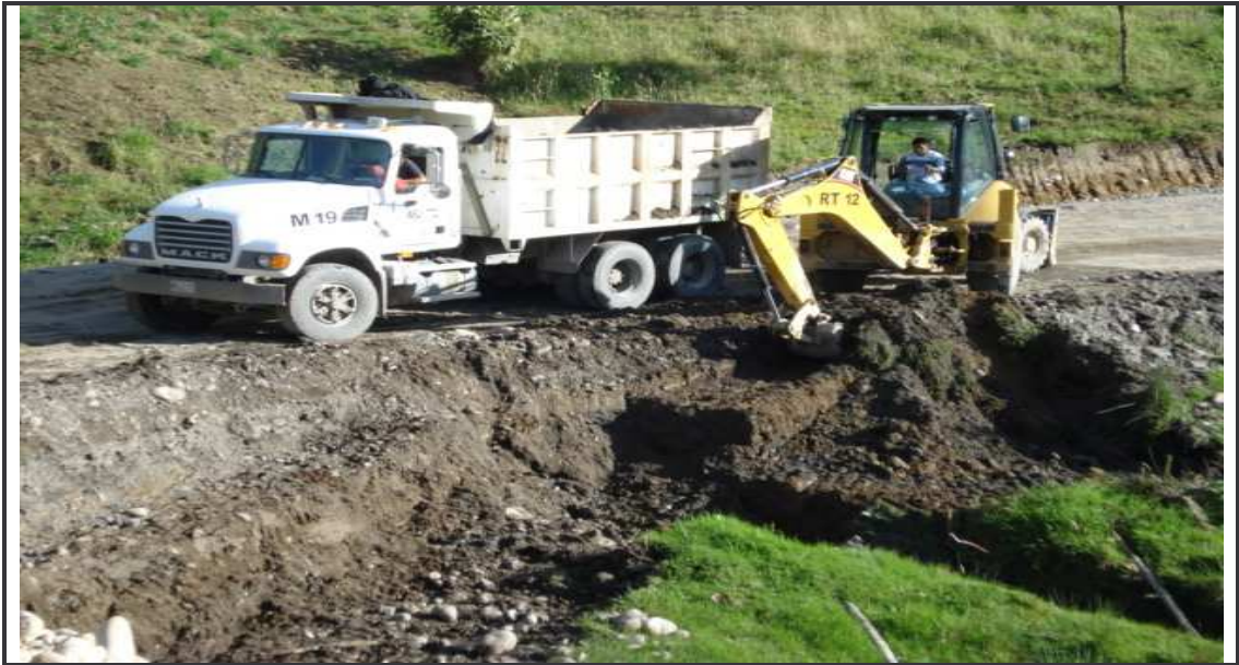
Figura 25. Excavación de manera escalonada. K45+270
