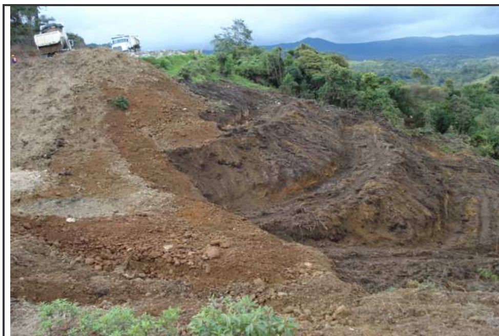
Figura 9. Disposición de material en el deposito No. 8 K 46+500
