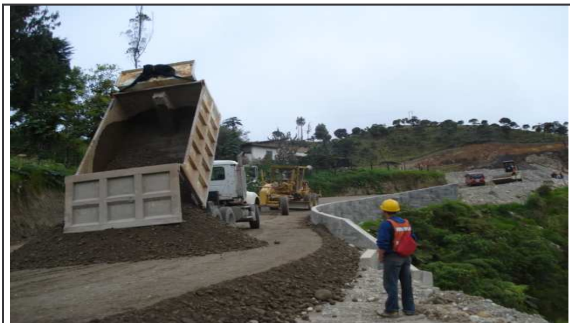
Figura 54. Transporte de material para colocación de subbase. K45+700
