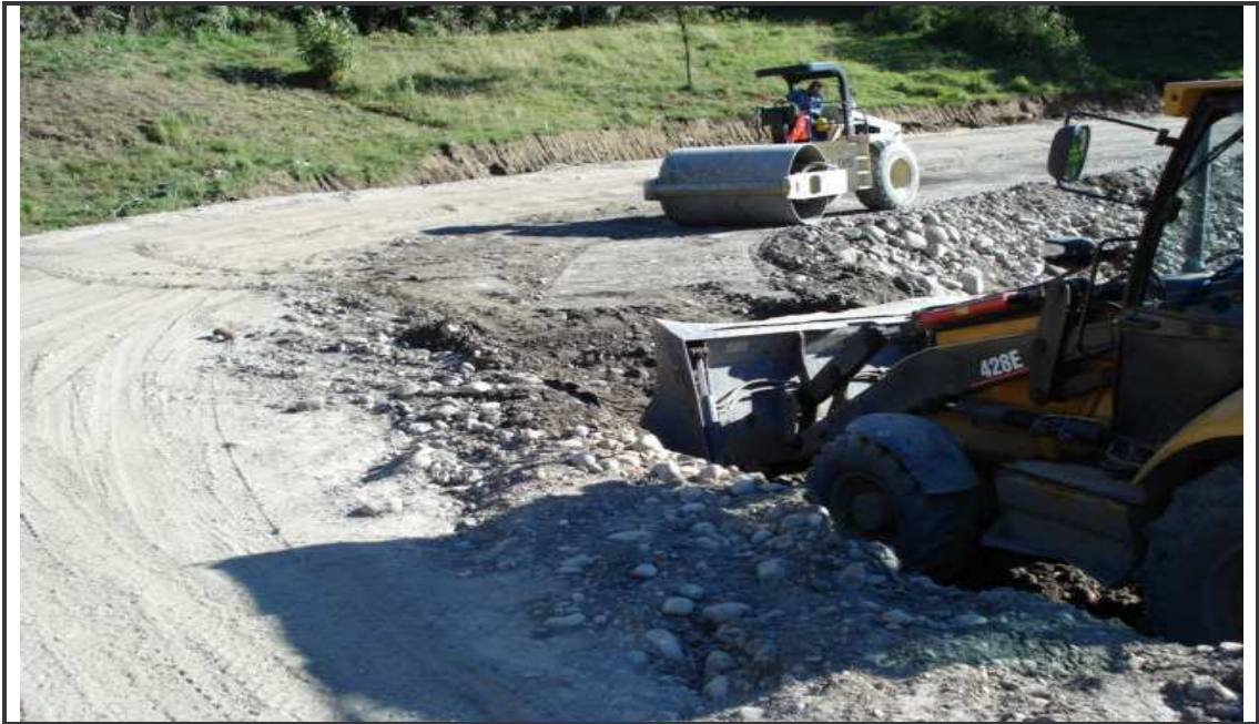
Figura 29. Acabado final de pedraplén de ladera K45+270
