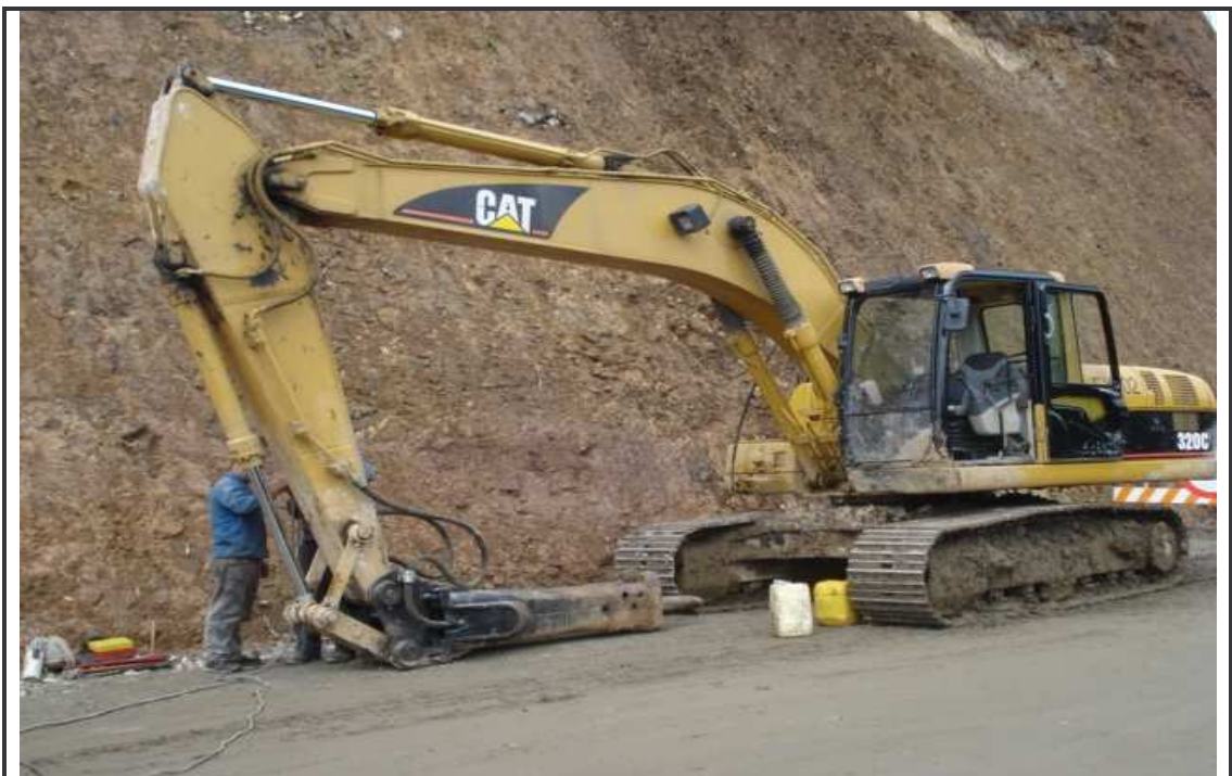
Figura 19. Instalación de martillo de perforación a la excavadora 320C
