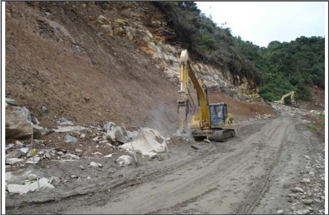
Figura 20. Excavación de roca para ampliación de calzada. K43+200
