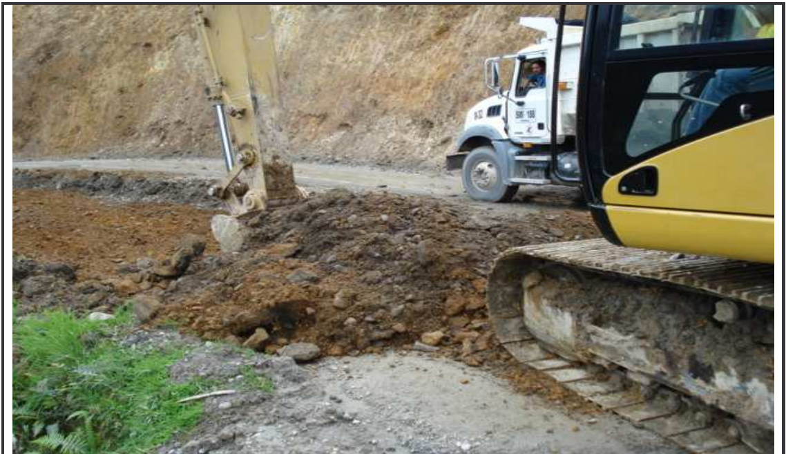
Figura 17. Cargue de volquetas con material proveniente del cajeo. K46+800
