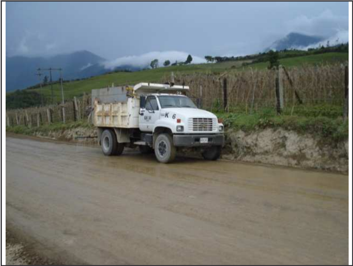
Figura 60. Humedecimiento del material. K48+600
