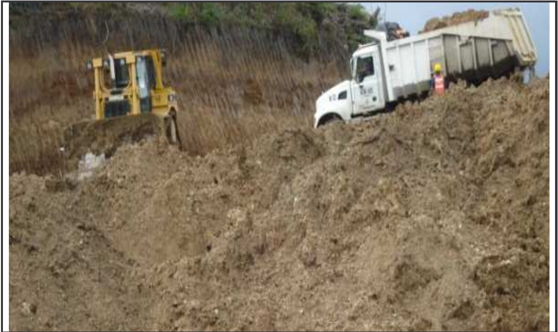
Figura 35. Conformación de depósito con bulldozer. K46+500
