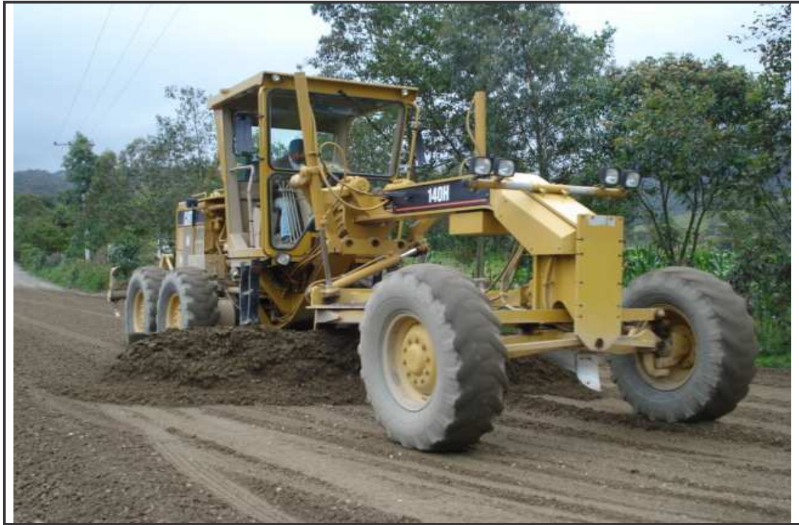
Figura 58. Extendido material de base. K48+450
