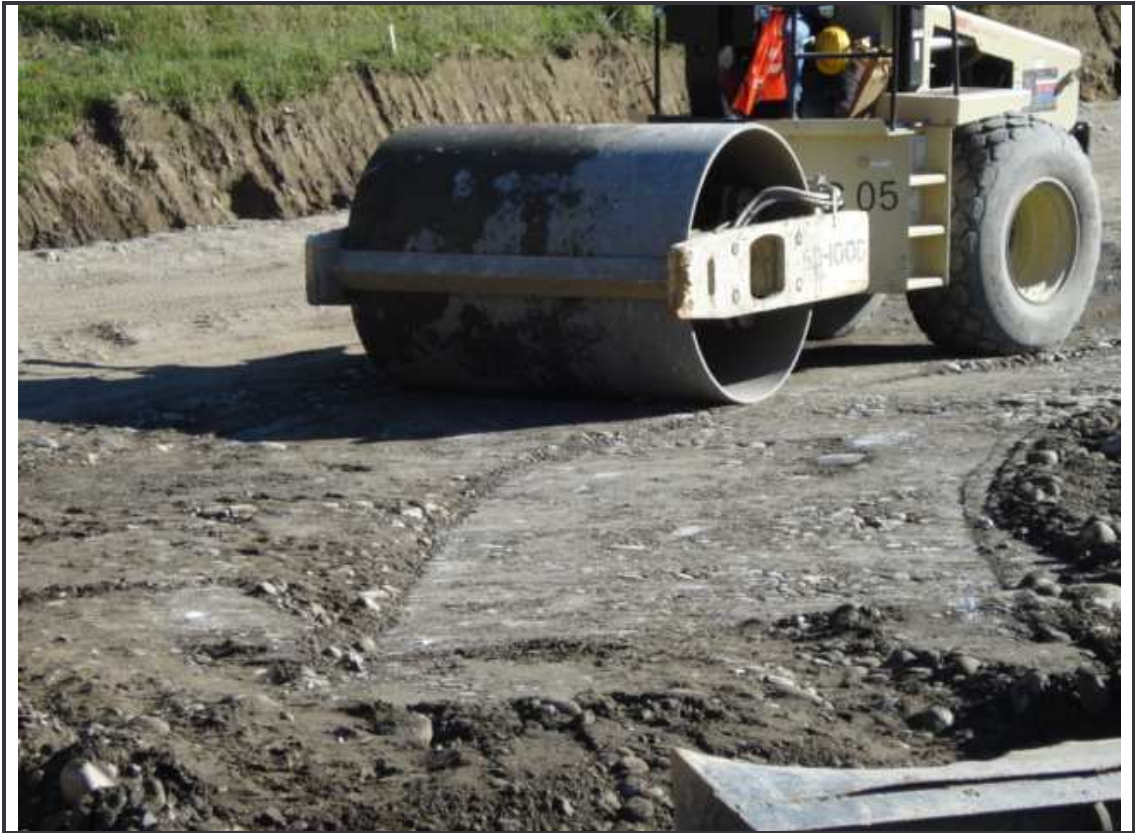
Figura 23. Compactación capa final Pedraplén. K44+900
