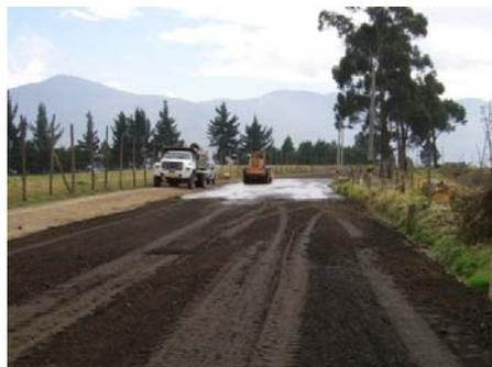
Fotografías No. 35 y 36. Chequeo de niveles de la Base Granular.
