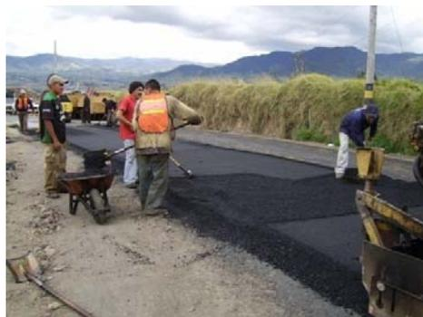
Inmediatamente se extiende la mezcla, se compacta con compactador de rodillo y compactador neumático, hasta alcanzar la densidad requerida, como se muestra en las Fotografías, 45 y 46.
