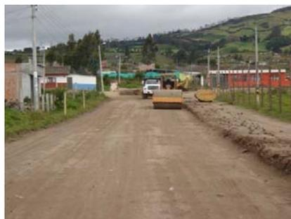
Al mismo tiempo que se realiza la excavación y retiro de este material, se continúa con la nivelación, escarificación y compactación en el tramo comprendido entre el K0 + 930 al K0 + 446,24.
