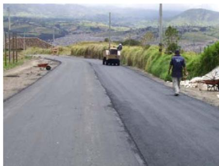
La calidad de la mezcla utilizada es garantizada por el proveedor del asfalto y posterior a la colocación de la carpeta se realizará la extracción de núcleos para la comprobación de las condiciones de la mezcla puesta en obra.
