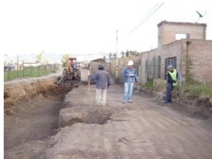
Los tramos de sobre-excavación se rellenan con relleno efectuándose capas de 15 cm que se humedecen hasta alcanzar la humedad requerida y se compactan con el compactador de rodillo, puesto que el ancho de la excavación así lo permite.
