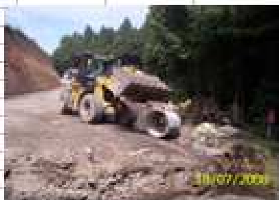
INSTALACIÓN DE TUBERIA K28+495.
