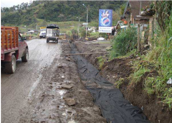
Foto 76. Construcción de alcantarillas
