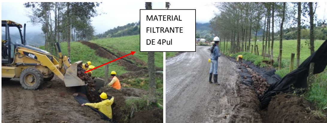
Foto 54. Llenado de material filtrante K23+900
