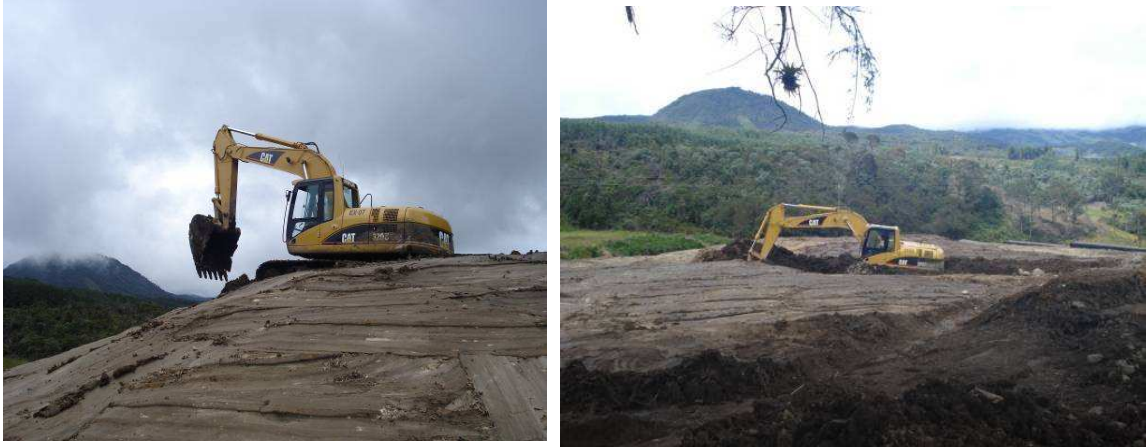
Foto 12. Conformación y compactación zona de deposito K23+700
