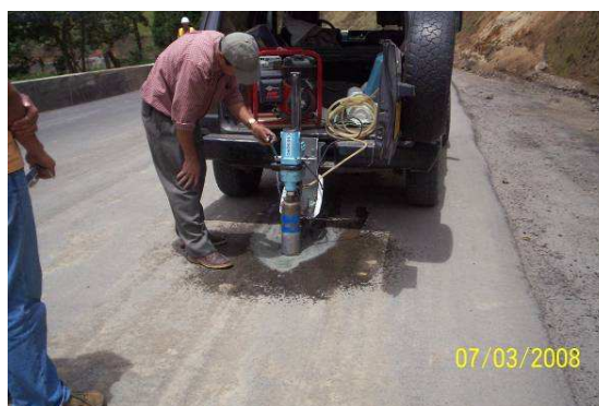
Foto 20. Extracción mecánica de núcleos concreto asfáltico carpeta
