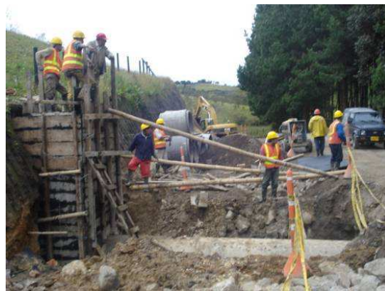
Fundición de caja de Alcantarilla Fundición De Poceta Alcantarilla
