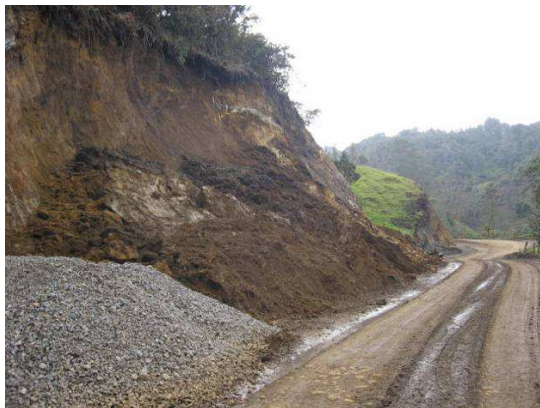
Foto 9. Remoción de derrumbe K28+500
