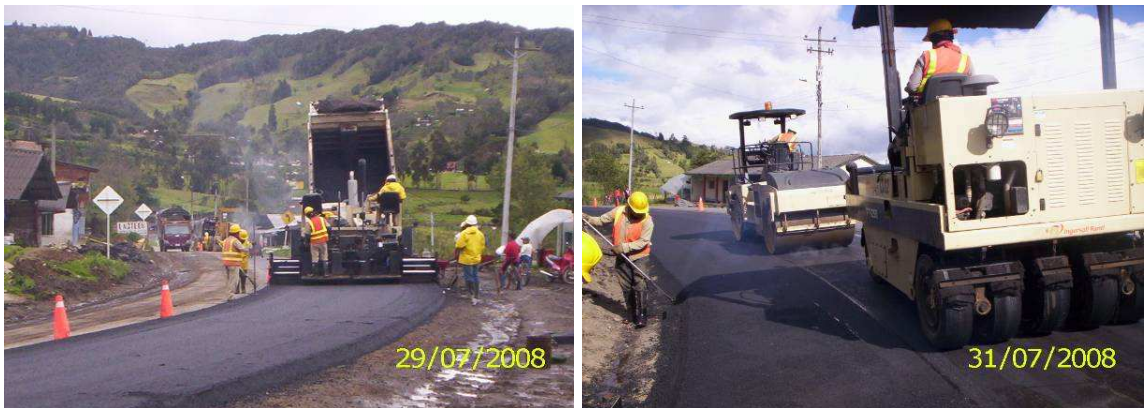
Foto 73. Extensión y compactación de sobrecarpeta
