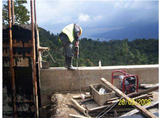
Realce De Muro De Contención
