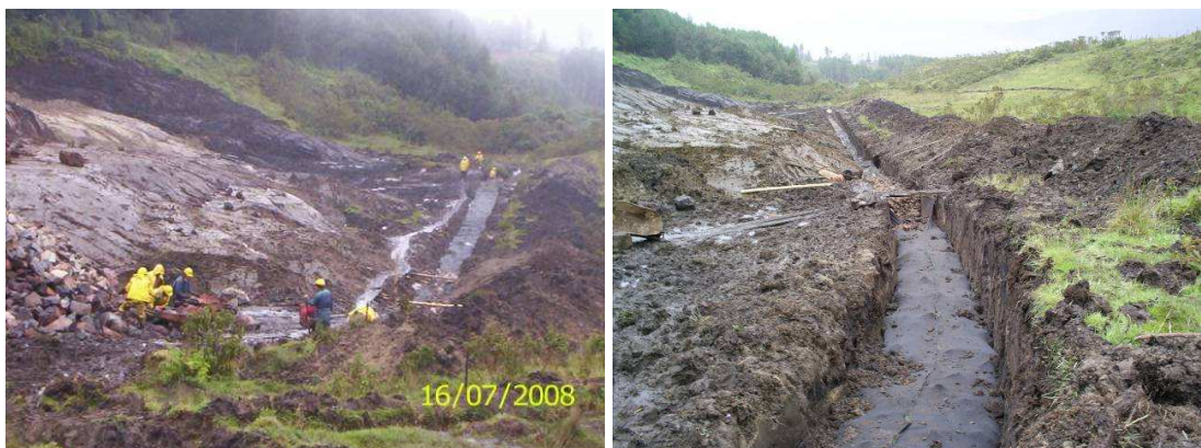
Foto 57. Instalación de filtro en deposito No 10 K27+850
