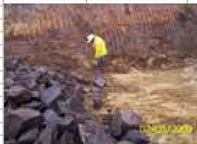
PEDRAPLEN PARA AMPLIACIÓN VIAL L30+500
