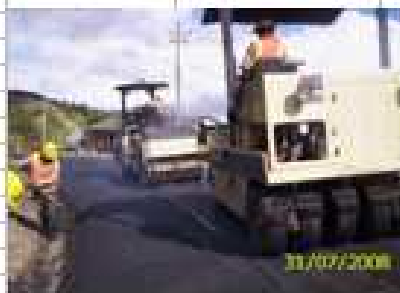
COMPACTACIÓN DE CARPETA ASFALTICA L23+236 A K23+350 CI.
