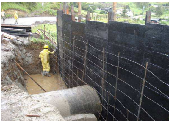
Foto 77. Construcción de muro de contención
