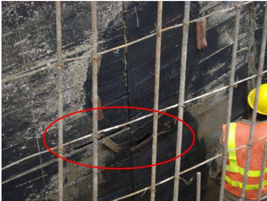
Foto 46. Formaleta muro de contención
