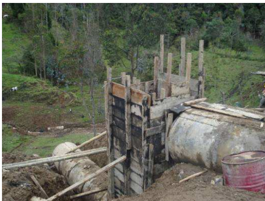
Fundición de caja de Alcantarilla Fundición De Poceta Alcantarilla
