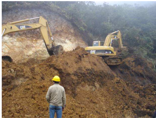
Foto 9. Remoción de derrumbe K28+500
