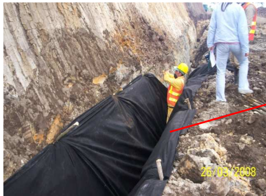
Foto 53. Instalación de geotextil
