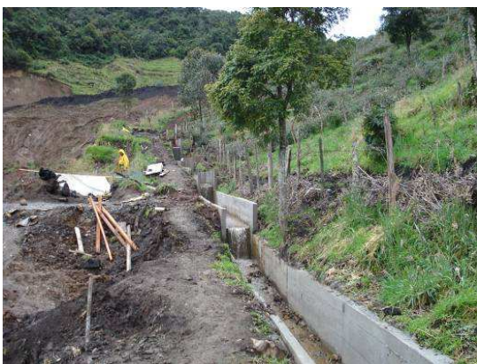
Foto 41. Canaleta revestida en concreto depósito 26+400.
