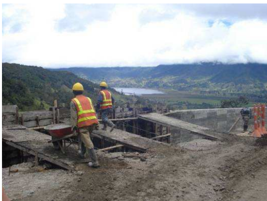
Foto 44. Muros de contención
