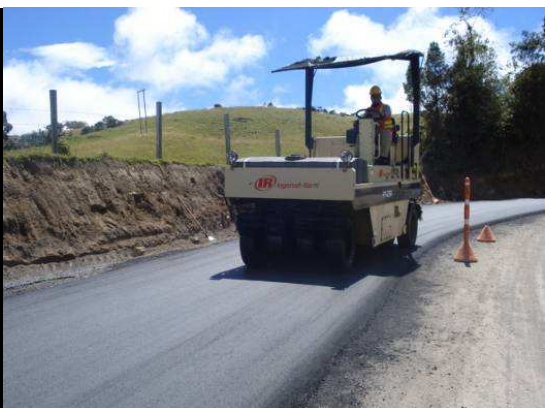
Compactación Con Rodillo Neumático
