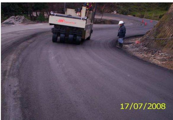
Compactación Con Rodillo Neumático
