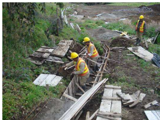
Foto 41. Canaleta revestida en concreto depósito 26+400.
