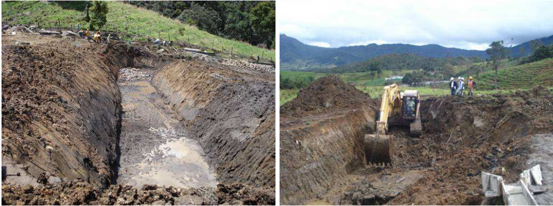
Foto 31. Excavación para muro en gaviones deposito K26+400
