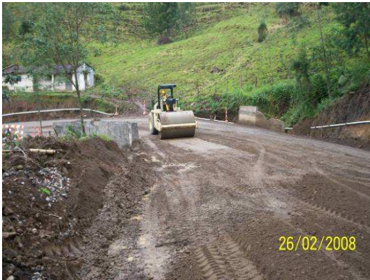
Foto 18. Compactación de base granular
