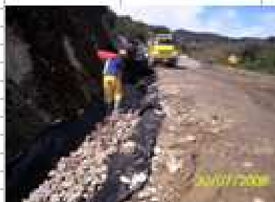
CONSTRUCCIÓN DE FILTRO K29+400 A K30+390.
