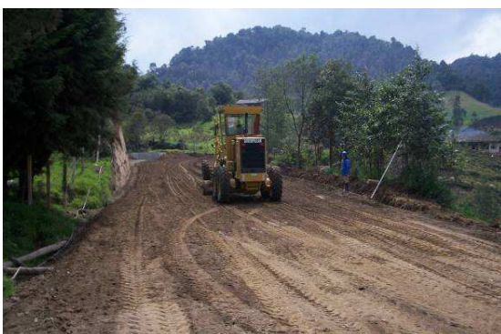
Foto 19. Extensión de base granular
