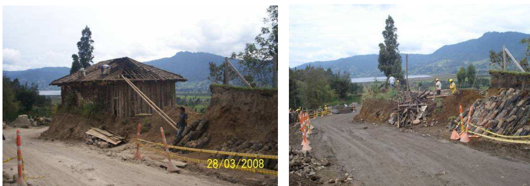
Foto 7. Vivienda afectada por corte K24+630
