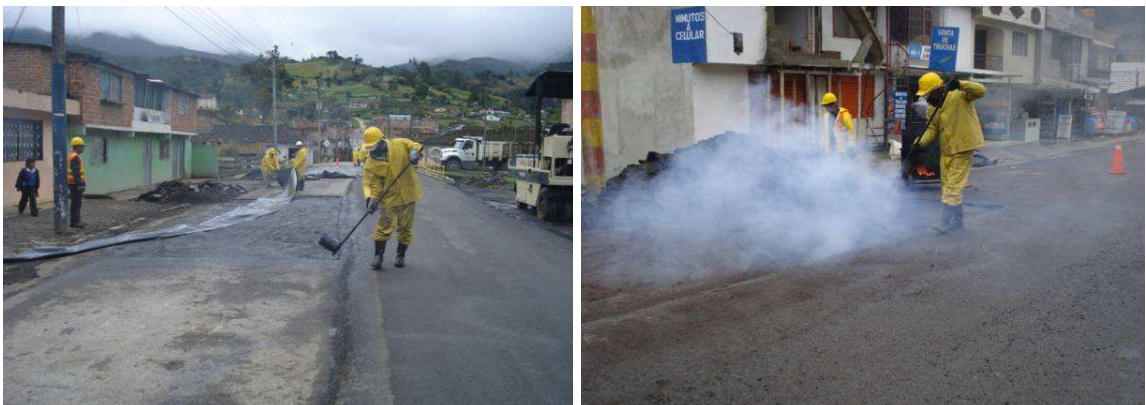
Foto 72. Extensión y compactación de mezcla asfáltica.
