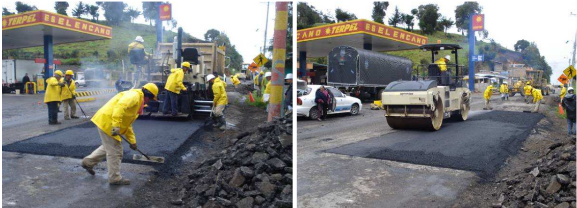
Foto 73. Extensión y compactación de sobrecarpeta
