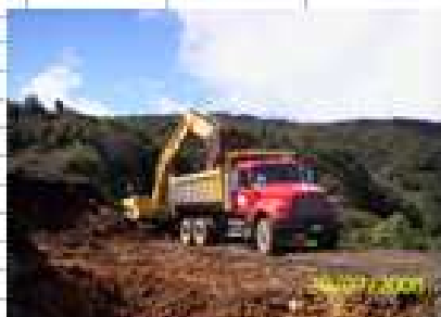
CORTE DE TALUD L30+500
