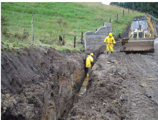
Foto 32. Excavación para filtros
