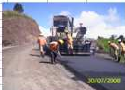
EXTENSIÓN Y COMPACTACIÓN K26+260 A K26+320
