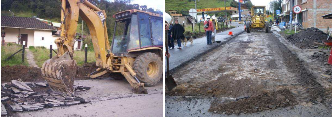
Foto 70. Secado de sub base para parcheo
