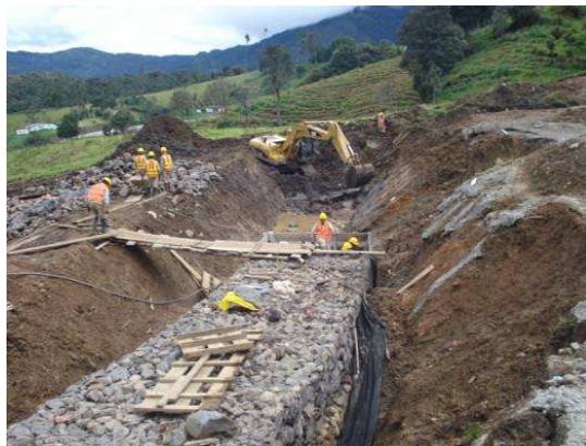
Foto 32. Excavación para filtros
