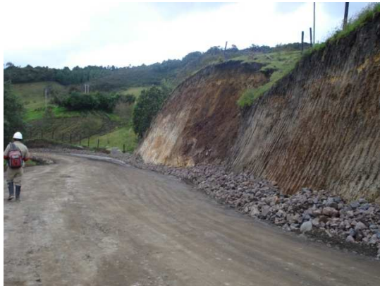
Foto 56. Material filtrante K30+000 A K30+150
