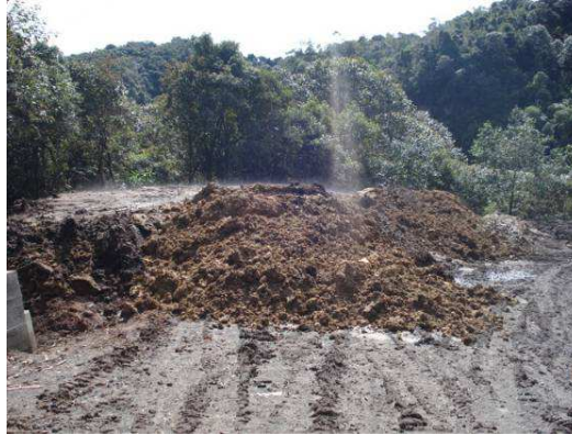
Foto 13. Material proveniente de corte K26+860
