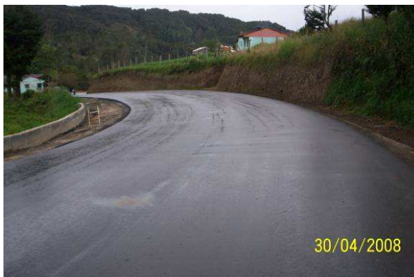
Carpeta Terminada Banca A= 7.30M
