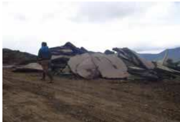
Foto 28. Retiro de carpeta asfáltica K26+239 A K26+280
