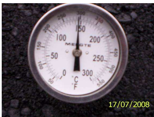
Foto 26. Chequeo temperatura de mezcla asfáltica
