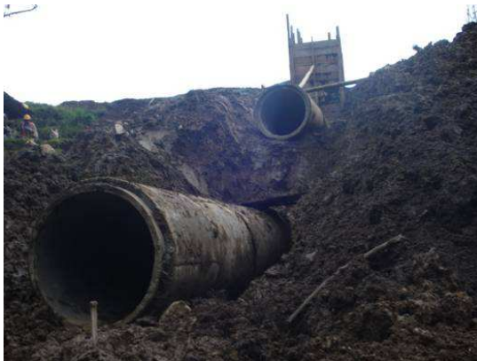
K25+309 deposito No 7
