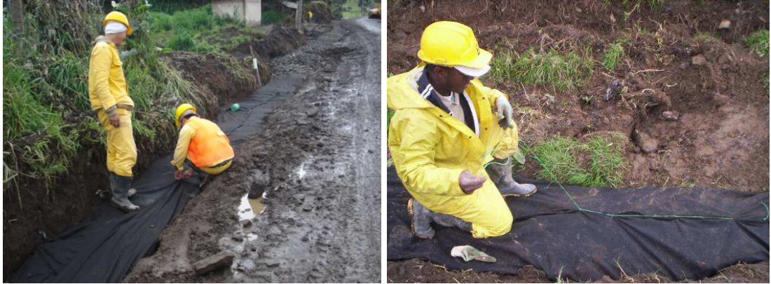
Foto 56. Material filtrante K30+000 A K30+150
