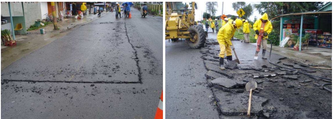
Foto 69. Demolición carpeta asfáltica existente
