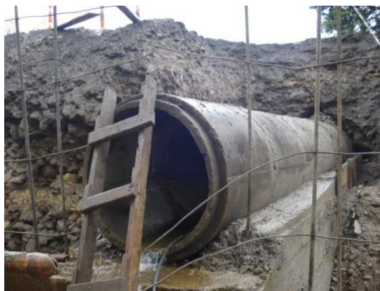
Foto 38. Solado para muro de contención
