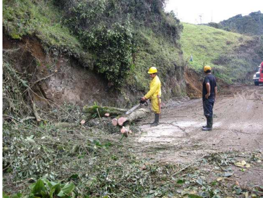
Foto 2. Descapote para corte de talud K28+300
