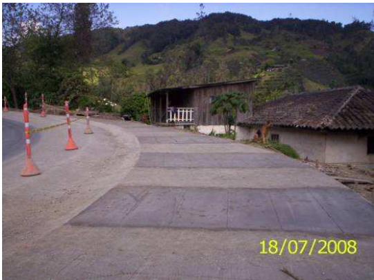
Construcción Bahía (MD) K24+280 A K24+300
