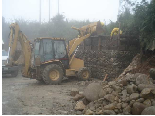
Foto 134. Construcción etapa 3 K40+970.
