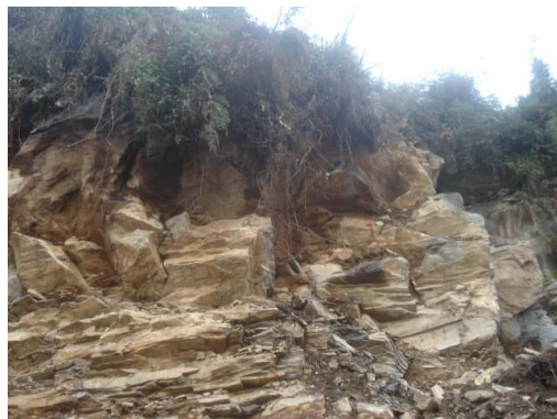
Foto 44. Talud en roca K43+050.
