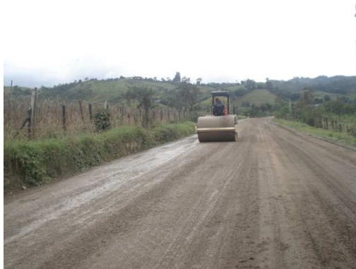
Foto 83. Compactación base K48+650.
