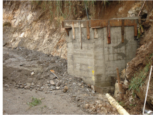
Foto 108. Relleno Alcantarilla K51+070.
