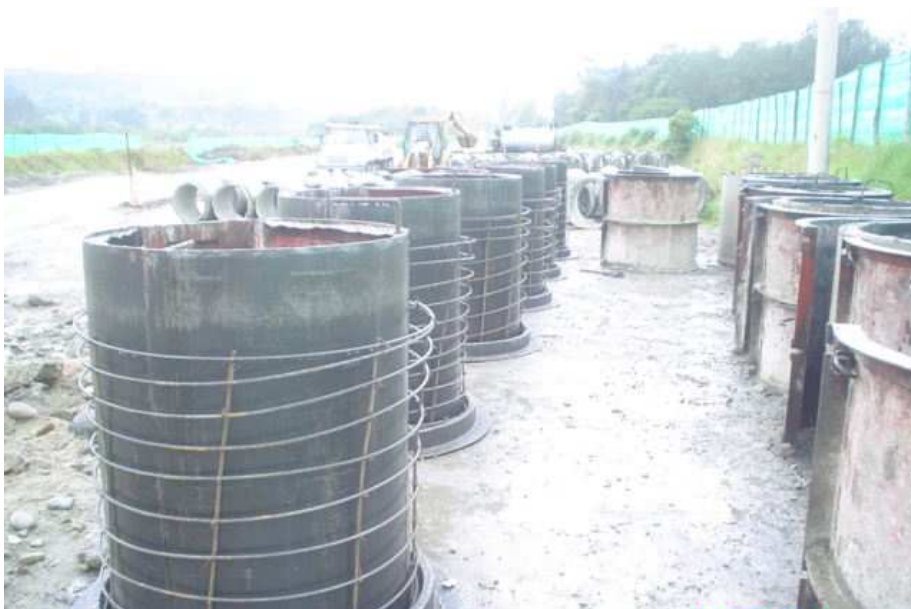
Foto 4. Armado de refuerzo de la tubería, en las formaletas Toma de muestras
