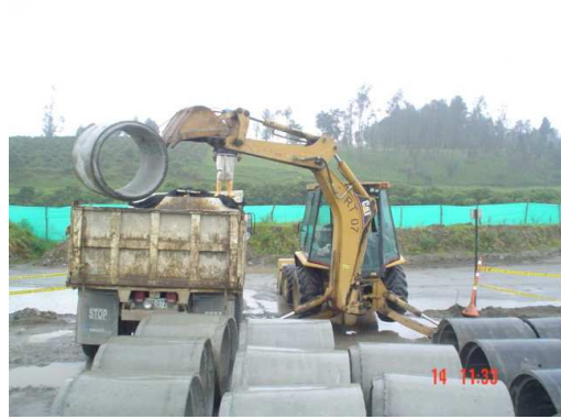
Foto 118. Cargue de tubería.
