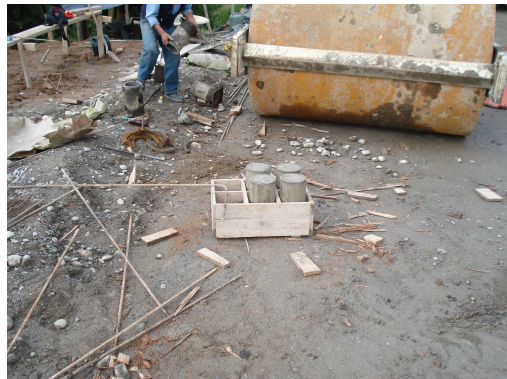
Foto 154. Toma de cilindros obras.
