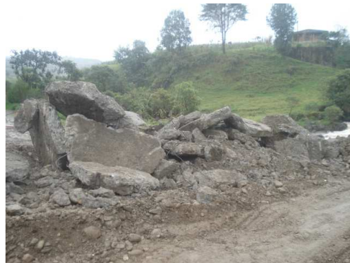
Foto 143. Demolición de estructura.
