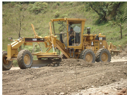
Foto 72. Extensión subbase K46+550.
