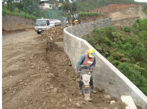
Foto 104. Relleno. Muro K45+700.
