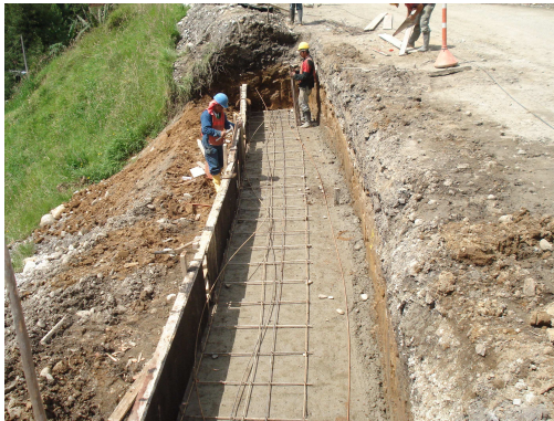
Foto 113. Zarpa Muro K44+550.
