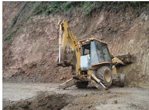
Foto 100. Excv. Alcantarilla K42+860.
