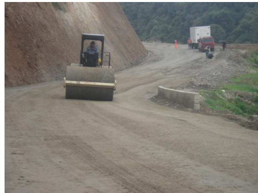
Foto 76. Compactación sub-base K43+650.
