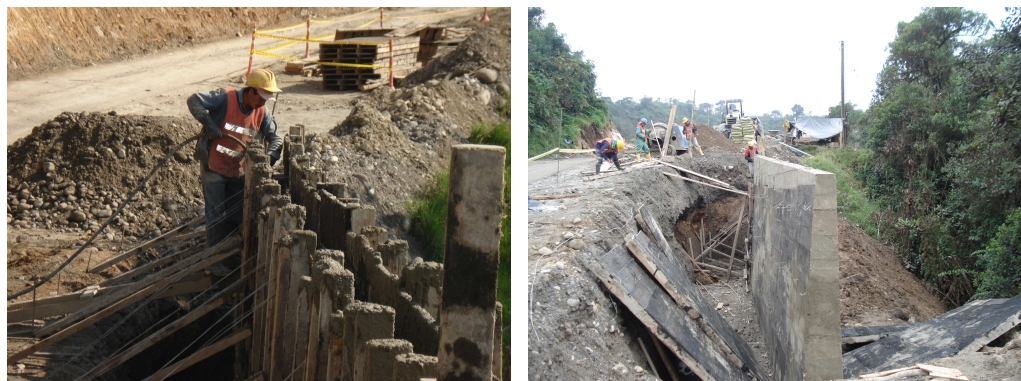
Foto 115. Vibrado concreto K44+650. Foto 116. Vástago terminado K44+650.
