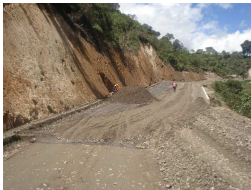
Foto 71. Extensión subbase K45+400.
