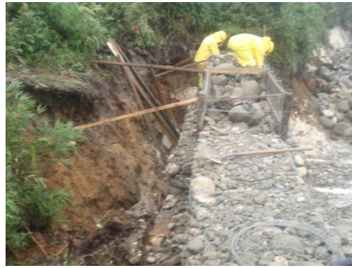
Foto 135. Construcción etapa 3 K40870.
