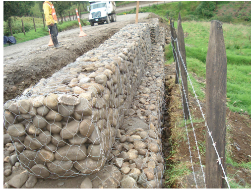
Foto 140. Construcción K40870. etapa 2 terminado
