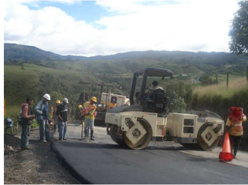
Foto 98. Compac. Empalmes K49+700.
