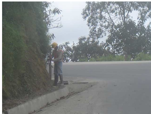
Foto 106. Relleno. Cunetas K49+620.
