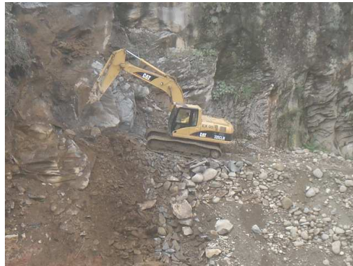
Foto 42. Talud en roca K43+050.
