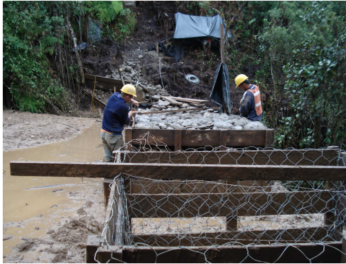
Foto 139. Construcción Depósito K46+500. etapa 3
