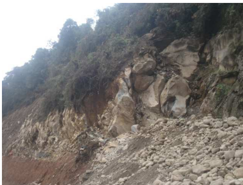
Foto 43. Talud en roca K43+050
