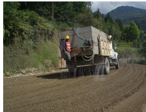
Foto 78. Humedecimiento Base K50+350.
