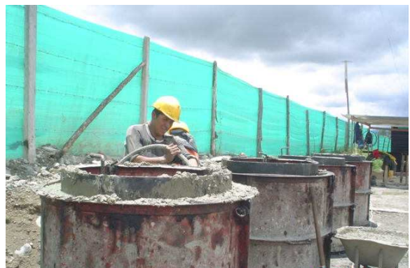
Foto 3. Vibrado del concreto
