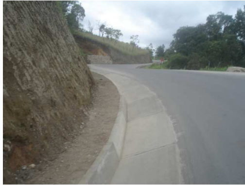
Foto 107. Relleno Cunetas K49+450.
