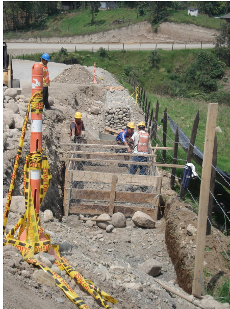
Foto 137. Construcción K50+100. etapa 1
