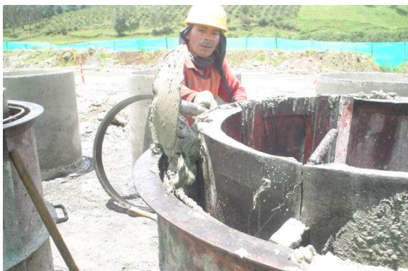
Foto 2. Llenado de concreto
