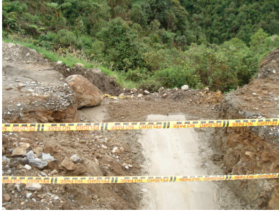
Foto 109. Solado de limpieza alcantarilla
