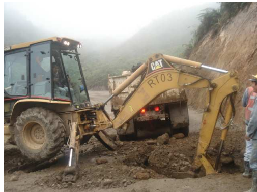
Foto 99. Excv. Alcantarilla K40+280.
