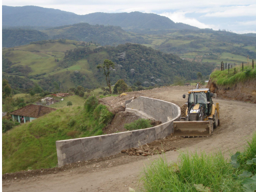
Foto 103. Relleno. Muro K45+700.
