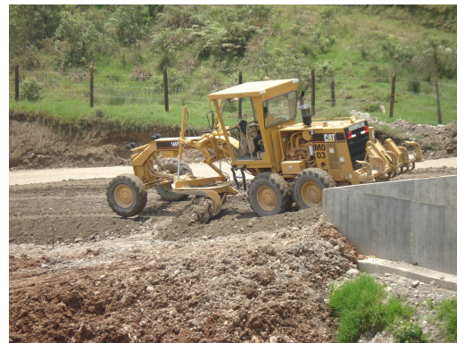
Foto 70. Extensión subbase K46+550.
