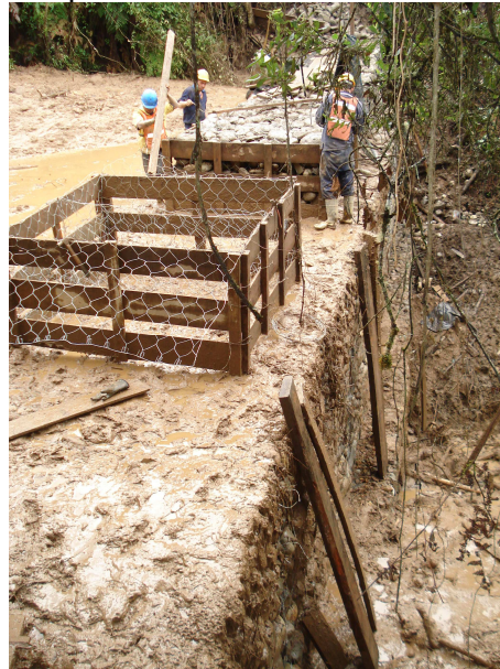
Foto 138. Construcción Depósito K46+500. etapa 3
