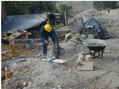
Foto 153. Toma de cilindros obras.
