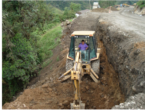
Foto 101. Excv. Muro K44+550.
