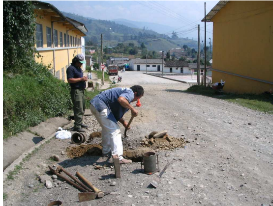
Foto 1. Lugar de inicio del proyecto de pavimentación. PR 51+070
