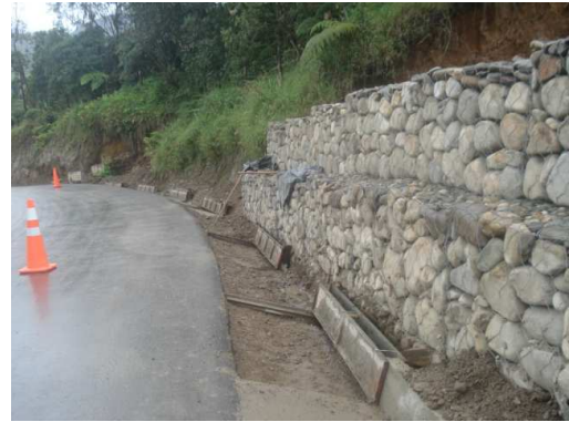
Foto 141. Muro K49+600. etapa 3 terminado
