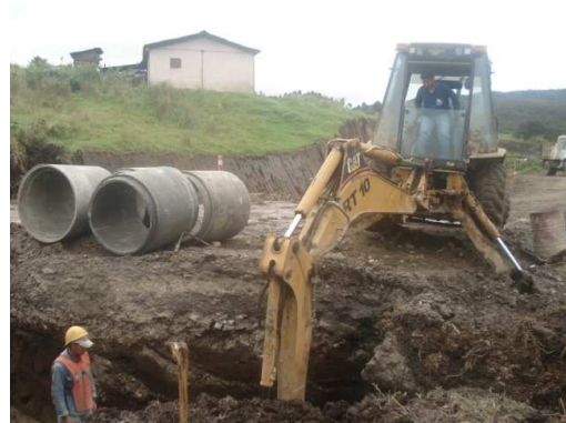
Foto 122. Descargue de tubería.
