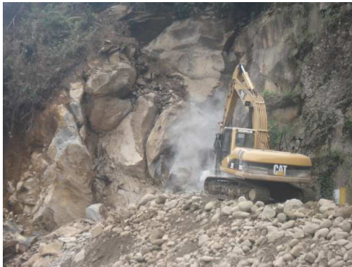
Foto 41. Talud en roca K43+050
