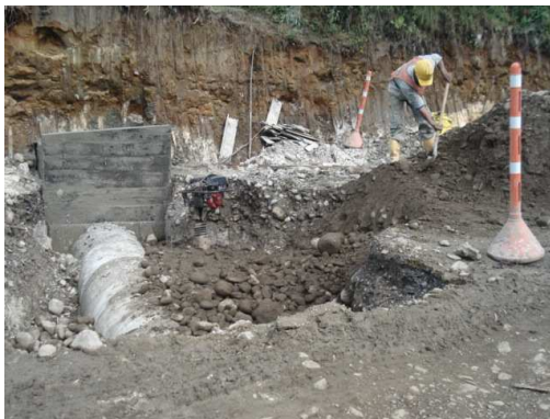
Foto 105. Relleno. Alcantarilla K40+870.
