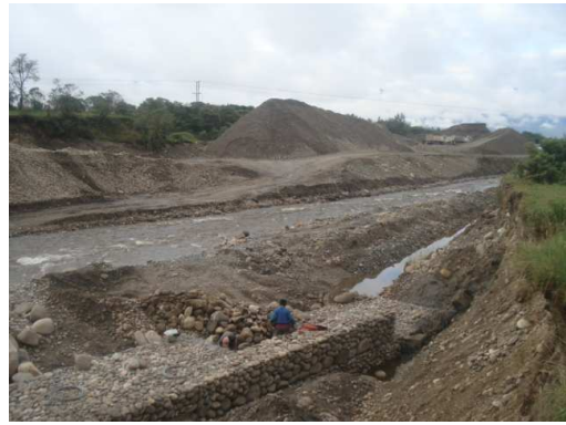
Foto 136. Construcción río San Pedro.
