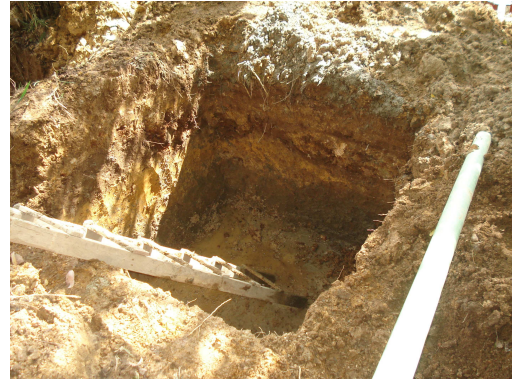
Foto 102. Excv. Tubería K50+950.
