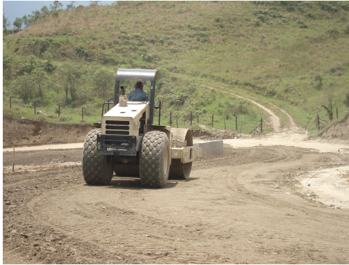
Foto 73. Compactación sub-base K46+400
