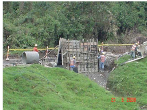
Foto 112. Solado cabezal.
