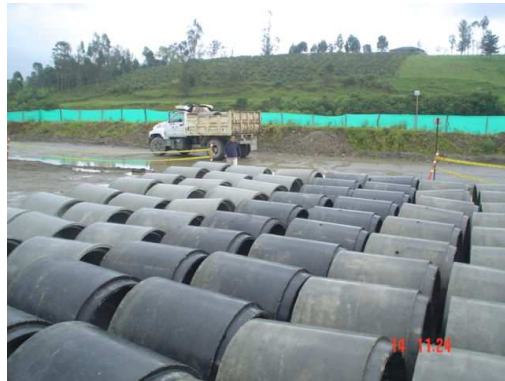
Foto 119. Tubería en stock.
