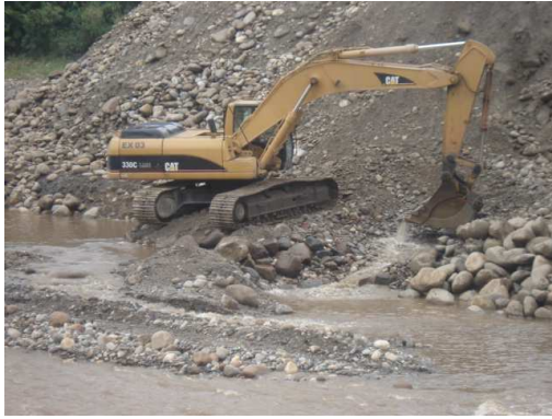
Foto 133. Excavación río San Pedro.
