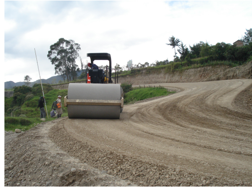
Foto 80. Compactación Base K50+650.
