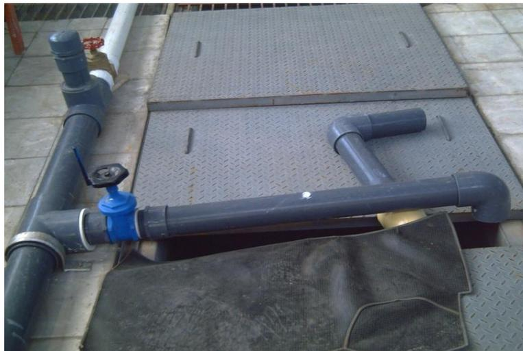
El desarenador instalado no estaba en capacidad de manejar el nuevo caudal por lo que se realizó una reevaluación del diseño del mismo, ampliando los orificios del fondo y el orificio de desagüe de salida; en los orificios del fondo se perforo un nuevo orificio cuyo diámetro es de 9 cm quedando 3 orificios del mismo diámetro (figura 8), en el diámetro de salida se amplio de 2½” a 4” (Figura 9)
