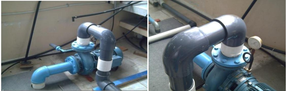
Con la entrada en funcionamiento de la motobomba de 2 HP se incremento el caudal y el tanque elevado no está en capacidad de soportar tal caudal se decidió entonces instalar una “T” y una válvula de compuerta en el recorrido desde la motobomba hasta el tanque para aliviar el exceso de caudal y retornarlo al reservorio.
