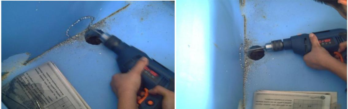
**Figura 10. Ampliación orificio de salida de 2/1" a 4"**
