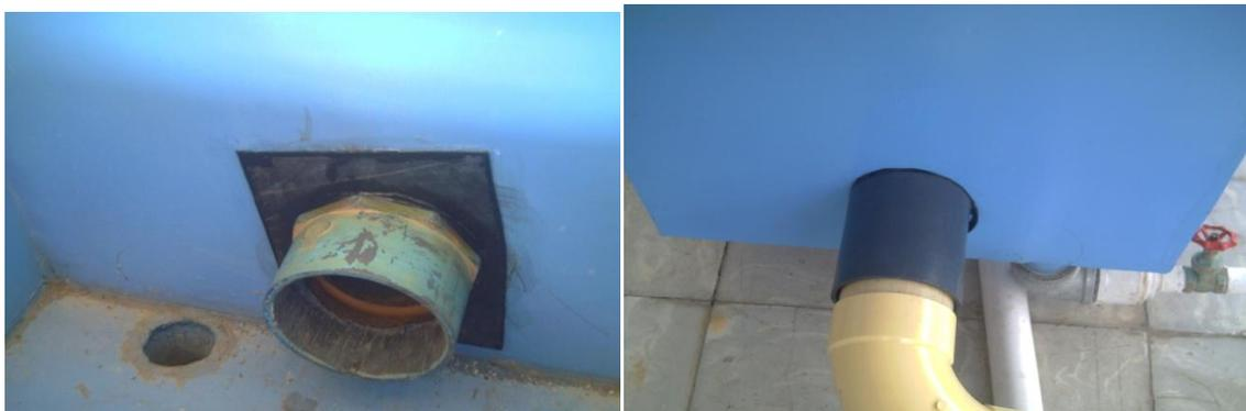
**Figura 12. Instalación tubería sanitaria desde el desarenador al reservorio**
