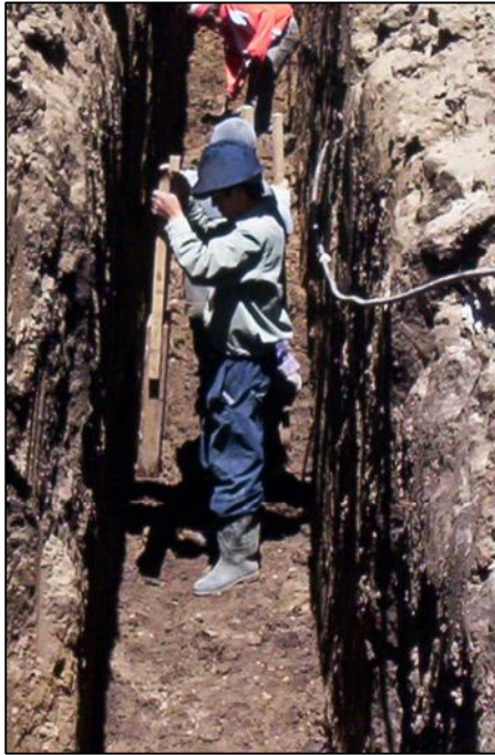
Figura 13. Compactación manual y mecánica del material de relleno.
