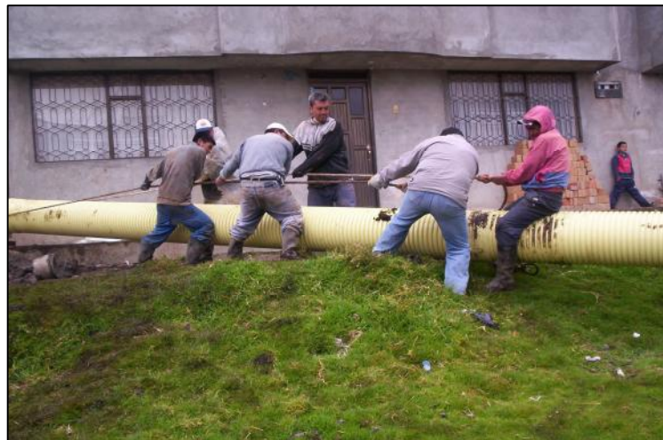
Figura 22. Acople de la tubería Novafort.
