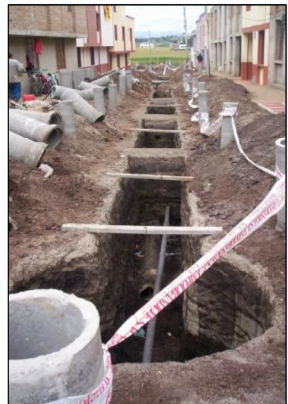
Figura 27. Excavación manual para instalación de tubería de alcantarillado.
