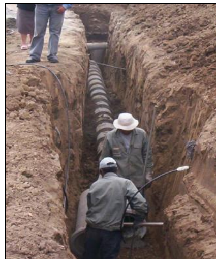
Figura 10. Excavación e instalación de tubería de cemento. Calle 27
