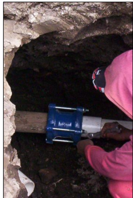
Figura 26. Unión de la tubería de cemento y Pvc. (Guiboulth).
