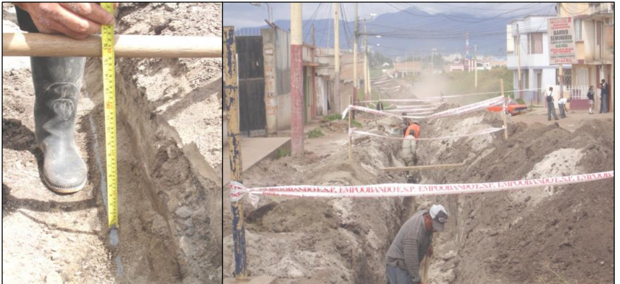
Figura 4. Excavación e instalación de acueducto diámetro 3". Carrera 5 Norte.
