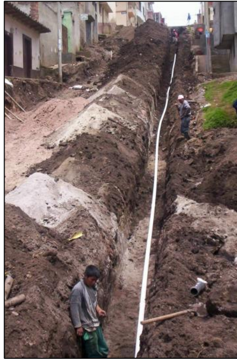
Figura 26. Unión de la tubería de cemento y Pvc. (Guiboulth).
