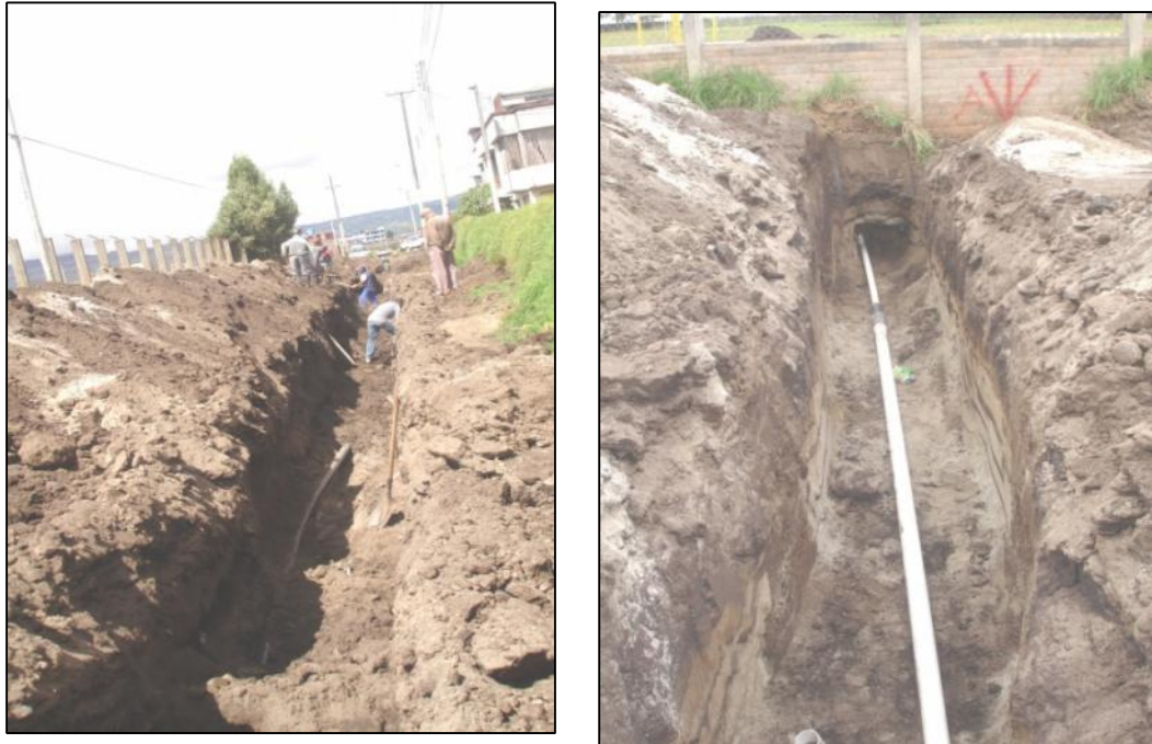
Figura 6. Construcción de sumideros. Carrera 5 Norte.
