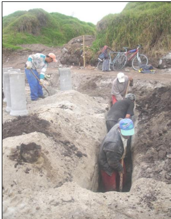
Figura 6. Construcción de sumideros. Carrera 5 Norte.
