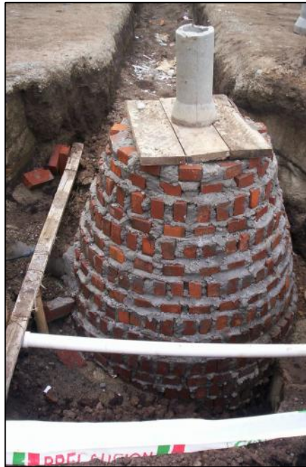
Figura 30. Cámaras terminadas. Villa Esperanza.
