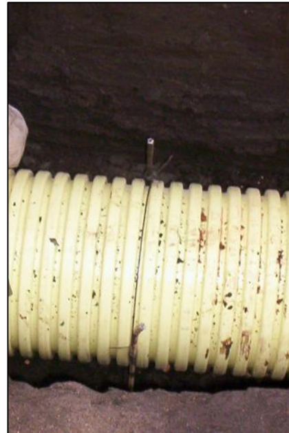
Figura 23. Instalación y aseguramiento de la tubería Novafort.
