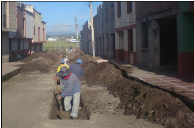
Figura 27. Excavación manual para instalación de tubería de alcantarillado.
