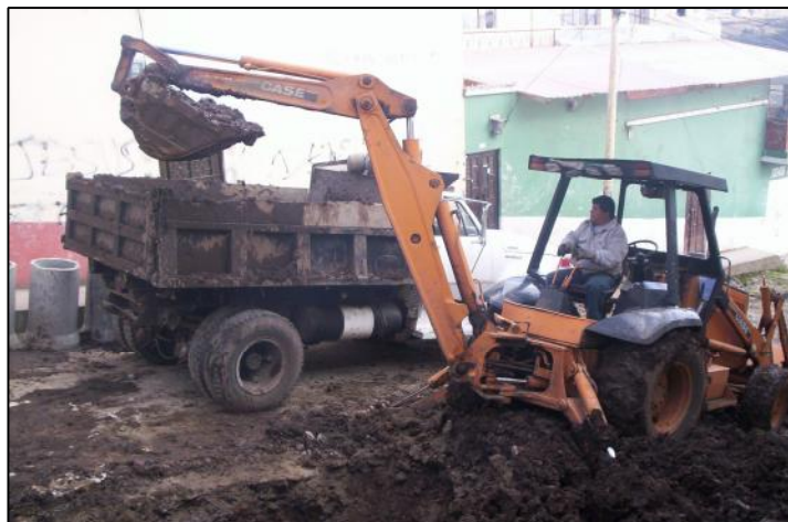
Figura 18. Excavación y desalojo de material.
