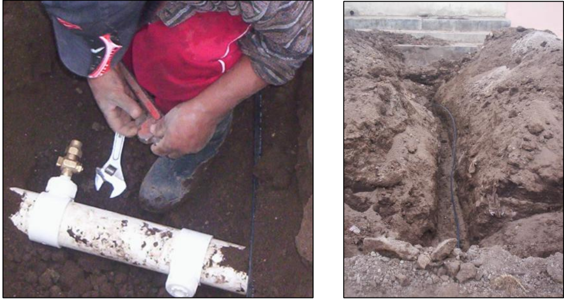
Figura 16. Excavación manual para la construcción de sumideros.
