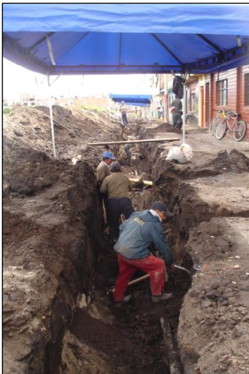
Figura 8. Instalación de acometidas domiciliarias de acueducto. Carrera 5 Norte.
