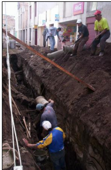
Figura 28. Instalación de tubería de alcantarillado.
