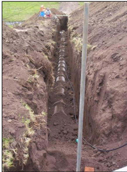
Figura 10. Excavación e instalación de tubería de cemento. Calle 27
