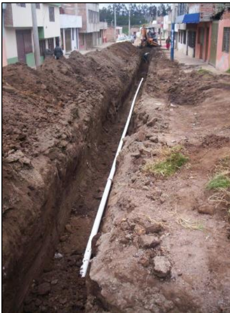
Figura 14. Instalación de la tubería de Acueducto. Calle 27.
