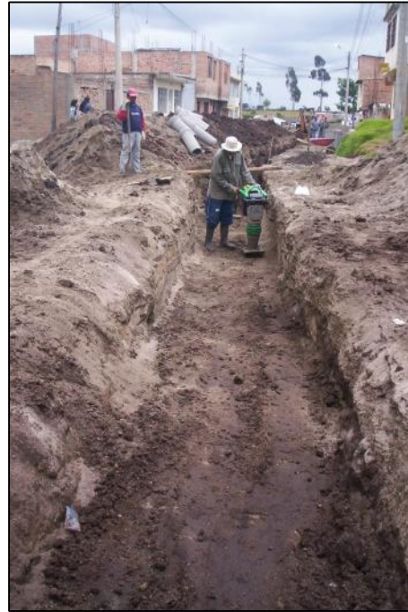
Figura 13. Compactación manual y mecánica del material de relleno.
