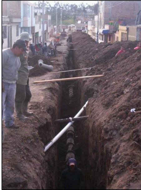
Figura 12. Construcción de cámaras de inspección y cámara de caída.
