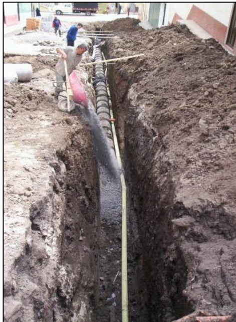
Figura 20. Instalación de la tubería de cemento. Relleno en base de triturado.
