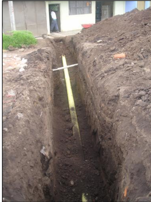
Figura 7. Instalación de acometidas domiciliarias de alcantarillado. Calle 11.
