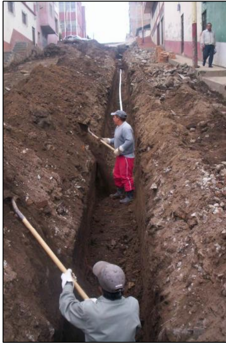
Figura 26. Unión de la tubería de cemento y Pvc. (Guiboulth).
