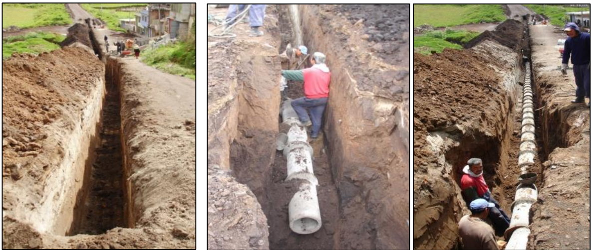
Figura 1. Excavación e instalación de tubería de cemento. Calle 11.
