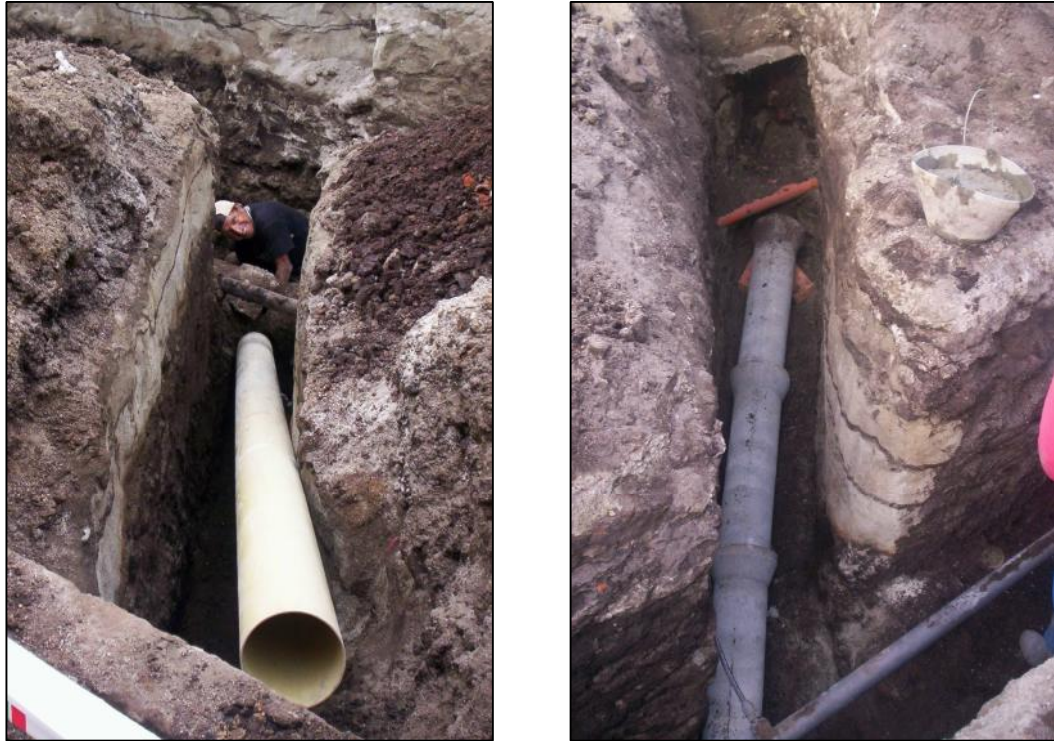
Figura 29. Instalación de acometidas domiciliarias de alcantarillado.
