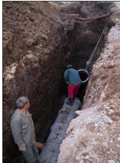
Figura 20. Instalación de la tubería de cemento. Relleno en base de triturado.
