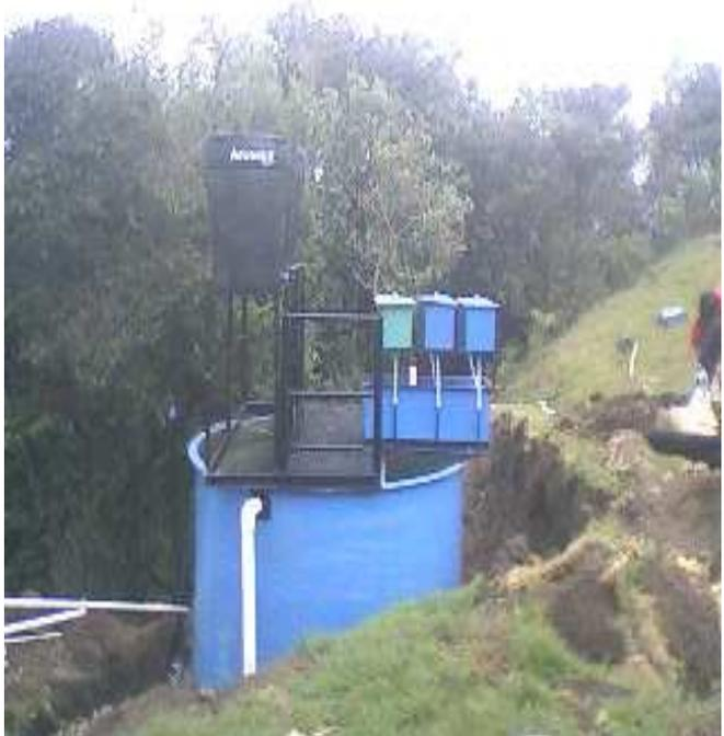
**Plantas De Tratamiento De Agua Potable Fabricadas En Poliéster Reforzado Con Fibra De Vidrio (PRFV)**
