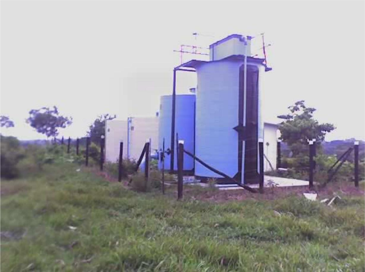
**Plantas De Tratamiento De Agua Potable Fabricadas En Poliéster Reforzado Con Fibra De Vidrio (PRFV) Compacta**
