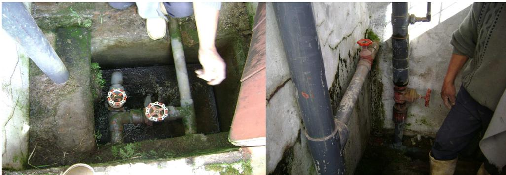
Figura No 10. Caja de Válvulas
