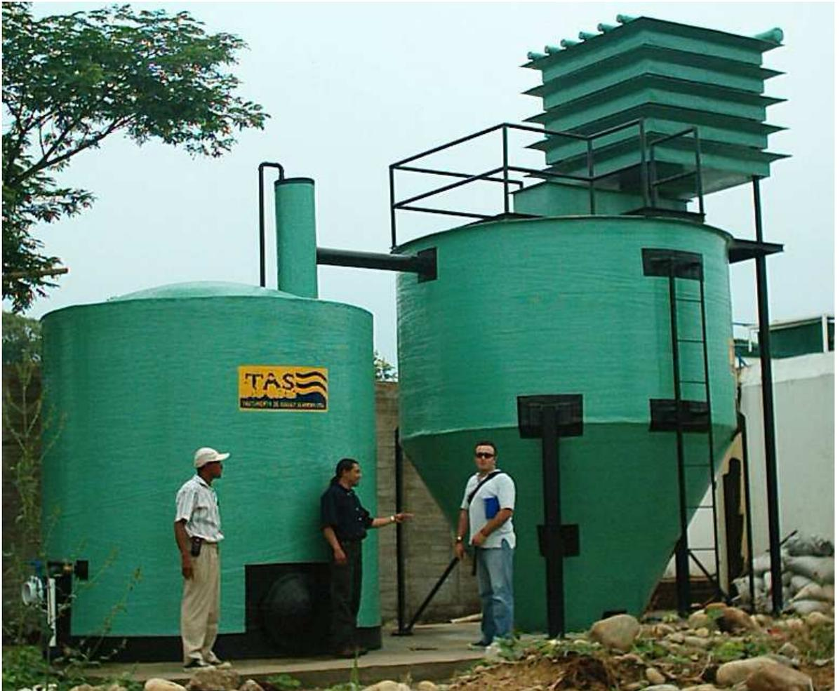
**Plantas De Tratamiento De Agua Potable Fabricadas En Poliéster Reforzado Con Fibra De Vidrio (PRFV)**
