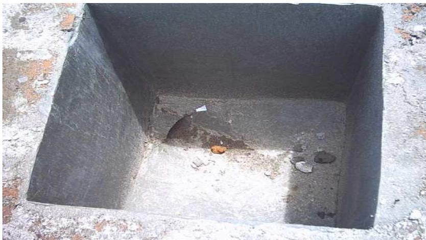
A continuación se hace la conexión de los sumideros, primero se realiza la ubicación del punto exacto teniendo en cuenta los parámetros de diseño del pavimento, dados por el topógrafo de la Secretaría de Infraestructuras, posteriormente se instala la tubería la cual es de cemento de 8" de diámetro, para así conectar el desagüe del sumidero hasta la cámara más cercana.
