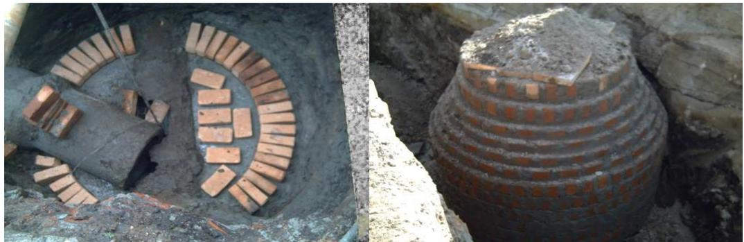
Posteriormente, se procede al relleno y apisonamiento por los lados de la tubería, para el relleno total de la excavación, se procede a rellenar con material de préstamo ya que el existente corresponde a un estrato arenoso y además durante este periodo llovió mucho lo cual hizo que el material se mojara y no proporcionara buenas características de compactación (ver foto 27).
