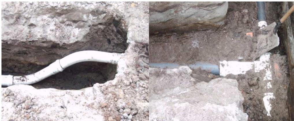
Una vez instalada la tubería se realiza la conexión de las acometidas domiciliarias la cual va desde el tubo de acueducto con galápago, llave de incorporación macho y hembra, manguera PF, hasta el medidor (ver foto 44 y foto 45).
