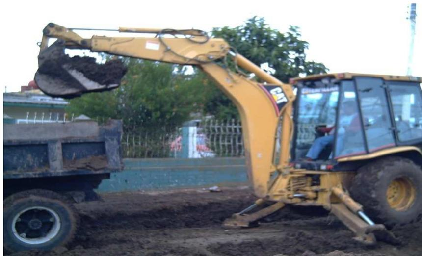
Una vez instalada la red de acueducto y alcantarillado se procede a excavar la capa de recebo, cuando ya se encuentra conformada la base del pavimento trabajo realizado por el personal de infraestructuras, para localizar las cámaras ya construidas, posteriormente se termina de pegar algunas filas de ladrillo dejándolas a nivel de la capa de recebo reduciendo el diámetro, hasta llegar a la corona con 60 cm medida del aro y la tapa de alcantarilla (ver foto 35).
