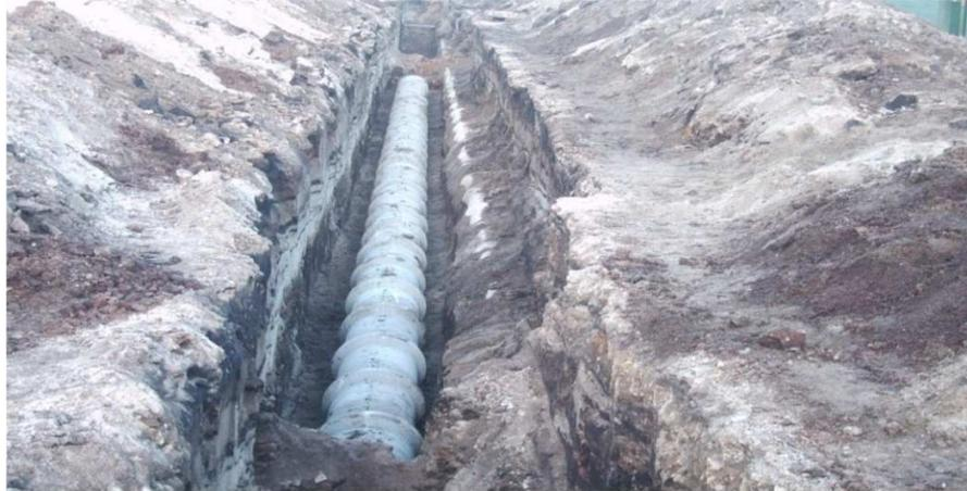
La tubería se instala y se pega con mortero; previamente se revisa que la mezcla se encuentre en la proporción adecuada: 1 bulto de cemento por 2 carretadas de arena, y se verifica que se disponga en forma alineada por medio de la ayuda del hilo.
