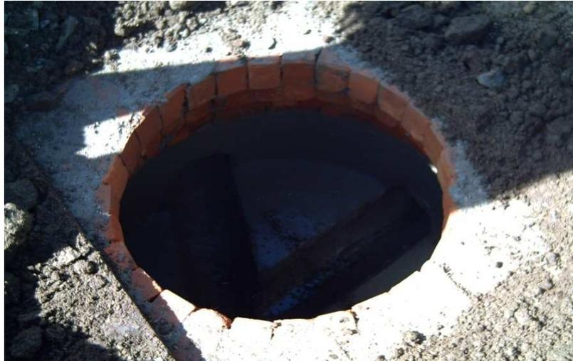
Posteriormente el personal de valorización se encarga de fundir la losa del pavimento, a continuación procedemos a excavar para encontrar la tubería de los sumideros, seguidamente se procede al armado de las formaletas para su posterior fundición (ver foto 36 y foto 37).
