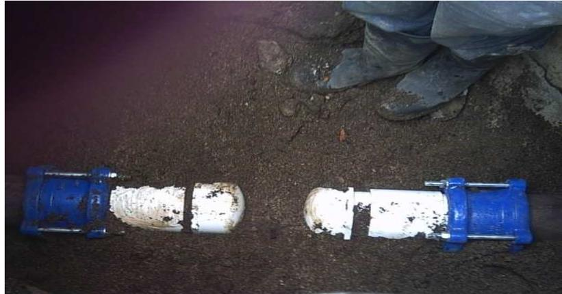
**Calle 16:** Se profundizó 110 m. de tubería en PVC RDE 21 de 4" de diámetro. Se realizaron tres empates, con la tubería que abastece de agua al sector, por medio de uniones de reparación y codos de 22 1/2° radio largo (ver foto 42). Para cerrar el circuito, se instalaron dos válvulas de cierre de paso y accesorios como tees en los cruces de las calles (ver foto 43).
