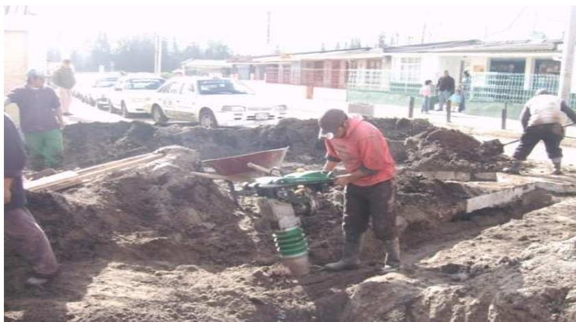
Posteriormente se realiza la conexión de las acometidas domiciliarias, la cual va desde una pequeña cajilla de inspección (ver foto 29) construida en el andén de cada vivienda, hasta la red principal de alcantarillado, la tubería es de cemento de 6" de diámetro (ver foto 30), la excavación se realiza a mano cuidando de que cumpla con la pendiente mínima y se disponga diagonalmente en ángulo de 45° a 60°.
