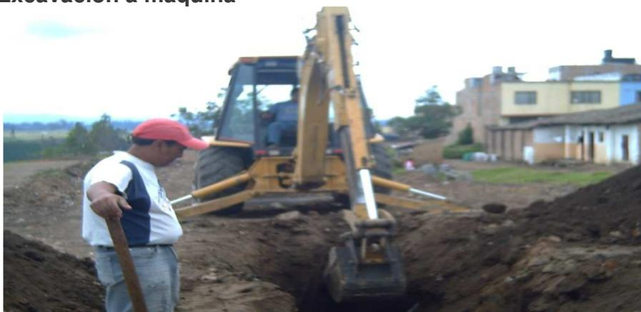
La tubería utilizada fue tubería de cemento, se instalaron 103 m. en tubería de 12" de diámetro, y 191,72 m. en 10" de diámetro, la tubería se instala y se pega con mortero (1:2), se verifica que la tubería se disponga en forma alineada por medio de la ayuda del hilo.
