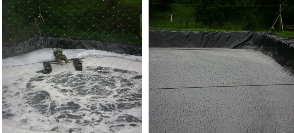
Figura 2. Tratamiento de Lixiviados del Relleno Sanitario Antanas. a) Laguna Aerobia y b) Laguna Anaerobia.
