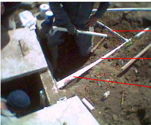
Instalación de tubería
