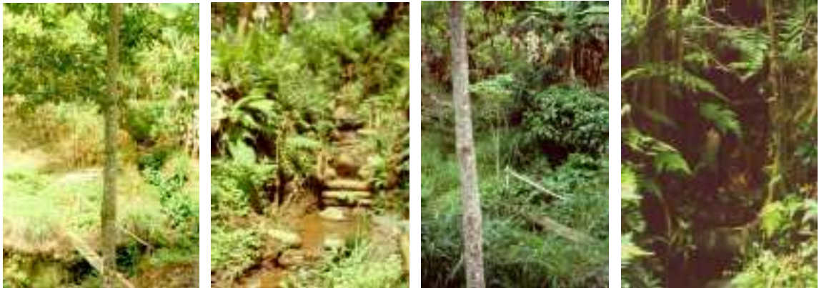
Construcción de trinchos vivos escalonados.
