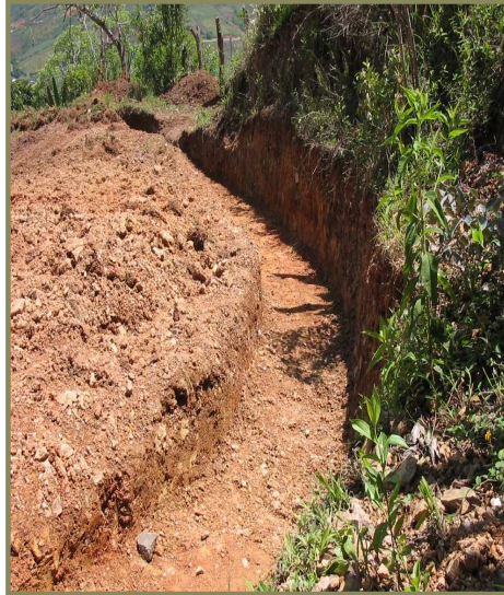
Figura 7. Construcción de acequia de evacuación de aguas de escorrentía, municipio Dagua, Vía a Santa María, 2004.
