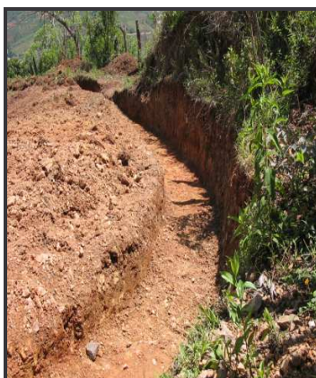
Elaboración de cunetas
