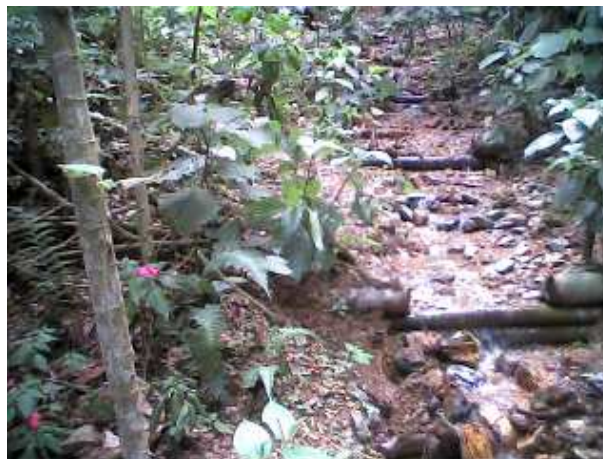
Figura 10. Trinchos escalonados, Quebrada Villa Rosa, Argelia – Valle
