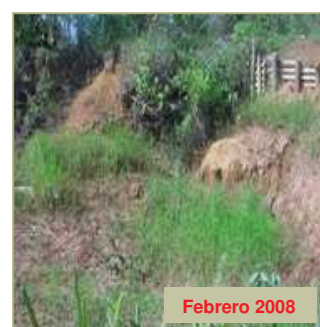
Estado actual de la obra
