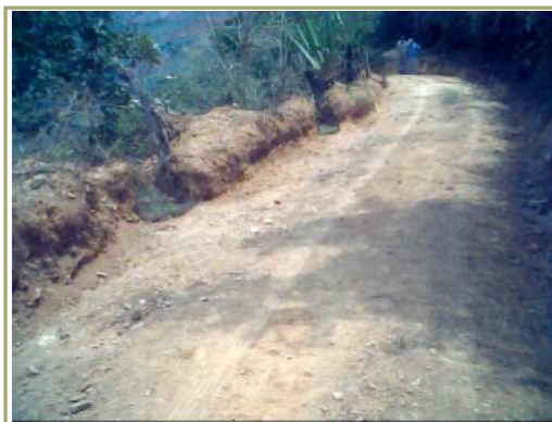
Figura 9. Construcción y empedrado de ventanas para el fraccionamiento en carreteras de los caudales máximos de escorrentía en los periodos lluviosos. Dagua – Valle. Febrero 11 de 2004.
