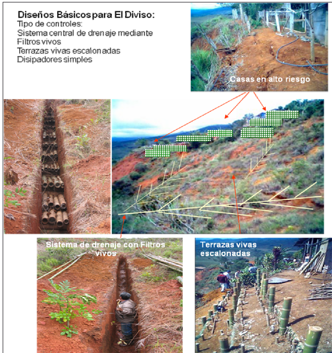
Figura 18. Diseño Básico para la restauración ecológica con obras biomecánicas en 3 sitios de la vereda El Diviso, municipio Dagua.
