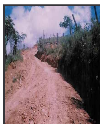
Perfilamiento de la vía.
