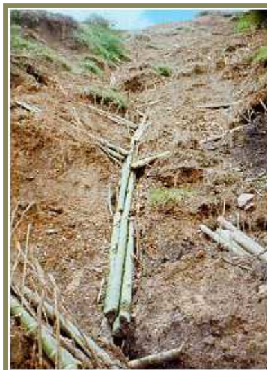
Figura 3. Construcción de filtros vivos en espina de pescado, usando guadua Guadua angustifolia , Manizales.
