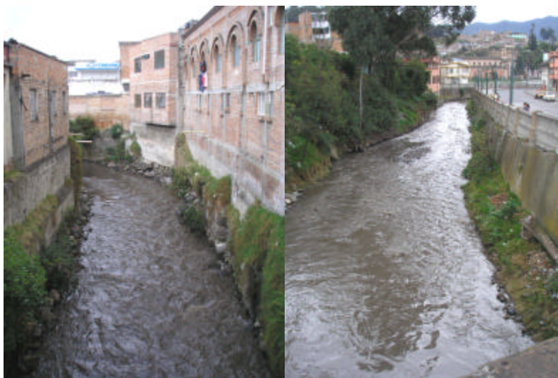
Figura 8. Río Pasto, sector los Dos Puentes
