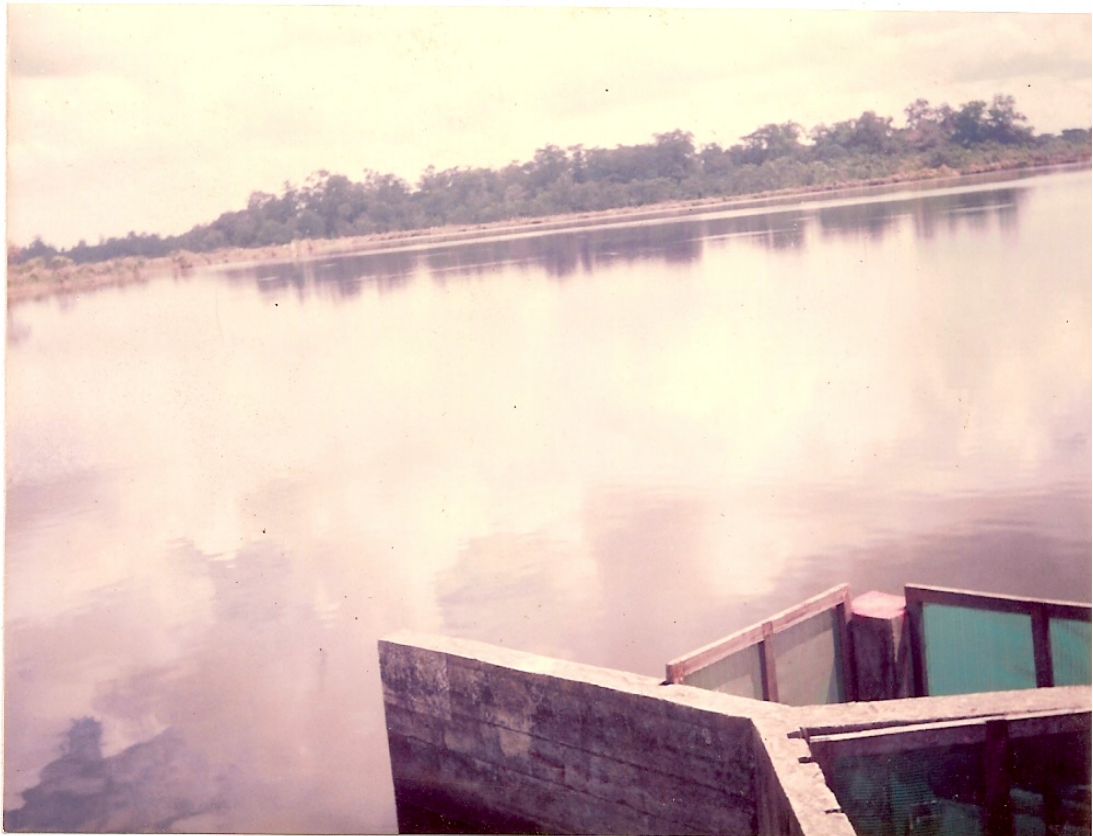
Figura 1. Compuerta de Entrada
