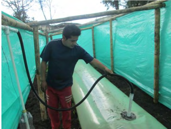
Figura 9. Instalación del conducto para el desplazamiento del biogás.
