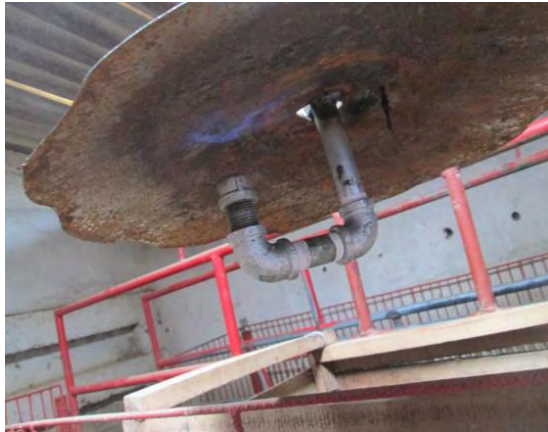
Figura 13. Instalación de calefactores en granjas porcícolas .
