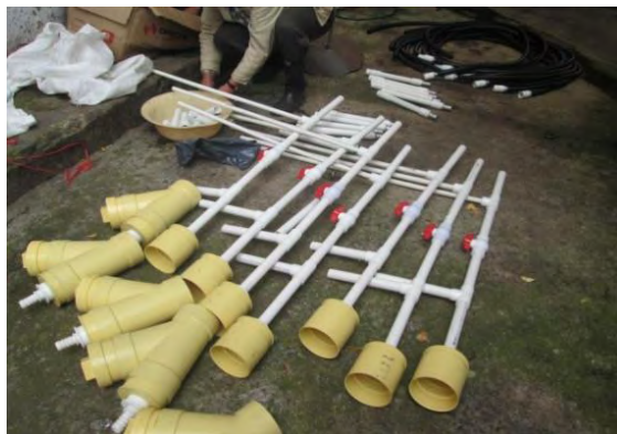
Figura 5. Construcción de estructuras de biodigestor.
