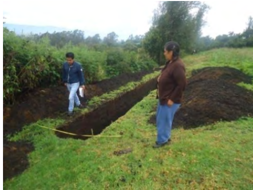
Figura 3. Trazado y excavación de la zanja. Usuarios ASOPPUNAR
