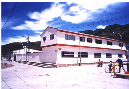
Fachada Principal-Avenida Los Estudiantes
