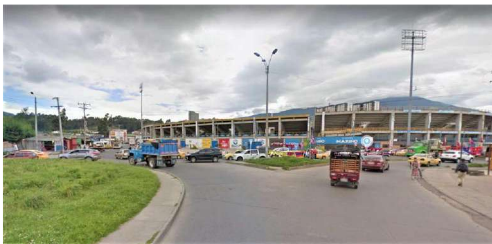
Figura 63. Fotografía aérea puente Estadio Libertad
