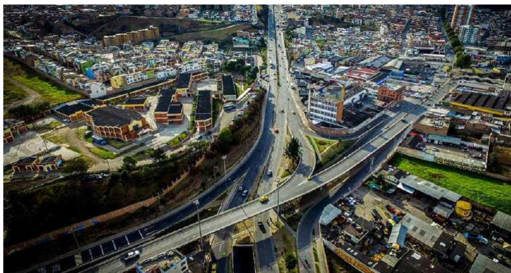
Figura 62. Fotografía aérea puente Estadio Libertad
