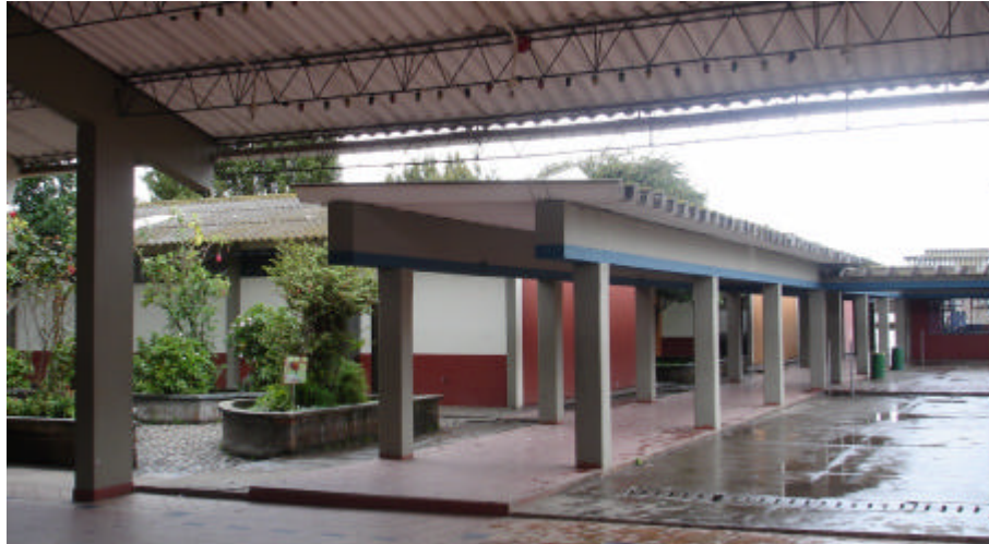
Foto. 2 Vista interna de las Instalaciones de la Institución Ciudad de Ipiales Área Cafetería y salones.
