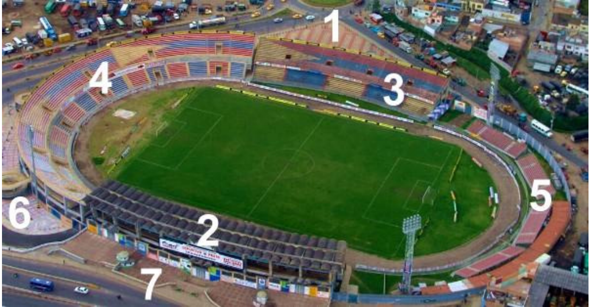
Figura 69. Vista aérea del estadio Libertad.
