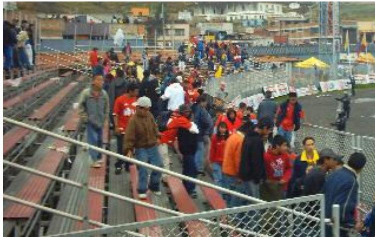
Figura 72. Vista interna de las tribunas metálicas de sur.
