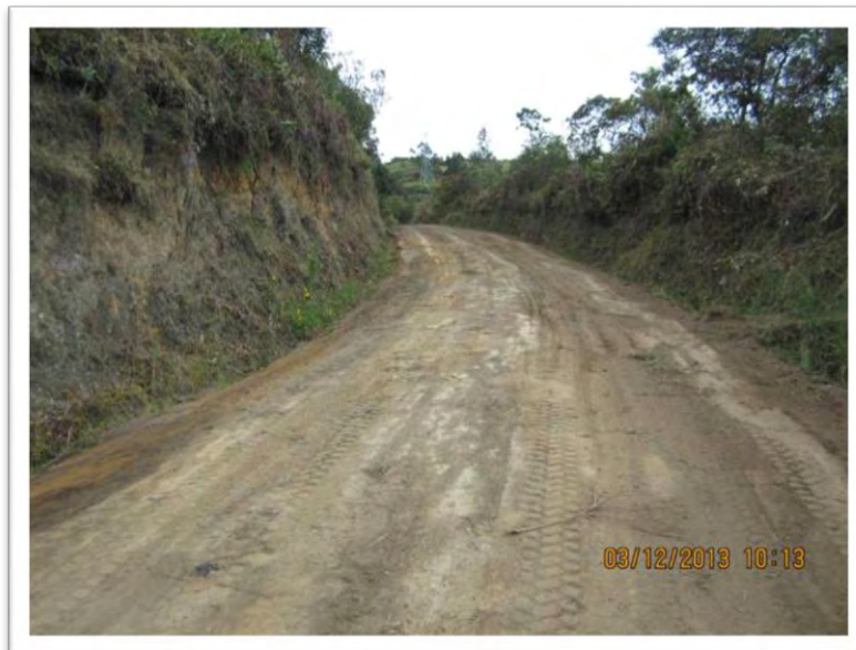
Fotografía N° 5.20 Vía Mejía - La Pradera después de la intervención.
