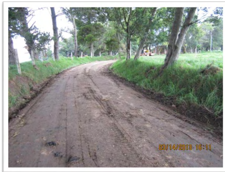
Fotografía N° 5.23 Vía Yacuanquer – La estancia. Vía después de la intervención.
