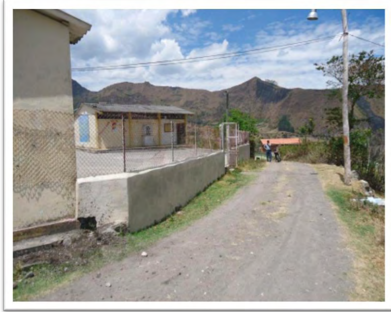
Fotografía N° 5.9 Vía Taznaque PR 8+430 – La Cocha antes de ser intervenida.
