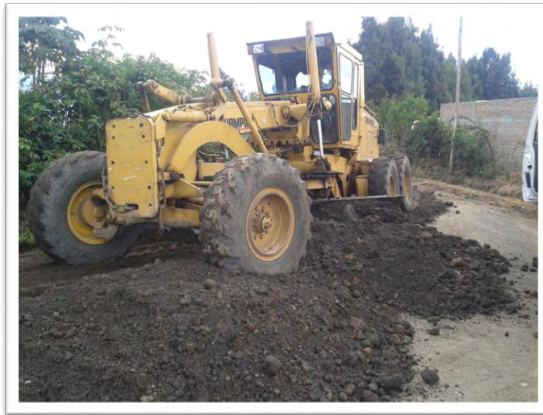
Fotografía N° 5.21 Vía Yacuanquer – La estancia. Trabajos en la vía 1.
