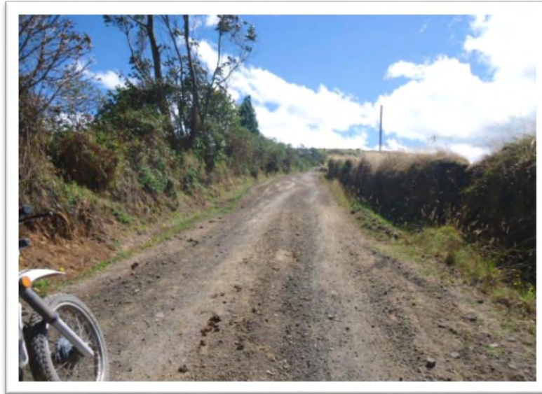
Fotografía N° 5.19 Vía Mejía - La Pradera antes de intervención.
