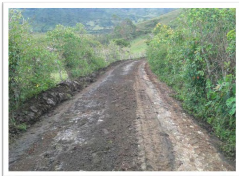
Fotografía N° 5.13 Vía Circunvalar Al Galeras K 18+940 – Zaragoza después de intervención.
