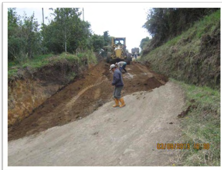
Fotografía N° 5.17 Vía El Rosario - San José De Córdoba. Trabajo en la vía.
