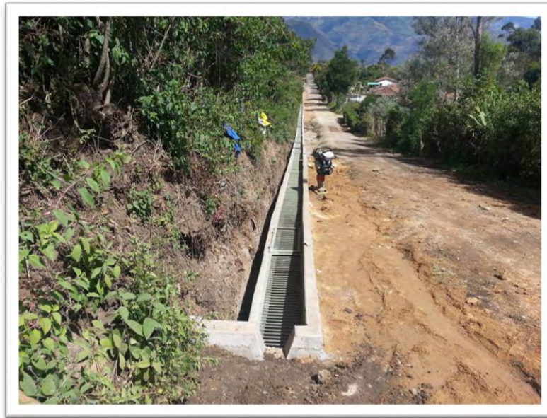
Fotografía N° 5.26 Vía circunvalar al Galeras PR 13+800 – Chapacúal bajo. Trabajos en la obra.
