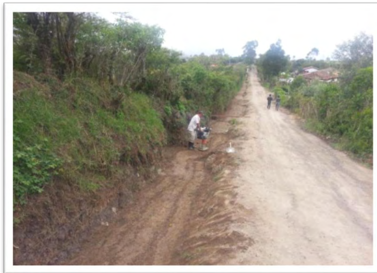
Fotografía N° 5.25 Vía circunvalar al Galeras PR 13+800 – Chapacúal bajo. Trabajos en la obra.
