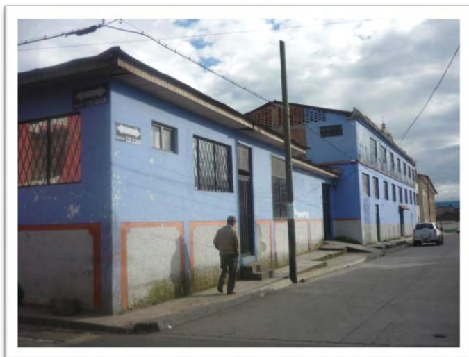
Fotografía N° 5.2 Instalaciones existente del Colegio Pedro León Torres
