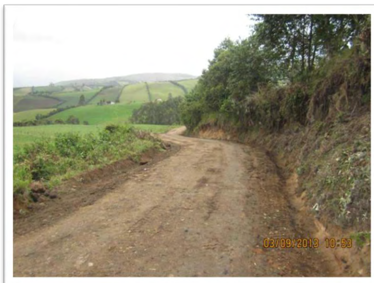
Fotografía N° 5.18 Vía El Rosario - San José De Córdoba después de intervención.
