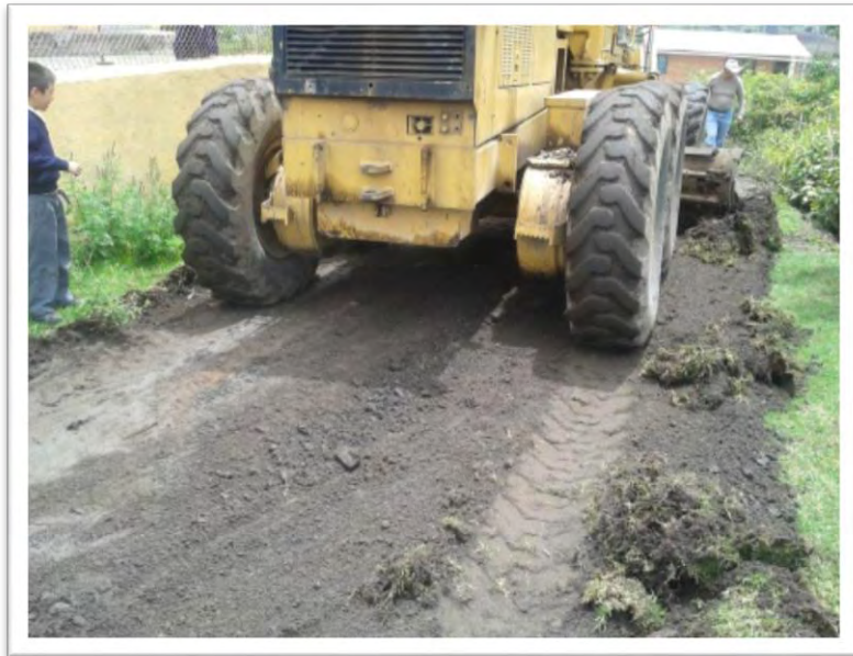
Fotografía N° 5.10 Vía Taznaque PR 8+430 – La Cocha Trabajos en la vía.
