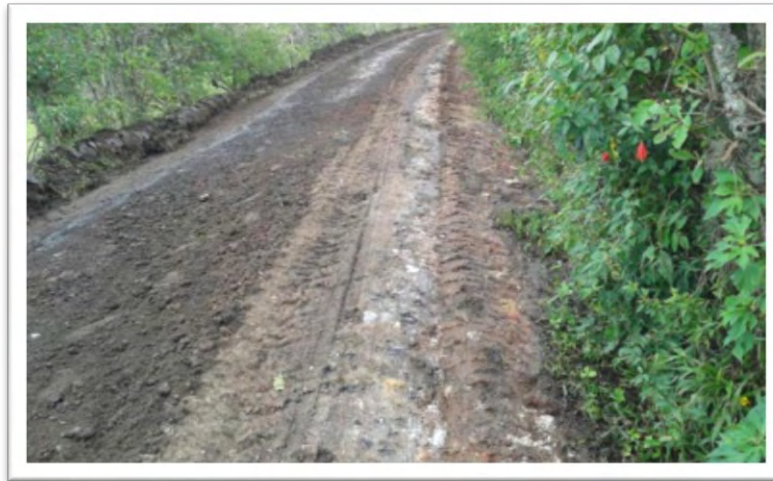
Fotografía N° 5.15 vía circunvalar al Galeras PR 13+454 - Chapacúal alto después de intervención.
