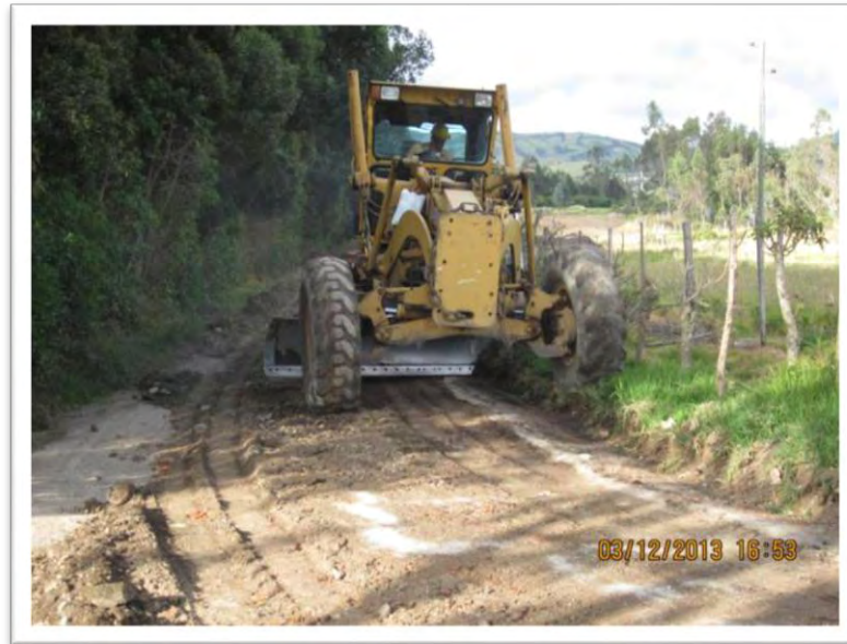
Fotografía N° 5.22 Vía Yacuanquer – La estancia. Trabajos en la vía 2.
