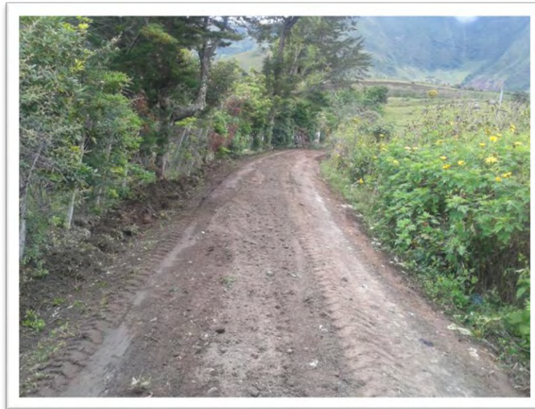
Fotografía N° 5.11 Vía Taznaque PR 8+430 – La Cocha Estado final de la vía.
