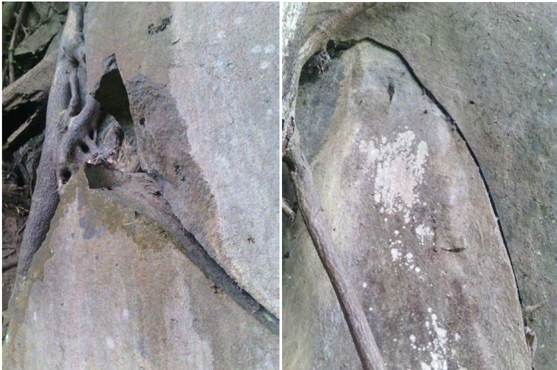
Foto 16. Fracturamiento de la roca del higuerón- desestabilización del lugar.
