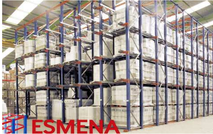
Figura 9. Estantería Drive in o Drive Through (d)
