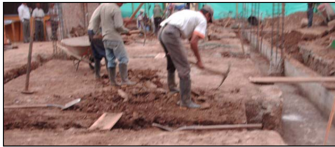
Figura 89. Excavación material común.
