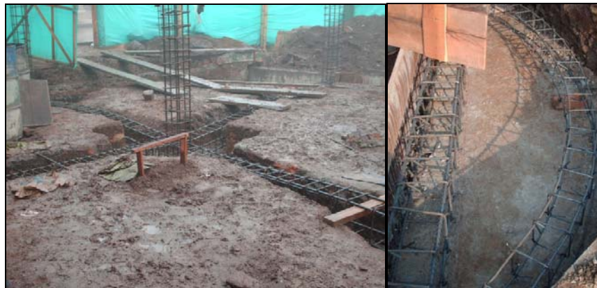
Figura 90. Armado del acero de refuerzo.
