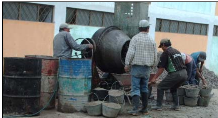
Figura 84. Producción del concreto en obra.
