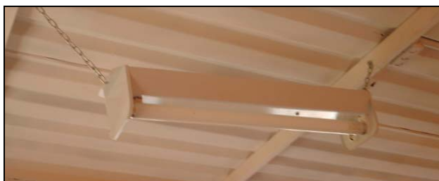
Figura 23. Instalación de lámparas.
