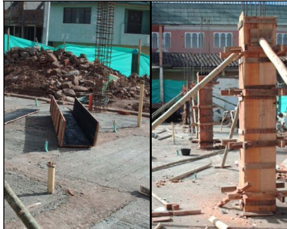
Figura 97. Encofrado de columnas.
