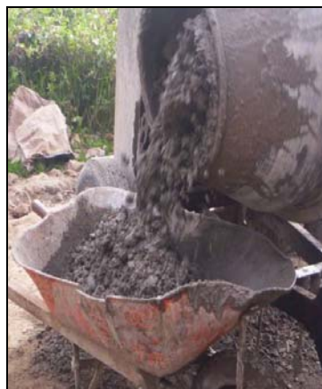
Figura 8 Producción del concreto en obra.
