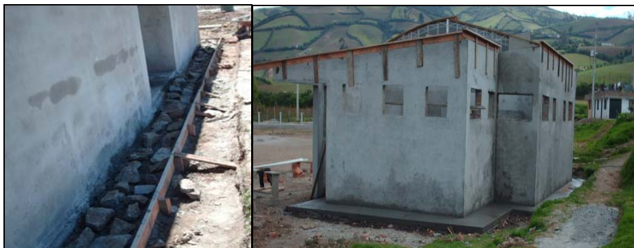
Figura 38. Fundición del andén.
