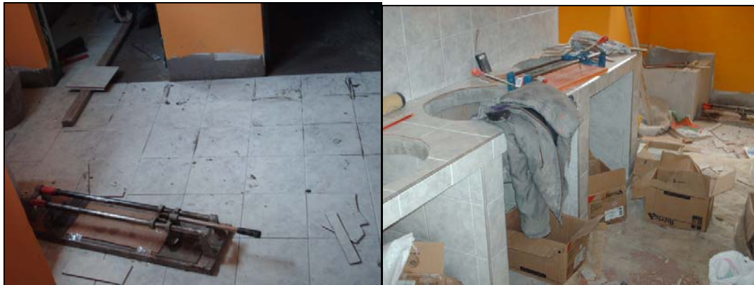
Figura 42. Cerámica en pisos y muros.
