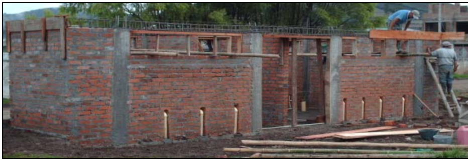
Figura 13. Fundición paca de piso
