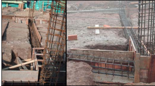
Figura 91. Encofrado para las vigas de cimentación.
