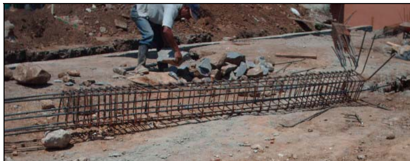
Figura 88. Puesta en pie del acero de columnas.
