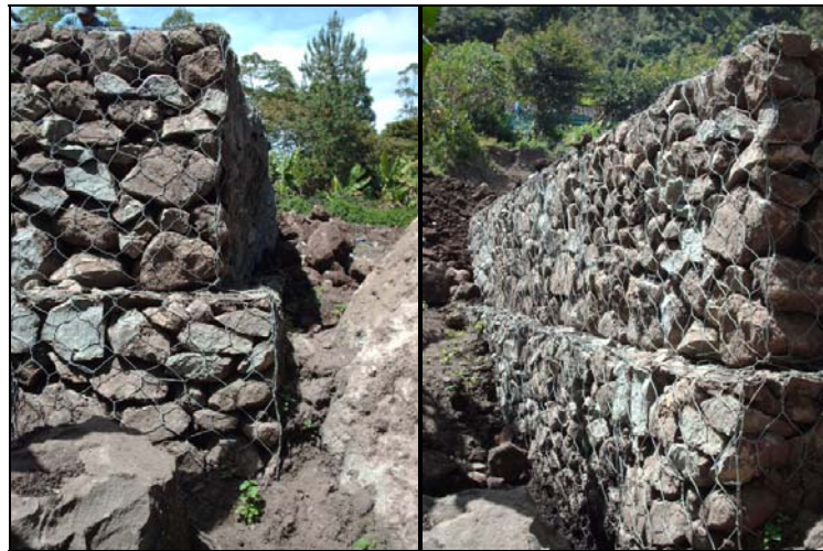
Figura 110 Muros de contención terminados.
