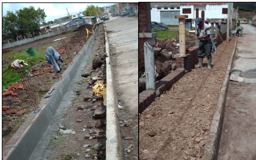
Figura 50. Muro en ladrillo.
