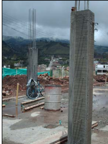
Figura 99. Desencoframiento de las columnas.
