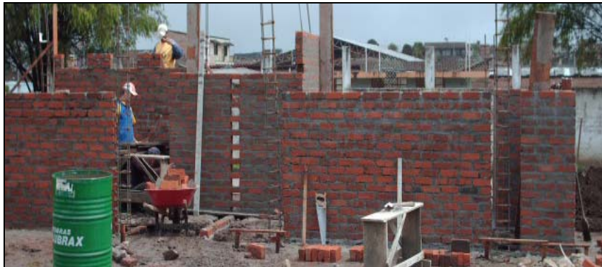
Figura 9 Fundición de columnas.
