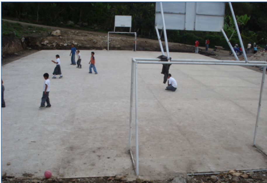
Figura 121. Terminado del polideportivo.
