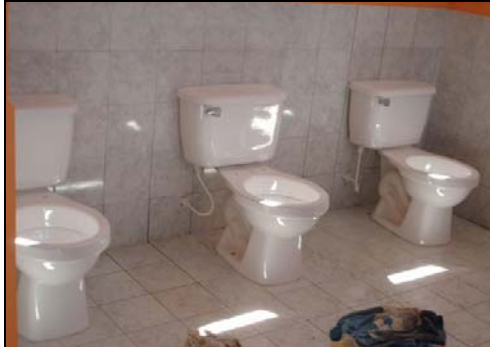
Figura 21. Instalación de sanitarios.
