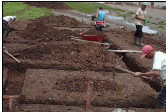
Figura 27. Excavación material común.
