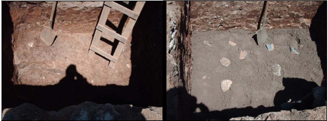
Figura 85. Excavación de material común.
