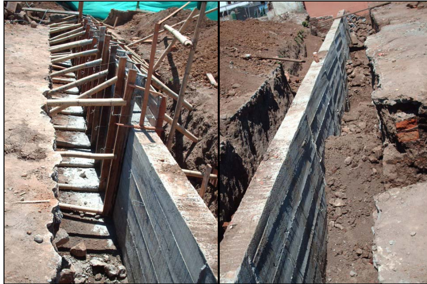
Figura 78. Desencofrado del muro.
