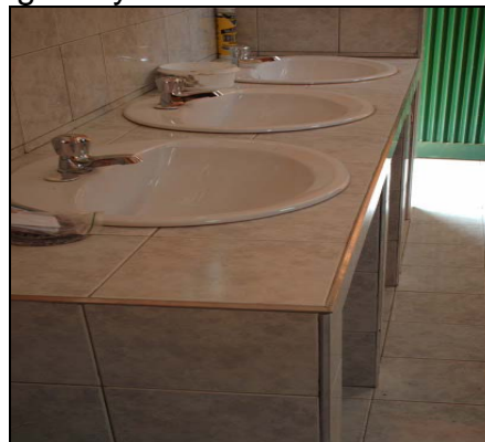
Figura 20. Instalación de grifos y lavamanos.
