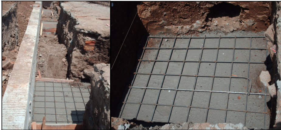
Figura 87. Instalado de la parrilla.
