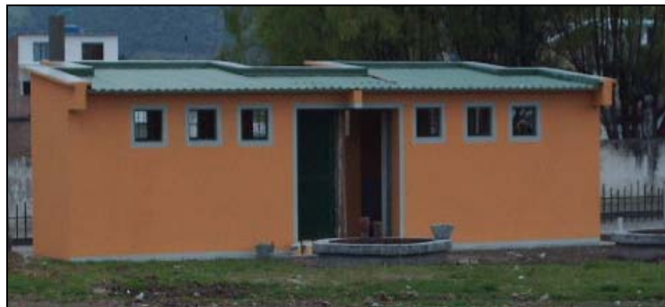
Figura 25 Batería sanitaria terminada.
