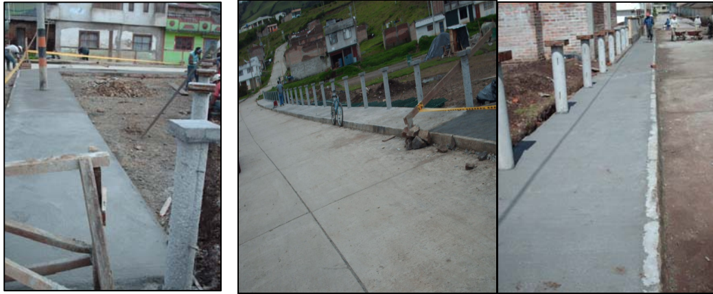
Figura 53. Fundición del sardinel.
