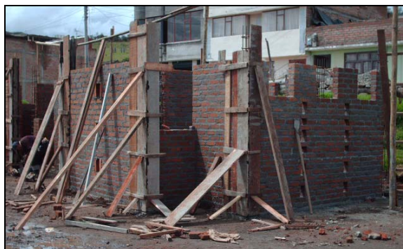
Figura 30. Fundición de columnas.
