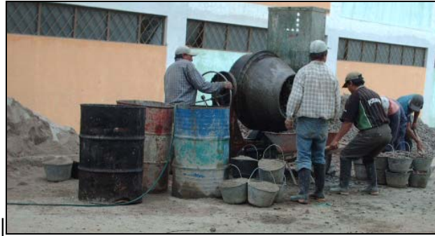
Figura 74. Vaciado del concreto.
