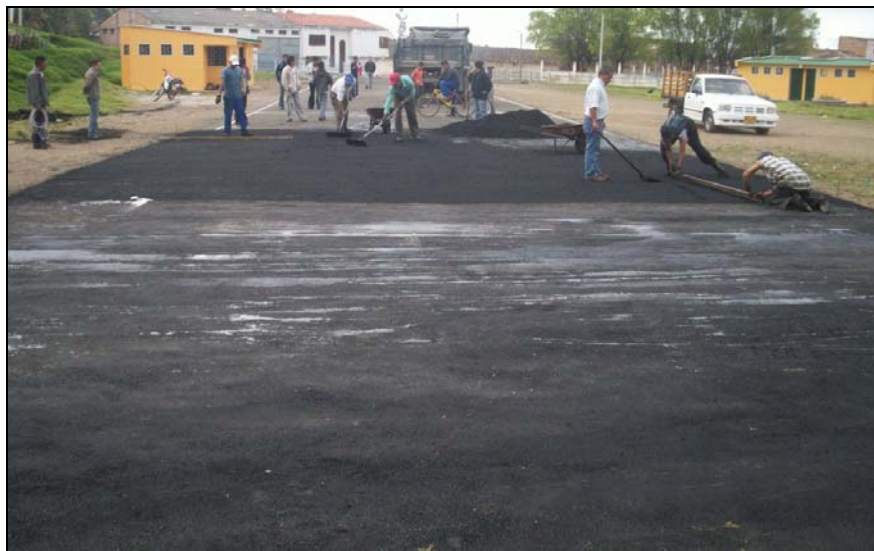
Figura 61. Aplicación del riego asfáltico.
