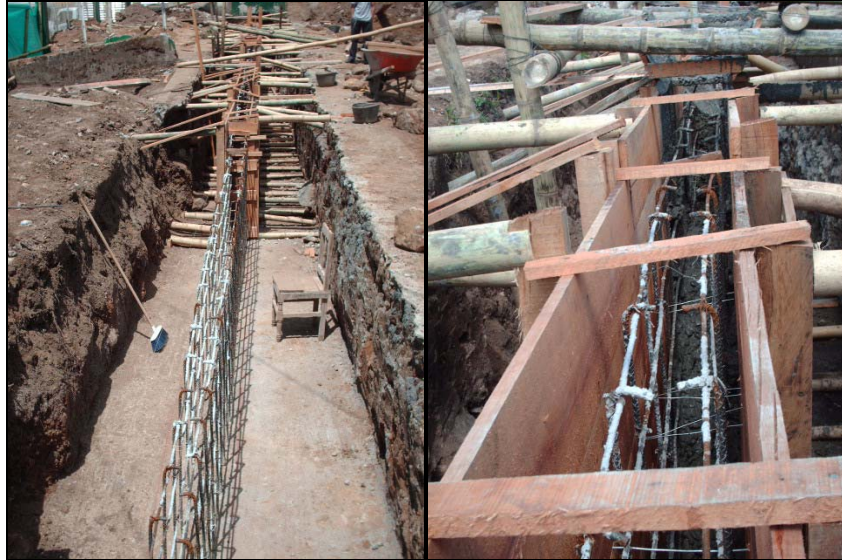
Figura 76. Encofrado del muro.
