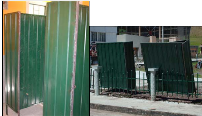
Figura 24 Puerta metálica baño.
