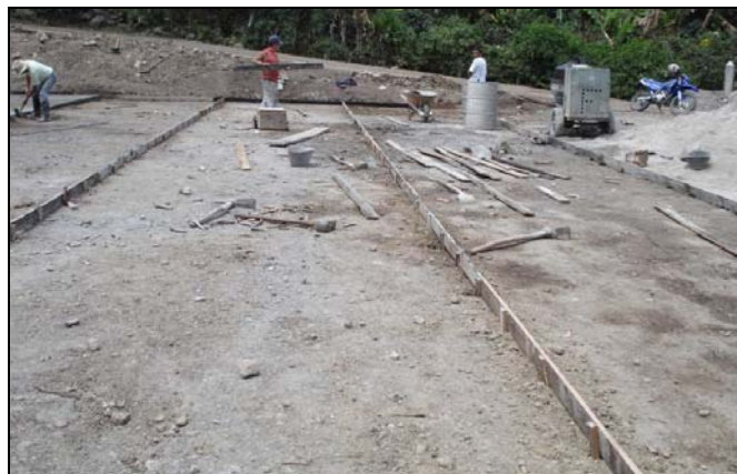
Figura 114. Colocación de la formaleta.
