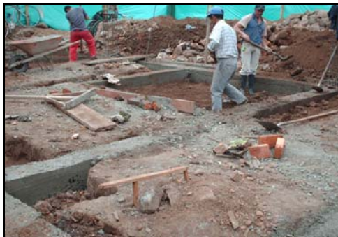
Figura 93. Excavación de material común.
