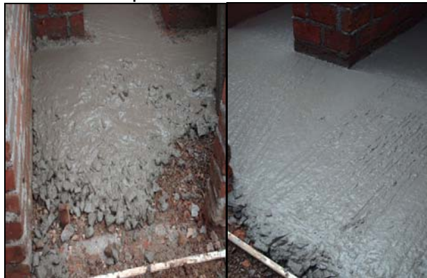
Figura 34. Fundición de losa de piso.
