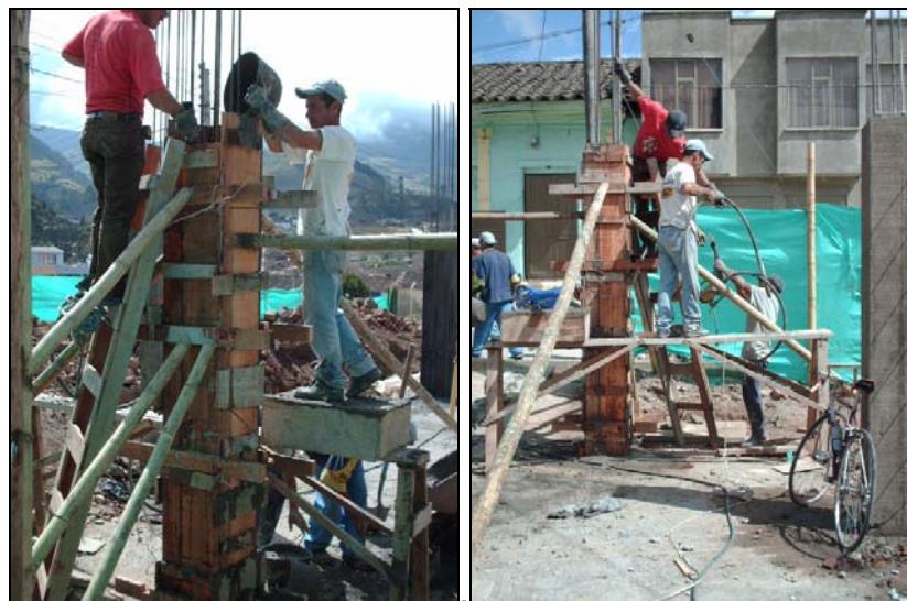
Figura 98. Vertimiento y vibrado del concreto.
