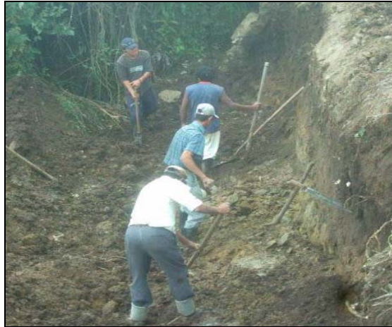
Figura 107. Excavación de material común.
