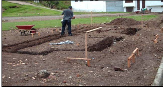
Figura 6 Excavación material común.
