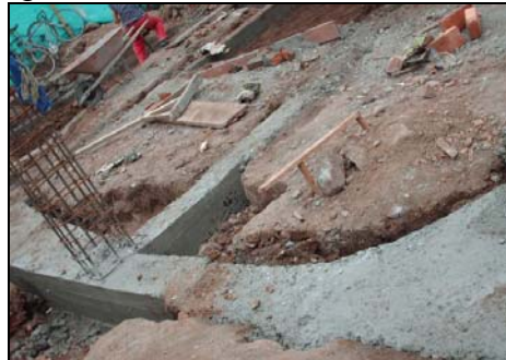
Figura 92. Fundición de vigas de cimentación.
