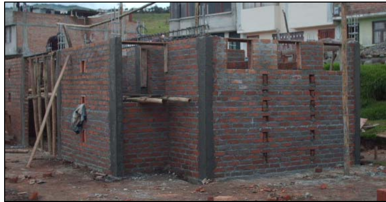
Figura 33. Fundición de dinteles.
