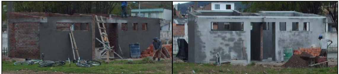
Figura 16. Repello de muros.
