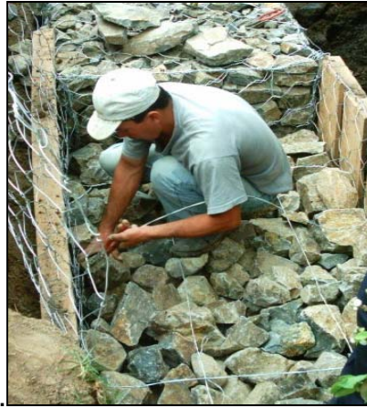
Figura 109. Instalación de los tensores.
