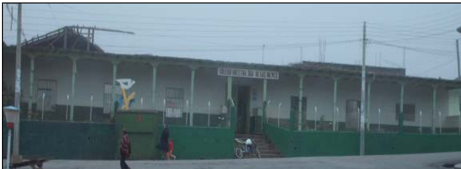
Figura 64. Demolición de fachada.
