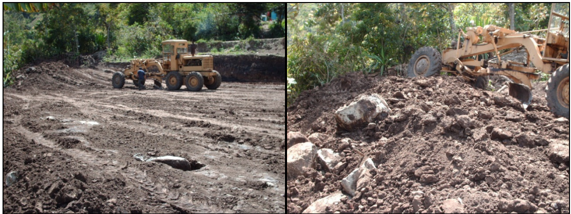
Figura 112. Nivelacion y perfilado.
