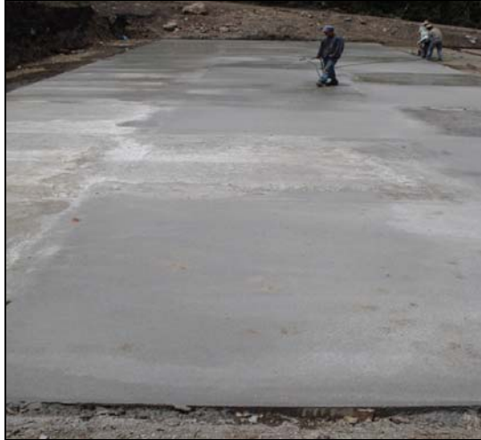
Figura 120. Curado del concreto.
