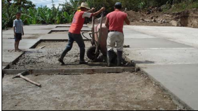
Figura 117. Vaciado del concreto.
