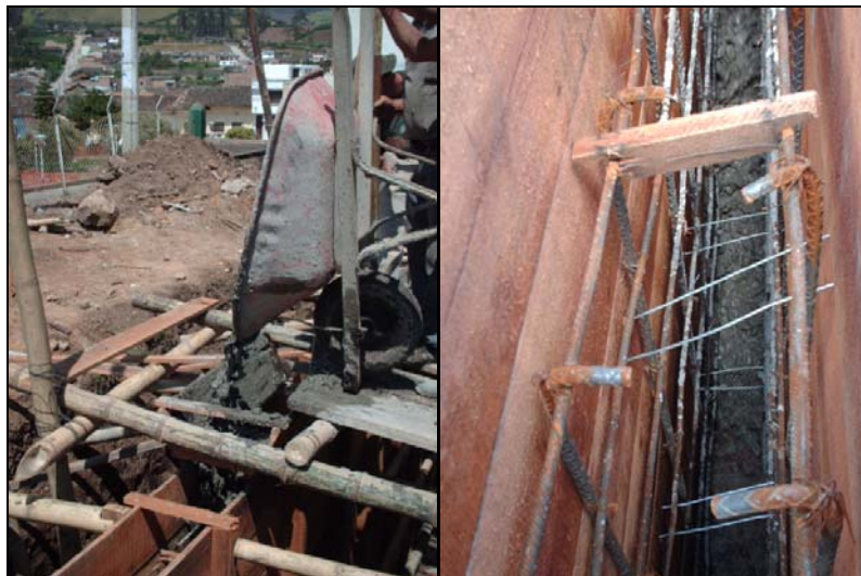
Figura 77. Fundición del muro.
