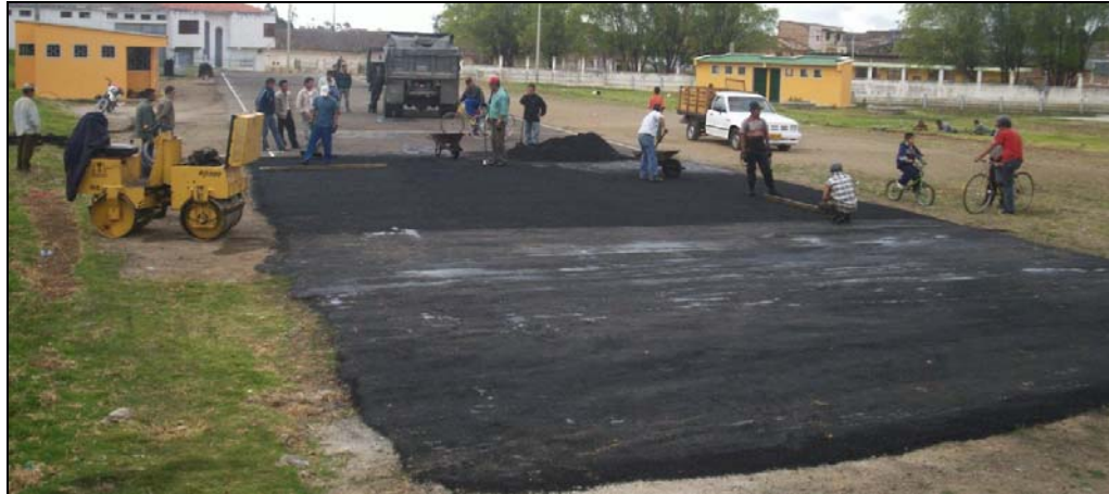
Figura 62. Compactación del asfalto.
