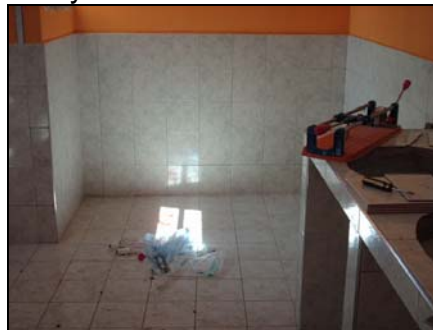
Figura 19 Cerámica en pisos y muros.
