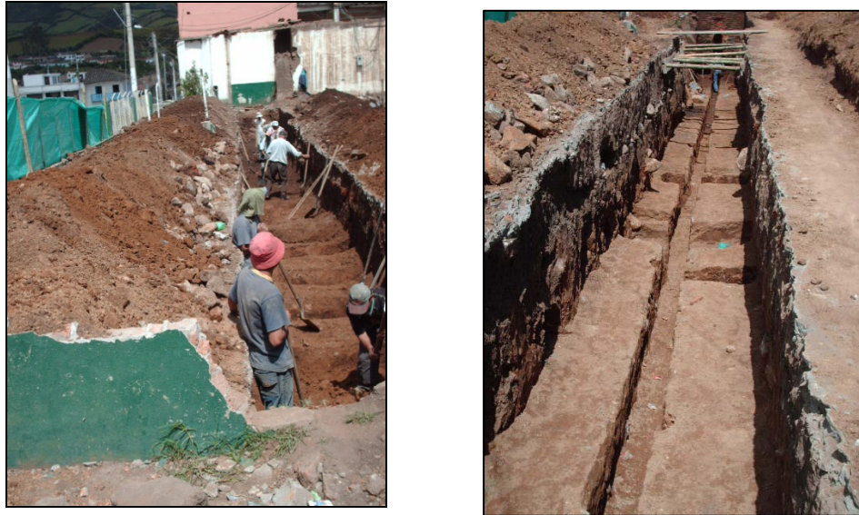
Figura 68. Excavación a mano de material común.
