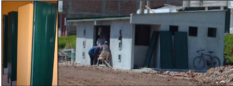
Figura 46. Instalación puertas metálicas.
