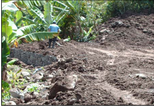
Figura 111 Relleno de los muros.
