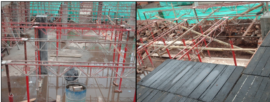
Figura 100. Apuntalamiento y formaleta de la estructura.
