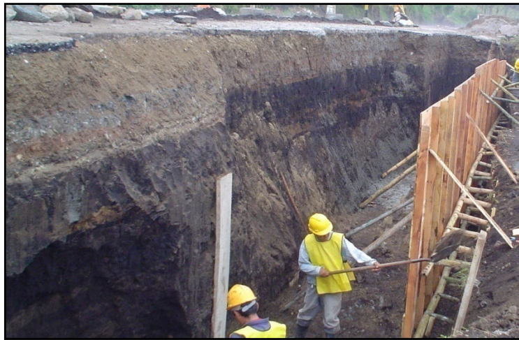
Figura 33. Encofrado para elevación.
