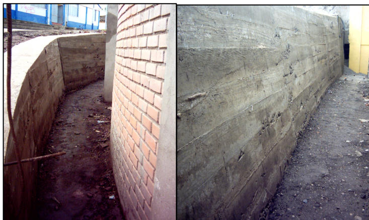
Figura 38. Vista estructura sin formaleta.
