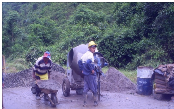
Figura 50. Transporte del concreto
