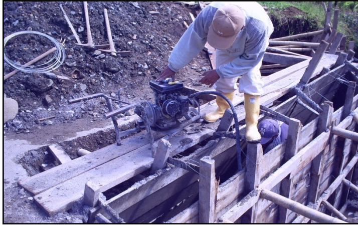
Figura 60. Aplicación de vibrador mecánico.
