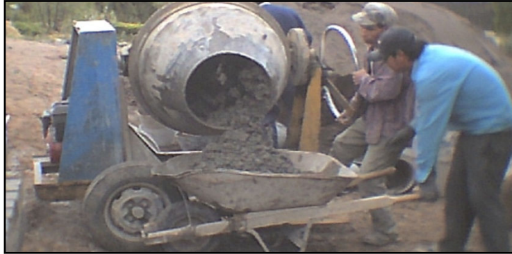
Figura 7. Transporte del concreto
