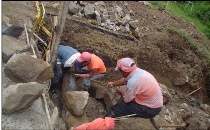
Figura 45. Demolición de pedraplen.
