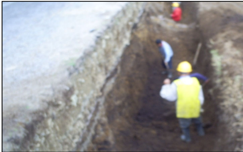
Figura 23. Excavaciones para cimentación.
