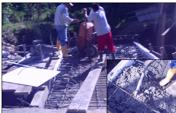
Figura 67. Fundición de losa.
