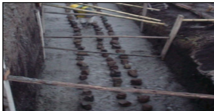
Figura 32. Fundición de rajón para junta.
