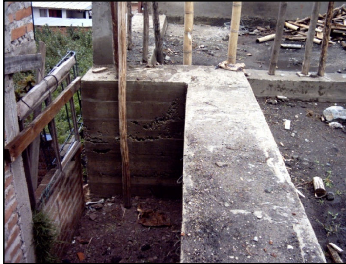
Figura 18. Vista estructura sin formaleta.
