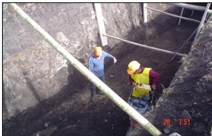
Figura 22. Replanteo y demarcación.
