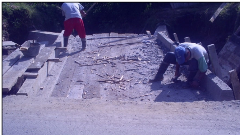
Figura 63. Armado de formaleta para losa.
