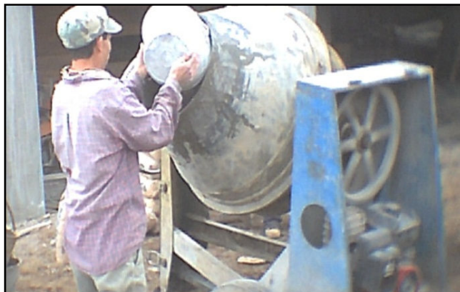
Figura 24. Producción del concreto en obra
