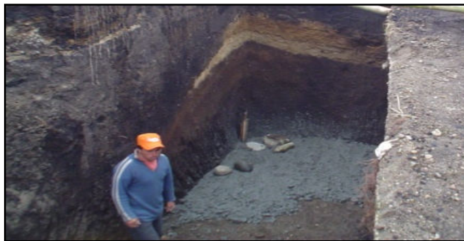
Figura 31. Fundición de zarpa.
