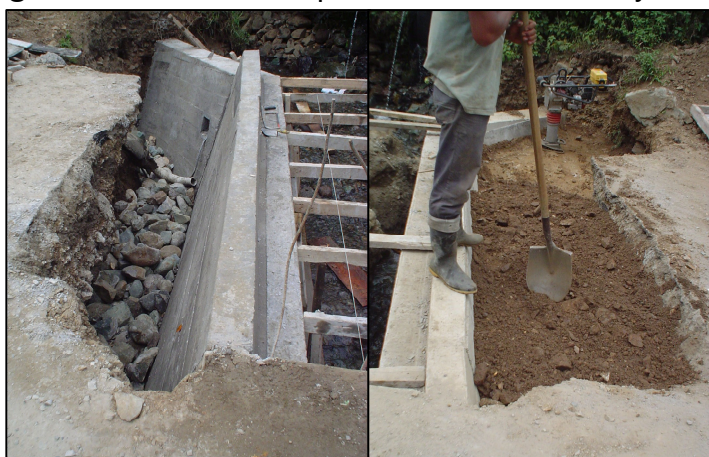
Figura 71. Relleno compactado sobre estribo y aleta.
