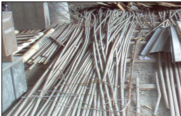
Figura 30. Almacenamiento de hierro bajo techo.
