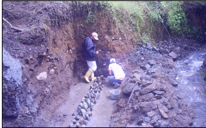
Figura 56. Fundición de rajón para junta.
