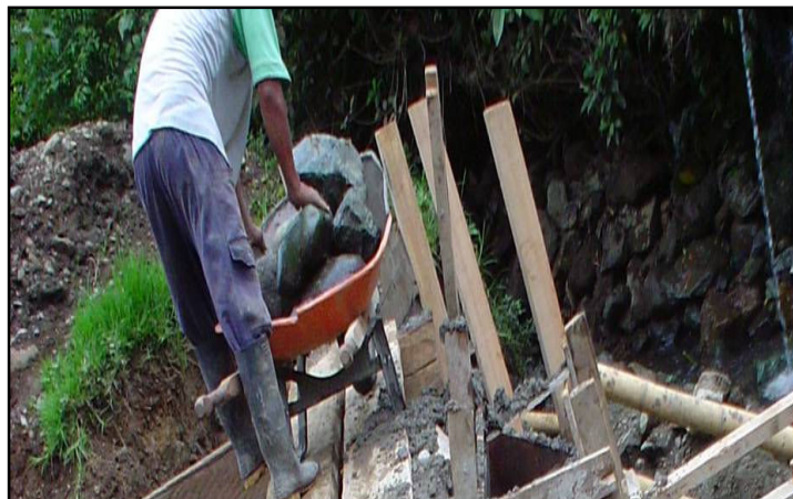
Figura 59. Canaletas para vaciado del concreto.
