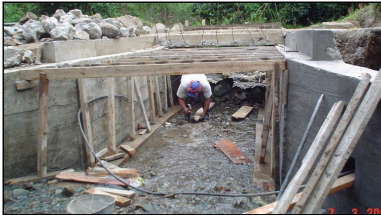
Figura 62. Vista estructura sin formaleta
