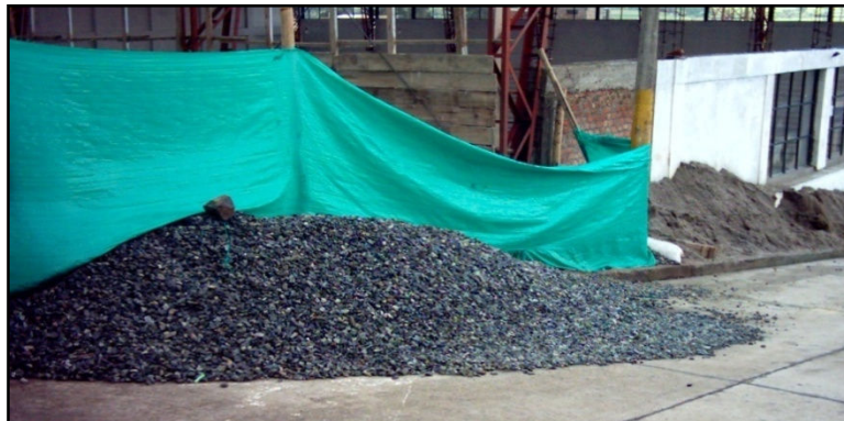
Figura 8. Almacenamiento de material.
