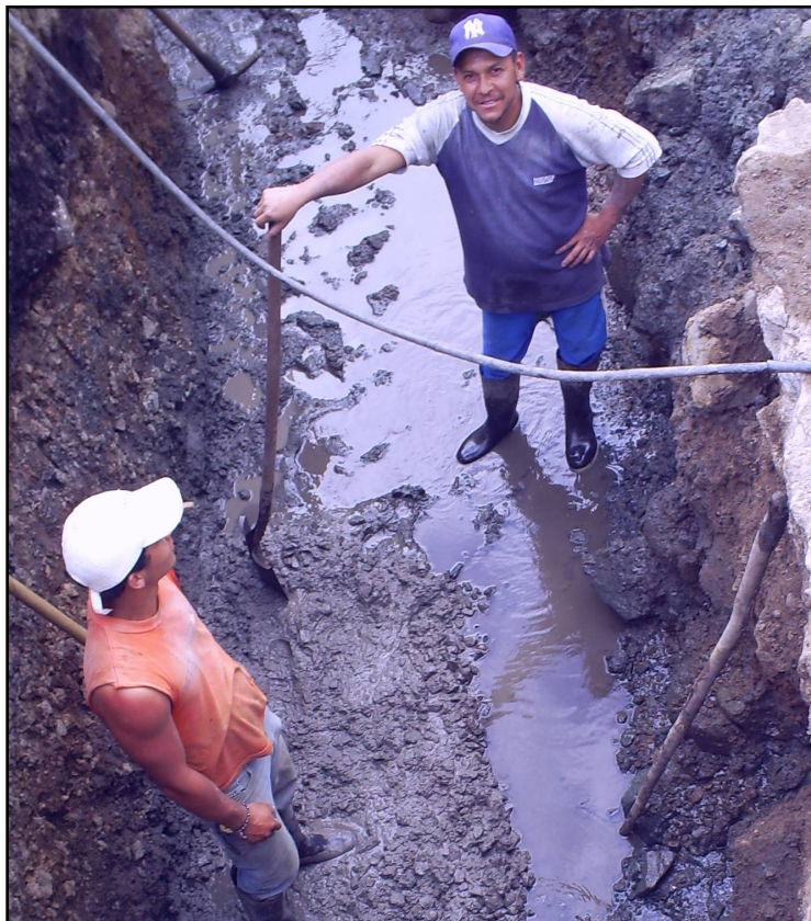
Figura 55. Fundición de zarpa.
