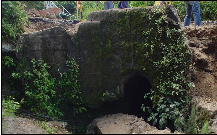
Figura 44. Replanteo y marcación.
