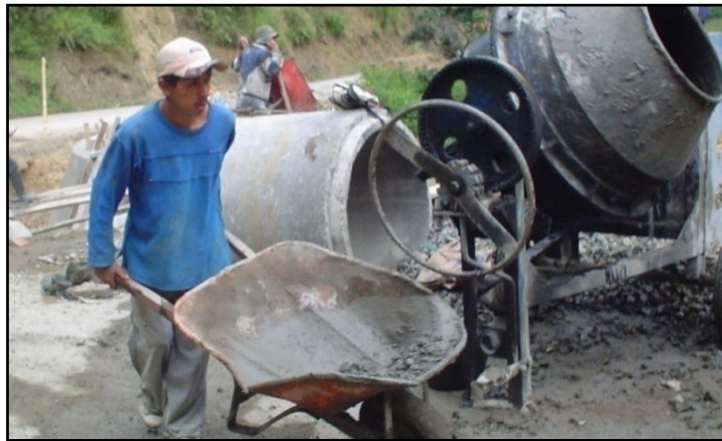
Figura 27. Transporte del concreto
