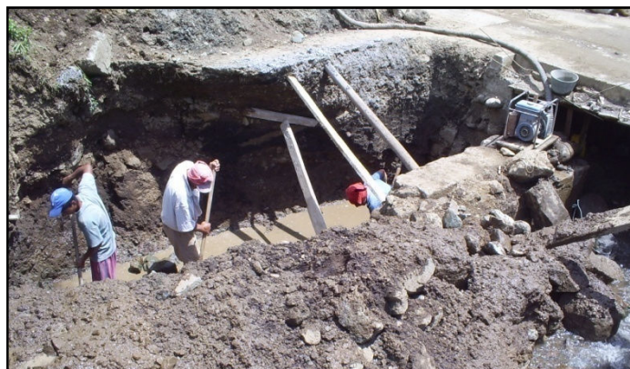
Figura 46. Excavaciones para cimentación.
