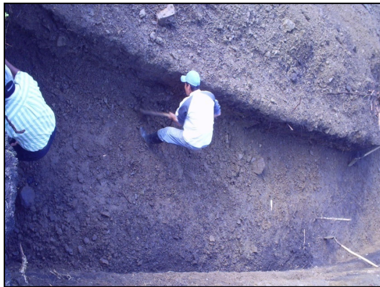
Figura 4. Excavaciones para cimentación.
