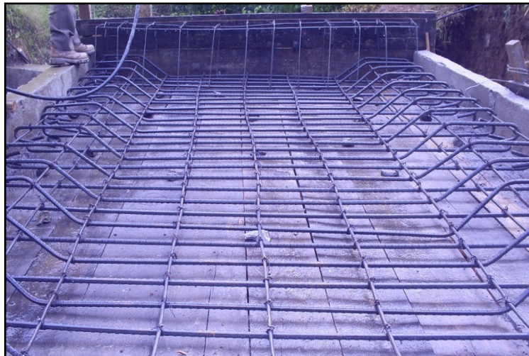
Figura 65. Colocación de refuerzo para losa.
