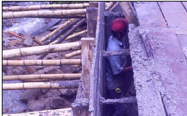
Figura 61. Instalación de tubería para drenaje.
