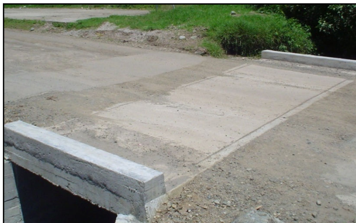
Figura 70. Vista de losa sin formaleta.
