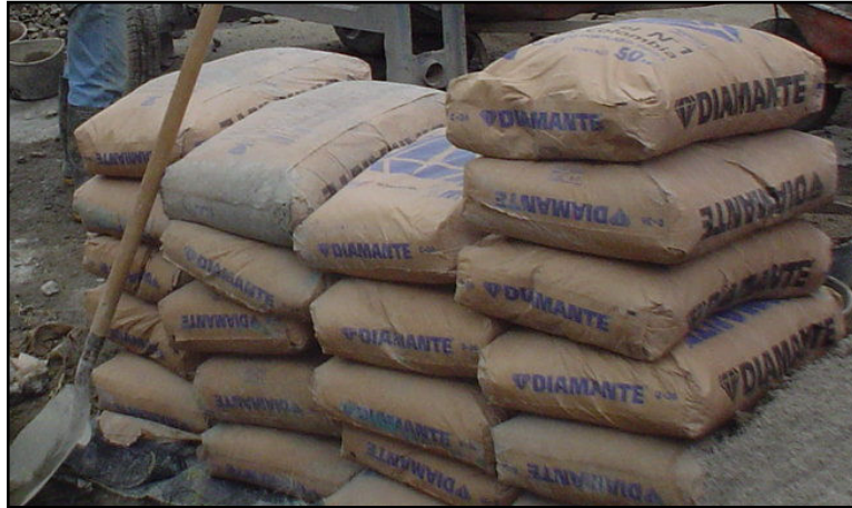
Figura 29. Almacenamiento del cemento.
