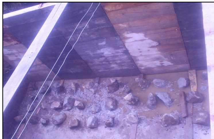
Figura 13. Encofrado para elevación.
