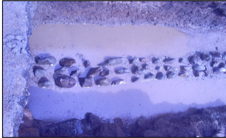
Figura 12. Fundición de rajón para junta.
