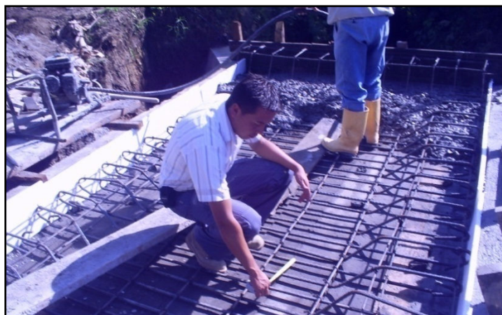
Figura 66. Verificación de espacio entre acero de refuerzo.
