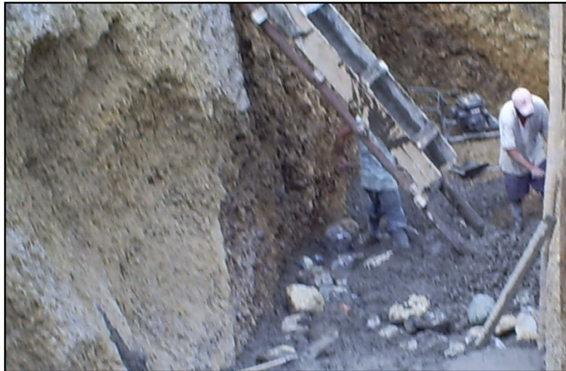
Figura 11. Fundición de zarpa.
