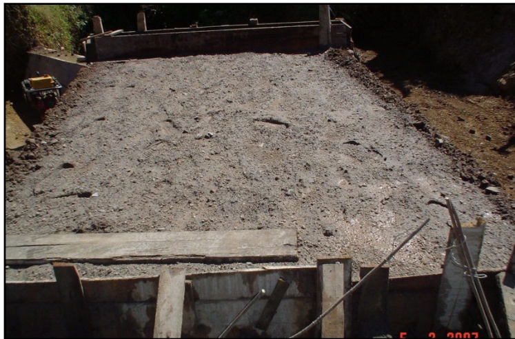
Figura 69. Curado de concreto.
