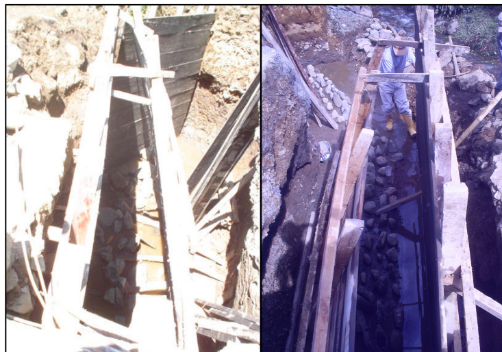
Figura 57. Encofrado para elevación.
