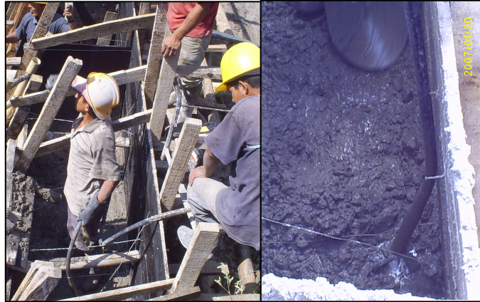
Figura 16. Aplicación de vibrador mecánico.
