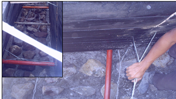
Figura 17. Instalación de tubería para drenaje.
