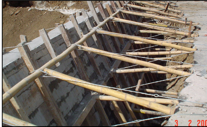
Figura 35. Canaletas para vaciado del concreto.
