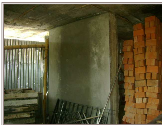
Figura 30. Reemplazo de una pantalla por dos columnas.
