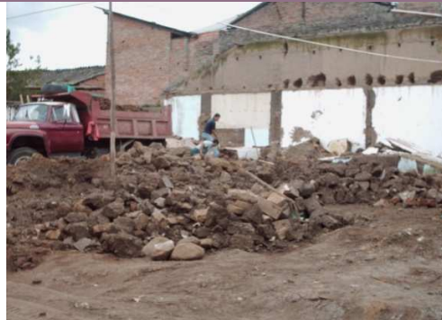
Se demolió 4 inmuebles sin licencia. Calle 13 No. 27- 42 - 52 – 56 SAN FELIPE
