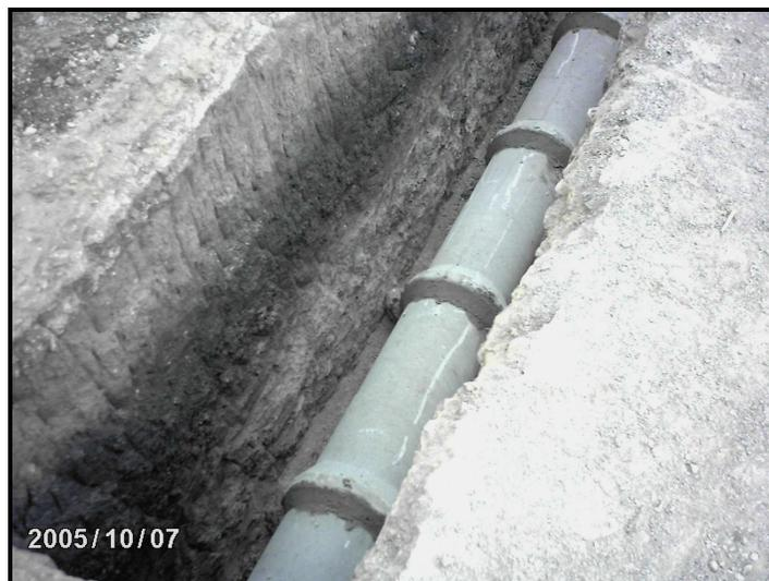
Se efectuaron las pruebas de filtración y resistencia de las tuberías de alcantarillado cumpliendo cabalmente con los requerimientos de interventoría. (Ver Fig. No 58).
