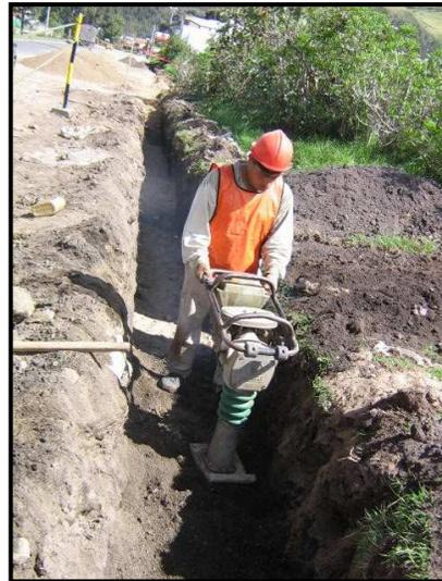
Una vez colocado el material de relleno que en algunos tramos fue en la totalidad de la excavación se procedió a rellenar con material seleccionado de la excavación previamente aprobado por interventoría. (Ver Fig. No 37).
