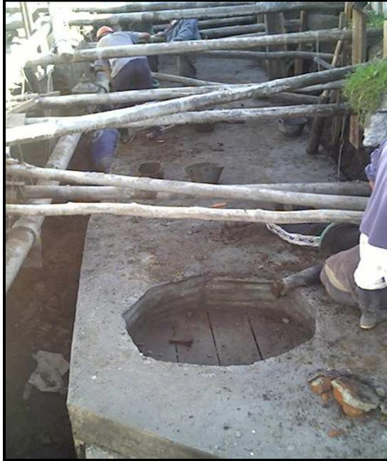
En la fundición de la losa, de los muros y de la tapa del box se utilizó agregado grueso (triturado) seleccionado de muy buena calidad, arena negra y cemento Portland, en las tres etapas de fundición se realizaron ensayos de compresión de cilindros en los cuales se obtuvieron resultados muy favorables que en algunos casos sobrepasan los 4000 psi. (Ver Fig. No 78).
