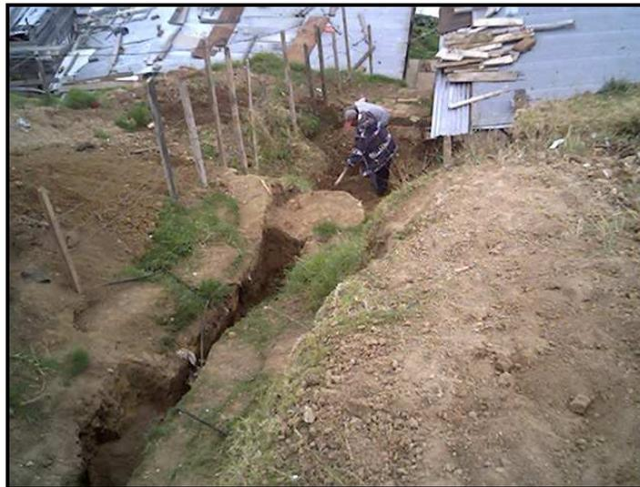
Se llevó a cabo la instalación de la tubería de presión PVC  $\frac{3}{4}$ " (Ver Fig. No 23), antes de bajar las tuberías a la excavación se debe tener cuidado que las tuberías estén bien limpias e instalarse libres de aceite, lodo o cualquier material que impida el correcto empalme de los elementos.
