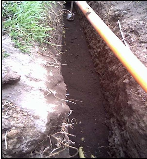
Se continúa con la construcción de las acometidas domiciliarias que constan de la instalación del conducto que permitirá el desagüe desde la cajilla domiciliar hacia la red de alcantarillado constituido por tubería de 6" en concreto en un sector y 6" en PVC sanitaria estructurada en otro tramo, así como la construcción de cajillas de 0,70 x 0,70m x 1m. (Ver Fig. No 49).
