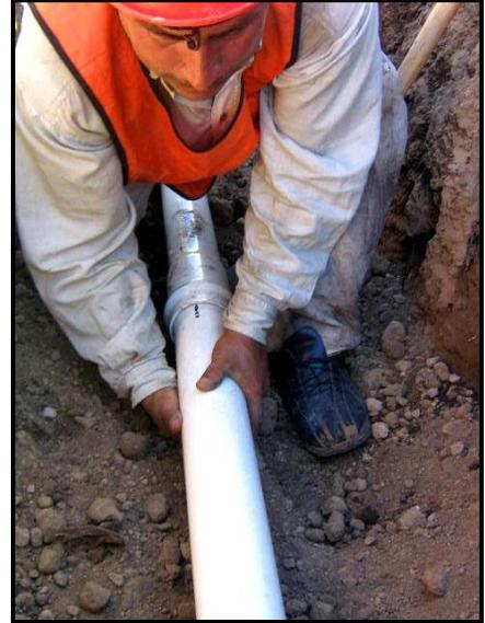
Se realizó la instalación de 3 válvulas HF de compuerta 3" con sello elástico, extremos lisos con vástago no ascendente en hierro dúctil sin rueda de manejo (Ver Fig. No 33). Los accesorios que se utilizaron son de PVC para flujo a presión que cumplen con las normas de calidad NTC-1339. Se construyó las cajillas para cada una de las válvulas en ladrillo tizón, de 0.70 x 0.70 x 1m debidamente esmaltadas.
