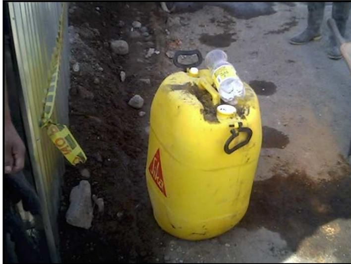
Se funde la cimentación y se le extiende un mortero impermeabilizado 1:3 con los aditivos necesarios para adquirir la impermeabilización y resistencia de  $220 \text{ kg/cm}^2$ , en la parte superior de ésta.
