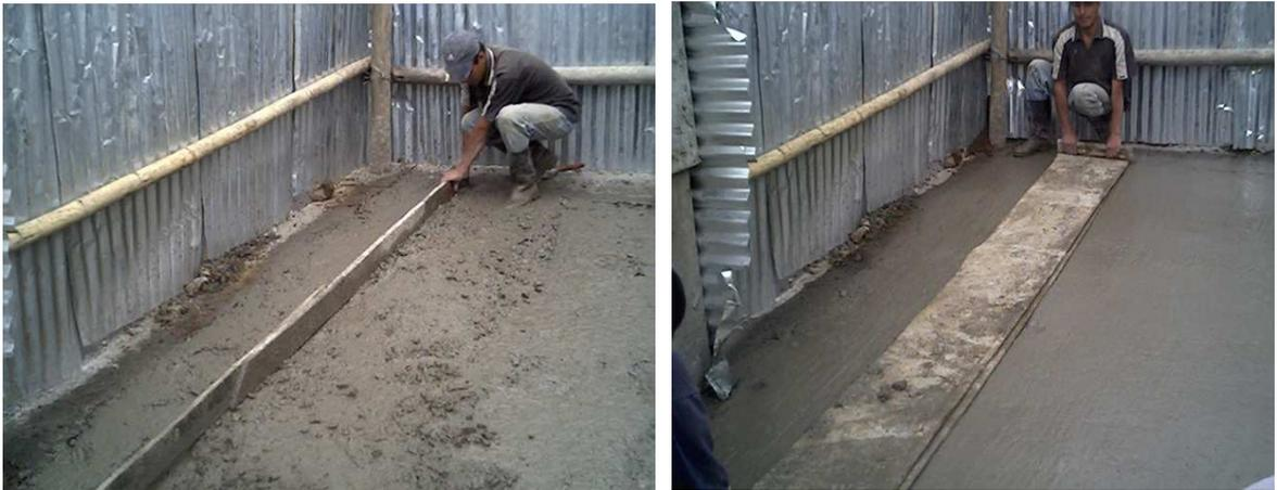
Para darle una textura adecuada al pavimento y evitar que se desgaste mas rápidamente se rozó cemento puro y se hace pasar una escoba plástica. (Ver Fig. No 87).
