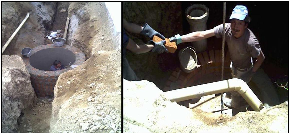
En todos los tramos de colectores de alcantarillado sanitario a construirse, correspondiente a tubería de diámetro 200mm (8"), se colocó una capa de material, conformada por cemento y recebo, para la cimentación adecuada de la tubería, la cual mejorará la capacidad portante del suelo de la base de la zanja (colchón).
