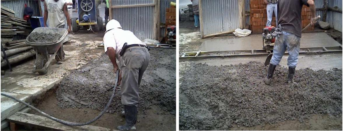
Después de tener el nivel deseado se retoca con la ayuda del codal y se le da el acabado deseado con la ayuda de una lona plástica que se hace pasar sobre el pavimento. (Ver Fig. No 86).
