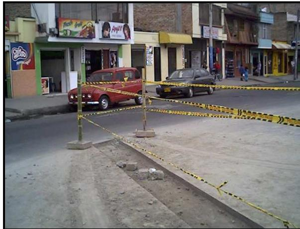
Se procede a realizar las respectivas excavaciones (Ver Fig. No 3) tanto en el andén como en la vía controlando los respectivos niveles para obtener las pendientes estipuladas dentro del diseño. En el sector del andén fue necesario desalojar el material inmediatamente debido a que se encuentra la entrada al Centro de Salud y existe gran concurrencia de peatones.
