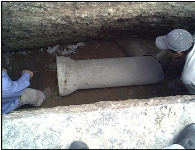
Se procede a colocar la tubería (diámetro 10" Clase 1) controlando cuidadosamente su alineamiento así como la pendiente de diseño (Ver Fig. No 5). Los tubos serán manejados cuidadosamente para evitar agrietamientos y roturas. Por ningún motivo las tuberías y accesorios se dejarán descargar volcados desde los camiones de transporte o al bajarlos a las zanjas. Para bajarlos a la excavación se deben utilizar sogas que permitan manipular el tubo y evitar posibles golpes que causen agrietamientos.
