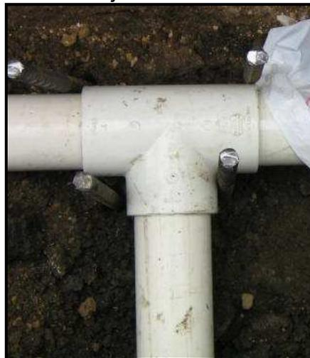
Una vez instalada y alineada la tubería se procedió a realizar el relleno compactado con material de recebo a los costados de la tubería y haciendo parte del encamado y atraque de ésta, hasta una altura de 30cm por encima de su clave exterior (relleno inicial). La compactación del terreno se realiza en capas de 15cm con ayuda de pisones manuales y saltarín. (Ver Fig. No 36).
