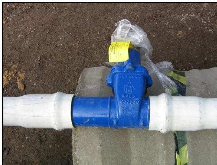
Se realizó en la abscisa K0 + 0,80 la instalación de una acometida de 3" para un proyecto urbanístico futuro en el lote de la familia Zaruma (Ver Fig. No 34), en la cual se instaló los siguientes accesorios tee PVC 3"x3"x3" UM, válvula HF Ø3" SE EL, 4 uniones de reparación PVC Ø3", tapón PVC soldado Ø3".
