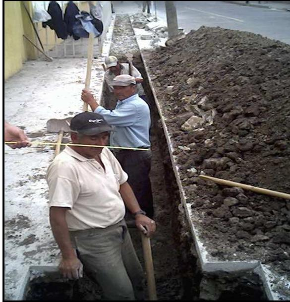
Se continuó con la colocación del material de colchón y material de atraque constituido por 50% de recebo y 50% de triturando el cual tiene un espesor de 10cm y llega hasta la mitad del tubo para servir como atraque. Se empalmó la tubería nueva al colector principal para así continuar con la instalación de la tubería aguas arriba. (Ver Fig. No 4).
