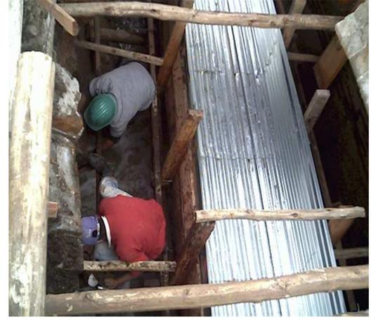
Se realiza la excavación del terreno y se toman los respectivos niveles con la ayuda de manguera y nailon, por donde se funde la cimentación en concreto ciclópeo en un espesor variable que va hasta 2,5m de profundidad y una proporción de 60% concreto simple de 2500 psi, y 40% de rajón. (Ver Fig. No 71).
