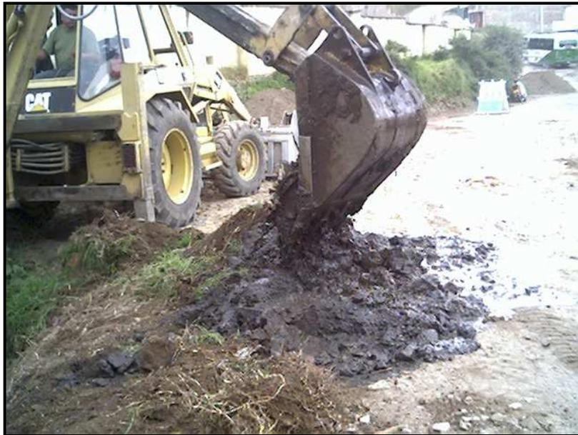
*Figura No 16. Limpieza de la entrada a la canalización de la Quebrada*
