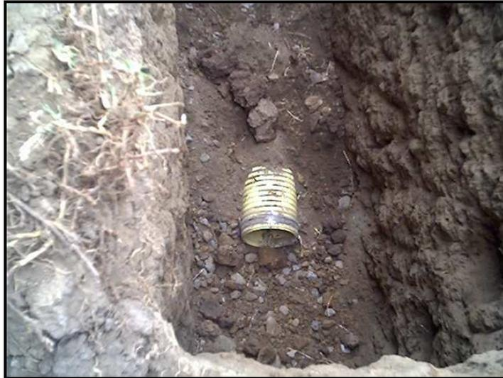
Después de colocar el material de atraque se debe aplicar relleno compactado con recebo, es el llenado de la zanja desde la cota clave de la tubería, hasta 30cm por encima de nivel de la misma. (Ver Fig. No 48).
