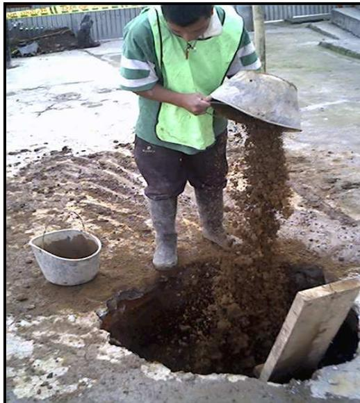
Se construye la cámara de inspección en la que se colocan peldaños cada 0,40m en hierro de diámetro mínimo de 5/8", para facilitar el ingreso del personal de mantenimiento.
