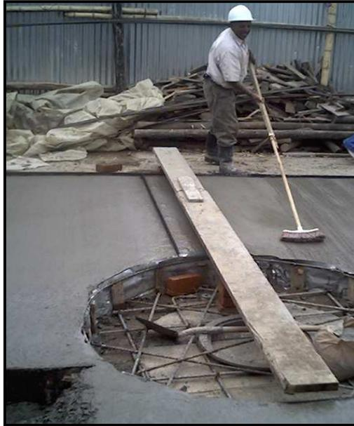
Por último se procede a efectuar el respectivo curado del concreto y la reposición de sardineles. (Ver Fig. No 88).
