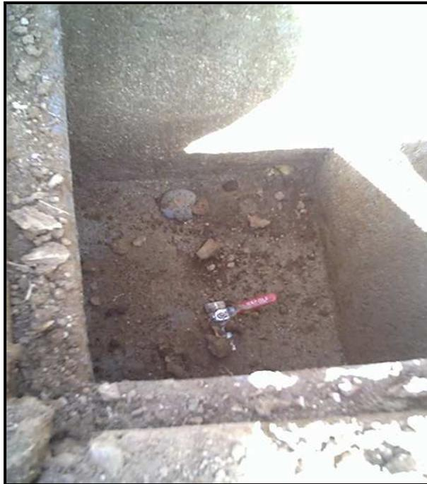
Se rellenó las excavaciones con relleno simple, este relleno se usa para el atraque del tubo, desde el nivel de la batea externa del tubo hasta 30cm por encima de la clave exterior de la tubería usada para mejorar el material de la excavación, El material se colocó y compactó en capas horizontales uniformes que no excedan 10cm de espesor compactado.
