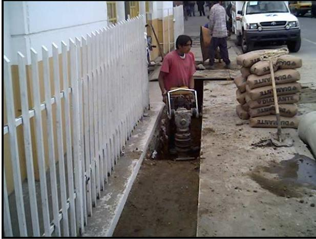
Se instala la tubería hasta la cajilla nueva (0.8m x 0.8m h = 1.7) que se construye para el cambio de dirección de la tubería, completamente esmaltada para evitar la filtración del agua, además cuenta con la cañuela para darle la curva al flujo de agua. (Ver Fig. No 7).
