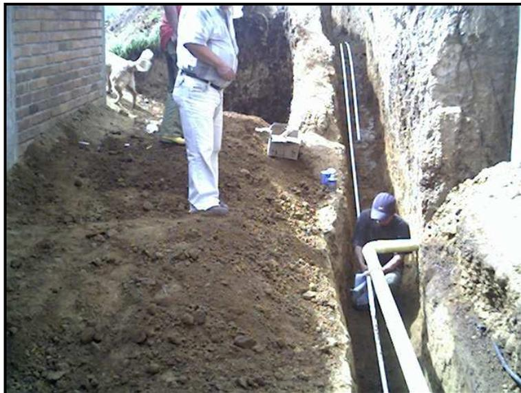
Después de realizar la respectiva instalación de tubería se instaló una Tee reducida de  $\frac{3}{4}$ " a  $\frac{1}{2}$ ", a la que posteriormente se le une un niple de tubería PVC 1/2" RDE 13.5 U.S, de una longitud de 0,30m al cual se le ensamblará un adaptador hembra, para lograr la adecuación del registro de incorporación  $d=1/2$ ", continuando en seguida con la tubería P.F, instalando finalmente el registro de corte.
