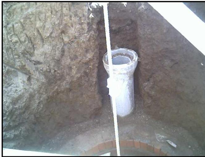
Después de colocar el material de cimentación y la instalación de la tubería se debe realizar el atraque hasta una altura igual al diámetro del colector a utilizar, para todos los tramos a construir; esta será una capa de material de mejoramiento conformada por una mezcla en proporción 1 a 1 de recebo y triturado común (50% - 50%). (Ver Fig. No 46 y 47).
