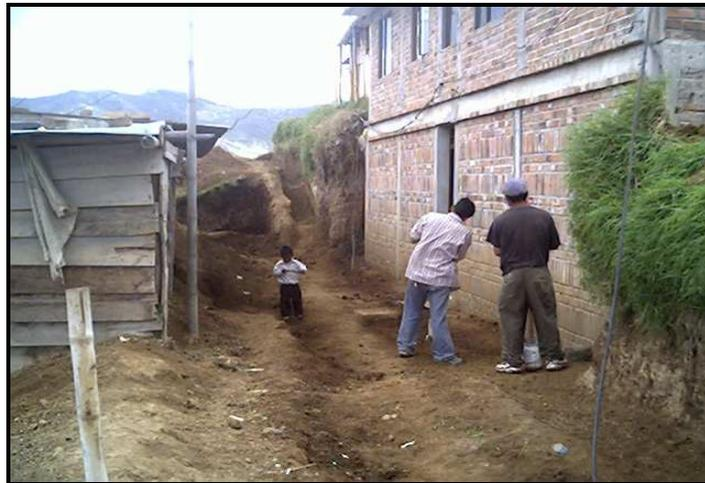
Con la colaboración del personal de mantenimiento de EMPOPASTO se procedió a efectuar los 2 empalmes correspondientes a tubería PVC de 2" que se conecta a la red abastecida del Centenario y que proporciona de agua a tres viviendas del sector bajo del barrio y 3" perteneciente a la red abastecida por el sistema Cujacal bajo.
