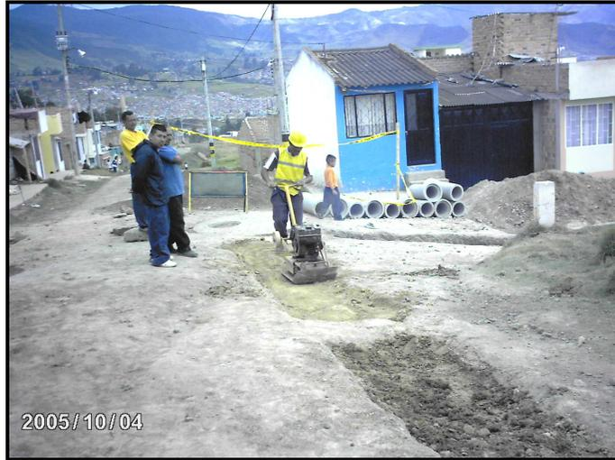
Cuando se terminó de realizar la respectiva compactación de la rasante se efectúan los ensayos de densidad para verificar el porcentaje de proctor modificado que se obtiene. (Ver Fig. No 61).
