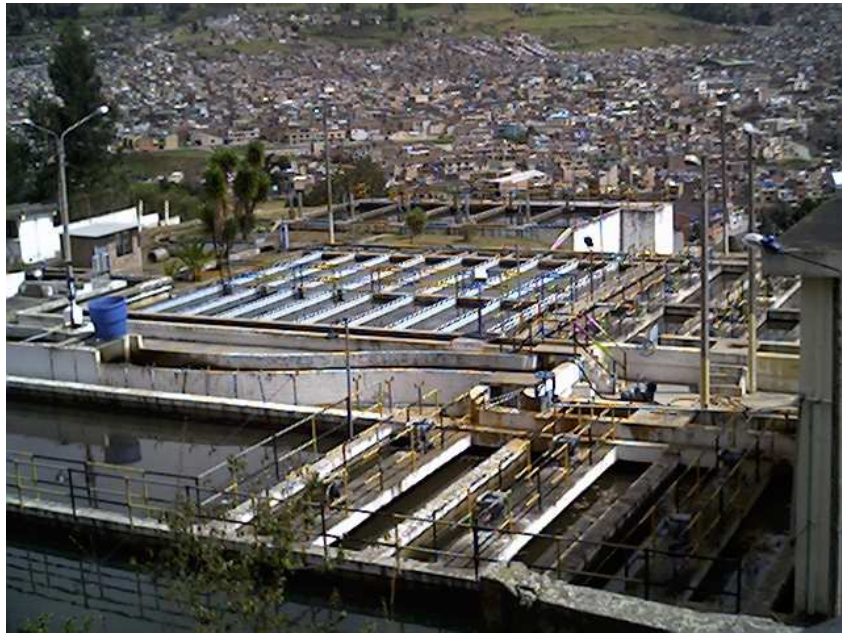
Figura 28. Vista General Planta de Tratamiento Centenario.
