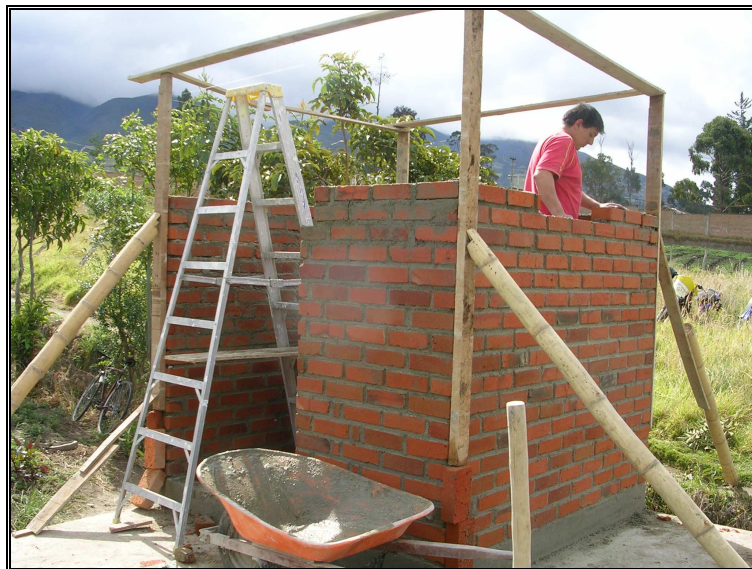
Figura 54. Construcción caseta de desinfección
