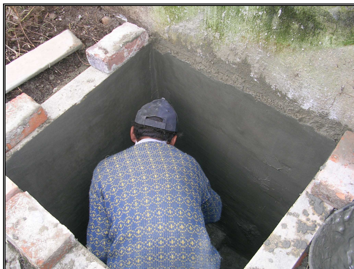
Figura 56. Construcción de cajilla para válvulas
