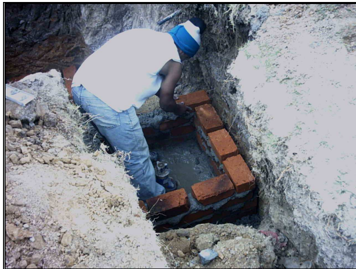
Figura 6. Construcción cajillas para válvula
