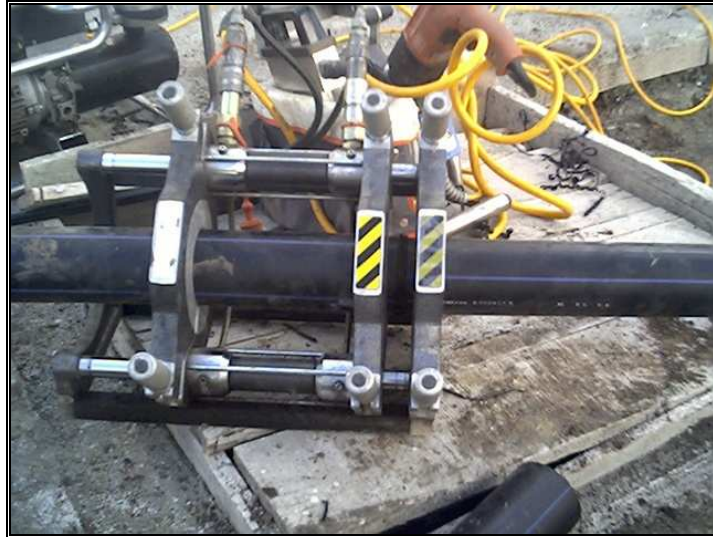
Figura 80. Unión de la tubería PE 100 PN 10 90mm
