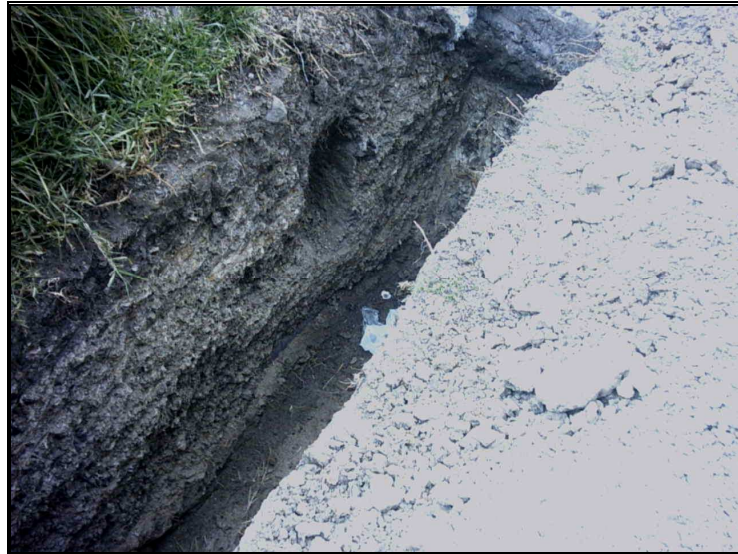
Figura 1. Excavación en material común
