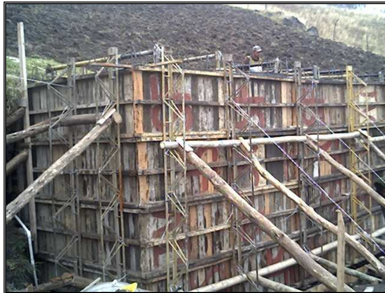
Figura 44. Armado de formaleta
