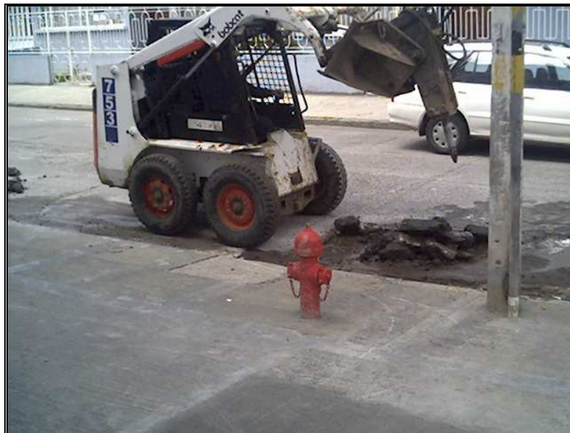
Figura 69. Corte y demolición de pavimento
