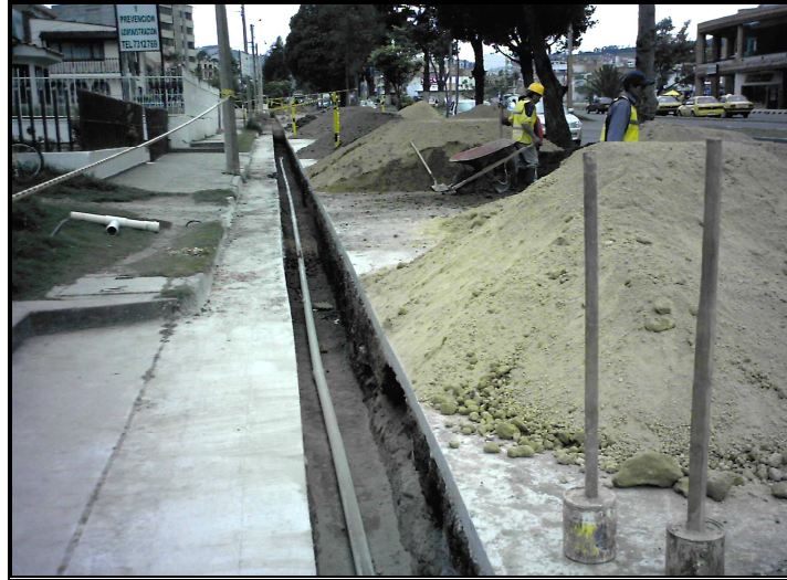
Figura 37. Instalación de tubería
