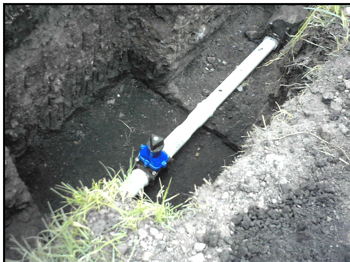
Figura 28. Instalación de válvula
