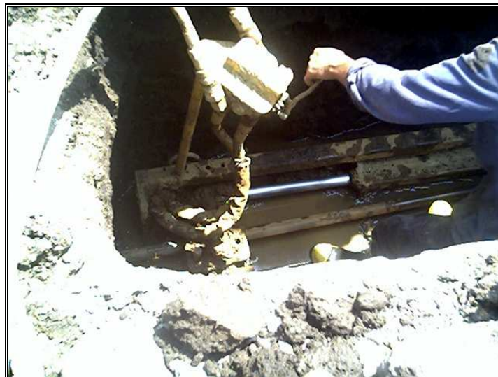
Figura 75. Introducción barras de acero
