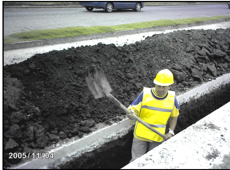
Figura 35. Excavaciones en material común
