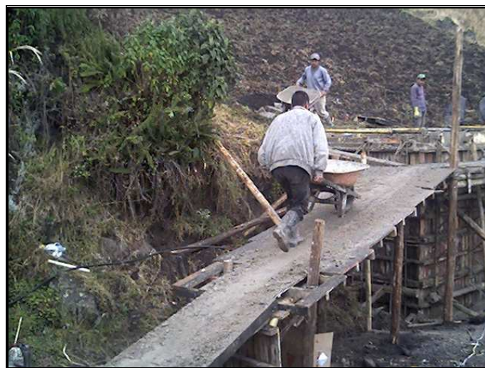
Figura 46. Rampa de acceso
