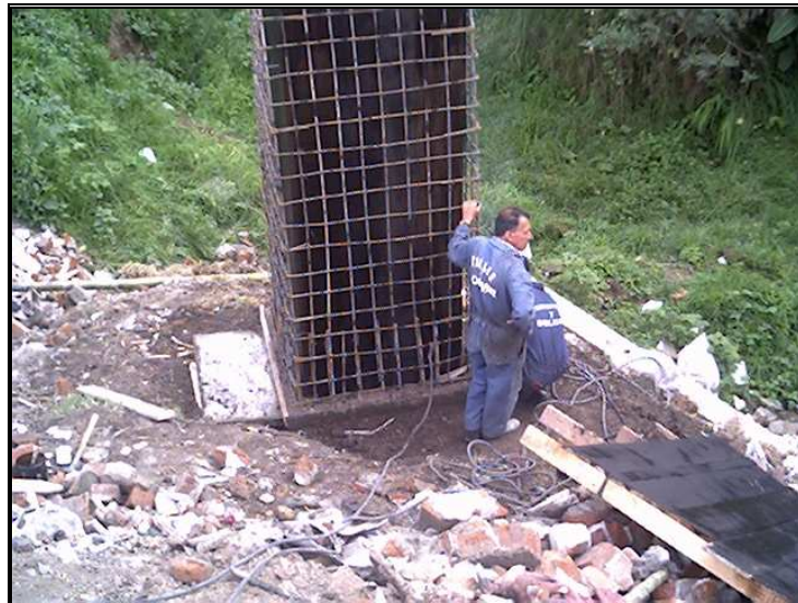
Figura 21. Empalme acero existente mediante soldadura
