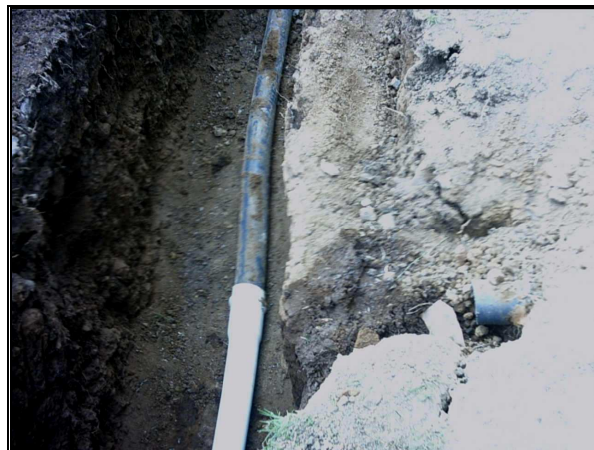
Figura 4. Profundización de tubería
