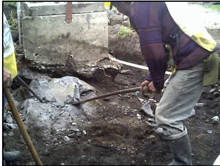
Figura 42. Excavación en roca
