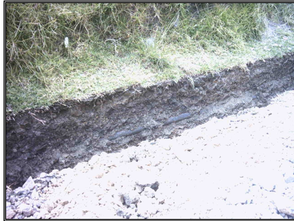
Figura 3. Excavación a un lado de la tubería
