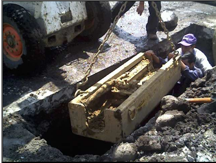
Figura 74. Instalación unidad de accionamiento hidráulico
