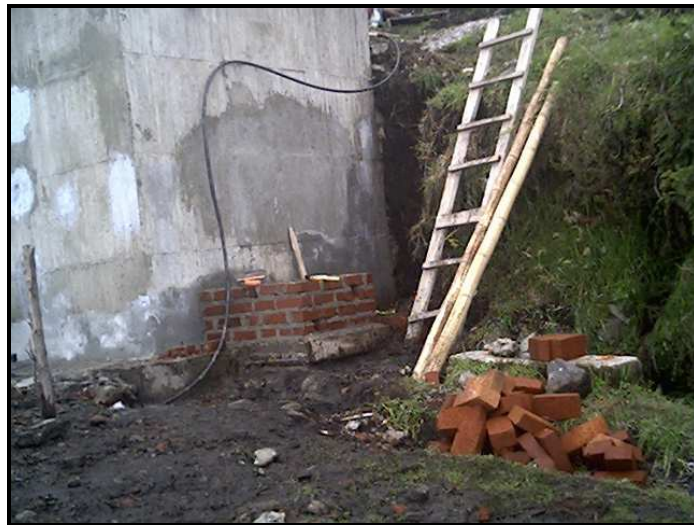
Figura 49. Construcción cajillas de salida
