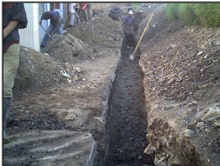
Figura 8. Rellenos y compactación
