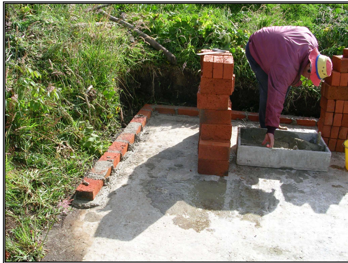
Figura 66. Construcción caseta de desinfección - sector Anganoy
