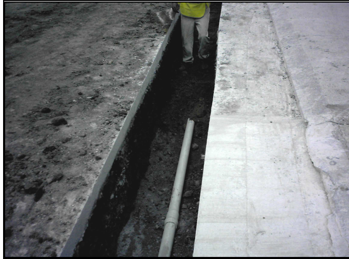
Figura 27. Instalación de tubería
