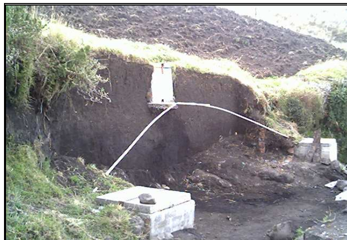
Figura 41. Demolición y excavaciones
