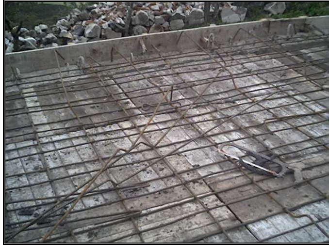
Figura 48. Fundición losa de cubierta
