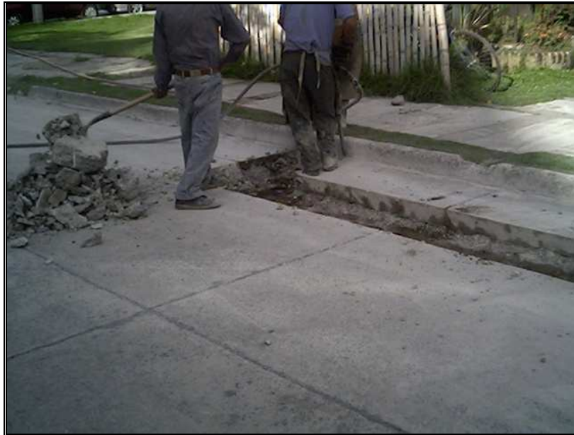
Figura 25. Corte y demolición de andén
