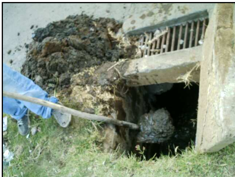
Figura 12. Extracción de sedimentos
