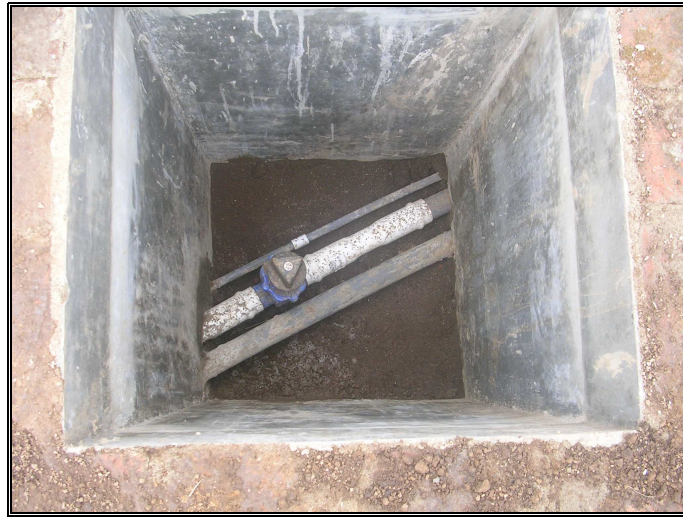
Figura 57. Instalación de válvula
