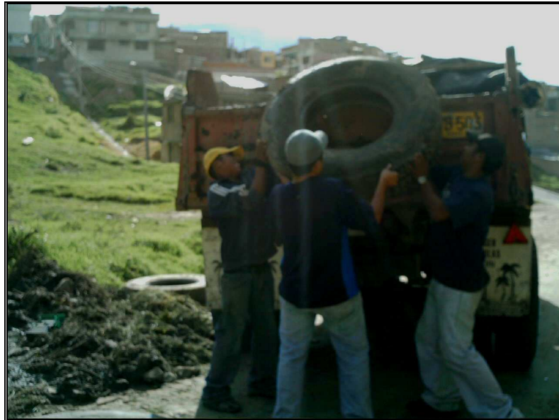
Figura 19. Retiro de escombros
