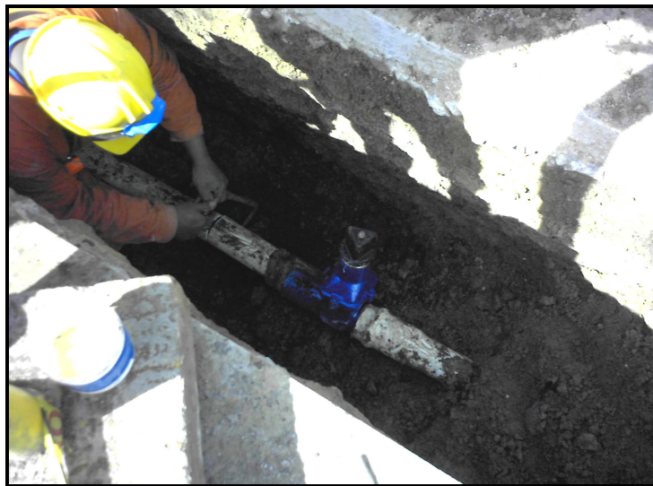
Figura 38. Instalación de válvulas
