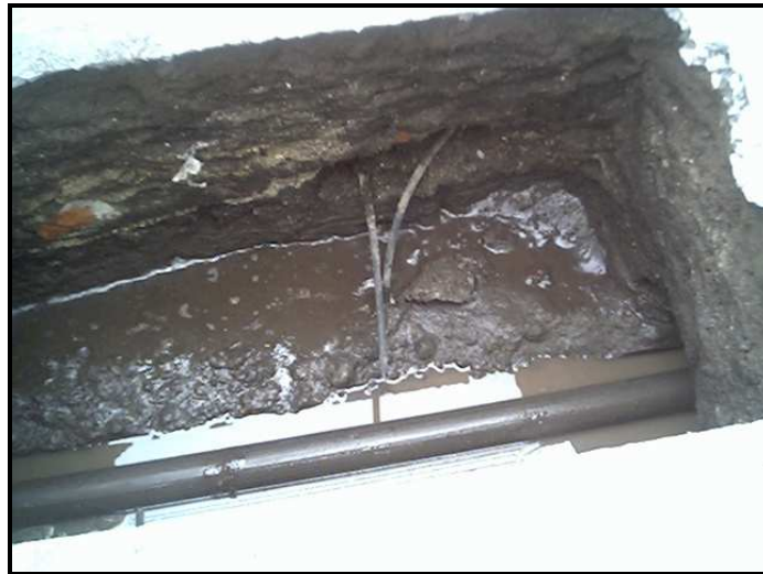
Figura 78. Halado de la tubería
