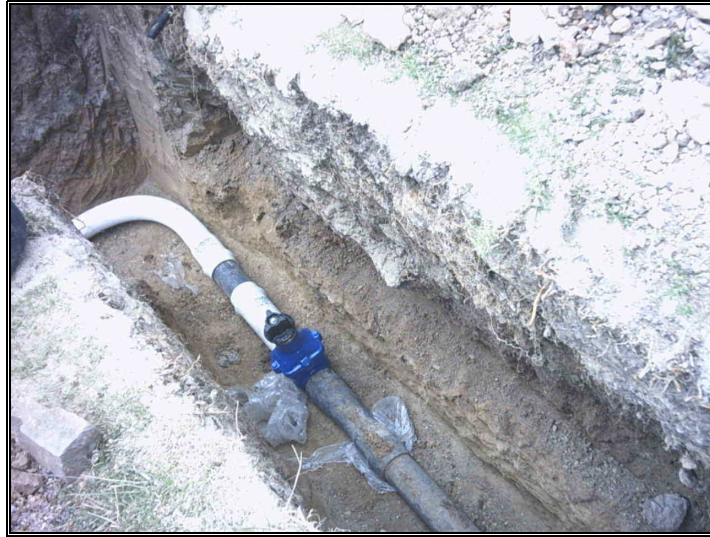
Figura 5. Instalación de válvulas
