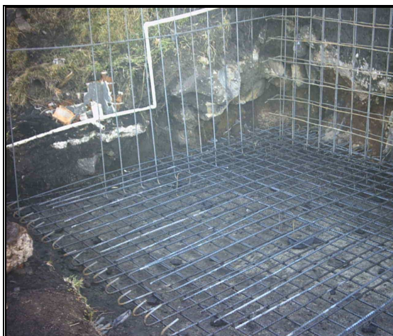
Figura 43. Armado de refuerzo
