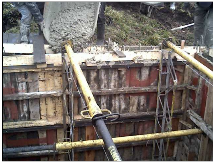
Figura 47. Vaciado del concreto
