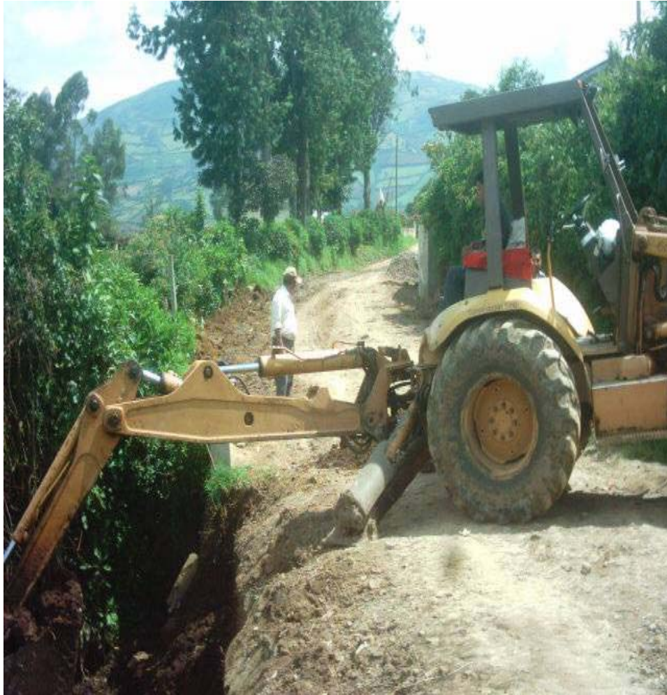
Figura 17. Excavación a maquina.
