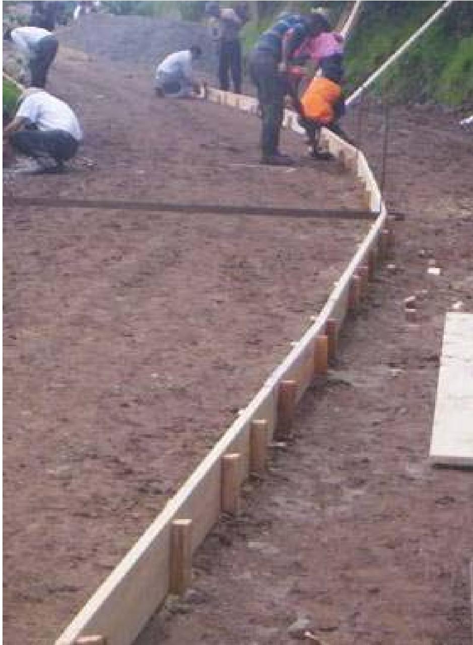
Figura 55. Colocación de formaleta para el pavimento.
