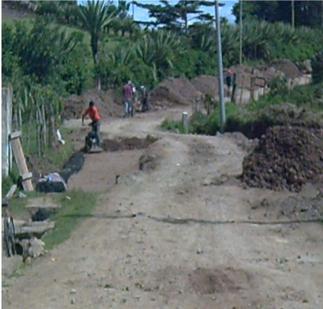
Figura 11. Compactación lateral filtro 1.
