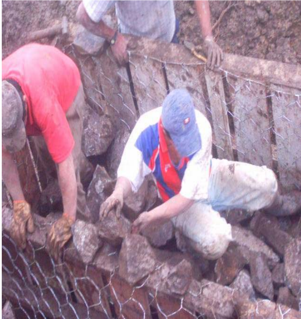
Muro # 4, ubicación K 0+510 m – K 0+522 m. Febrero 15 de 2006.
