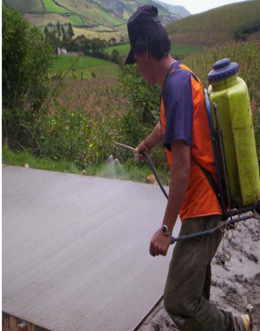
Figura 62. Curado del Concreto.
