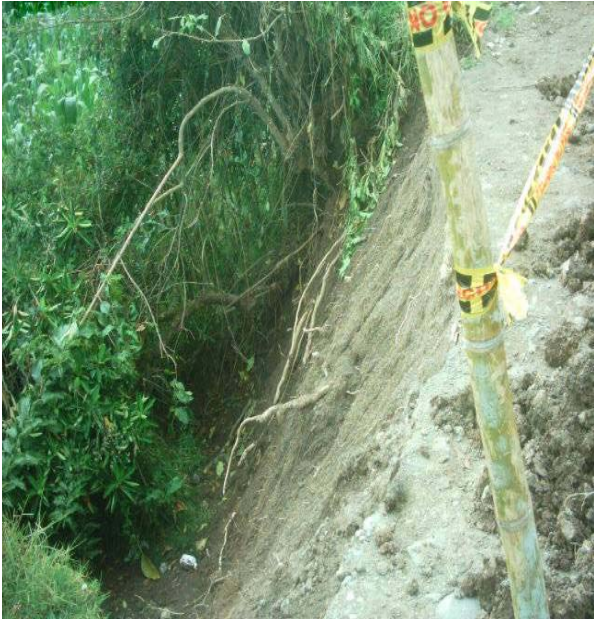
Figura 14. Desprendimiento de la banca.
