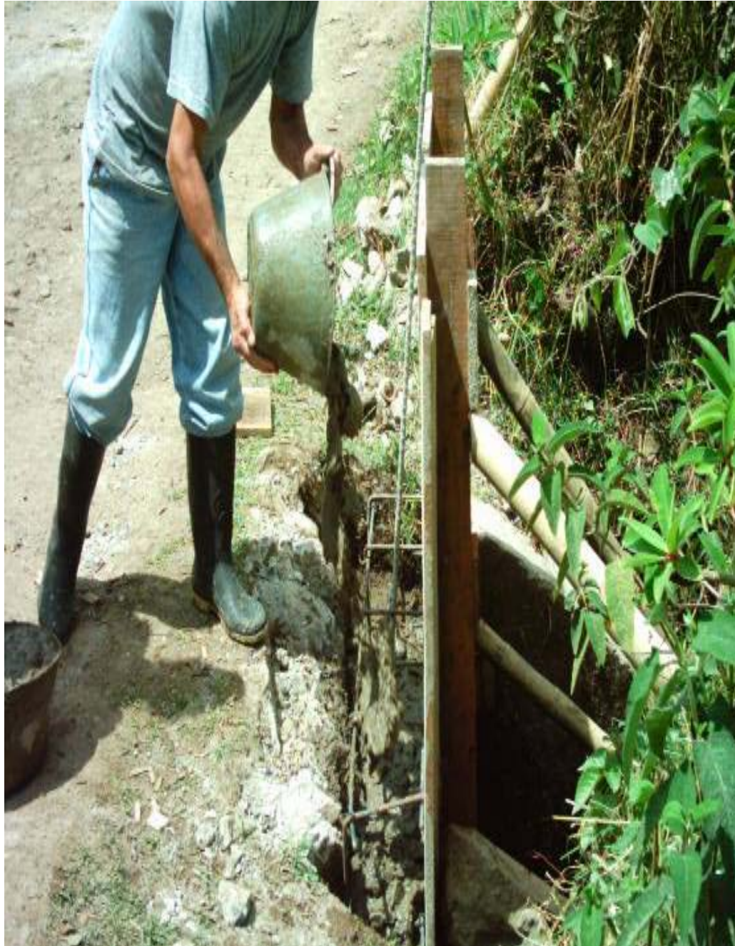
Alcantarilla # 3, abscisa K 0+498 m. Abril 6 del 2006.
