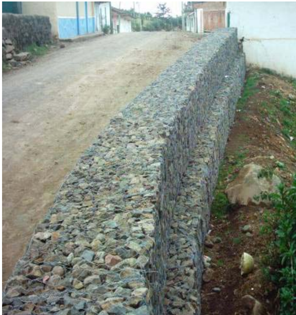
Muro # 5, Ubicación K 0+121 m - K 0+151 m. Febrero 15 de 2006.
