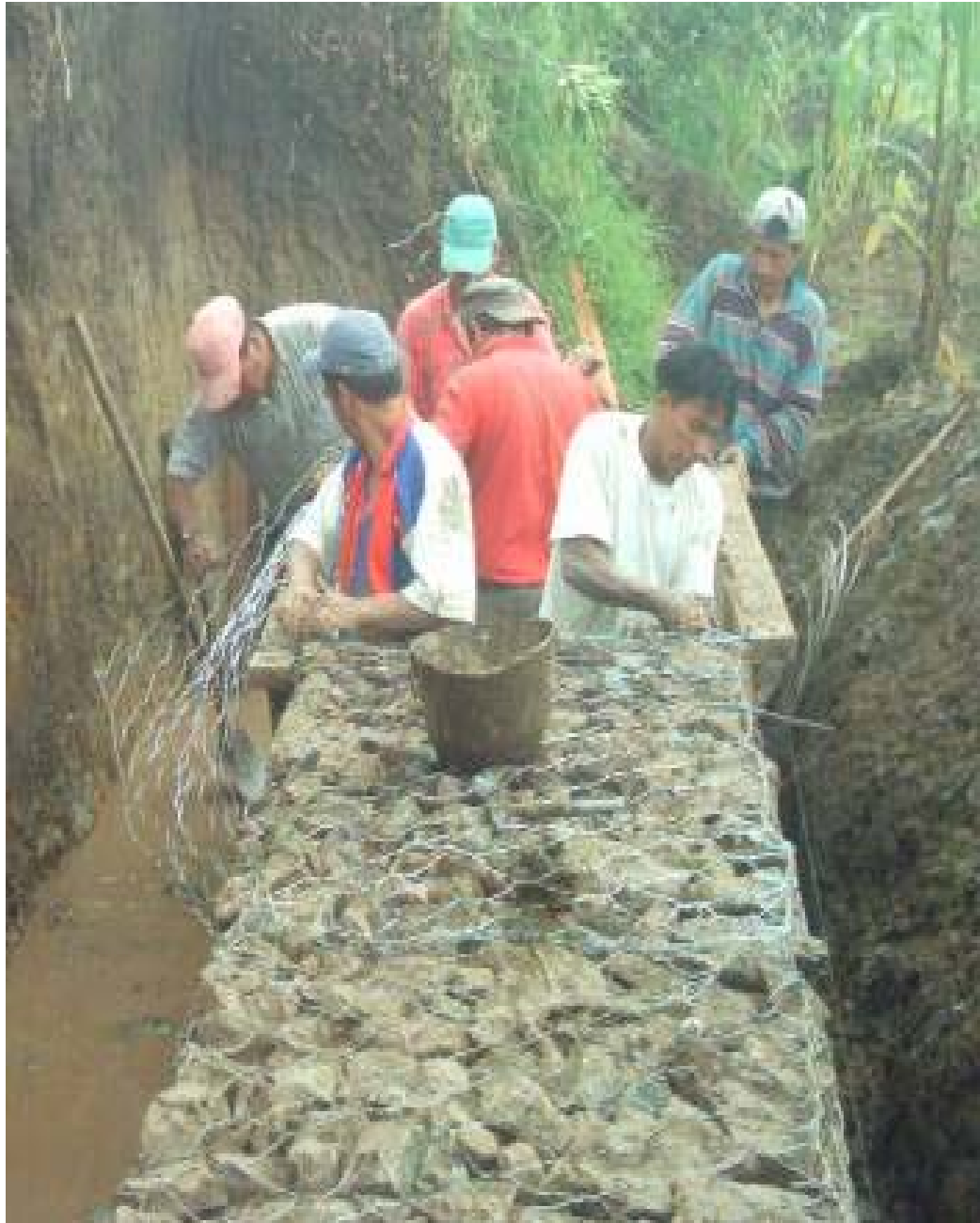
Muro # 4, ubicación K 0+510 m – K 0+522 m. Febrero 17 de 2006.
