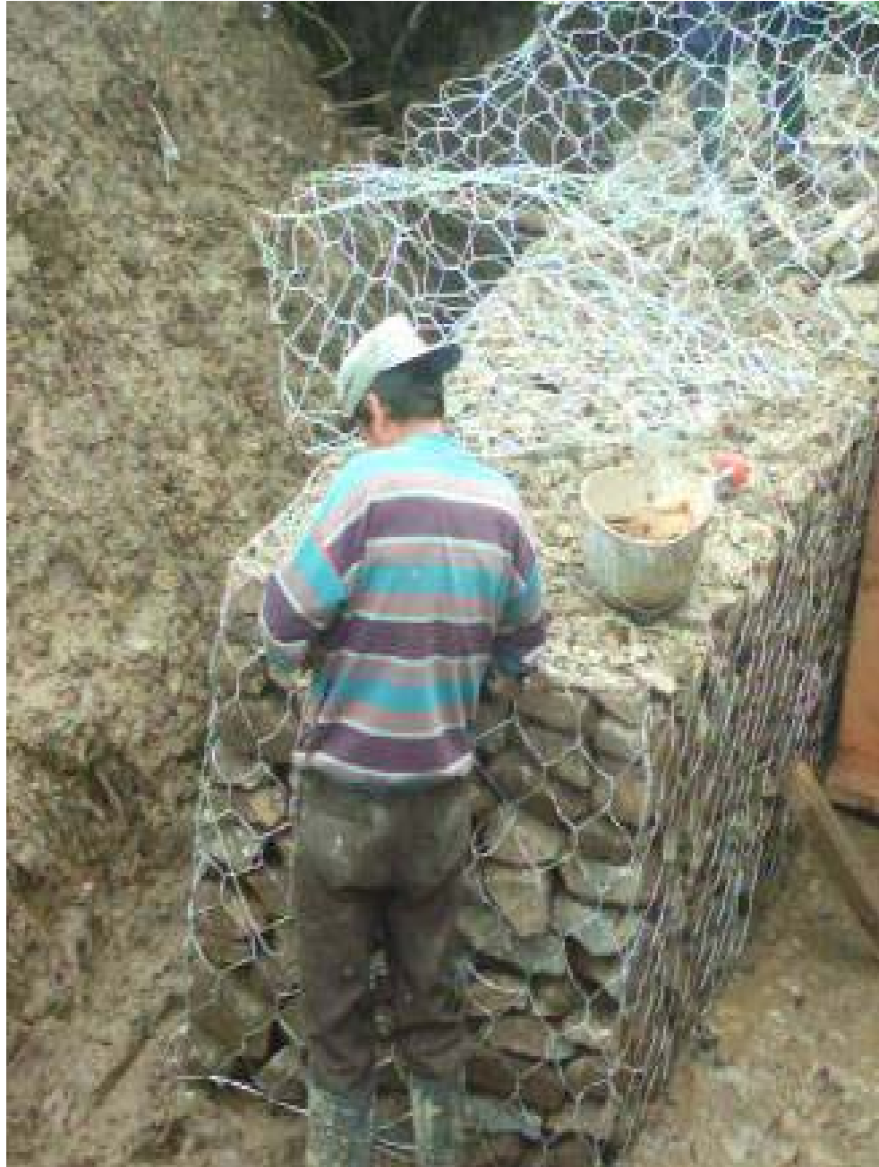
Muro # 4, ubicación K 0+510 m – K 0+522 m. Febrero 16 de 2006.
