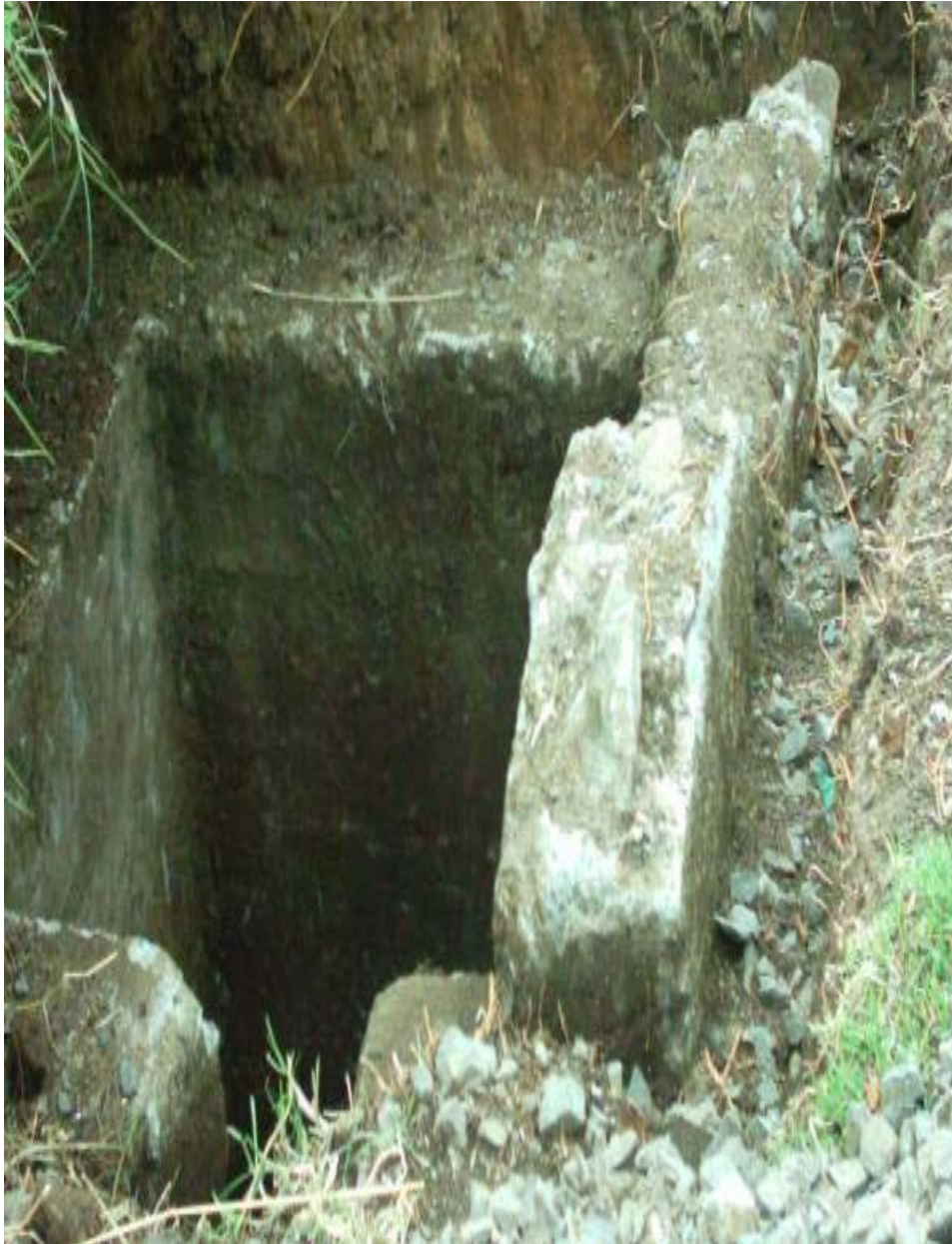
Alcantarilla # 1, abscisa K 0+178 m. Marzo 27 del 2006.
