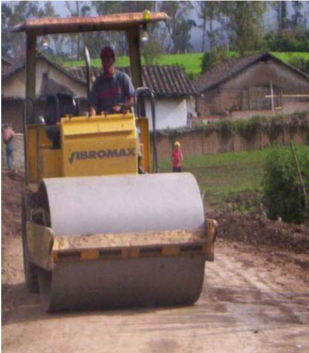
Figura 50. Compactación de sub-base.
