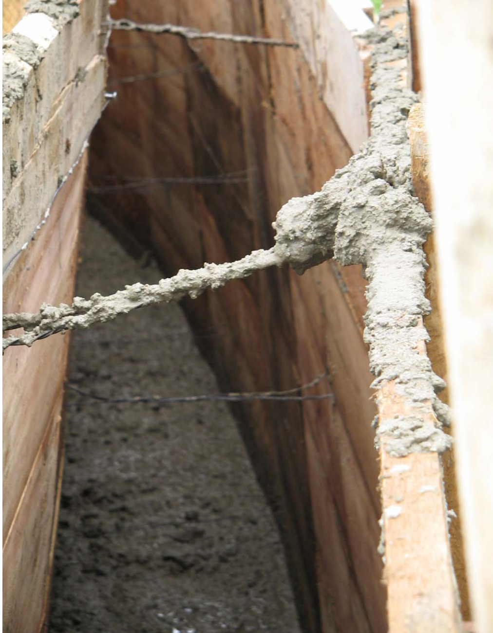
Figura 33. Muro concreto ciclópeo, el rajón envuelto en concreto.
