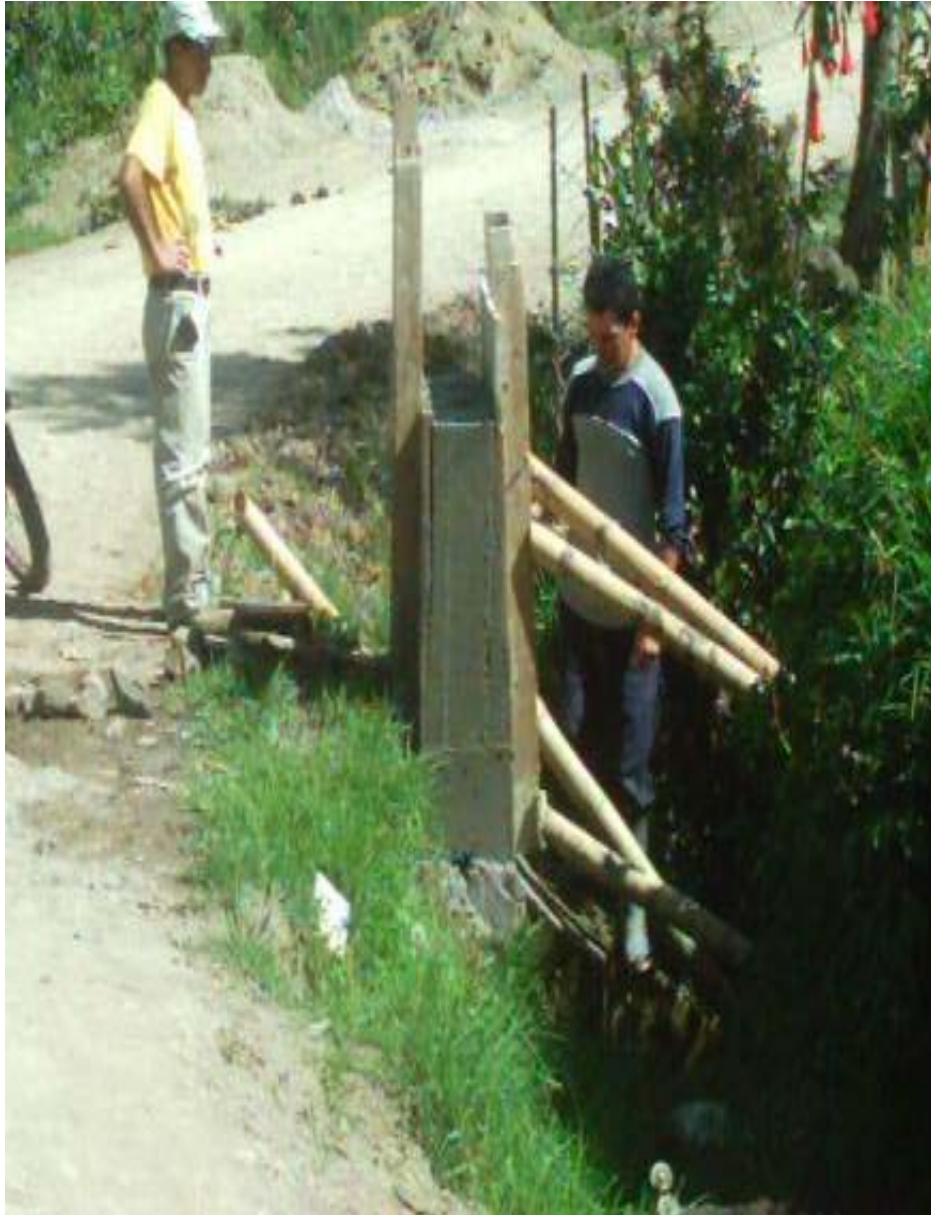
Alcantarilla # 2, abscisa K 0+267 m. Marzo 29 del 2006.
