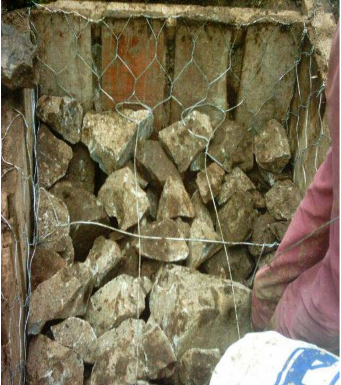
Muro # 4, ubicación K 0+510 m – K 0+522 m. Febrero 16 de 2006.
