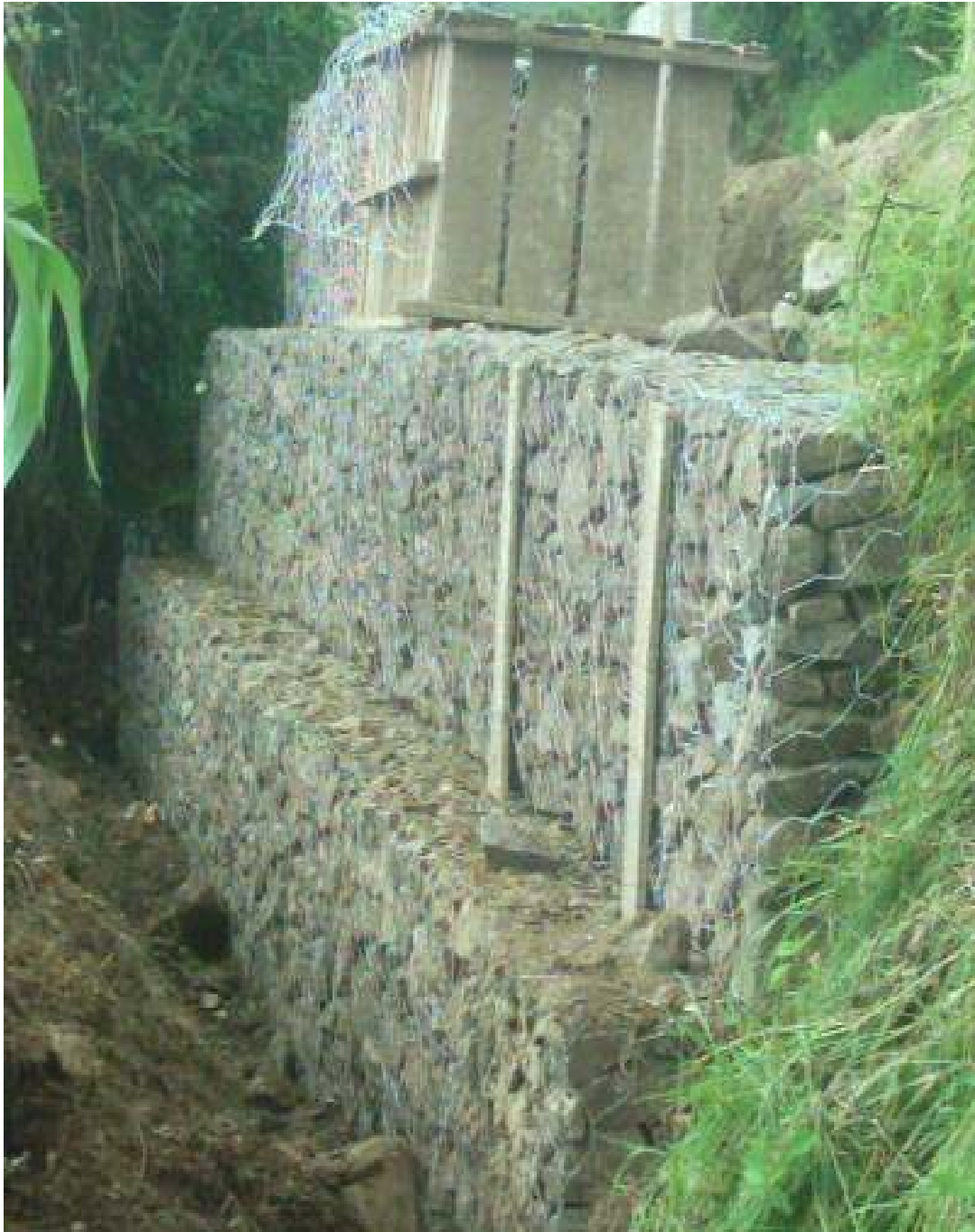
Muro # 4, ubicación K 0+510 m – K 0+522 m. Febrero 23 de 2006.
