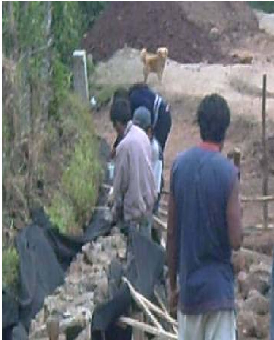
Figura 8. Colocación del material filtrante.
