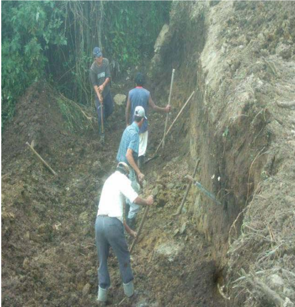
Figura 18. Excavación a mano.
