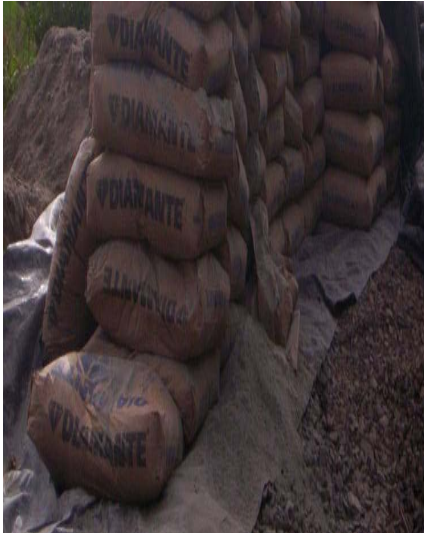
Figura 54. Material acordonado para el pavimento.
