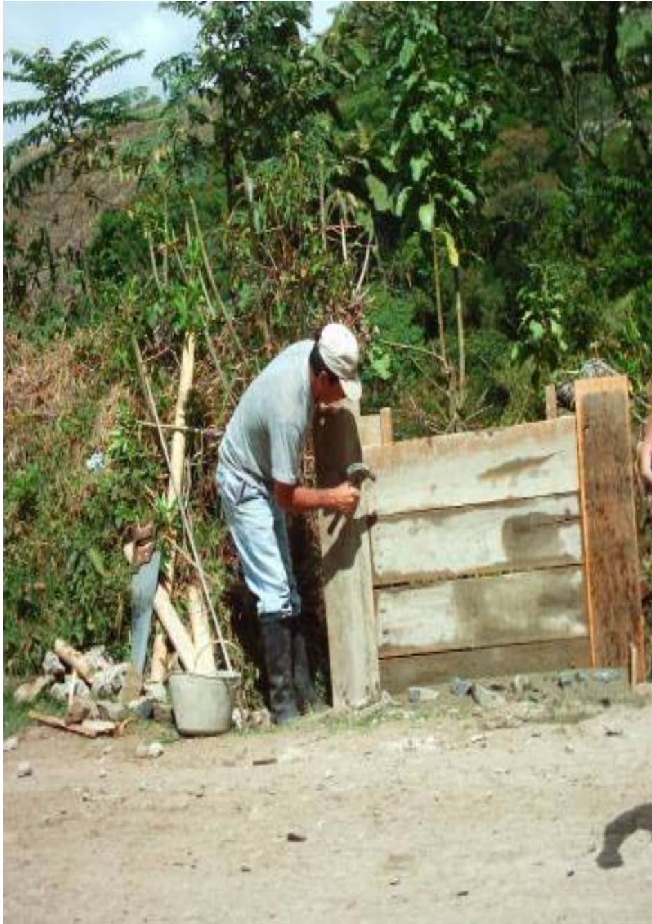
Alcantarilla # 2, abscisa K 0+267 m. Marzo 27 del 2006.
