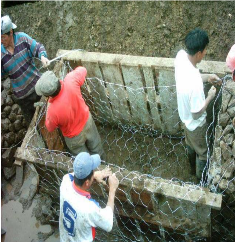
Figura 19. Instalación de las canastas del gavión.
