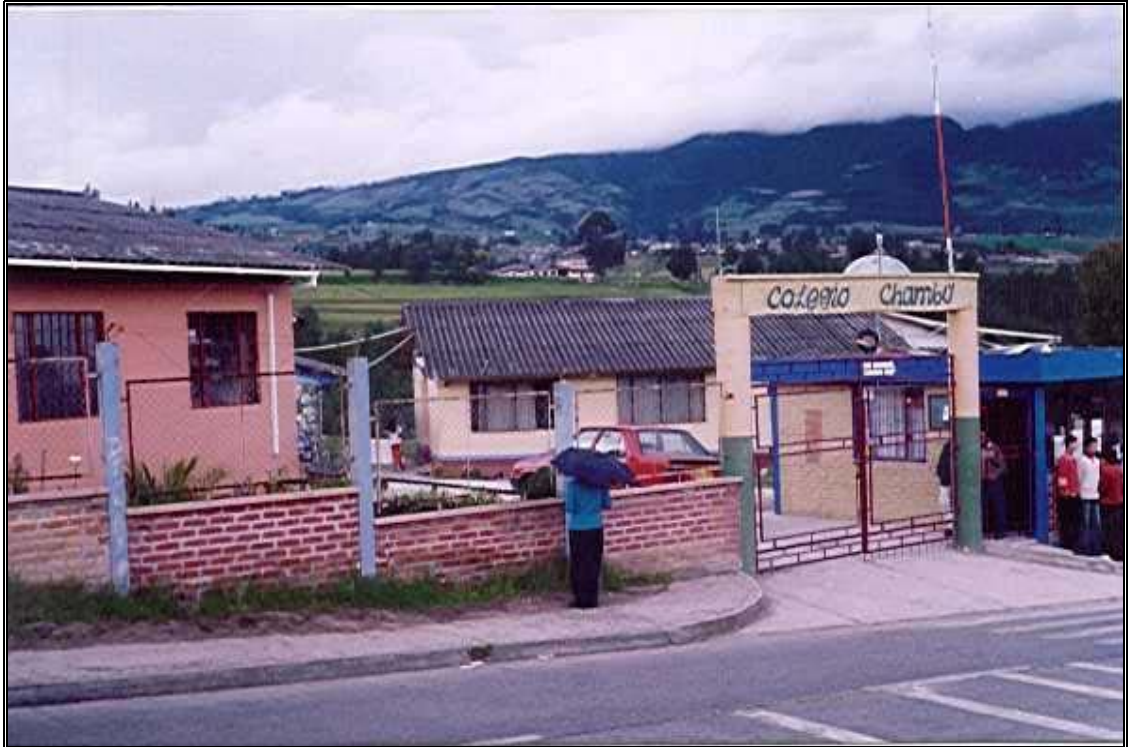
Figura 1. Colegio Municipal Chambú
