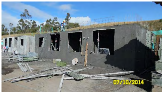
Figura 26. Desencofre de apartamento.
