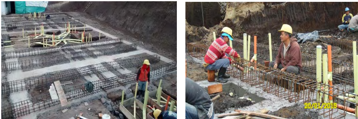
Figura 16. Amarre de vigas de cimentación.
