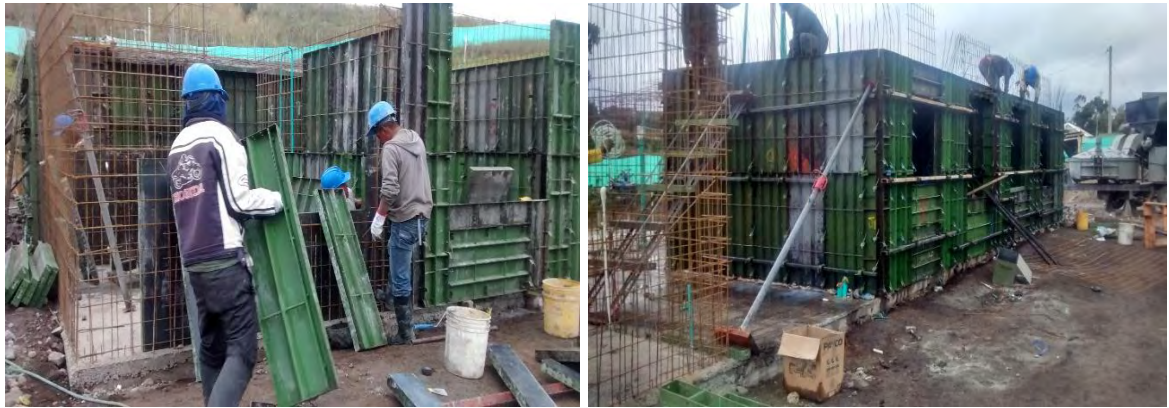
Figura 24. Formaleta metálica para fundición de apartamentos.
