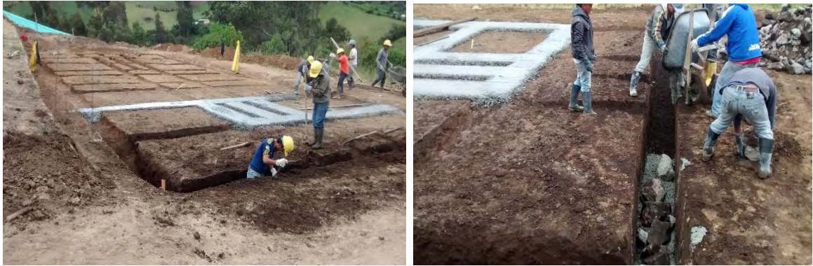
Figura 15. Mejoramiento de suelo.
