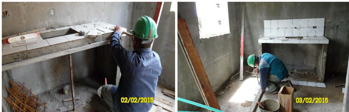
Figura 31. Enchape de mesón de cocina.
