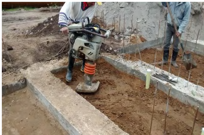
Figura 20 .Compactación con recebo y material de sitio.
