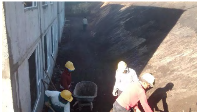
Figura 56. Perfilada de taludes.
