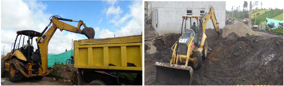
Figura 13. Descapote, excavación y desalojo de material.
