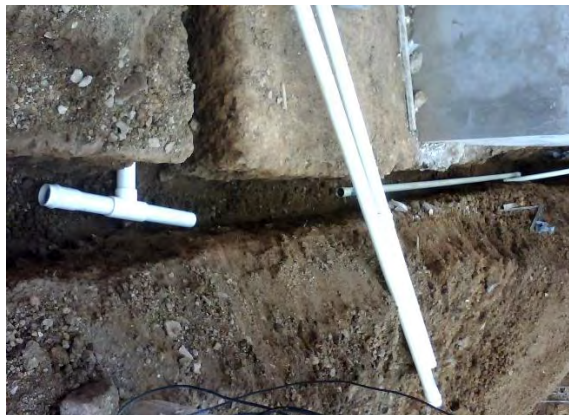
Figura 54. Instalación de acueducto.
