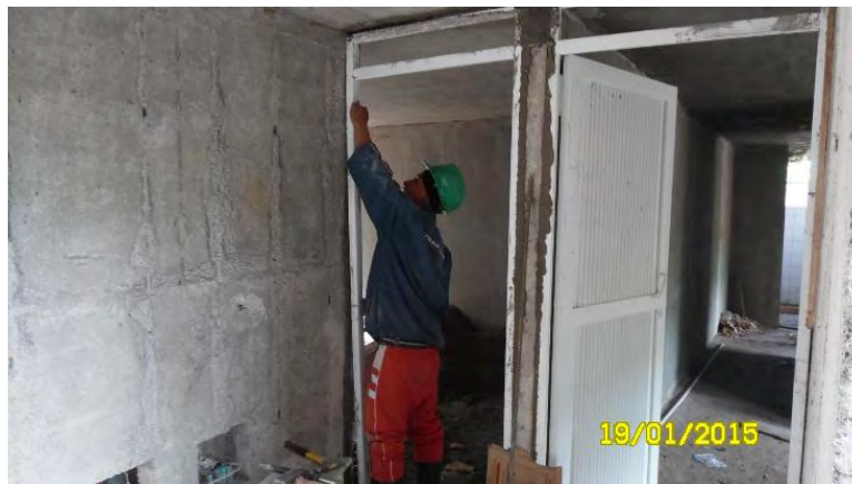
Figura 37. Instalación de puerta metálica.
