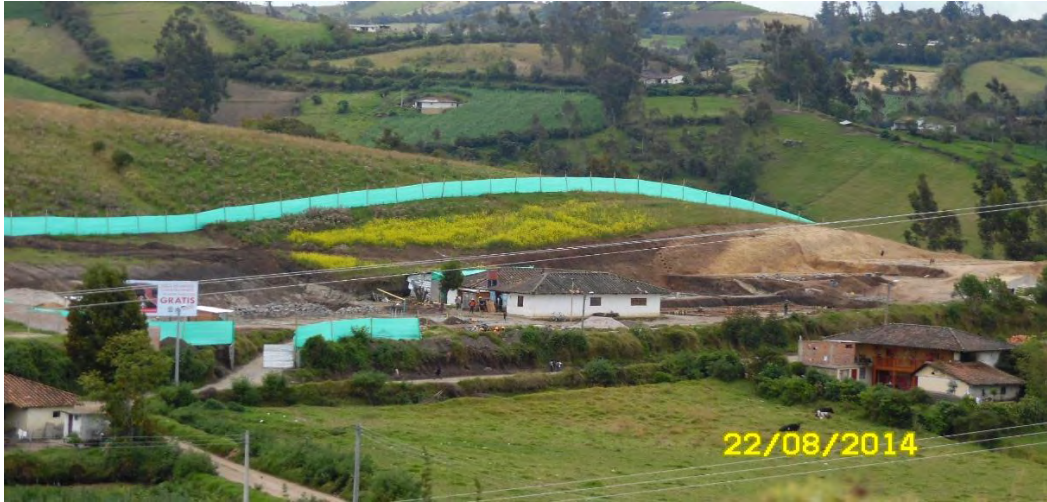
Figura 11. Vista panorámica inicio de obra.
