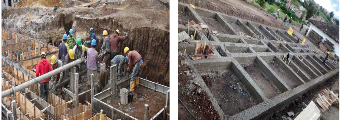
Figura 19. Fundición de vigas.
