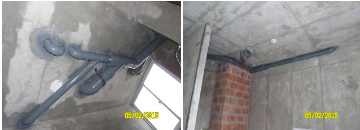
Figura 36. Pintura gris basalto para tubería.
