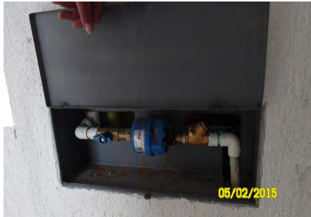
Figura 38. Instalación de medidor.
