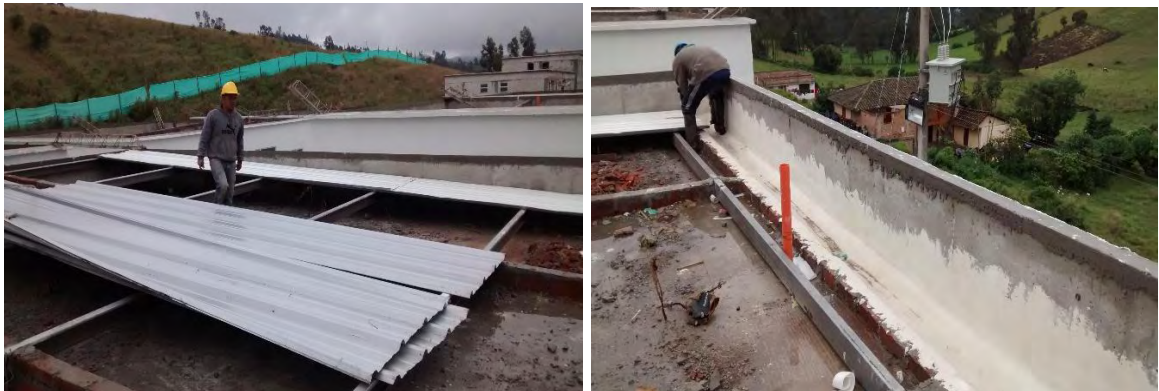
Figura 42. Instalación de cubierta.
