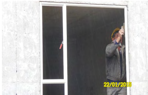
Figura 30. Instalación de ventana.
