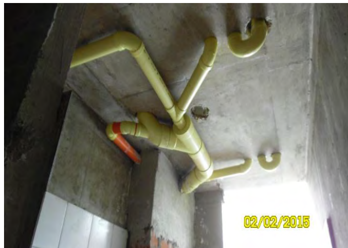
Figura 35. Instalación de bajantes sanitarios.
