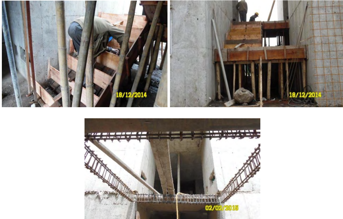
Figura 27. Fundición de gradas
