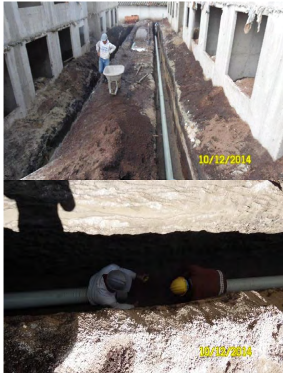
Figura 51. Instalación tubería novafort.
