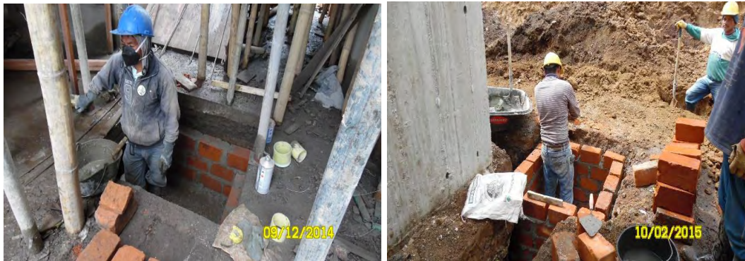
Figura 53. Elaboración de cajas de inspección.
