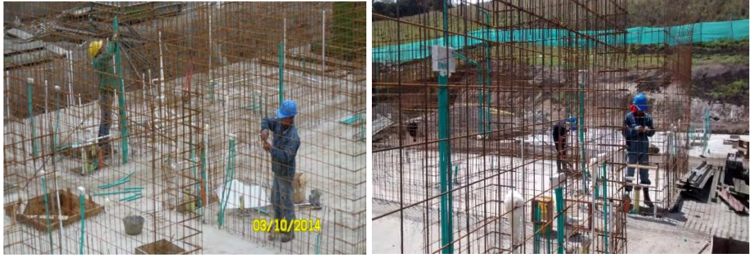
Figura 23. Instalación de malla para muros.
