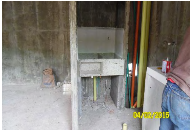
Figura 32. Instalación de lavadero.
