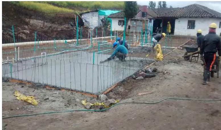
Figura 22. Fundición de losa cimentación.
