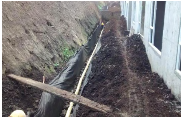
Figura 52. Instalación de filtro.
