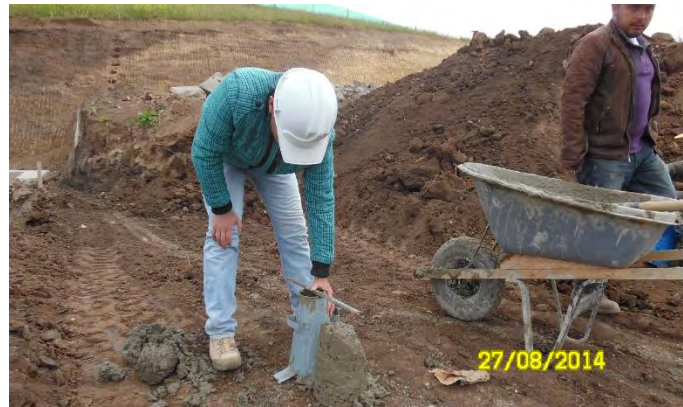
Figura 44. Prueba cono slump Insitu.
