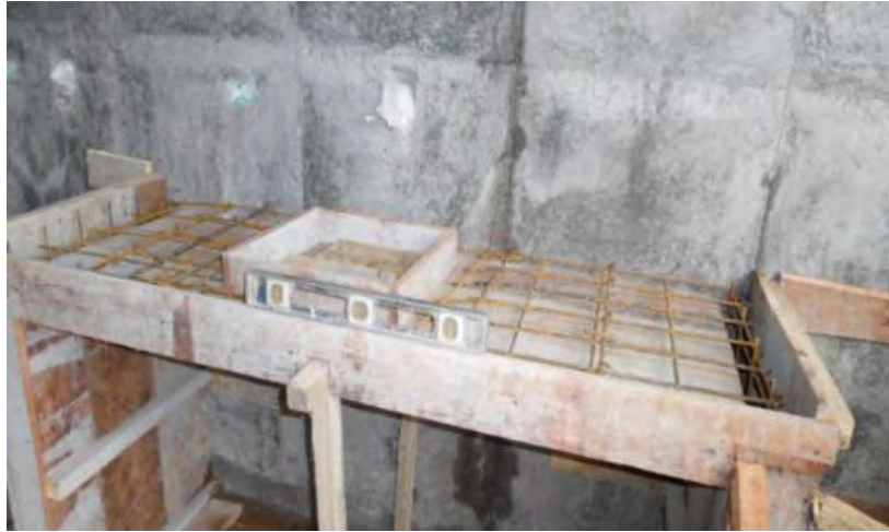
Figura 28. Fundición de mesón en concreto.
