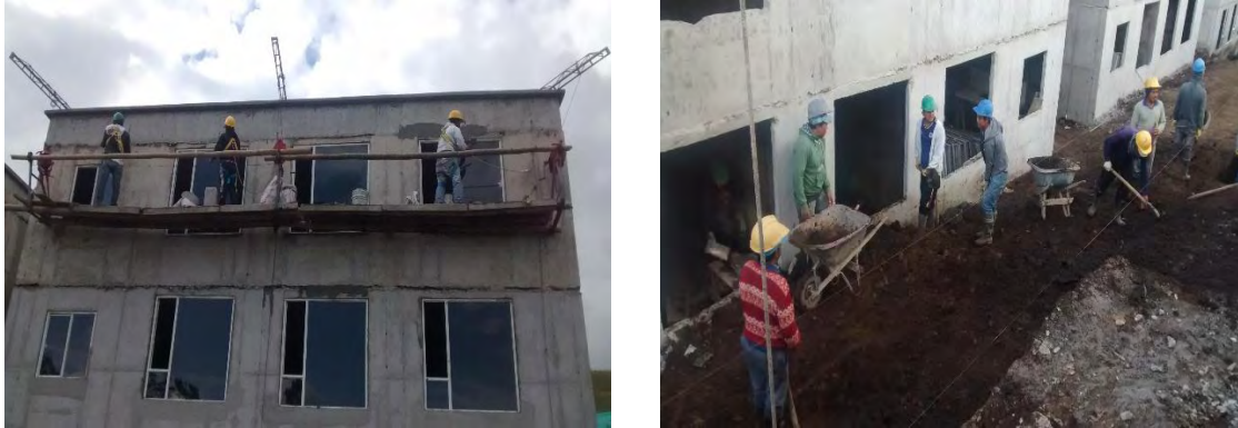
Figura 60. Utilización de elementos de protección.
