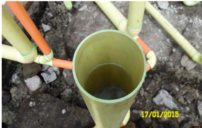
Figura 46. Prueba de estanqueidad.
