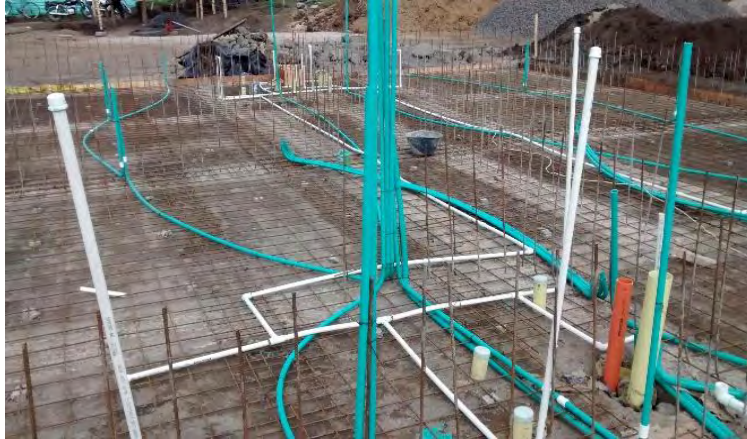
Figura 21. Instalación de malla e instalaciones eléctricas, hidráulicas.
