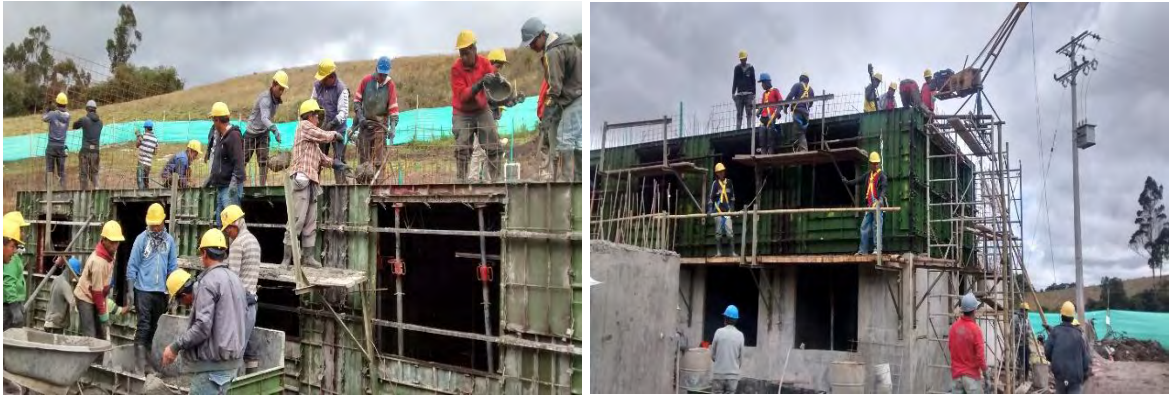
Figura 25. Fundición de apartamentos.
