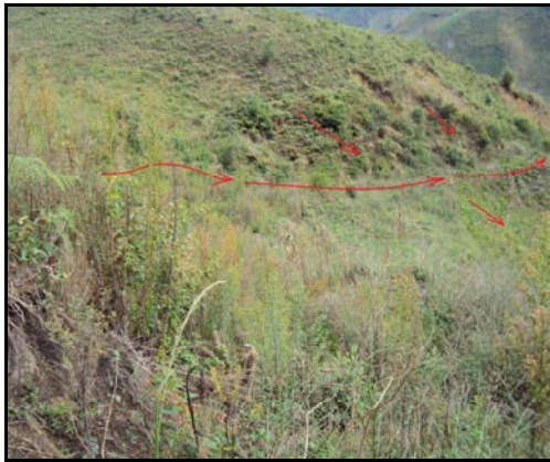
Figura 53. Superficies de falla transversales sobre la cabeza del deslizamiento rotacional, vereda Gavilla alta
