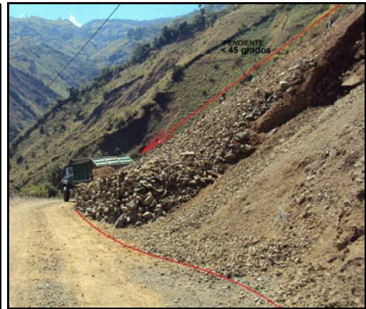
Figura 63. Bloques de roca sobre ángulo menor a 45 grados, depositados sobre la carretera Las Mesas El Tablón
