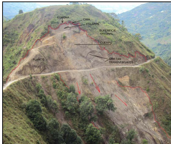
Figura 50. Deslizamiento traslacional, carretera hacia la vereda Los Yungas
