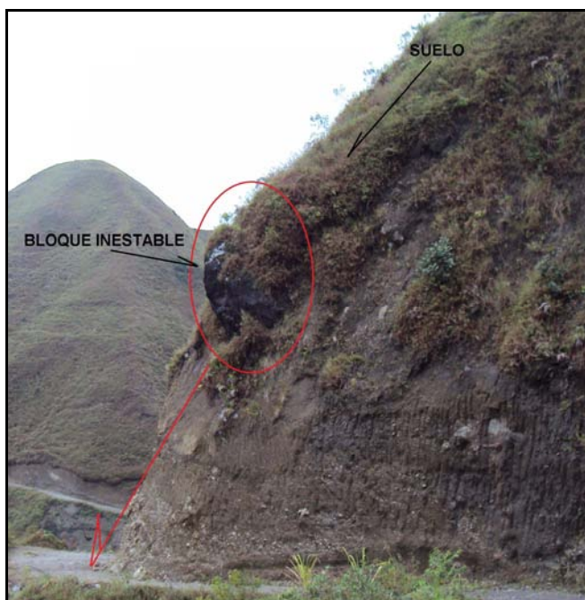
Figura 65. Caída de rocas sobre la carretera hacia la vereda Los Yungas
