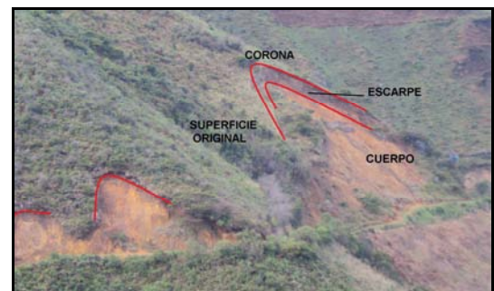
Figura 57. Formación de sucesivos movimientos de rotación sobre el camino hacia la vereda Gavilla baja
