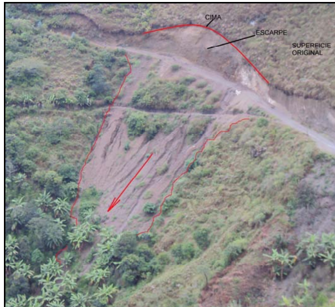
Figura 51. Deslizamiento traslacional sobre la carretera hacia la vereda Doña Juana
