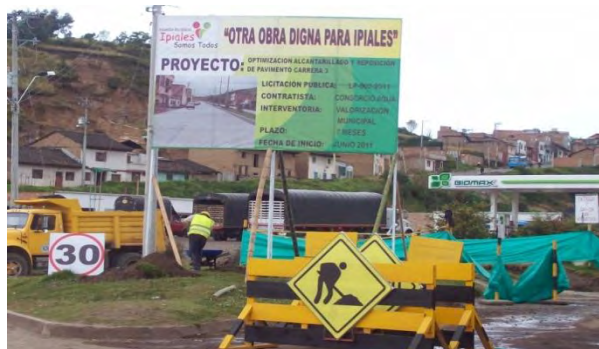
Figura No.68 Valla informativa del proyecto.
