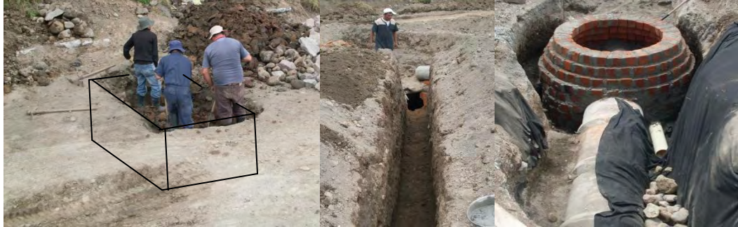
Figura No.38 Instalación tubería de 3" RDE 21 para acueducto.
