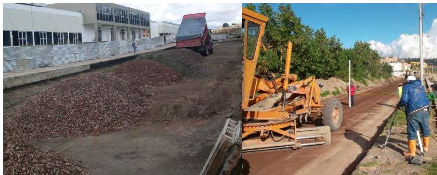
Figura No.32 Acordonamiento y Perfilación de Subbase granular.
