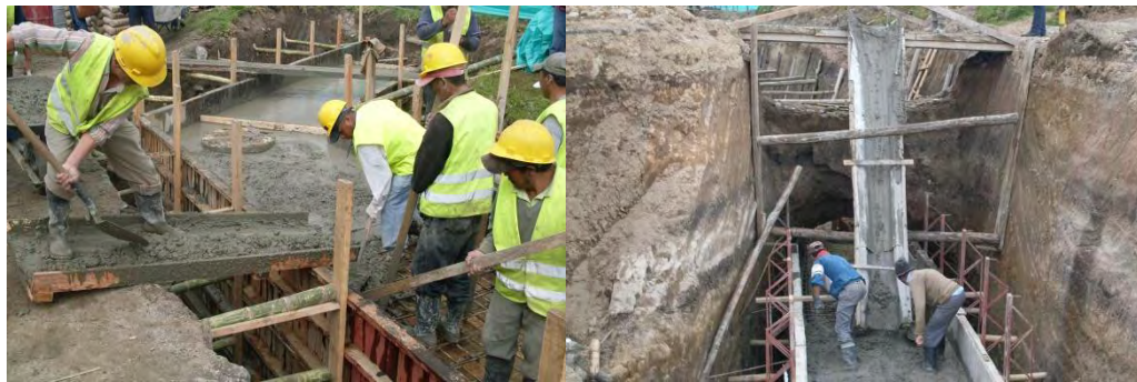
Figura No.8 Colocación de concreto en Box Couvert.
