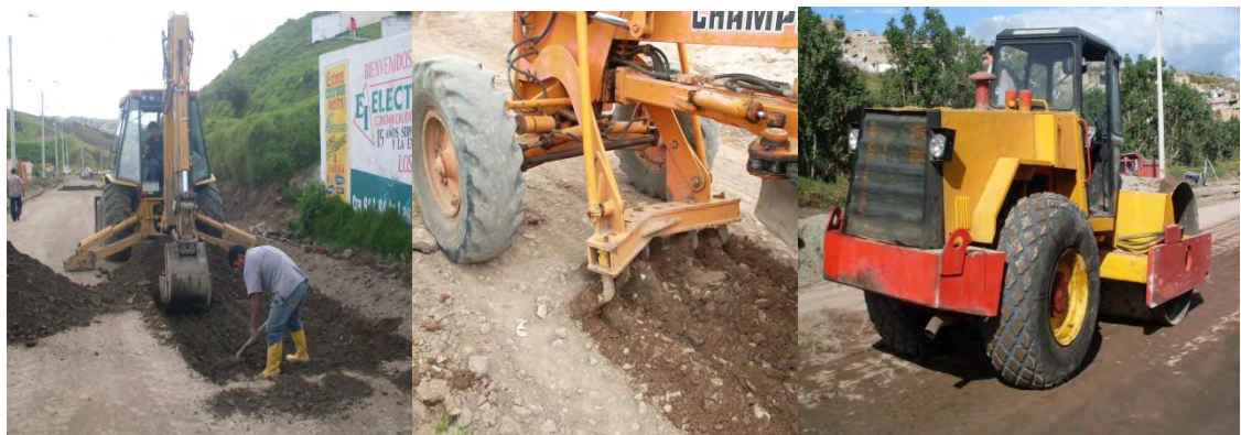
Figura No.33 Escarificación y compactación de Subbase granular.
