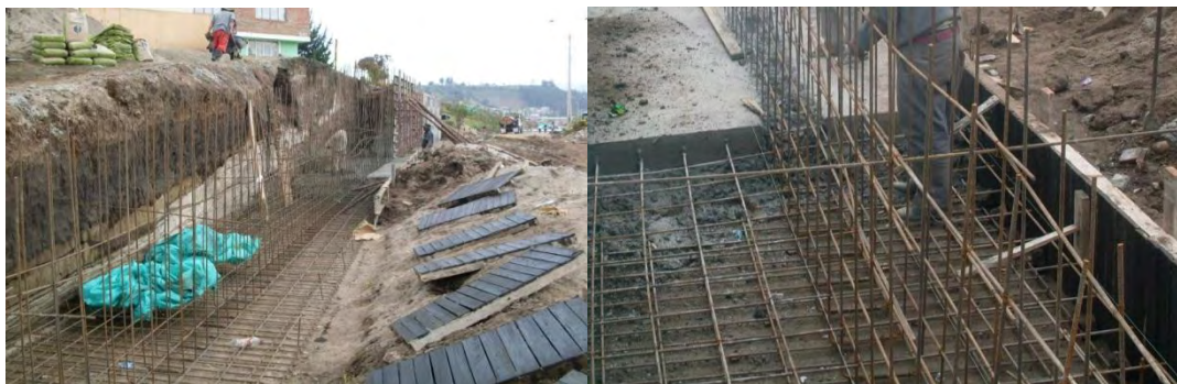
Figura No.64 Armadura de refuerzo muro de contención.
