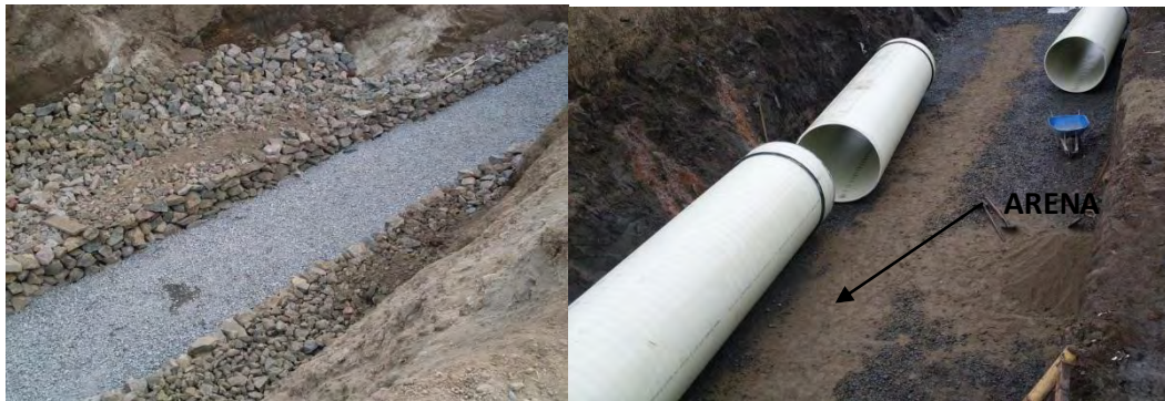
Figura No.16 Encamado con triturado y afinado con arena para base de tubería estructural.
