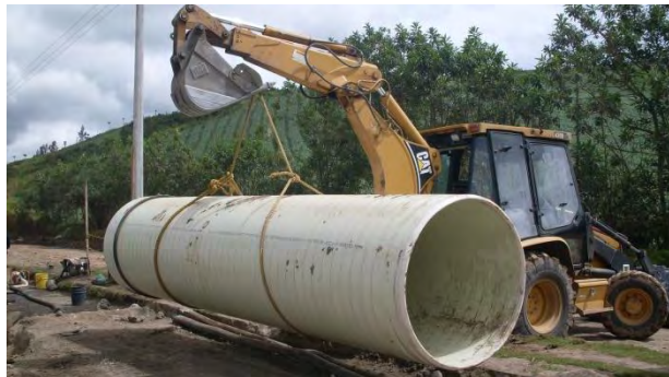
Figura No.14 Manipulación de tubería estructural NOVALOC.
