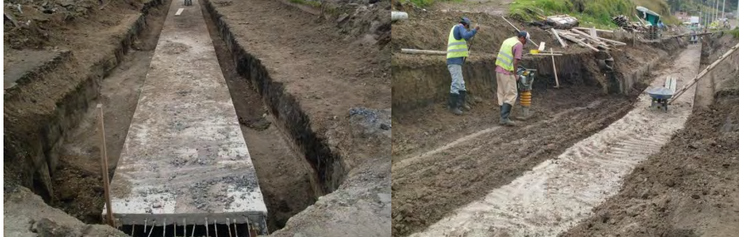
Figura No.12 Relleno longitudinal en Box Couvert.
