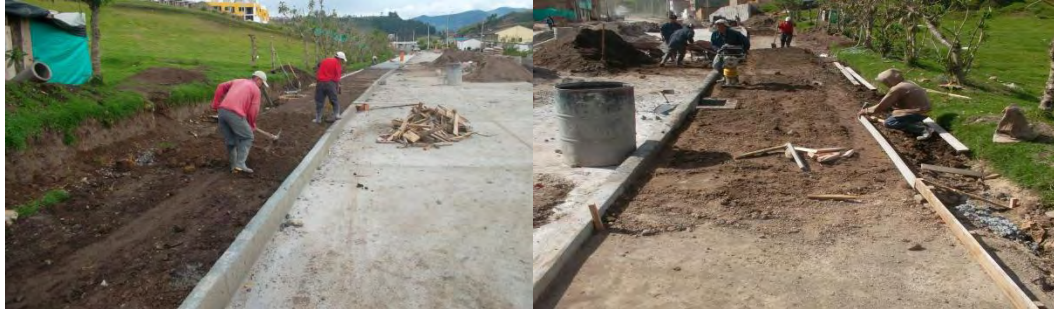
Figura No.61 Excavación y formaleta para andenes.
