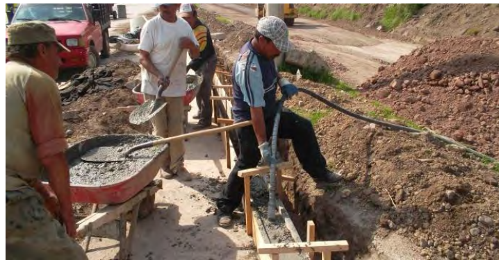
Figura No.60 Vibrado de concreto para sardinel.
