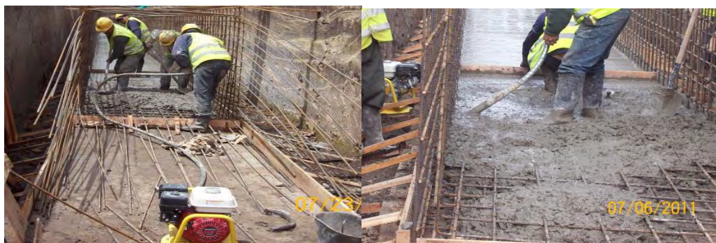
Figura No.9 Compactación de concreto para Box Couvert.
