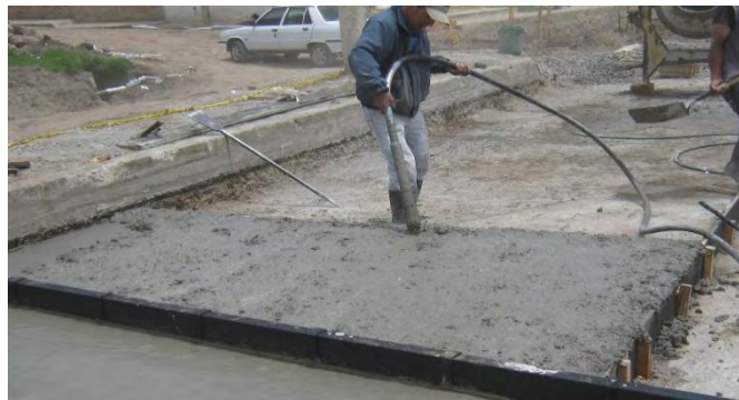
Figura No.53 Vibración interna de concreto MR-39.
