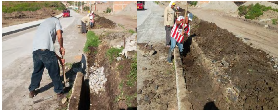
Figura No.59 Demolición de sardinel, excavación para reposición de sardinel.
