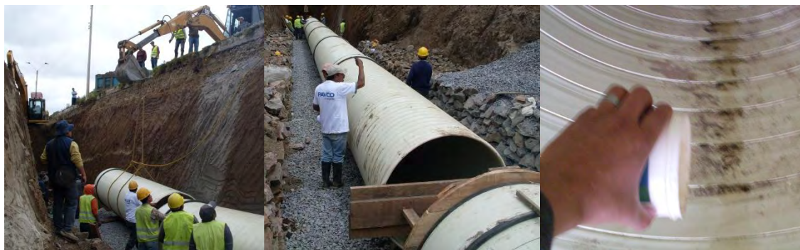
Figura No.17 Instalación y chequeo de pendiente de tubería estructural.
