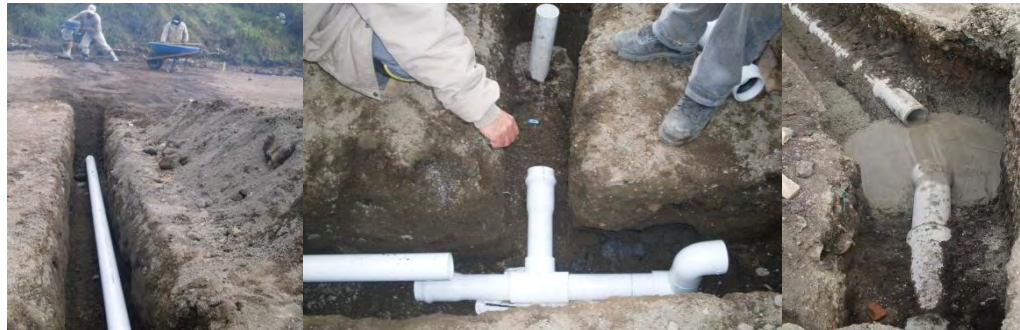
Figura No.39 Instalación de tubería de alcantarillado paralelo.
