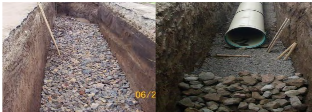
Figura No.3 Mejoramiento con material rajón para construcción de Box Coulvert e instalación de tubería.
