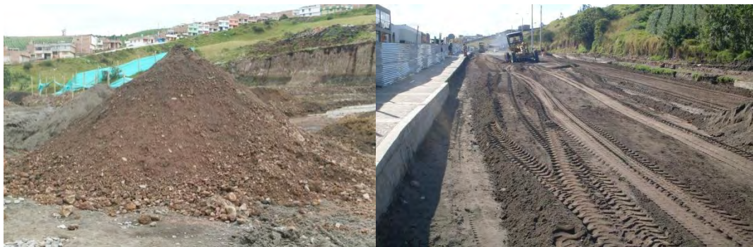
Figura No.27 Acordonamiento, Extensión y aireación de mejoramiento con recebo.
