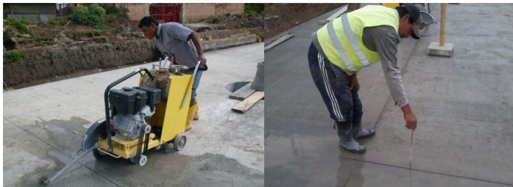
Figura No.57 Elaboración de junta y chequeo de profundidad de corte.
