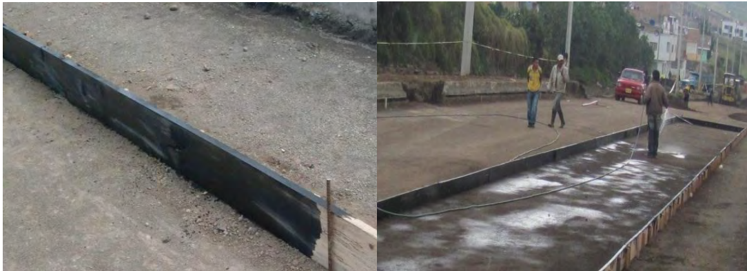
Figura No.50 Formaleta con aceite y humedecimiento de Subbase.
