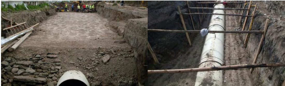
Figura No.22 Relleno con material de sitio para tubería estructural.
