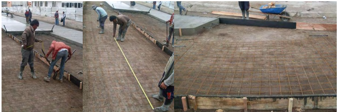
Figura No.47 Refuerzo transversal y longitudinal con malla de 1/4".
