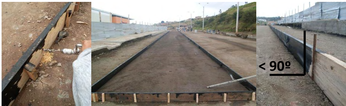
Figura No.41 Instalación de formaleta para losa.
