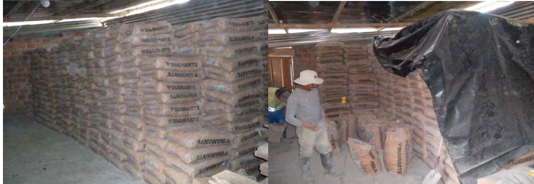
Figura No.48 Almacenamiento del Cemento
