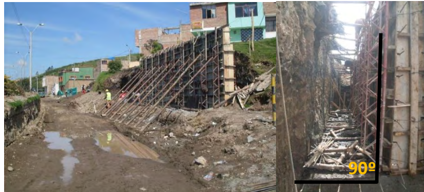
Figura No.65 Formaleta para muro de contención.
