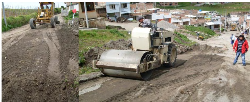
Figura No.71 Conformación y compactación de subrasante.
