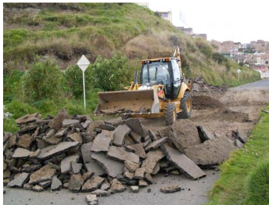
Figura No.1 Demolición de carpeta asfáltica.
