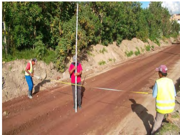
Figura No.31 Chequeo de nivel para conformar Subbase granular.
