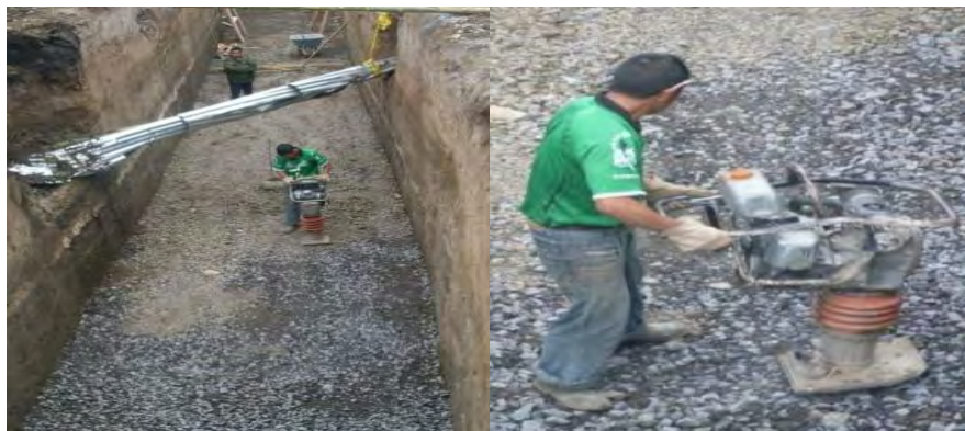
Figura No.4 Mejoramiento con material triturado para construcción de Box Couvert e instalación de tubería.
