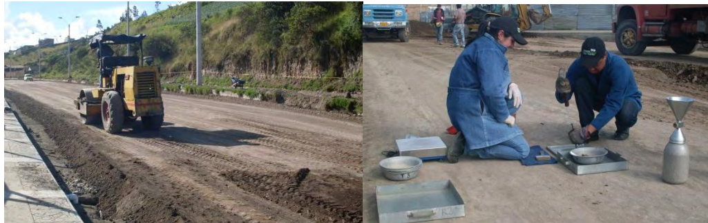
Figura No.28 Compactación y Control densidades de mejoramiento.
