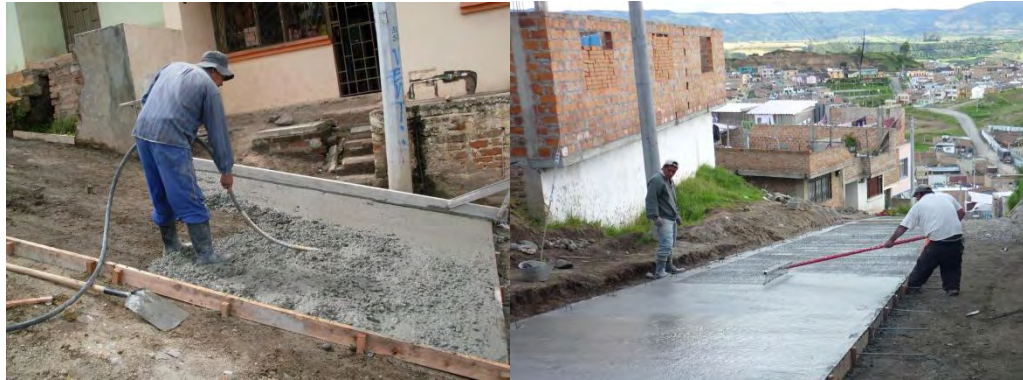
Figura No.74 Compactación y texturizado de concreto Jaime Báteman.
