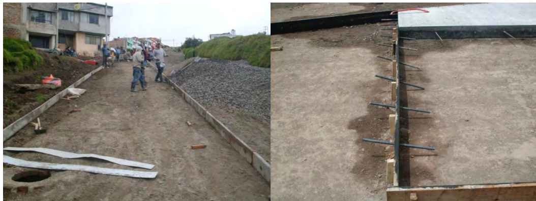
Figura No.73 Instalación de formaleta y acero de refuerzo.
