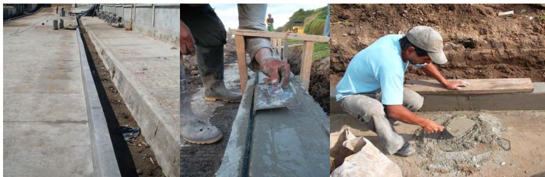
Figura No.58 Bordillos carrera tercera
