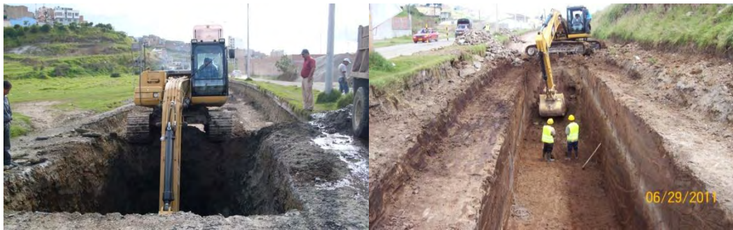
Figura No.2 Excavación de zanja para construcción de alcantarillado.
