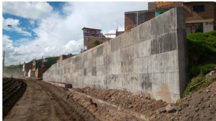
Figura No.66 Muro de contención carrera tercera.
