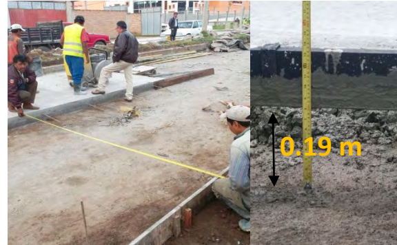
Figura 43 Chequeo ancho y espesor.
