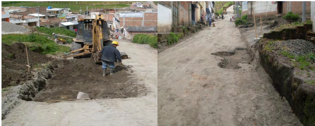
Figura No.72 Subbase compactada y eliminación de fallos.
