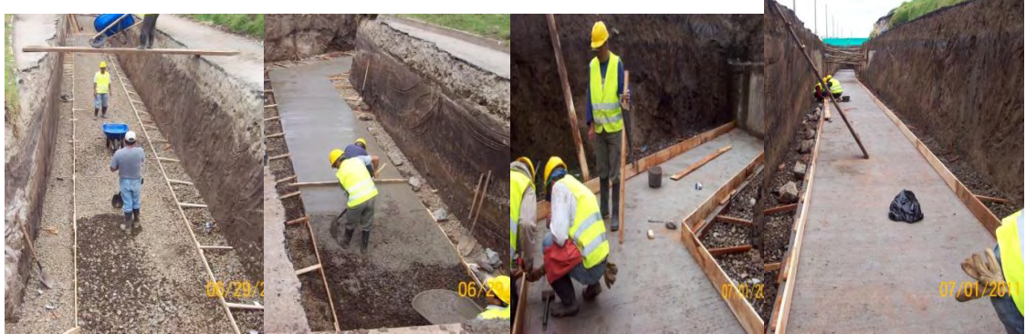
Figura No.5 Formaleta para solado y base de Box Couvert.
