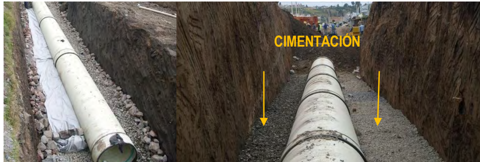
Figura No.19 Cimentación de tubería estructural.
