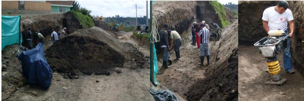
Figura No.63 Excavación y mejoramiento de suelo para muro de contención.
