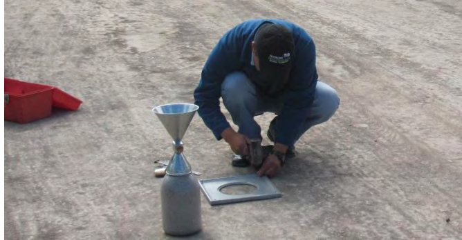
Figura No.34 Ensayo del cono y la arena para Subbase granular.
