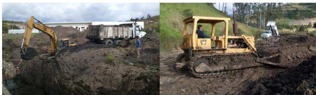
Figura No.77 Equipo o maquinaria de trabajo
