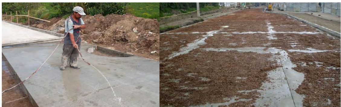
Figura No.56 Riego directo de agua sobre losa y mantos saturados.
