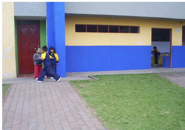
Figura 8. A la derecha del Restaurante se encuentran los baños de los niños
