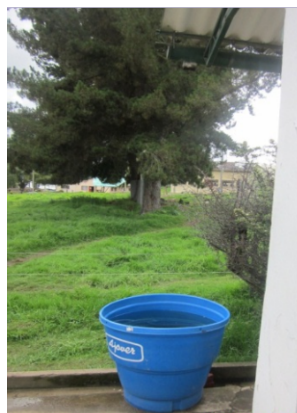
Figura 52. Sistema para recolección de agua lluvia: canaleta conductora y tanque recolector.
