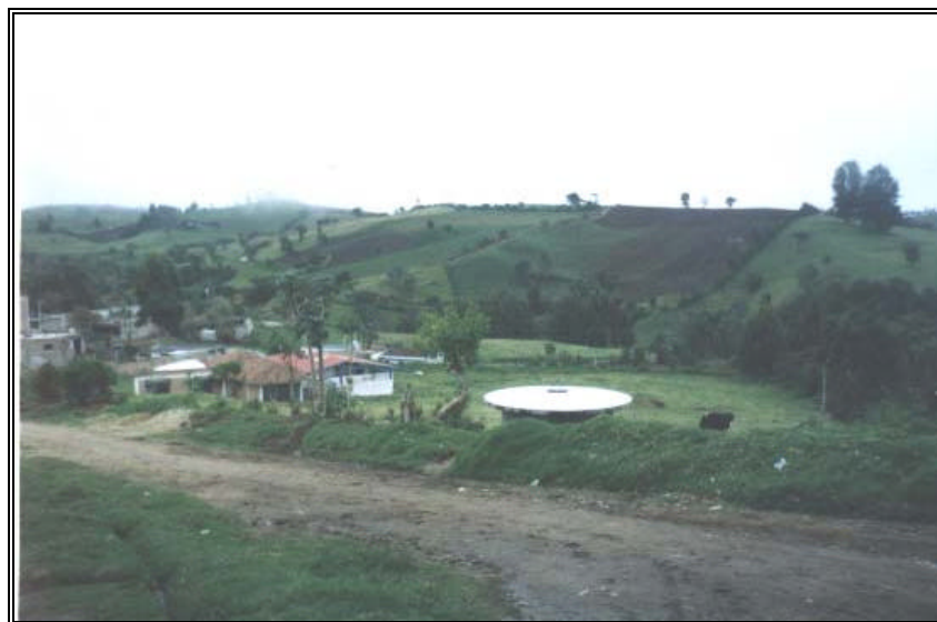
Figura 40. Vías en buen estado
