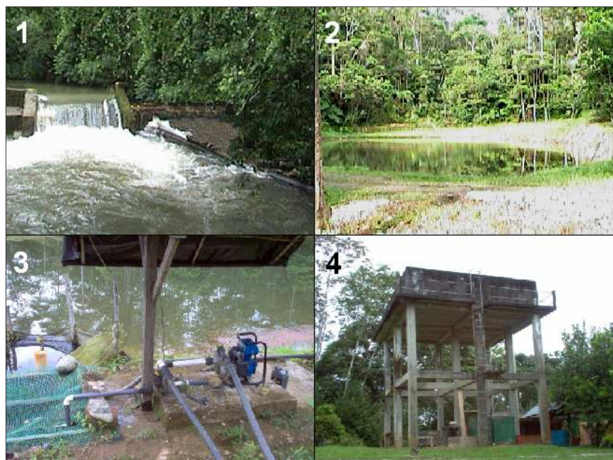
1. Bocatoma 2. Embalse 3. Electroboomba 4. Tanque elevado
