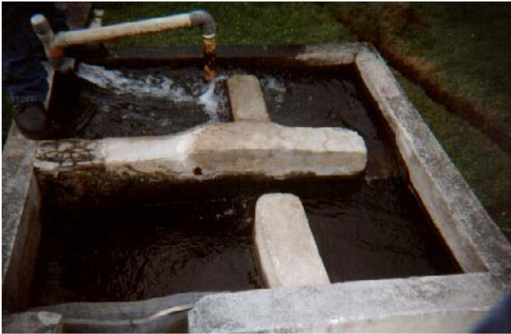
Figura 5. Cámaras sedimentadoras por rebose.
