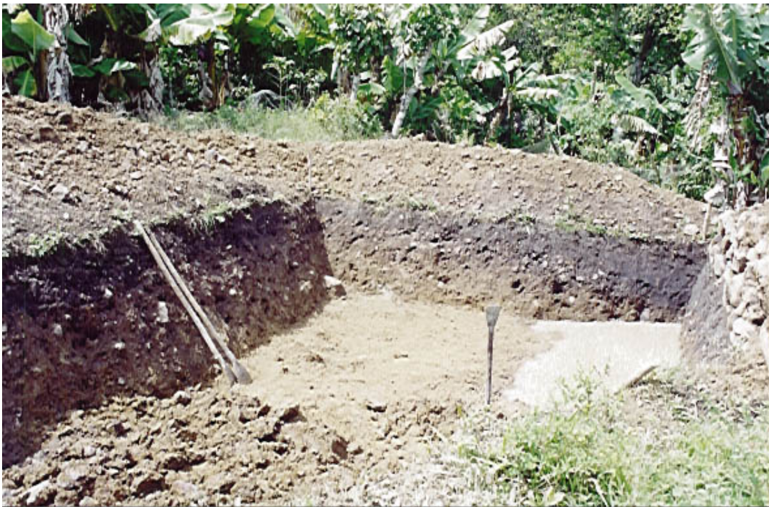
Figura 10. Diseño y construcción de estanques.
