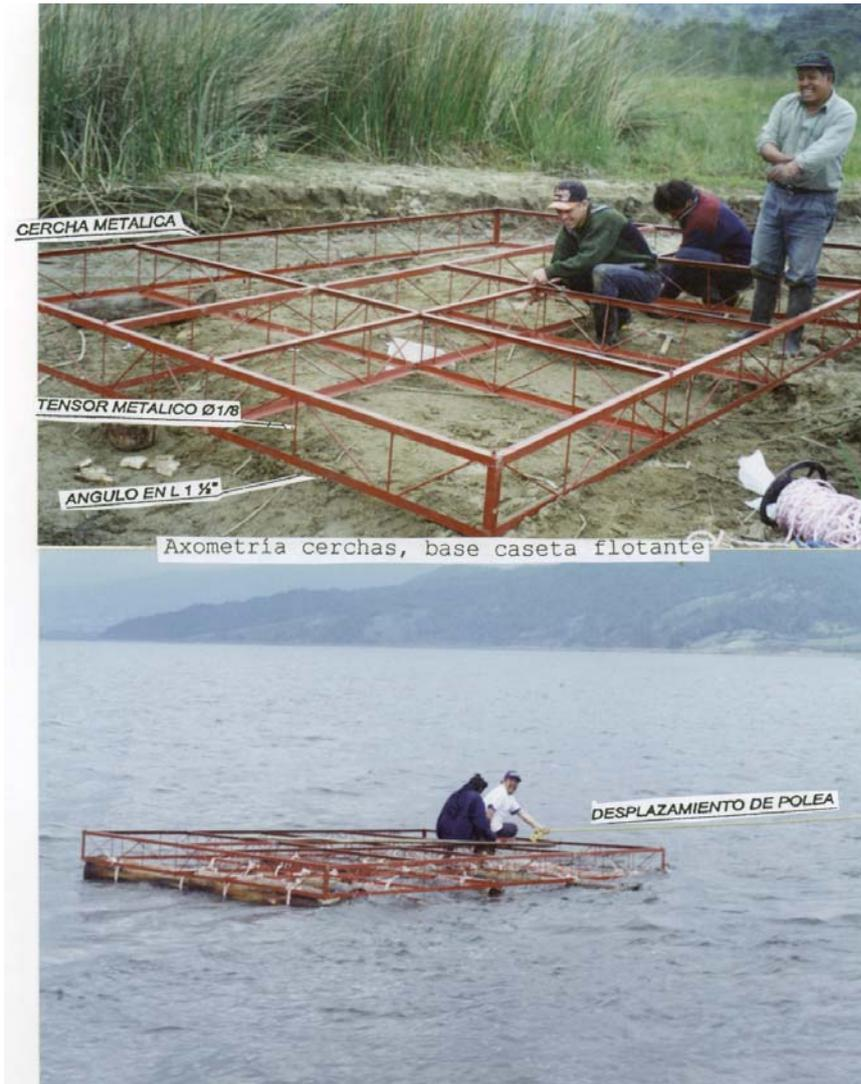
En esta estructura se encuentra una polea que sostiene la línea con el objeto que el sistema flotante se mantenga a ras del agua independientemente de las fluctuaciones de nivel de laguna y/u oleaje (Figura 15).
