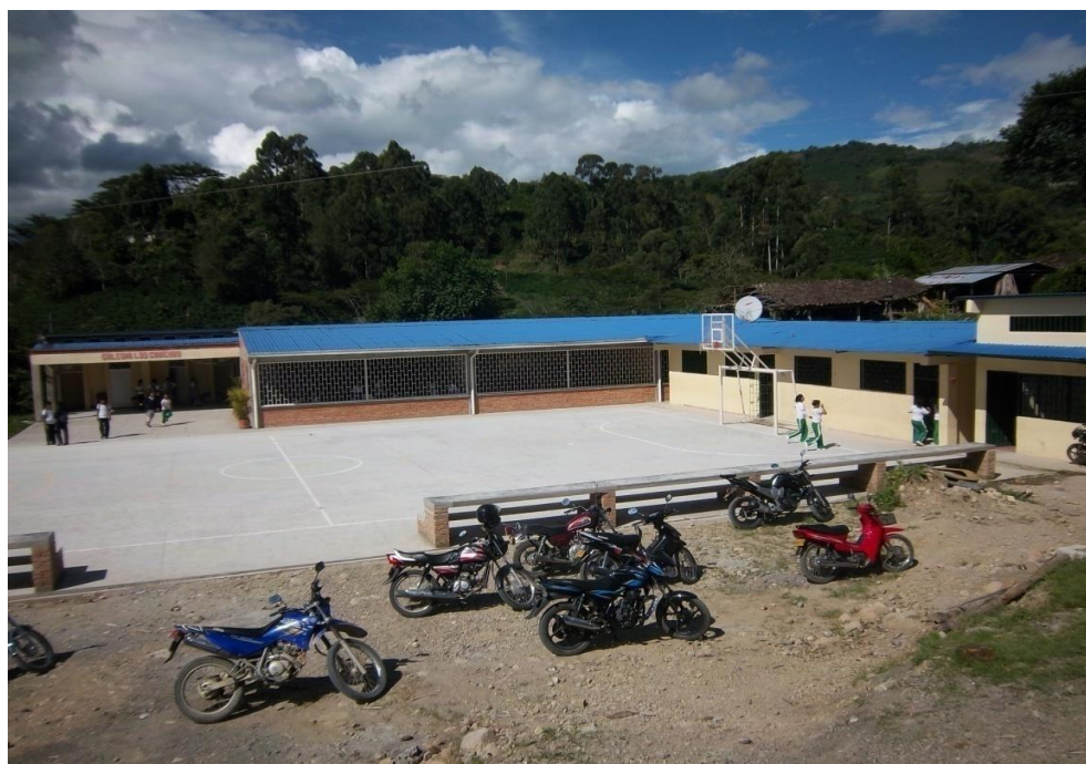
Figura 1. Instalaciones Institución Educativa Los Cauchos
