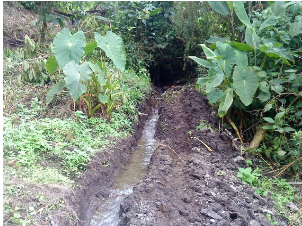
Figura 11. Canal de conducción.
