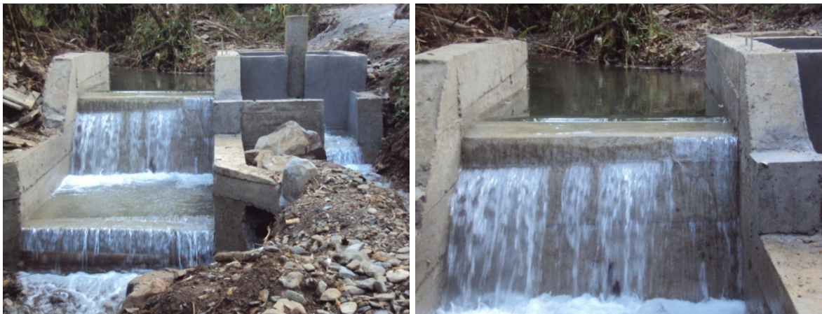
Figura 10. Estado final construcción Bocatoma lateral.
