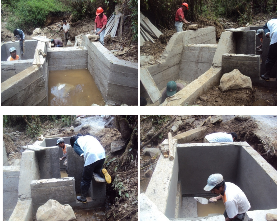
Figura 9. Proceso de construcción Bocatoma lateral.
