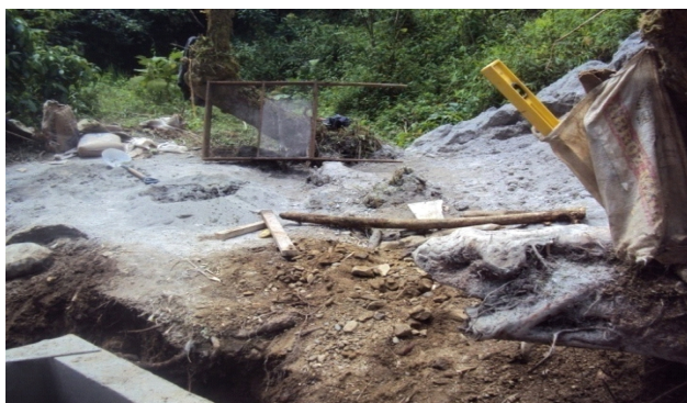
Figura 3. Materiales y equipos de construcción.
