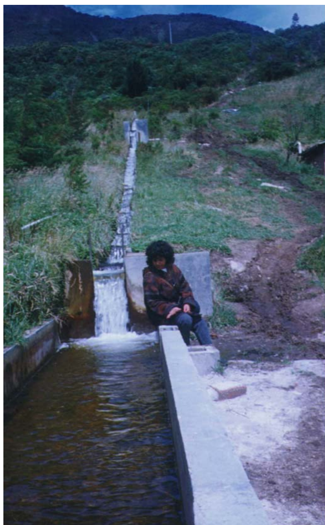
Figura 4. Canal de Conducción Estación “El Mana”.
