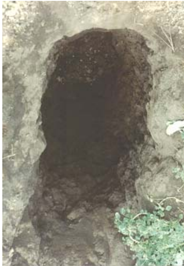
Figura 6. Excavación – vista del pozo rectangular Vereda de Bellavista Tumba aprox. 4 m de profundidad
