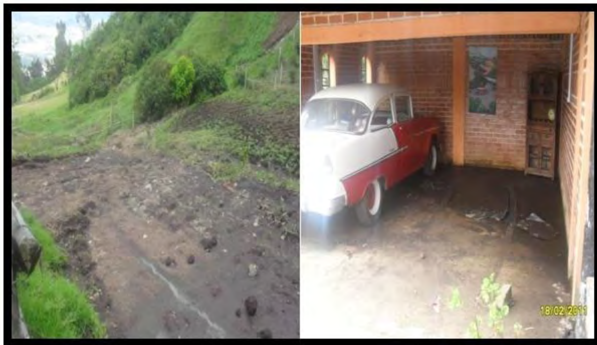
Figura 23. Daños por inundación parte alta sector San Cayetano, año 2011
