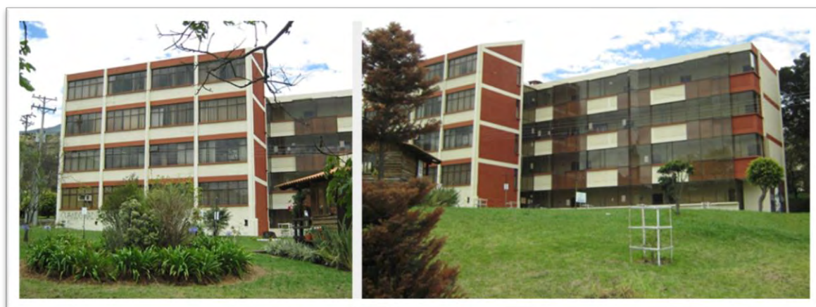
Figura 16. Edificio bloque 2, nivel 2, donde funciona el P.I.A. Sede principal Torobajo. Universidad de Nariño.
