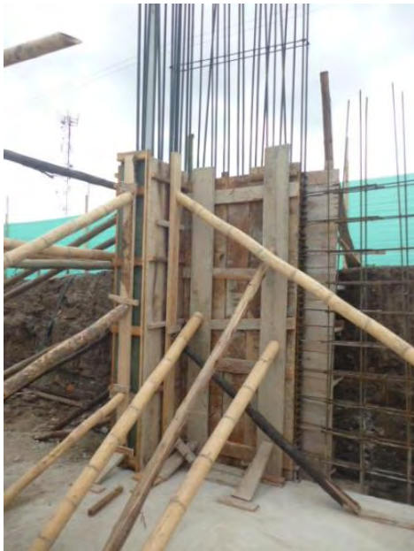
Figura 20. Encofrado Muro estructural.
