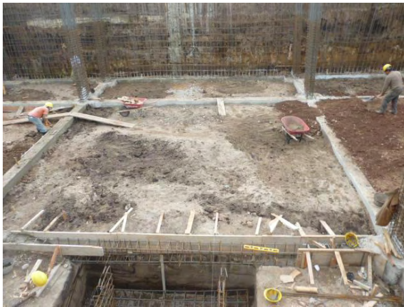
Figura 11. Fundición vigas de cimentación.
