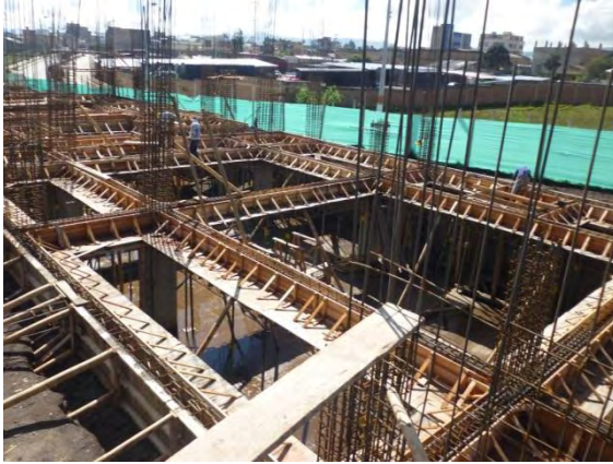
Figura 23. Encofrado Fase II.
