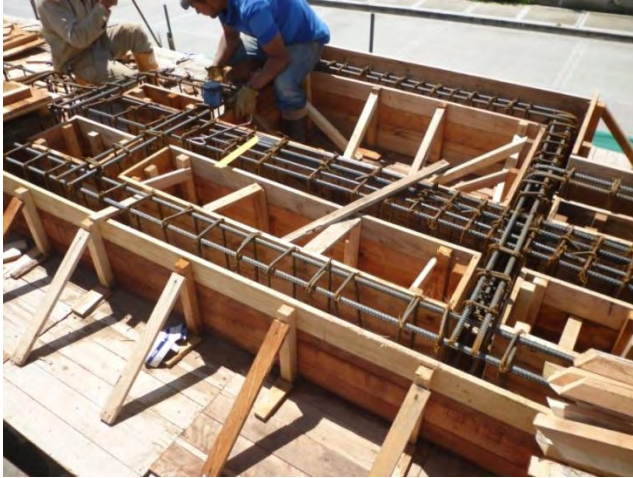
Figura 32. Encofrado Fase II.
