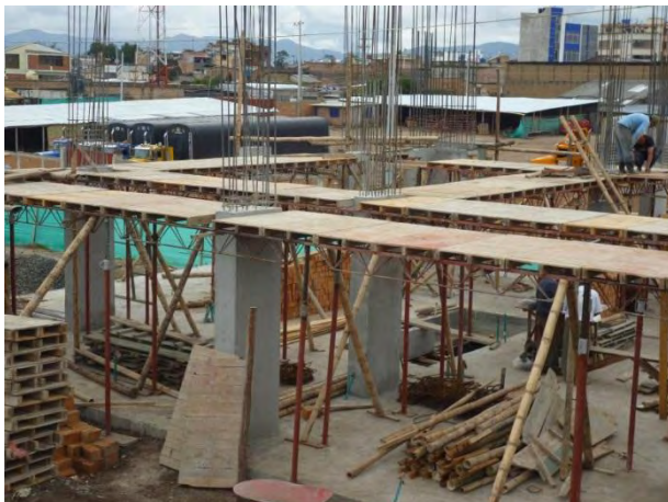
Figura 31. Encofrado Fase I.
