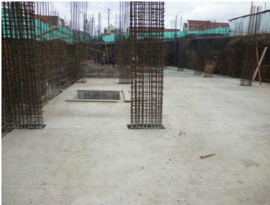
Figura 18. Acero de refuerzo columnas.
