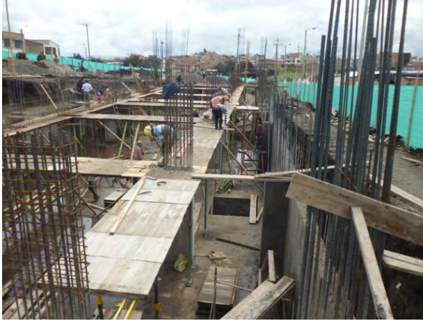
Figura 22. Encofrado Fase I
