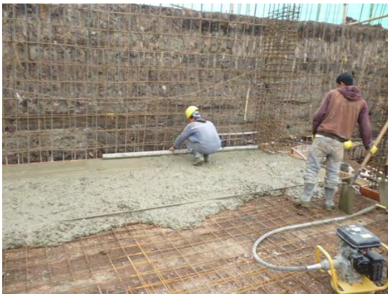
Figura 16. Fundición Losa de Piso
