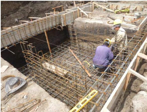
Figura 12. Refuerzo foso ascensor.
