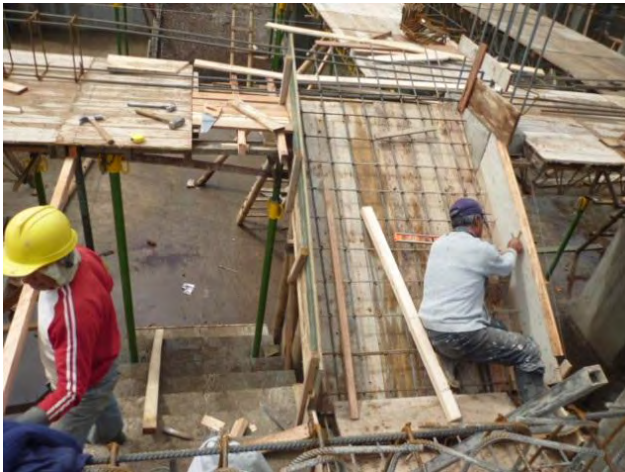
Figura 26. Acero de refuerzo escalera.
