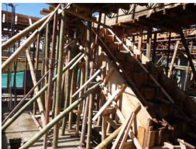
Figura 34. Acero de refuerzo escalera.
