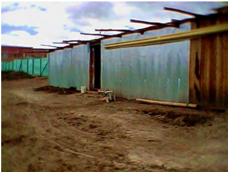
Figura 8. Campamento provisional de obra.
