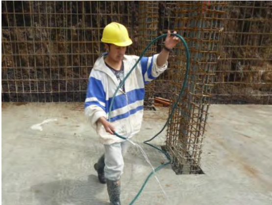
Figura 17. Curado losa de piso.
