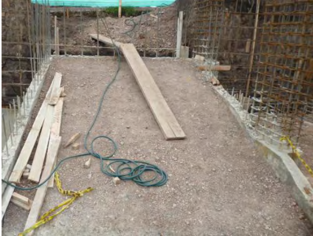
Figura 13. Relleno material común rampa.
