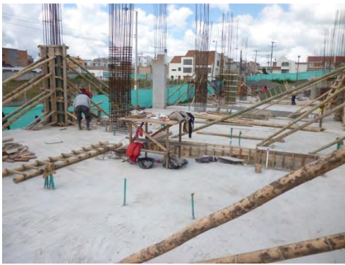
Figura 27. Primer entrepiso fundido.
