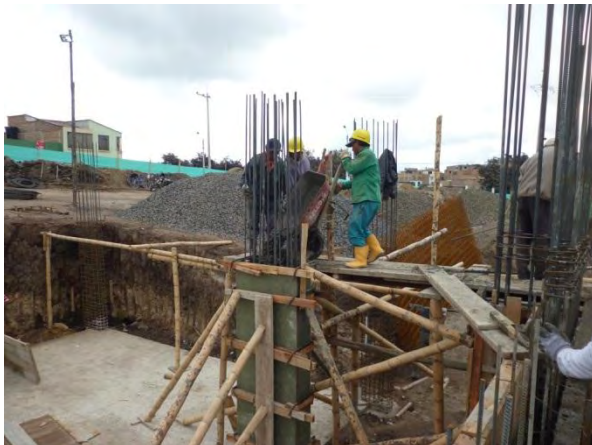
Figura 21. Fundición de columnas.
